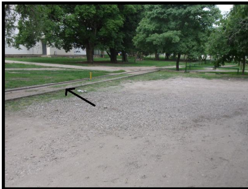
Fig. 18 Cordón Cuneta a extraer Playa n° 2. Fuente: Elaboración Propia
