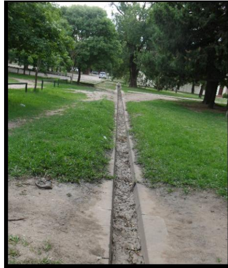
Fig. 13 Canal de Desagüe Existente. Fuente: Elaboración Propia
