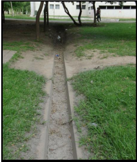
Fig. 13 Canal de Desagüe Existente. Fuente: Elaboración Propia
