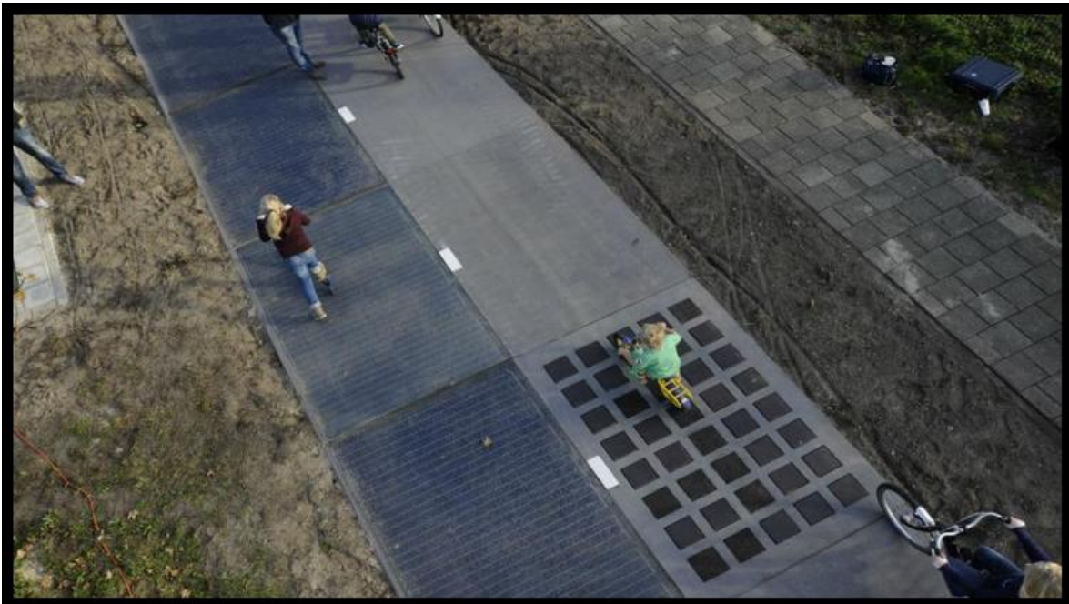
Fig. 57 Ciclovía con Paneles Solares. Fuente: SolaRoad
