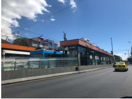
Fotografía N° 34. Parada Trolebús Santa Clara. Fotógrafo: Leandro De la Cadena
