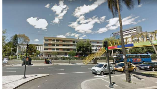
Fotografía N° 14. Cerramiento PUCE oeste. Fotógrafo: Leandro De la Cadena
