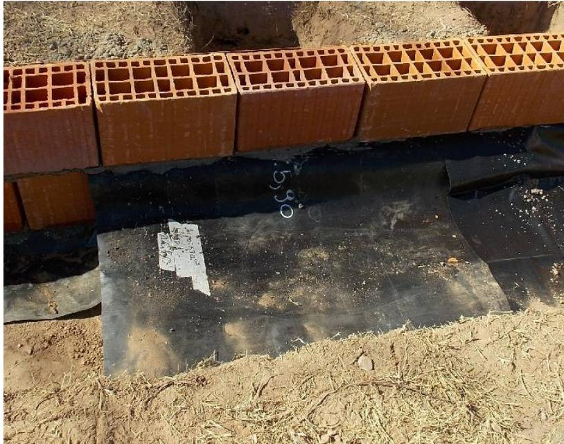
Fig. 5- Emplazamiento de la barrera ejecutada con geomembrana de polietileno de alta densidad (HDPE) inserta dentro del muro y a 0.20m de profundidad.
