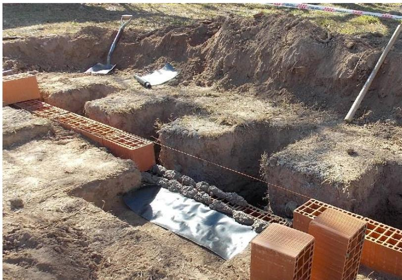
Fig. 4- Emplazamiento de la barrera de suelo-bentonita en donde se observa la colocación del film de polietileno para garantizar la estanqueidad de la junta entre la barrera y el muro.
