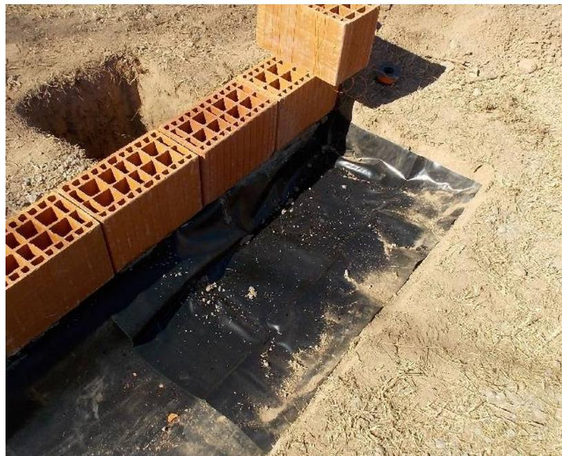
Fig. 6- Emplazamiento de la barrera ejecutada con geomembrana de policloruro de vinilo (PVC) inserta dentro del muro y a 0.20m de profundidad.
