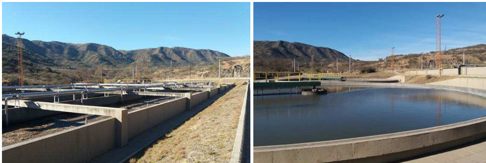
Ilustración 41. Planta de tratamiento de efluentes Costa Azul.
