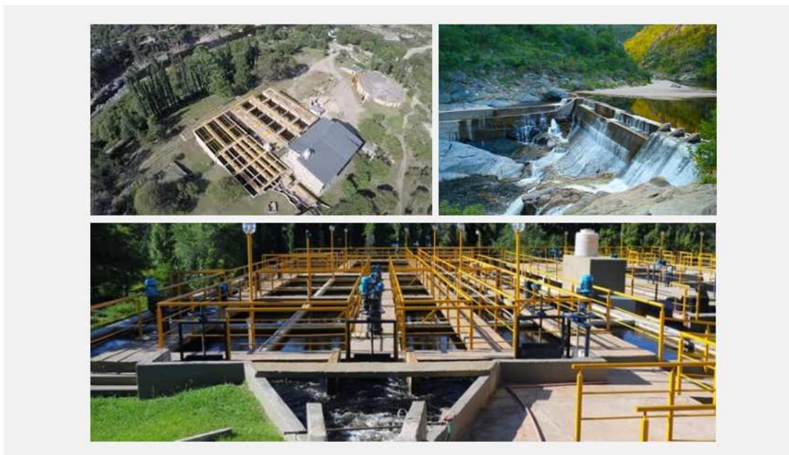
Ilustración 37. Planta potabilizadora de Cuesta Blanca. Azud y toma de agua. Fuente: Coopi.
