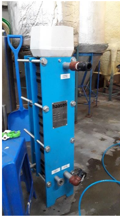
Figura 7: Intercambiador de calor en la cervecería Viarava.
