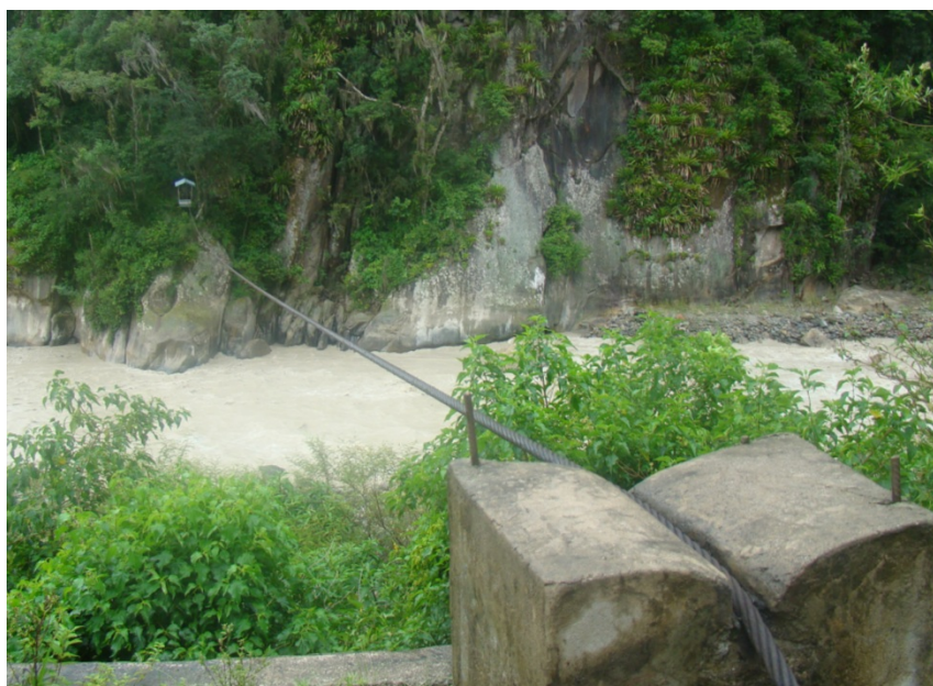
Figura 3.1. Cablecarril utilizado para cruzar el Río Bermejo
