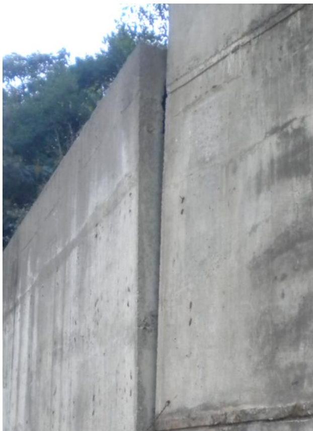
Figura 3.6. Inclinación de los muros de ala del estribo Norte
