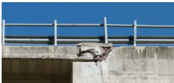
Figura 3.6. Inclinación de los muros de ala del estribo Norte
