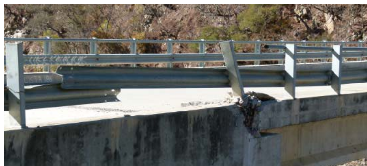
Figura 3.7. Deterioro del tablero en la unión con el estribo Norte
