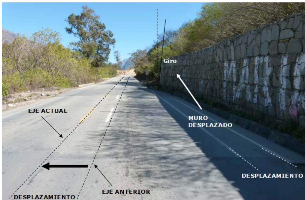
Figura 2.1. Señales visuales de desplazamientos sobre la ruta hacia La Mamora.
