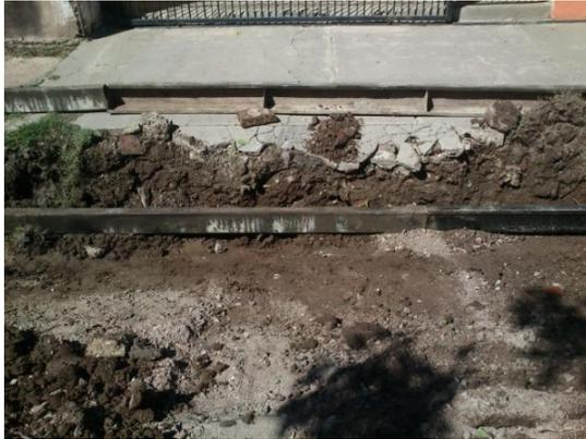
Fig. 3.3.17 Cuneta moldeada, utilizando tanza para nivelar los moldes de base.
