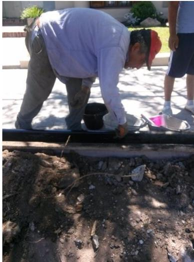
Fig. 3.3.37 Pintado de los moldes con aceite desencofrante.
