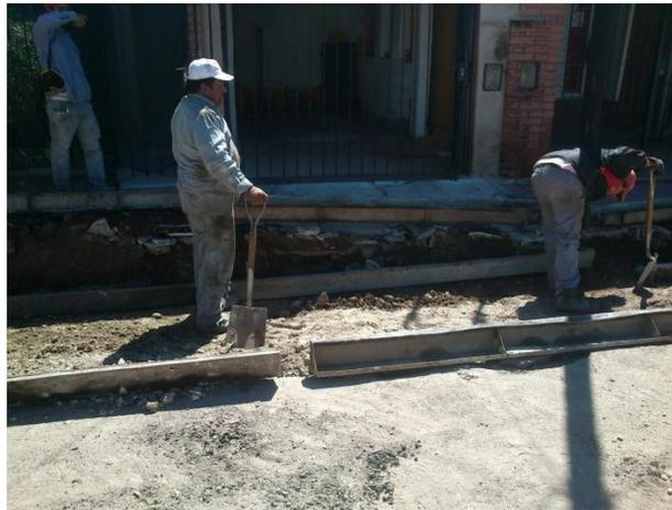
Fig. 3.3.32 Proceso de moldeado.
