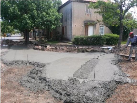
Fig. 3.3.45 Proceso de "fratachado".
