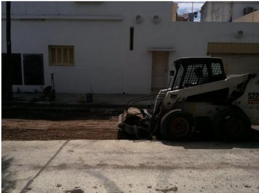
Fig. 3.3.19 Compactado con rodillo liso vibrador hidráulico.
