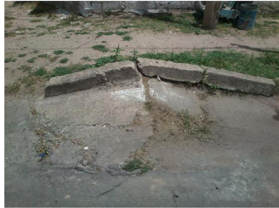
Fig. 2.4.4 Levantamiento por viga de hormigón macizo.
