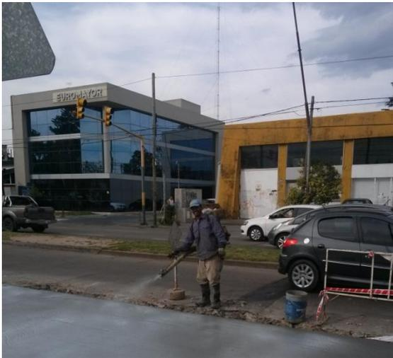
Fig. 3.3.49 Colocación de la pintura antisol
