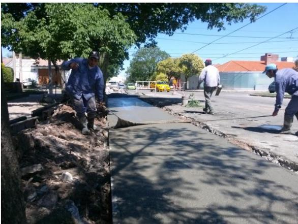
Fig. 3.3.47 Terminación superficial con bolsa arpillerera.
