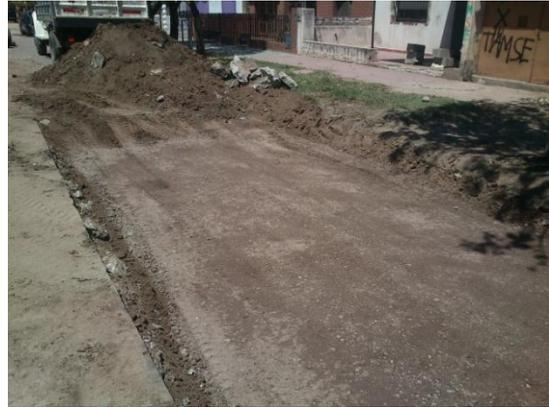
Fig. 3.3.23 Base terminada, compactada con rodillo liso vibrador de mano.
