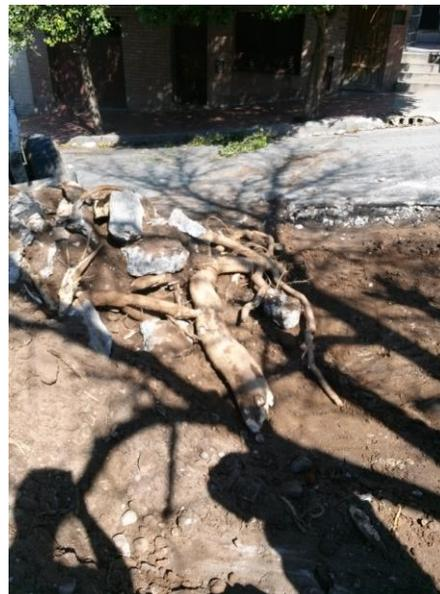
Fig. 2.4.11 Levantamiento por una raíz perdida debajo del pavimento.
