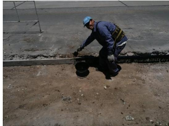
Fig. 3.3.38 Pintado de los moldes con aceite desencofrante.
