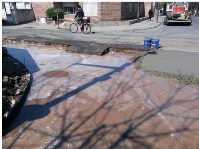
Fig. 3.3.7 Rotura de un caño de la red de agua.
