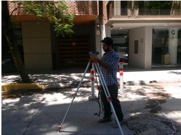
Si el suelo natural debe ser removido y luego reemplazado por suelo nuevo, el procedimiento de nivelado de los estacones es similar al caso anterior, solo que la estaca define una cota superior a la cual se debe llegar con el suelo nuevo. Este procedimiento de relleno se realiza por acción de una pala mecánica que distribuye el suelo en la superficie del bache y en capas que deben ser compactadas, hasta el nivel definido por la estaca.
