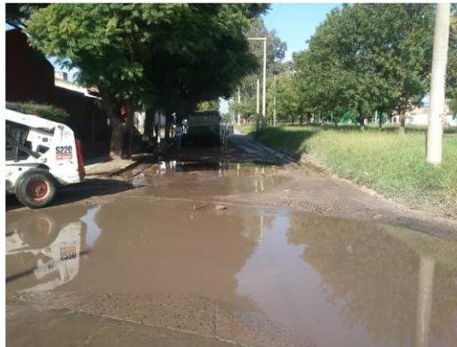
Fig. 2.1.1 Hundimiento por falta de soporte de la subrasante.
