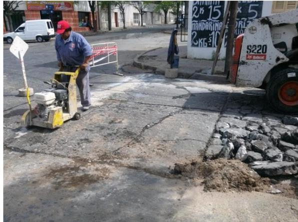
Fig. 3.3.3 Proceso de Aserrado.
