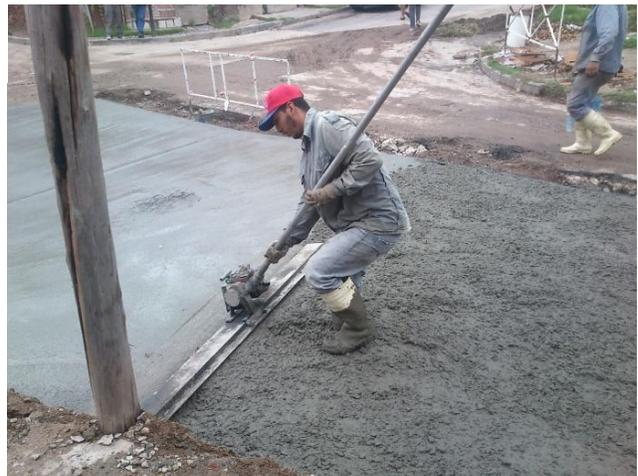
Fig. 3.3.44 Proceso de vibrado.
