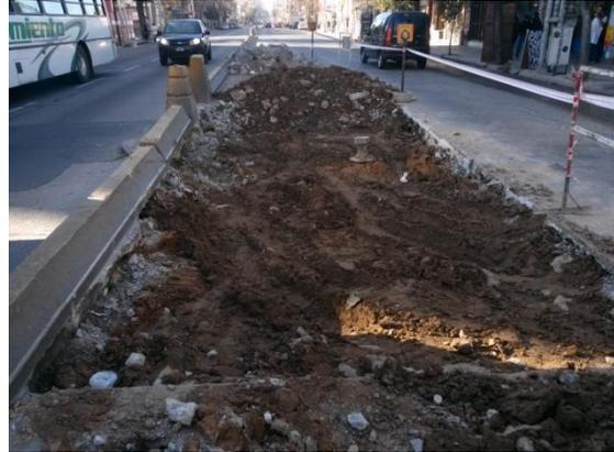
Fig. 2.4.9 Estado de subrasante por colapso de una red cloacal.
