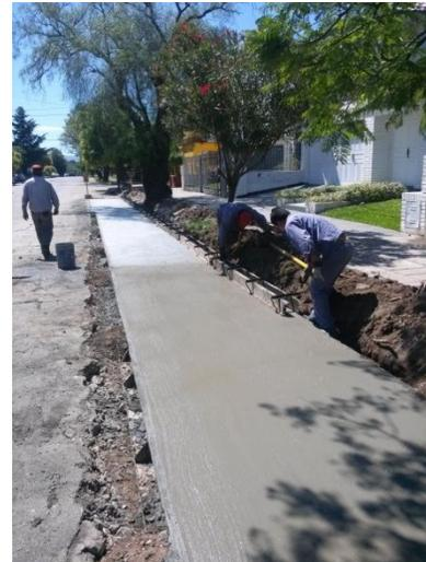
Fig. 3.3.50 Diferencia entre hormigón con y sin antisol
