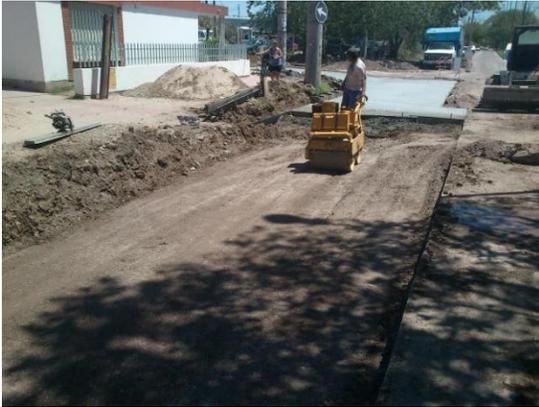
Fig. 3.3.22 Compactado con rodillo liso vibrador de mano.
