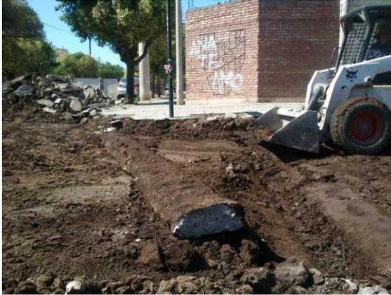
Fig. 2.4.3 Viga de hormigón macizo encontrada debajo del pavimento.
