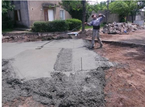
Fig. 3.3.46 Proceso de "fratachado".
