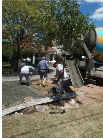
Fig. 3.3.28 Camión “mixer”, para la provisión de hormigón.
