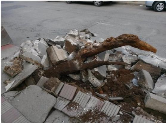
Fig. 2.4.10 Levantamiento por una raíz perdida debajo del pavimento.
