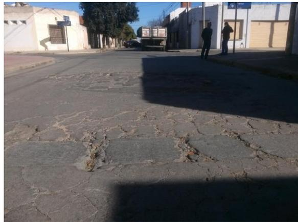
Fig. 2.4.7 Deterioro del pavimento por un “zanjeo”.
