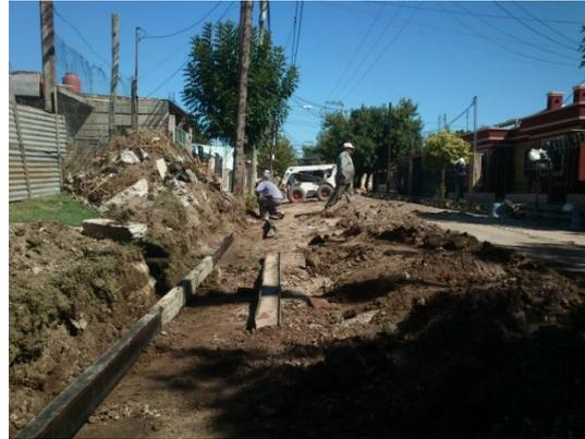
Fig. 3.3.18 Cuneta moldeada, utilizando tanza para nivelar los moldes de base.
