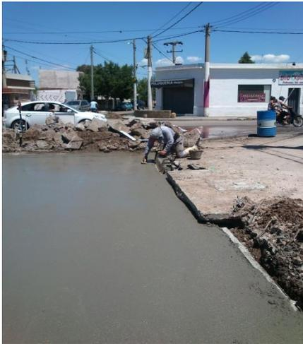
Fig. 3.3.31 Losa en proceso de fraguado, moldeada.
