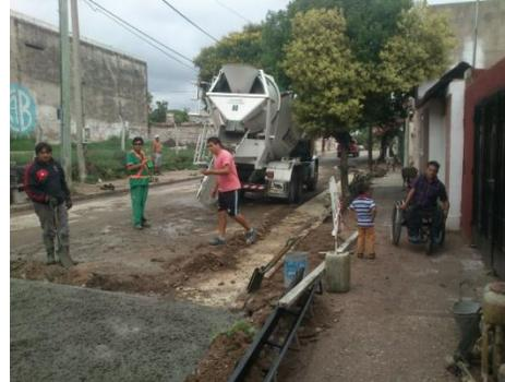
Fig. 3.3.29 Camión “mixer”, para la provisión de hormigón.
