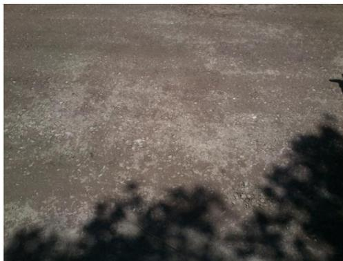
Fig. 3.3.21 Base terminada, compactada con rodillo liso vibrador hidráulico.
