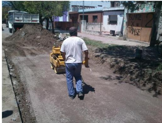
Fig. 3.3.24 Compactado con rodillo liso vibrador de mano.
