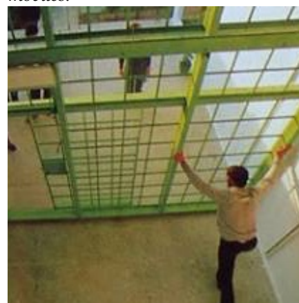
Fig. 250 Recuperado de: https://www.fondazionerenzopiano.org/it/ Los ambientes tienen la capacidad de ampliarse con el corrimiento de aberturas sobre rieles previamente colocados en los laterales del contenedor estructural. Siendo el propio habitante el que transforma la arquitectura con una tecnología a su alcance.
