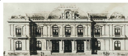
Fig. 93 Recuperada de: https://www.lavoz.com.ar/espacio-de-marca/bancor-rinde-homenaje-al-arquitecto-francisco-tamburini Fachada del proyecto de Francisco Tamburini del año 1887, actual Museo del Banco de Córdoba .
