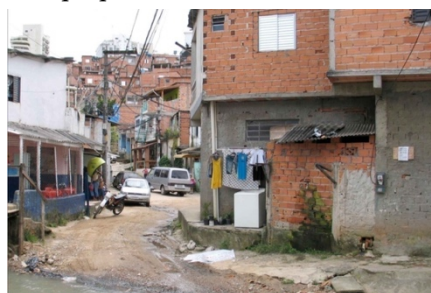
Fig. 186 Recuperada de: http://www.mmbb.com.br/ Imagen del sector a intervenir antes de la canalización del arroyo, donde se visualizan permanentes inundaciones y derrumbes de las precarias viviendas existentes.
