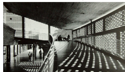
Fig. 24 Recuperada de: https://elestimulo.com/climax/carlos-raul-villanueva-un-renacentista-que-vencio-las-sombras/ Universidad de Caracas. Proyecto de arquitecto Villanueva (1957).
