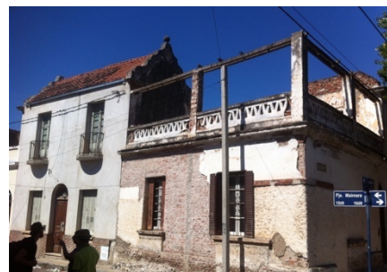
Fig. 290 Fuente: fotografía propia. La forma espacial del conjunto, en su proyecto inicial, incluye patios y terrazas de expansión, espacios permeables a las mutaciones de la vivienda. En la imagen puede visualizarse parte de la estructura de pérgolas sobre terrazas, las cuales han sido cerradas como primera etapa de ampliación en el tiempo.
