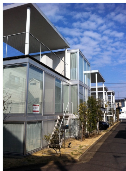
Fig. 170 Fuente: fotografía propia. Apartamentos Shakuji, proyecto de Kazuyo Sejima, el conjunto en forma de cluster, abierto en sus bordes, configura expansiones internas al conjunto y externas a la ciudad.
