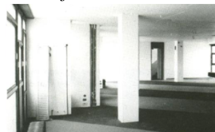
Fig. 350 Recuperada de: http://homeusers.brutele.be/kroll/auai-project-ZS.htm Vista del interior de los departamentos, donde la estructura permite la fluidez interior y la posibilidad de transformación en el tiempo, haciendo una estructura estable de hormigón y otra transformable de madera o metal.
