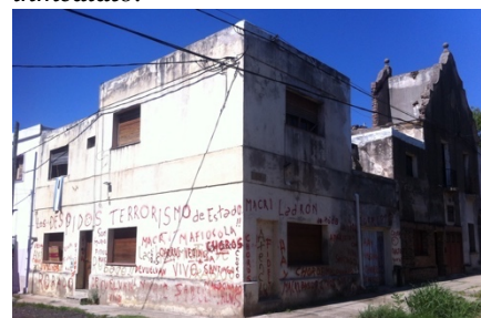
Fig. 295 Fuente: fotografía propia. En la imagen se puede ver la transformación del proyecto de origen, donde se ha cambiado la cubierta inclinada por una plana, agregando ambientes sobre huecos de terrazas. La casa de esquina, además, ha mutado a mural de expresión de crítica política por el propio habitante.
