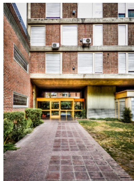
Fig. 88 Fotografía de Gonzalo Viramonte. Recuperada de: https://www.plataformaarquitectura.cl/cl/02-360727/clasicos-de-arquitectura-la-obra-urbana-de-togo-diaz-jose-ignacio-diaz Edificio Güemes I y II sobre La Cañada, proyecto de Togo Díaz, donde las pautas del código permiten la creación de vacíos en planta baja y espacios verdes hacia la calle. Estas expansiones son posibles al no significar mayores costos para la empresa, ni la obligación de respetar una línea imaginaria perimetral; de esta manera, el edificio, regulado por la ordenanza del FOT se ajusta a las dimensiones del lote para su superficie total, liberando espacios vacíos para la ciudad.
