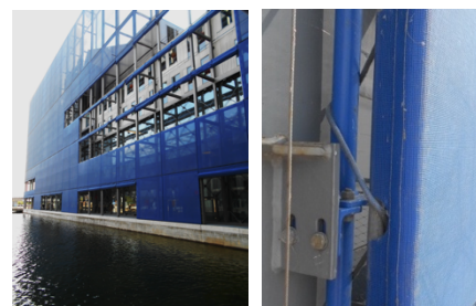
Fig. 235 Fotografía de arriba a la derecha de: Seier + Seier. Las demás fotografías: fuente propia. Koncerthuset, auditorio de conciertos de Copenhague, Dinamarca, autor arq. Jean Nouvel, 2009. El edificio muestra decisiones técnicas de diseño de sus elementos que lo posibilitan abierto y activo en el tiempo. El proyecto se desarrolla a partir de una resolución técnica particular de sus envolventes haciendo una doble piel, la cual permite no solo crear espacios intermedios de diafragmas entre el interior y exterior, sino convertir a todo el conjunto en una pantalla urbana de exposición de eventos.
