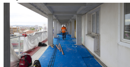
Fig. 357 Recupera de: https://www.lacatonvassal.com/ Imagen de los espacios de jardines de invierno anexados al edificio existente. A la derecha de la imagen, se pueden ver aún las aberturas existentes antes de ser removidas.
