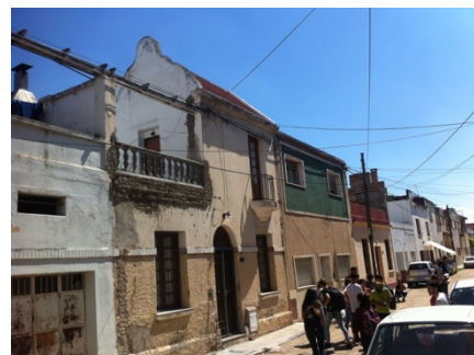
Fig. 292 Fuente: fotografía propia. Calle interna del conjunto donde se puede ver la transformación de las viviendas por sus habitantes. Las envolventes neocoloniales son cambiadas a un nuevo lenguaje racional, se reviste con variedad de materiales, cierran patios y terrazas agregando ambientes a las viviendas y transformando así todo el conjunto.
