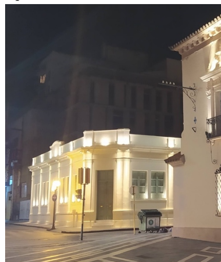
Fig. 81 Fuente: fotografía propia. En la imagen se visualiza la obra del CCUNC paralizado en sus tareas de obra, como se ve por detrás de su única fachada restaurada e iluminada, conformando una nueva etapa de obras inconclusas.
