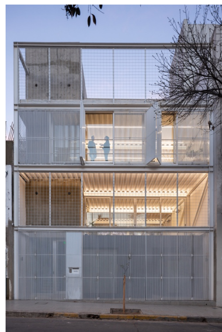
Fig. 397 Fotografías de: Javier Agustín Rojas. Proyecto de los arquitectos: Andrea Livobich, Diego Sabbatini, Javier Giorgis. Año: 2017. Imagen del edificio WIP, arriba se puede ver su preexistencia, una vivienda unifamiliar y la medianera ciega expuesta producto de la sucesión de cambios en la normativa. En la imagen de abajo, se visualiza la obra del WIP, envolviendo lo existente en una nueva reformulación espacial de ambientes polivalentes y flexibles, que a la vez, hacen una sucesión de transiciones espaciales entre el espacio exterior e interior del edificio.
