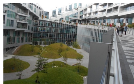
Fig. 153 Fuente: fotografía propia. El edificio de 8 House se estructura espacialmente a través de una vereda continua que va trepando toda la edificación.
