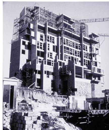
Fig. 349 Recuperada de: https://www.researchgate.net/figure/Krolls-hybrid-structural-design-for-the-faculty-Imagen-de-la-obra-durante-su-construccion-donde-se-visualiza-la-estructura-de-hormigon-armado-independiente-la-que-permite-la-diversidad-de-completamiento-en-aberturas-y-cerramientos
