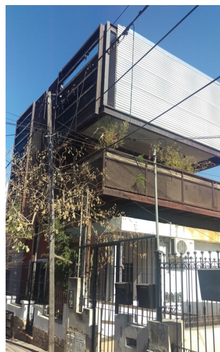
Fig. 15 Fuente: fotografía propia. Casa transformada en barrio Güemes, en Córdoba, donde se visualizan diferentes estratos de obras. Sobre una vivienda existente se le suma, a manera de parásito, una nueva construcción para vivienda en planta alta con espacios de expansión, liberando la planta baja para locales y consultorios. La transformación de la casa original permite lidiar con el código de edificación, actualizar los ambientes para nuevas funciones y dar al barrio nueva vitalidad. Proyecto de arq. Barbaresi, C., 2018.
