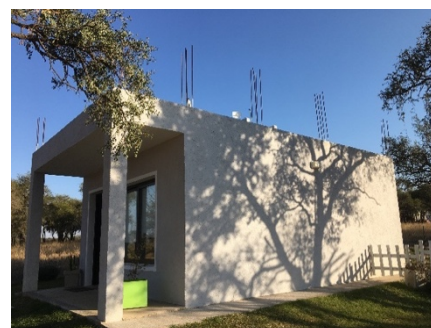
Fig. 114 Fuente: fotografías propias. En las fotografías de estas viviendas unifamiliares, se visualiza la proyección a futuro de las construcciones, con sus hierros al aire o su esqueleto estructural planteado para otra etapa, mostrando así la intención de una obra a continuar, sin cerrar. Esta situación se ve en gran cantidad de construcciones en la ciudad, a la espera de un futuro crecimiento.
