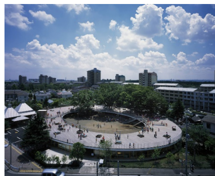
Fig. 306 Recuperada de: http://www.tezuka-arch.com/ El edificio en forma de elipse transforma la cubierta en espacio de juegos, cambiando el uso tradicional de patio claustral.
