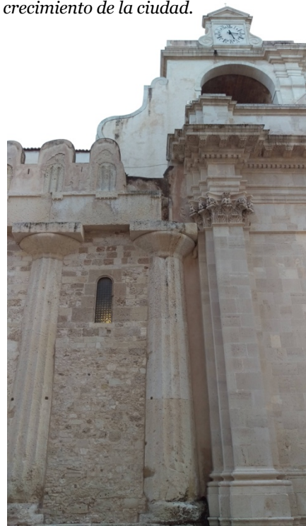
Fig. 207 Fuente: fotografía propia. Imagen exterior de la catedral de Siracusa construida sobre un templo griego, donde se visualizan los pilares preexistentes intrincados en el nuevo edificio, evidenciando la mutación de la arquitectura.
