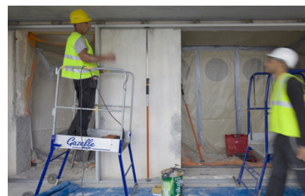
Fig. 358 Recupera de: https://www.lacatonvassal.com/ La mutación del edificio implica una organización de gestión rigurosa. En la imagen se visualiza el cambio de aberturas existentes y agregado del espacio de terraza-jardín, manteniendo los habitantes viviendo en su interior.
