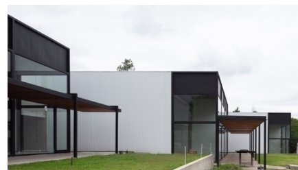
Fig. 396 Fotografías de: Javier Agustín Rojas. Proyecto de arquitectos: Diego Sabattini, María Ramon Viciano, Javier Giorgis. Año: 2015-2019. Complejo comercial construido en Córdoba a partir de una cubierta existente prefabricada, la cual estaba abandonada por más de diez años. El proyecto la incluye en una nueva definición espacial y funcional.
