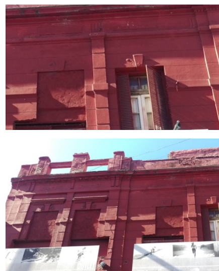
Fig. 109 Fuente: fotografías propias. Imagen de transformaciones de obras en calle Rivadavia, en la ciudad de Córdoba, donde la dinámica del contexto cultural y urbano local, llevan al constante replanteo de la unidad de la obra, donde aparece lo inacabado, contradictorio y feo como partes de su transformación. En la figura se puede visualizar el cerramiento de vanos, la superposición de cartelería, el seccionamiento de partes de la construcción abriendo nuevos locales, cambiando funciones y principalmente, siguiendo nuevos referentes sociales, lo cual muestra la transformación constante de la arquitectura en el paisaje urbano.
