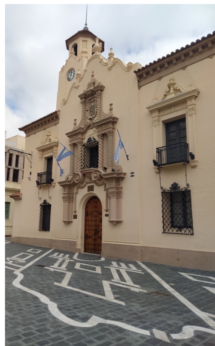
Fig. 73 Fuente: fotografía propia. Imágenes del actual Colegio Nacional de Monserrat, después de la apertura de calles y remodelación edilicia con transformación de sus envolventes. El nuevo lenguaje, en este tercer proyecto de estudio, reviste el edificio existente cambiando el referente anterior buscando rasgos tradicionales locales, que contradictoriamente elimina el lenguaje real austero existente, vistiéndolo de un plateresco español ajeno al edificio.
