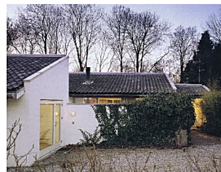
Fig. 254 Recuperada de: http://www.utzonphotos.com/ Vista exterior del prototipo con las cubiertas inclinadas sobre cada célula.
