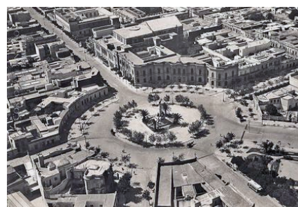
Fig. 50 Recuperada de: http://www.xn--cordobadeantao-2nb.com.ar/ Imagen aérea de Plaza Vélez Sarsfield donde se visualiza contexto urbano de edificación continua, conformando un tejido homogéneo, donde la plaza completa la idea de rótula urbana.
