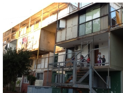
Fig. 361 Fuente: fotografía propia. Imagen del SEP I donde se pueden ver las pasarelas en el espacio semipúblico, internas a los edificios y desfazaje de los módulos de viviendas conformando espacios semicubiertos; los cuales representan expansiones de las viviendas inmediatas.
