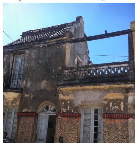
Fig. 293 Fuente: fotografía propia. En la imagen, la única vivienda sin modificaciones sustanciales que existe en el conjunto.
