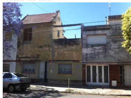
Fig. 297 Fuente: fotografía propia. En la imagen se visualiza la comparación entre el proyecto inicial y su mutación en el tiempo a través de dos viviendas vecinas del mismo conjunto. La paulatina transformación de las viviendas ha cambiado su volumetría porosa de origen por otra más compacta, con lenguajes arquitectónicos de líneas rectas y cubiertas planas.
