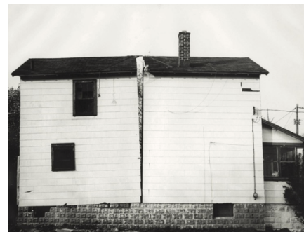
Fig. 47 Recuperada de: https://www.plataformaarquitectura.cl/cl/02-124790/arte-y-arquitectura-building-cuts-gordon-matta-clark La obra de Matta Clark, renace la ruina con su intervención artística, en la imagen se corta la vivienda fracturando el edificio, mostrando otra situación espacial y estructural.
