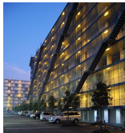
Fig. 333 Recuperada de: http://ante3tap.blogspot.com/2014/08/vivienda-colectiva-casos-de-estudio.html Fachada de accesos comunes al edificio a través de escaleras desfasadas.
