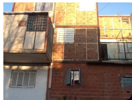
Fig. 364 Fuente: fotografía propia. Las ampliaciones de las viviendas van cerrando la porosidad de vacíos del conjunto en el tiempo, con mano de obra propia y materiales a disposición, cambiando la fisonomía y lenguajes académicos.
