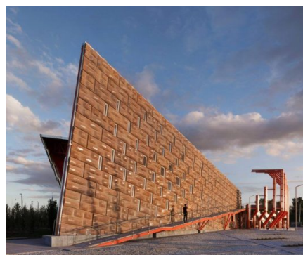
Fig. 315 Recuperada de: https://www.plataformaarquitectura.cl/cl/ El plano que evoca el acopio de bolsas del Grito de Alcorta, se enfatiza con su inclinación ante la vista desde la ruta, con una mayor velocidad de mirada desde la circulación vehicular. Distintas funciones culturales completan el programa del edificio, entre auditorios y salas de exposiciones.
