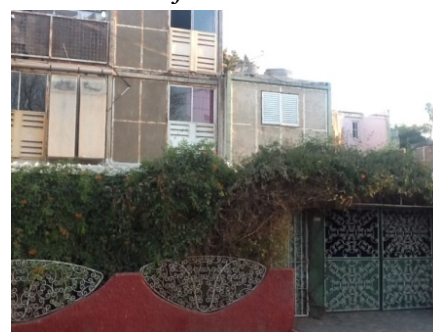
Fig. 363 Fuente: fotografía propia. Las transformaciones del conjunto denotan un esmero y cuidado por parte de sus habitantes, los detalles de herrería, conformación de patios y parquizaciones muestran una belleza espontánea con valor en su dedicación.
