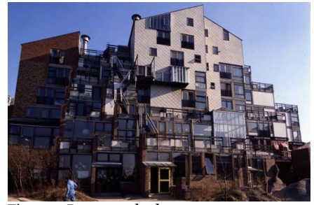
Fig. 351 Recuperada de: https://www.researchgate.net/figure/Kroll-s-hybrid-structural-design-for-the-faculty-housing-with-the-arbitrarily-placed_fig1_317348623 Vista exterior del conjunto donde se expresa la diversidad de lenguajes y las distintas posibilidades del proyecto, poniendo en crisis el rol del arquitecto como único autor.
