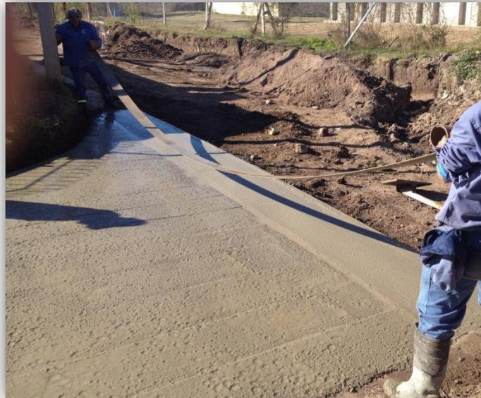
Figura 3.13: Cinta para alisar hormigón.
