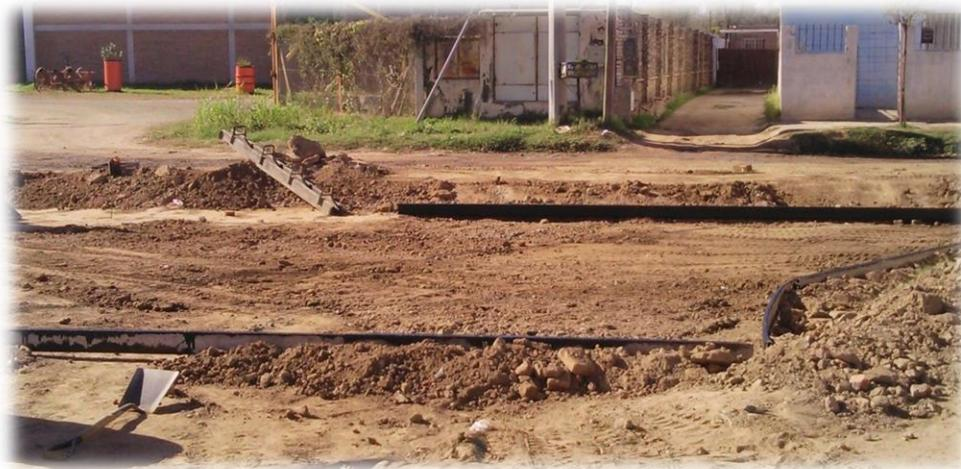
Figura 3.15: Colocación de moldes, práctica incorrecta.
