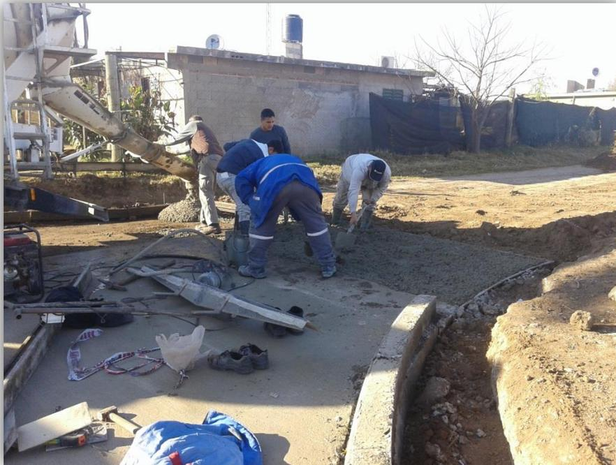
Figura 3.10: Colado del hormigón
