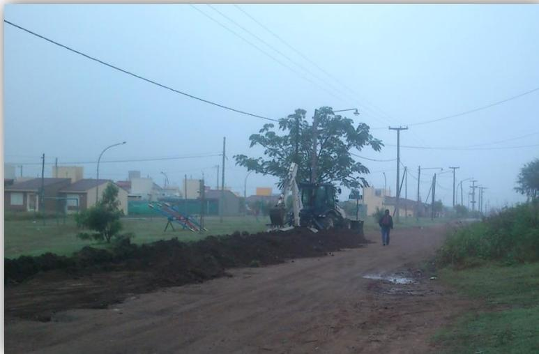
Figura 3.3 Remoción de material sobrante con mini retroexcavadora
