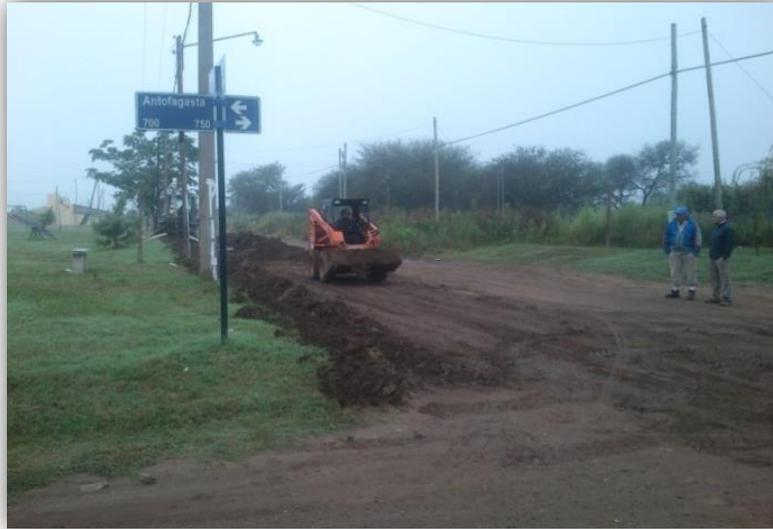
Figura 3.2: Excavación con mini cargadora
