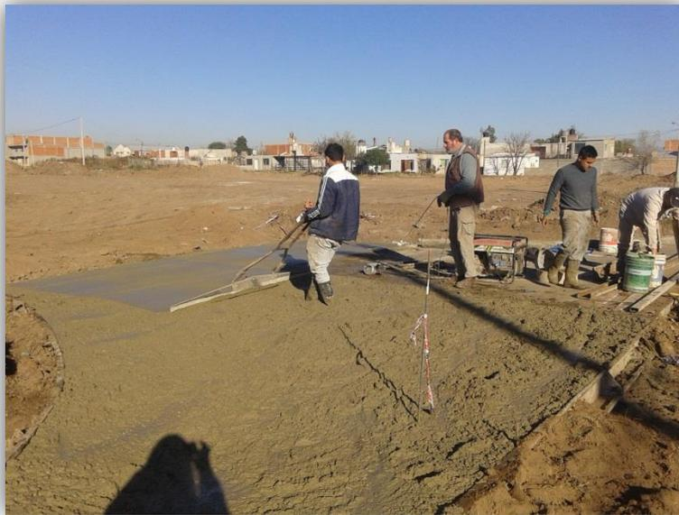
Figura 3.11 Vibrado del hormigón
