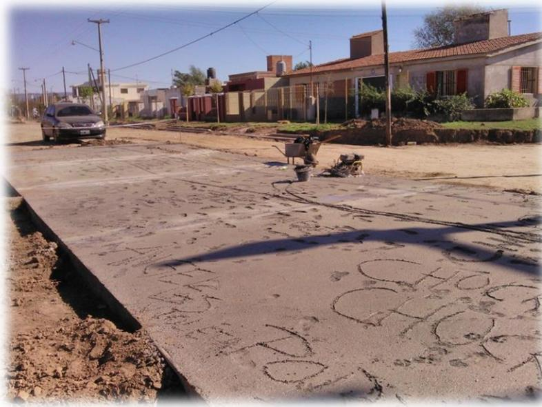
Figura 3.23: Paño de bocacalle arruinada por falta de protección.
