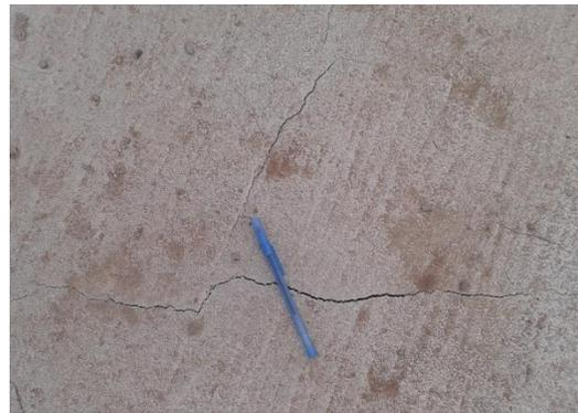
Figura 3.21: Fisuras en hormigón.
