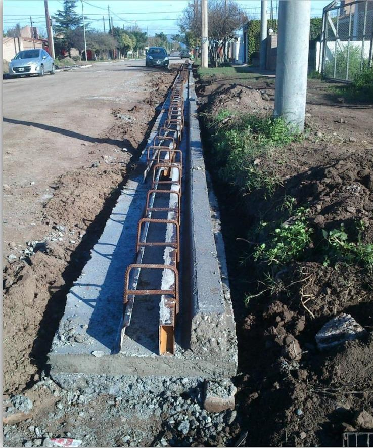
Figura 3.17: Desencofrado de cordón cuneta.
