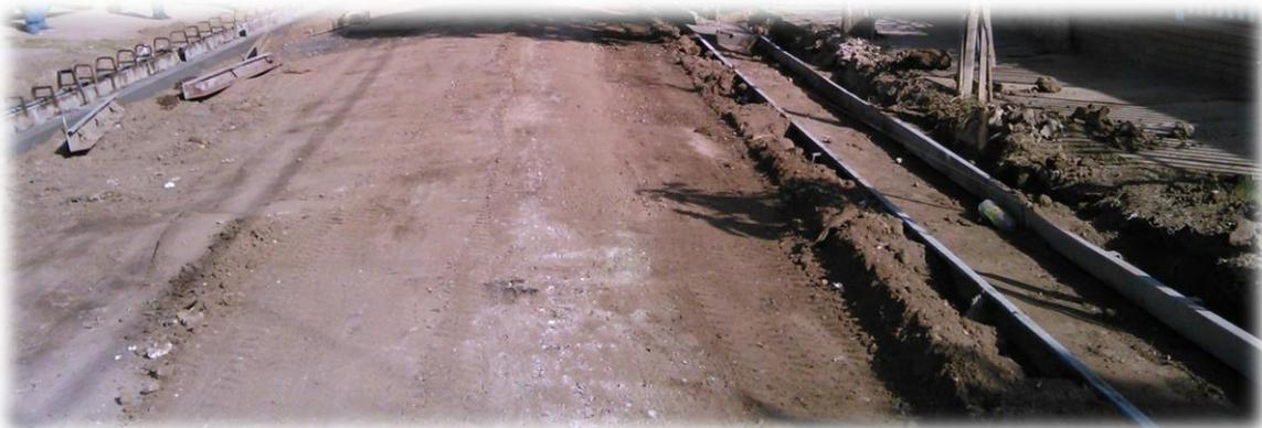
Figura 3.16: Colocación de moldes, práctica correcta.
