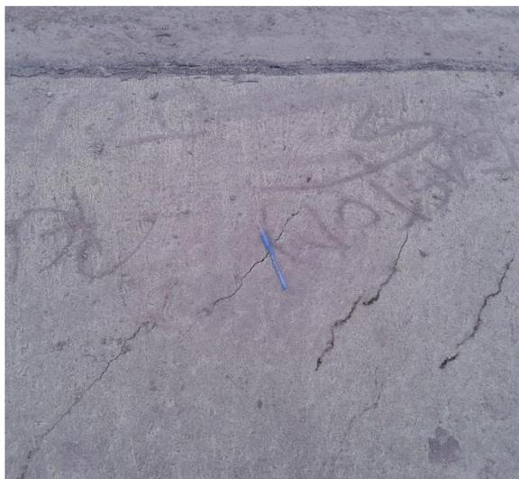
Figura 3.22: Fisuras en bocacalles de Hormigón.
