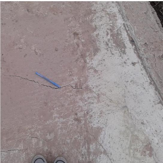
Figura 3.20: Fisuras en hormigón.
