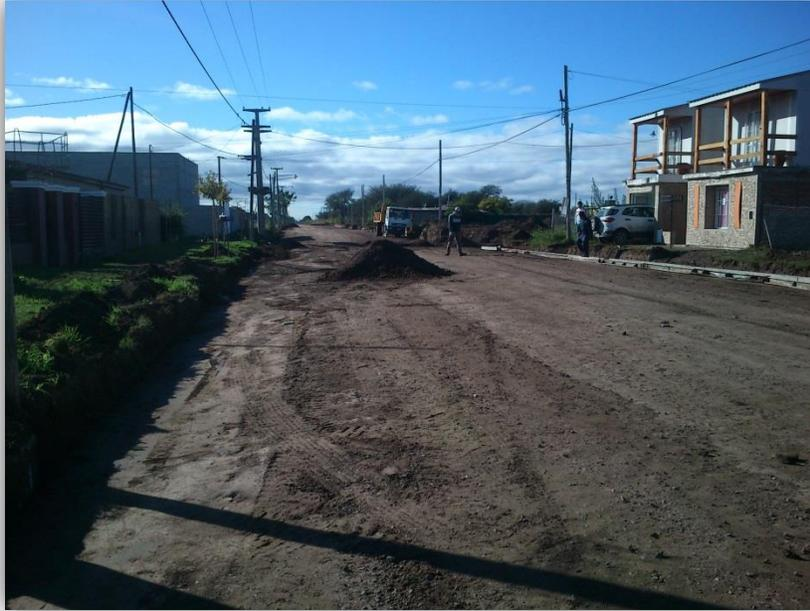
Figura 3.7: Subrasante compactada y perfilada en zona de cordon cuneta
