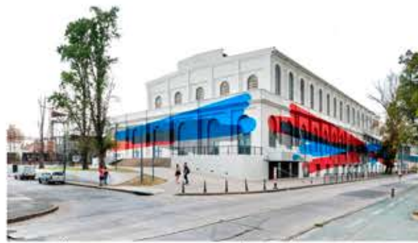
EX USINA TÉRMICA MENDOZA - PLAZA DE LA MÚSICA, CÓRDOBA
