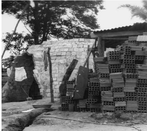
Figura 5: Cúpula de tijolos. Autor: arquivo pessoal de Nabil Bonduki
