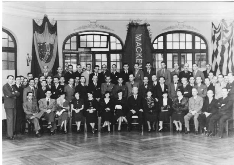
Figura 1. Formatura das turmas de Engenharia do Mackenzie College. São Paulo, 1931.
