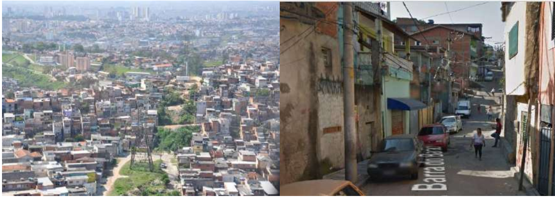
Imagem 01. Ocupações em topo de morro.
