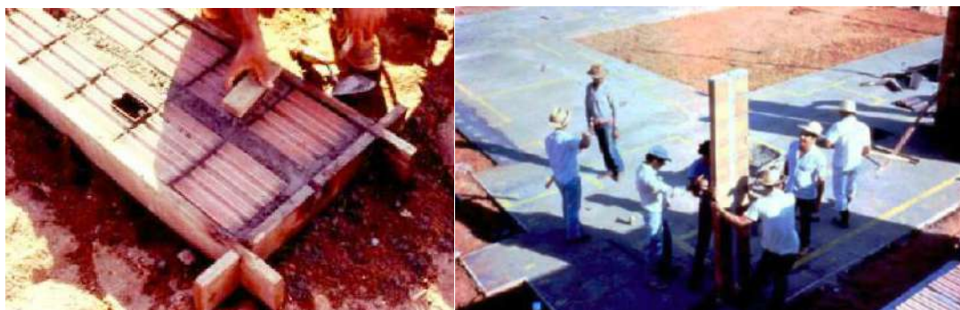
Figuras 7 e 8: Montagem do painel no canteiro de obras e construção das casas em Campinas. Fonte: Villa apud DUALIBI, 2013.
