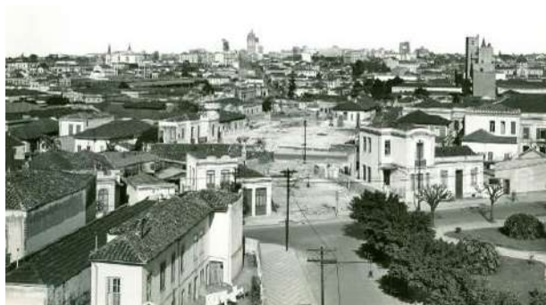
Imagem 03: Obras de prolongamento da Avenida São João, 1930. Excepcional tomada, tendo em plano intermediário o "Castelinho" da Rua Apa. Ao fundo, o centro da cidade, com destaque para Edifício Martinelli. Fonte: Acervo AHMWL – Arquivo Histórico Municipal Washington Luís.
