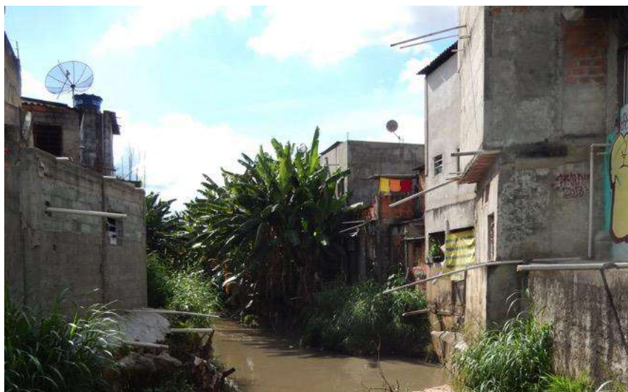
Imagem 03: Ocupação em beira de córrego. Fonte: Autores, 2015.
