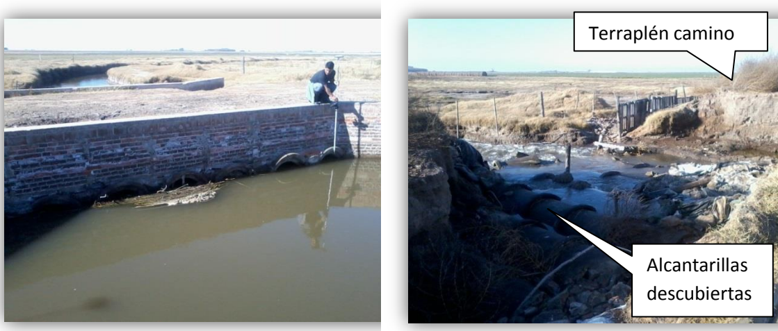
Figura 1.4-12 - Alcantarillas deterioradas
