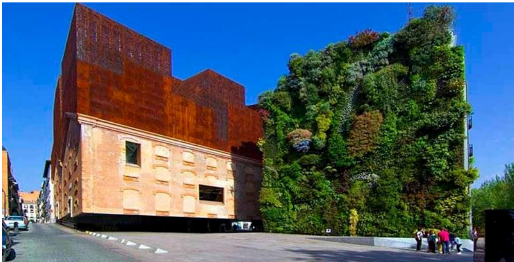
Figura 78. Herzog & de Meuron El Caixa fórum, Madrid, 2008.
