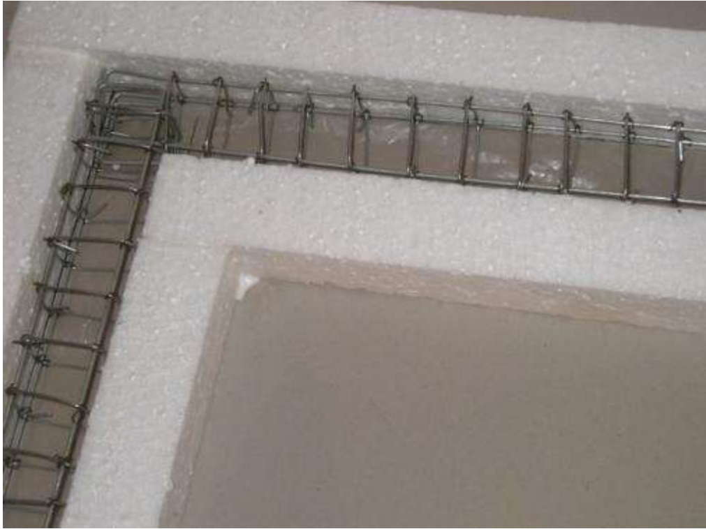
Figura 6. Estribado de vinculación viga - columna
