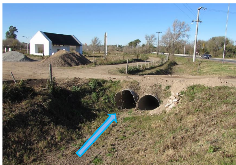
Figura 6.7 – Cruce del canal bajo el actual ingreso al loteo.
