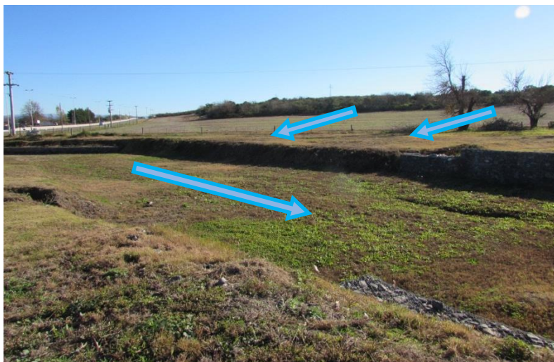
Figura 6.6 – Canal conductor en el cruce de la RP E-53.
