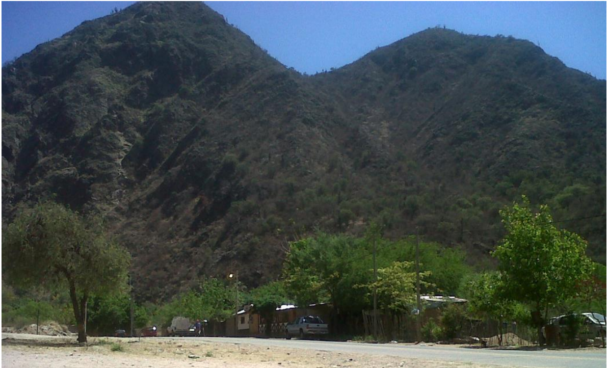
Ilustración 16: Vista ladera boquilla entrada Túnel N°1 – Prg. 1+840
