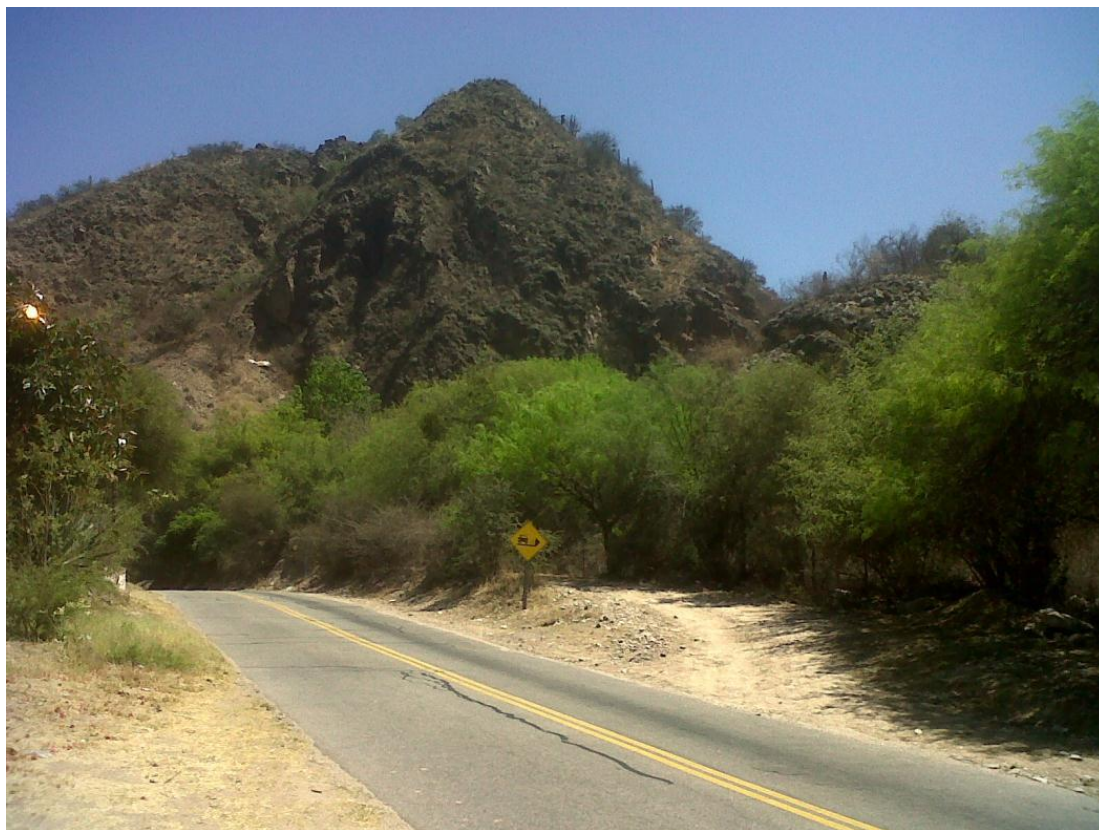
Ilustración 20: Vista ladera boquilla entrada Túnel N°2 – Prg. 3+380
