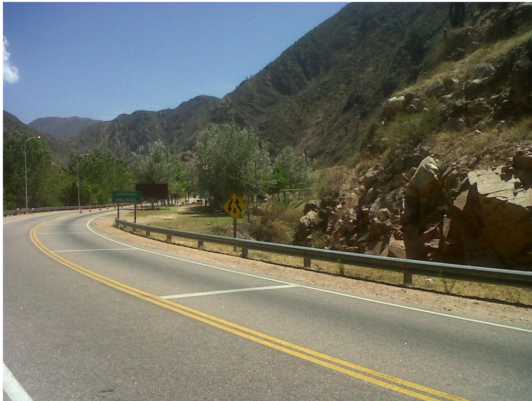
Ilustración 23: Vista Traza existente a repavimentar – Prg.4+750
