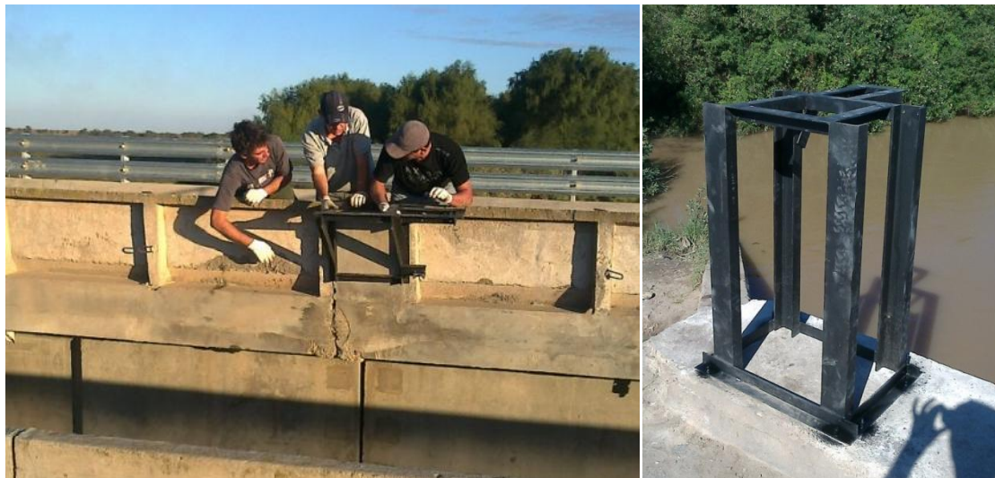
Figura 2.10 Instalación de soporte para limnómetro de Paso de Los Oscares (izq.) y el instalado en Paso de la Cina (der.)
