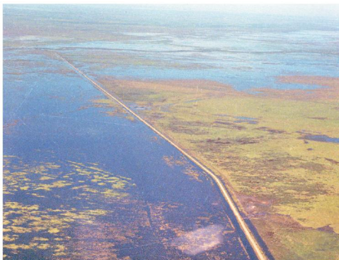
Figura 2.2 Vista aérea de la inundación en los Bañados del río Dulce a la altura del puente de Paso de la Cina, donde se aprecia el efecto de dique sobre la inundación en lámina que ejerce el camino que va hacia La Rinconada desde el oeste (Bucher, 2006)
