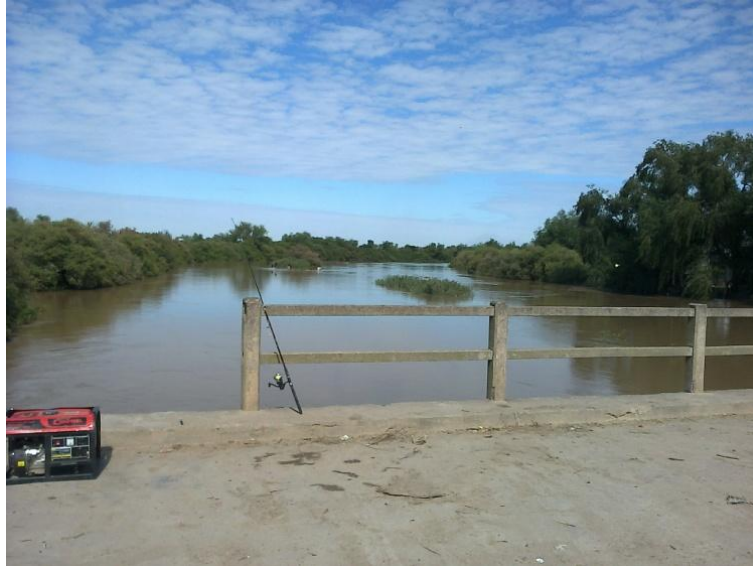
Figura 2.5 Vista aguas abajo del puente sobre el río Dulce en Paso de la Cina
