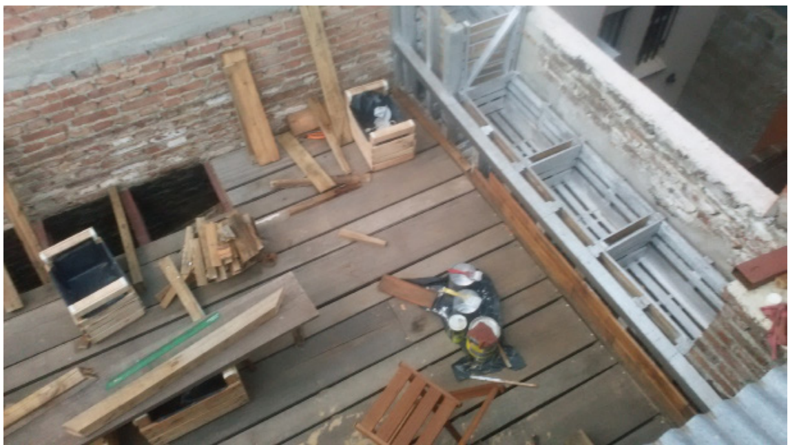
Fotografías del proceso constructivo de la estructura de la terraza según etapas
