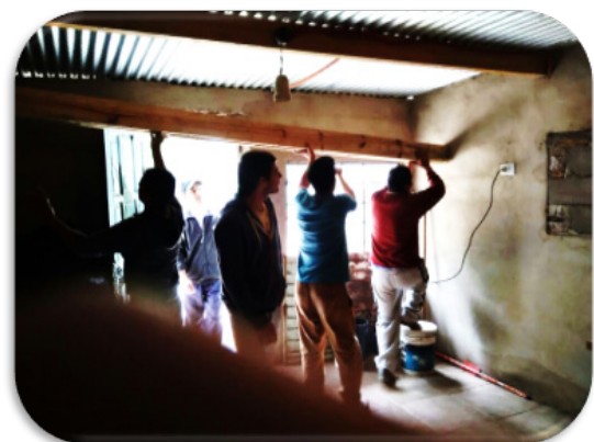
Imagen 8. Colocación de vigas
