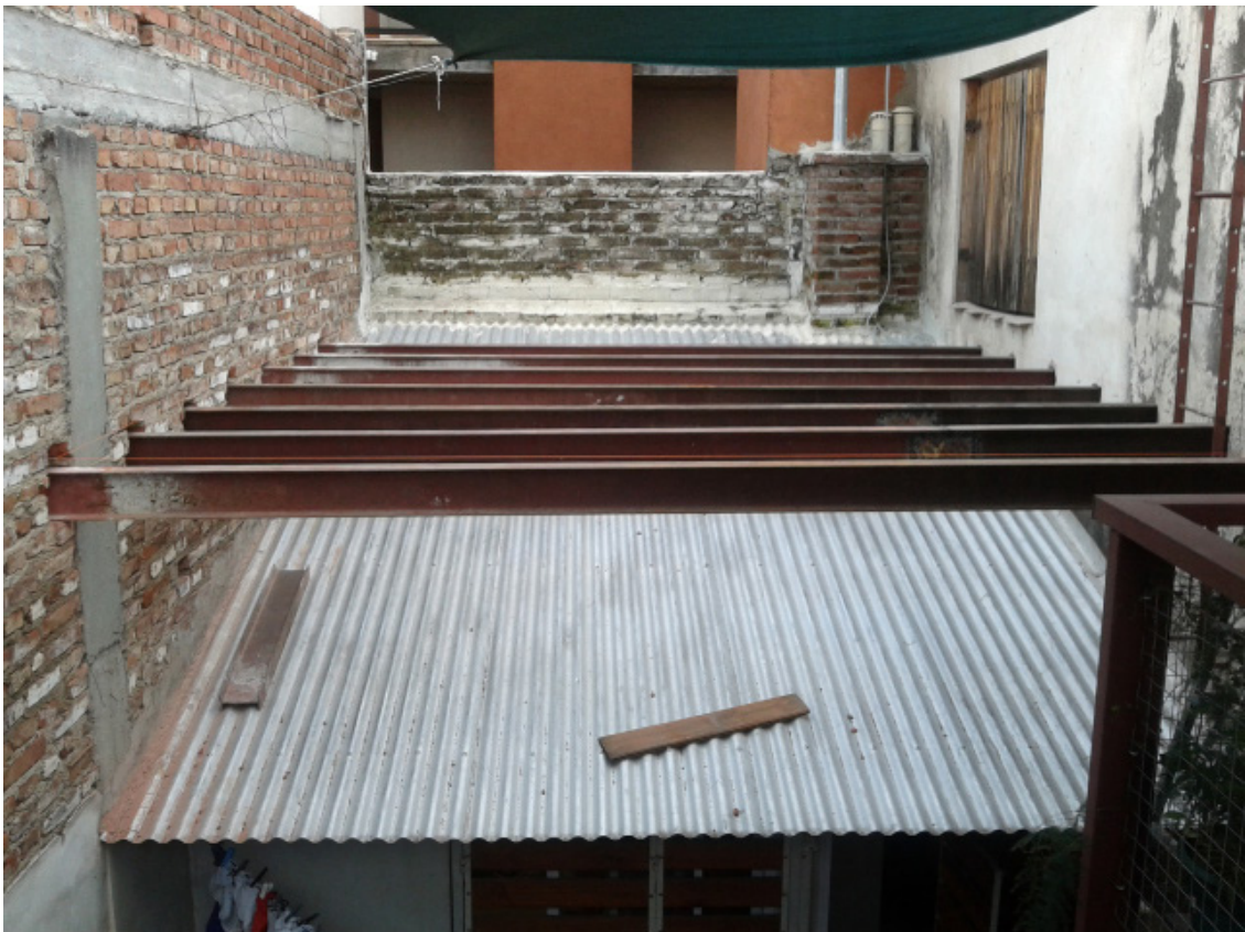
Fotografías del proceso constructivo de la estructura de la terraza según etapas
