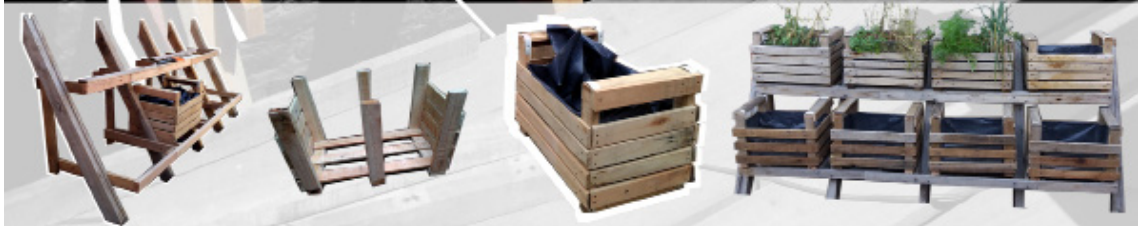
Fotografía de la construcción del soporte y cajones móviles para huerta.
