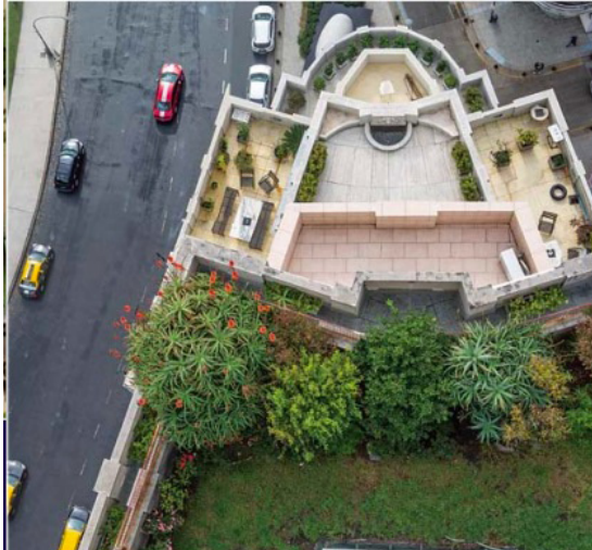
Foto: Edificio Kavanagh
