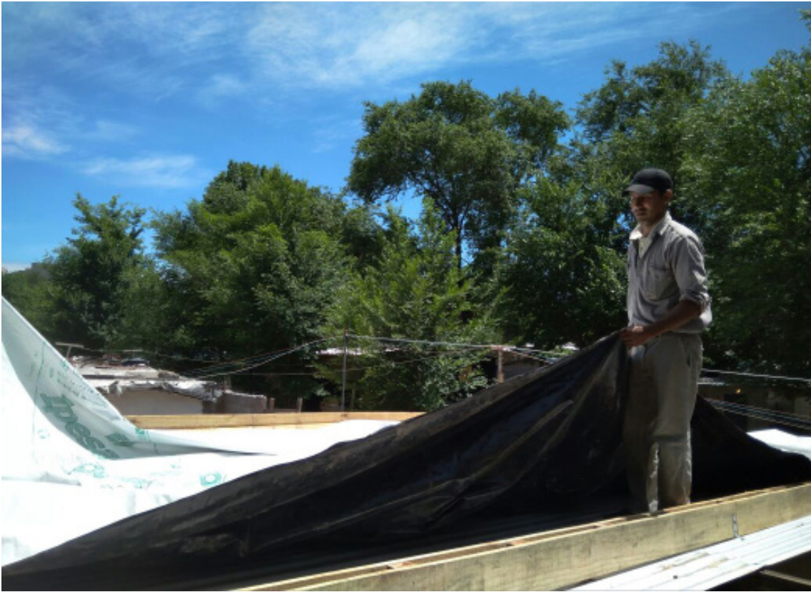
Imagen 11. Instalación del silo bolsa
