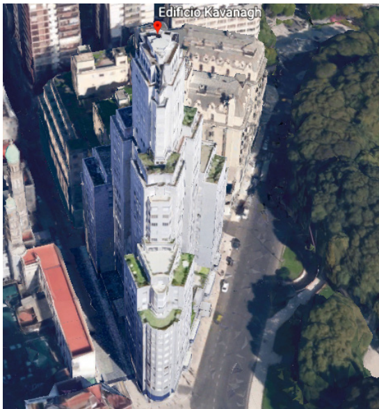
Foto: Edificio Kavanagh Fuente: Google earth
