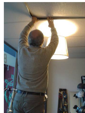
Figura 8. Ubicación de sensores en cámara de
