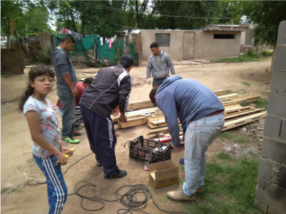
Imagen 9. Colocación de vigas
