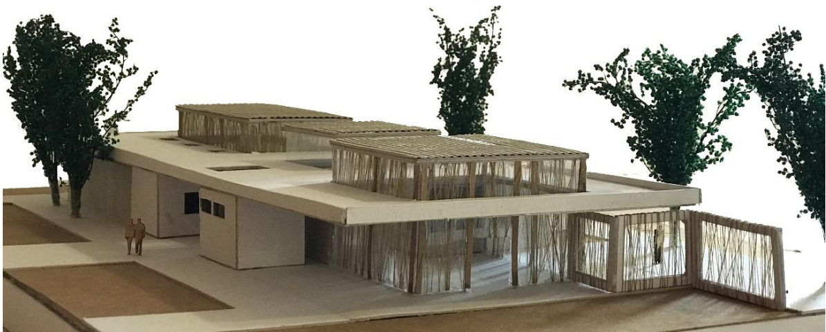
Fig. 32, 33 y 34. Maqueta 1:100. Se observan las transiciones y la relación con los espacios exteriores. Se aprecian los volúmenes vidriados con su materialidad que luego se repite en los distintos planos verticales para dar unidad al edificio. La cubierta es el gran elemento horizontal que unifica todo el proyecto.
