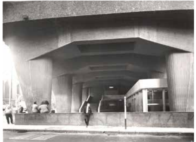
Imagen 2. Edificio República (Teléfonos del Estado), Avda. Corrientes esq. Maipú, Bs. As., Santiago Sánchez Elía, Federico Peralta Ramos, Alfredo Agostini (SEPPA). (proyecto de 1950). Fotografía: Manuel Gómez Piñeiro. Cortesía Esteban Guillermo Urdampilleta.
