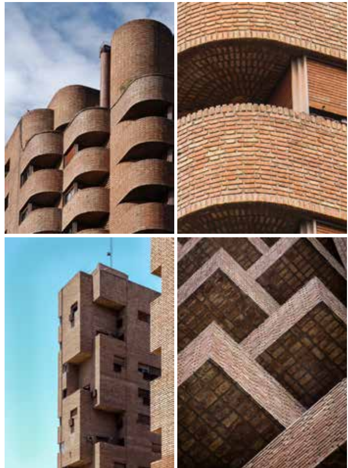
> Fig. 01: Diversos detalles en el trabajo del ladrillo como envolvente.
