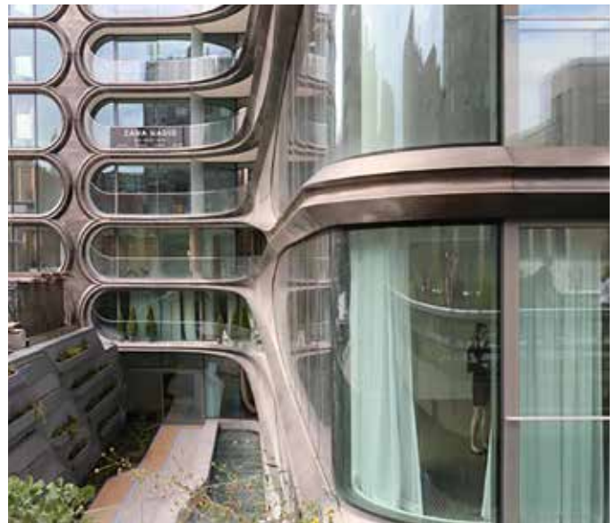
Zaha Hadid, edificio de residencias 520 West 28th, en New York. (Fotografías tomada por el autor)
