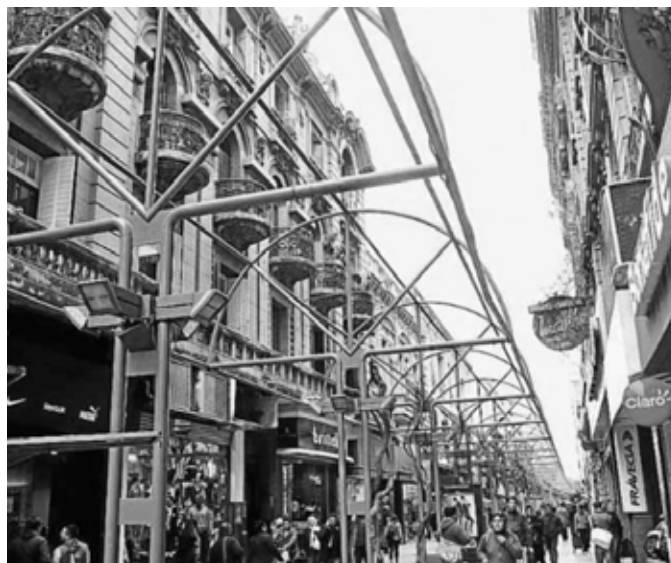
Fig 2: Las pérgolas de la peatonal de Córdoba, salvadas por la reacción ciudadana años atrás, pero despojadas de sus enredaderas que le proveían sombra: las malas prácticas en espacios urbanos de calidad.
