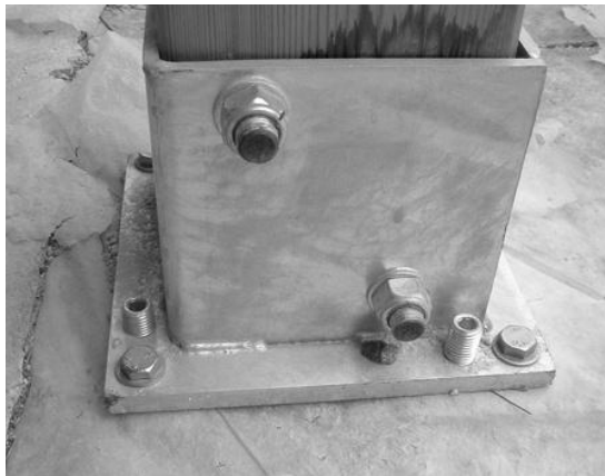
ANCLAJES METÁLICOS PARA COLUMNAS DE MADERAS
