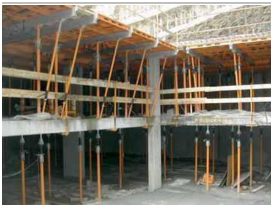
Sistema terminado, solo falta colar el hormigón
