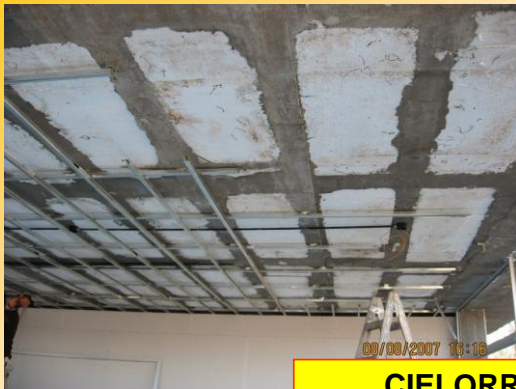
CIELORRASOS ARMADOS SUSPENDIDOS, realizados en PLACAS de yeso/cartón DURLOCK
