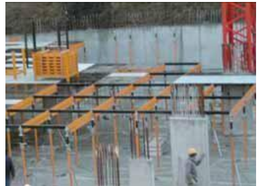
Con los paneles y las vigas en su posición se quitan las varas y los paneles quedan colocados en su sitio
