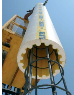
Armado de armaduras y colocación del encofrado
