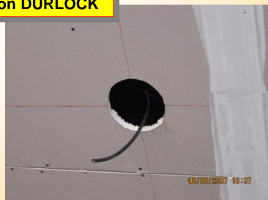
CIELORRASOS ARMADOS SUSPENDIDOS, realizados en PLACAS de yeso/cartón DURLOCK
