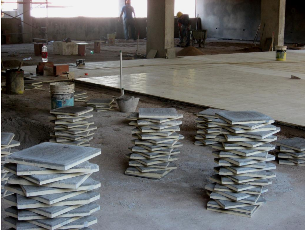
Estivado del material, próximo a su lugar de colocación.
