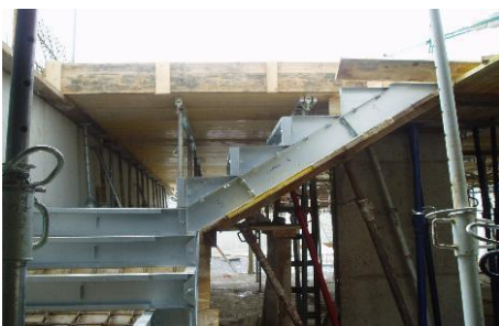
Encofrado de chapa galvanizada
