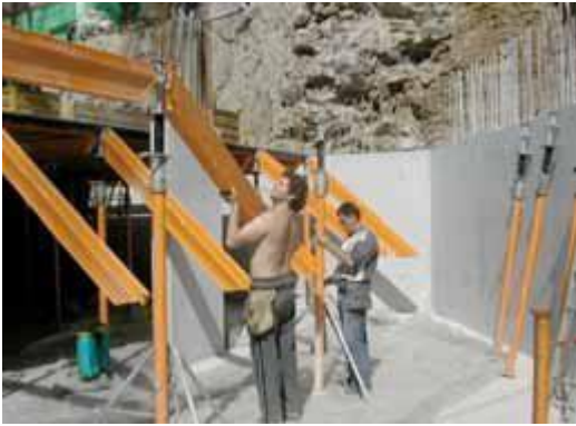
Primero instalaremos las vigas de un costado.
