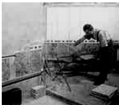
La guarda será el eje de la colocación del revestimiento cerámico.
