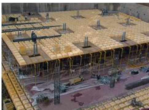
Vista final de un encofrado para losa nervurada
