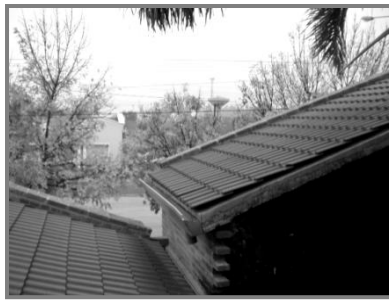
Cubierta de tejas cemento
