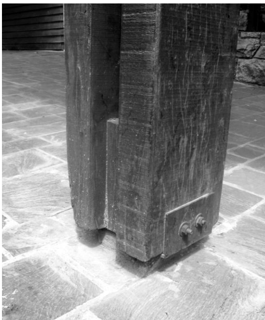
ANCLAJES METÁLICOS PARA COLUMNAS DE MADERA
