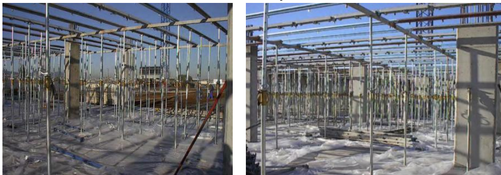
Armado del esqueleto, conformado por banquetas y sobre banquetas de arriostamiento transversales
