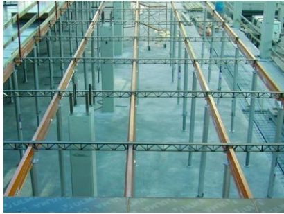
Montado de puntales y vigas
