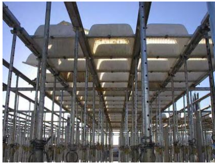
Colocación de los casetones plásticos
