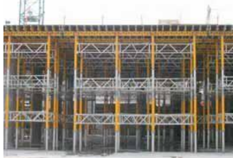
Estructura de soporte. Estructura inferior vertical compuesta por puntales y arriostramientos
