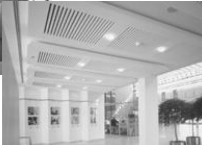
CIELORRASOS SUSPENDIDOS de placas de roca de yeso "KNAUF"
