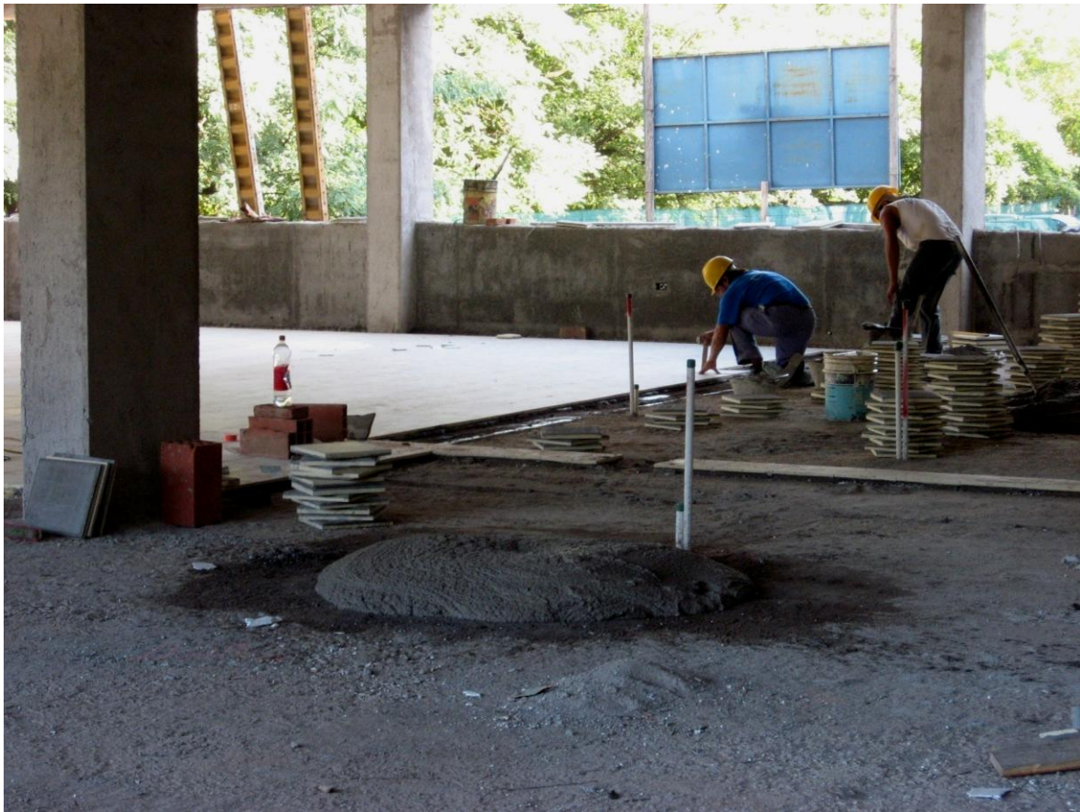
Realización de fajas guía a nivel entre reglas.
