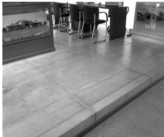
Placa pre losa utilizada en piso /entrepiso terminación cemento alisado visto.
