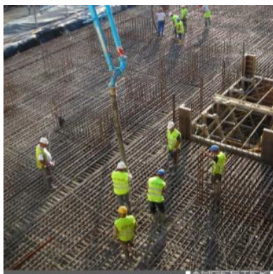
Colado del hormigón
