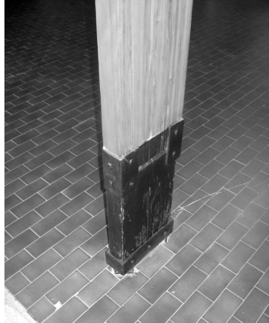
ANCLAJES METÁLICOS PARA COLUMNAS DE MADERA
