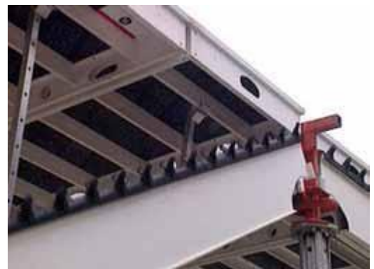
Con ayuda de unas varas colocamos los paneles en posición. Instalamos la viga del otro costado.
