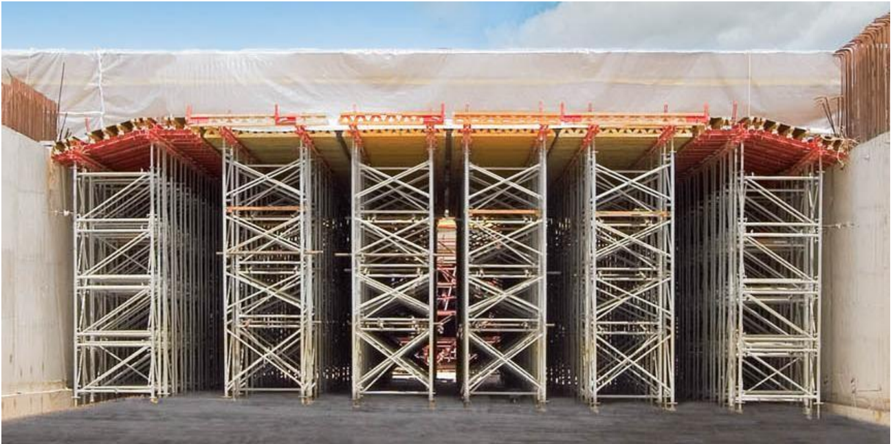
Conjunto de mesas encofrantes para el cierre horizontal. Vínculos con los tabiques Laterales ya desencofrados
