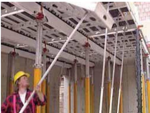
Con ayuda de unas varas colocamos los paneles en posición. Instalamos la viga del otro costado.
