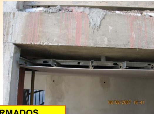
CIELORRASOS ARMADOS SUSPENDIDOS, realizados en PLACAS de yeso/cartón DURLOCK
