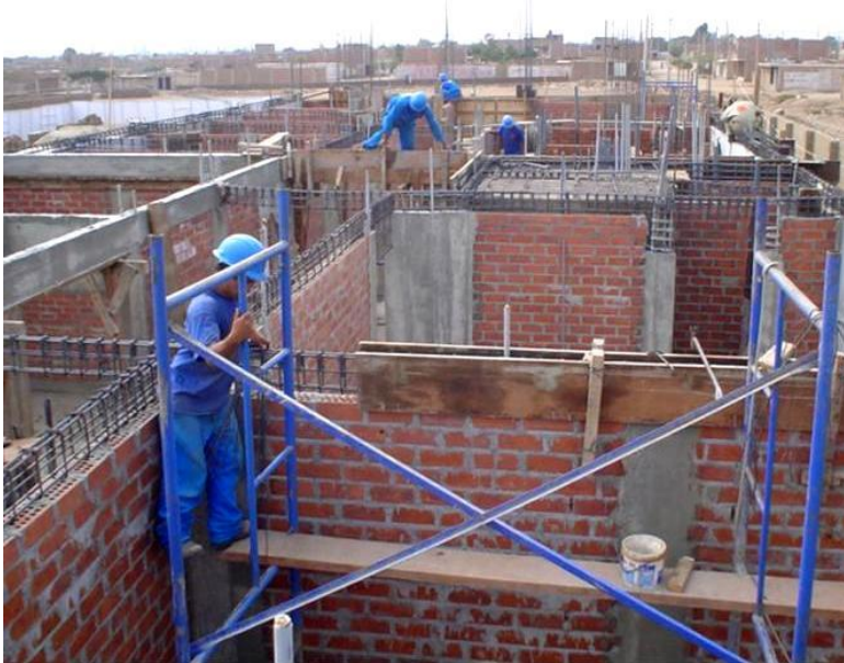
Estructura independiente de vigas y columnas. Armado de encofrado de vigas.
