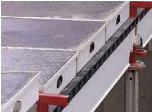
Con los paneles y las vigas en su posición se quitan las varas y los paneles quedan colocados en su sitio
