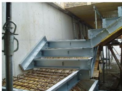
Primero se arma el fondo, luego se coloca la AS (armaduras) y luego se armarán, los encofrados para las contrahuellas y sus laterales
