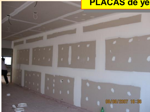
CIELORRASOS ARMADOS SUSPENDIDOS, realizados en PLACAS de yeso/cartón DURLOCK
