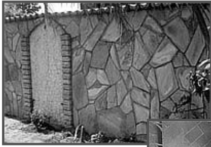
PISO y REVESTIMIENTOS DE LAJAS DE PIEDRA NATURAL
