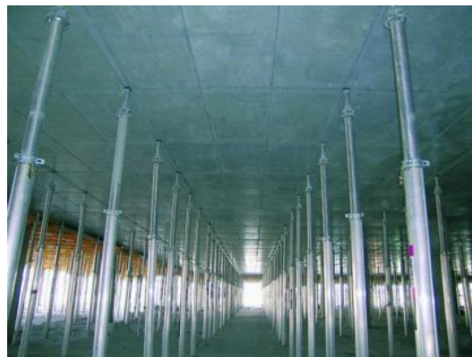
Vista inferior, ya sacados los paneles horizontales el hormigón a la vista
