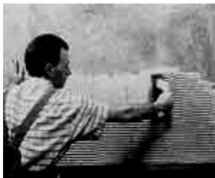
La guarda será el eje de la colocación del revestimiento cerámico.
