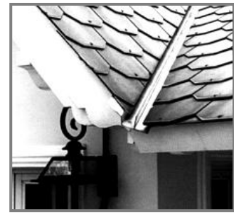
Cubierta de tejas asbesto
