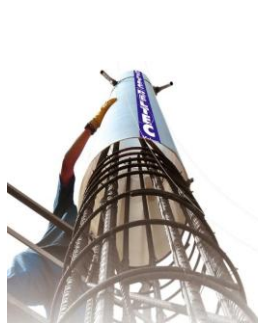
Armado de armaduras y colocación del encofrado
