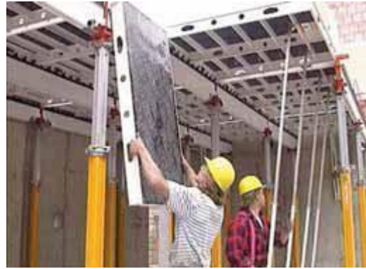
De la viga vamos colgando los paneles.
