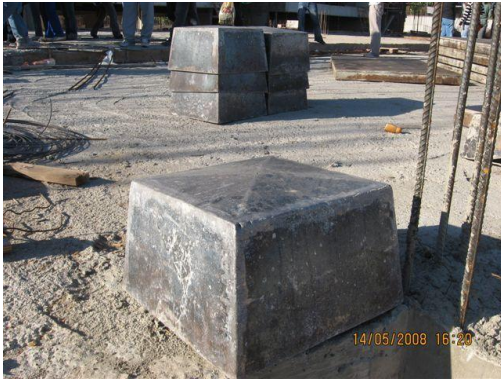
Encofrado para losa alivianada con casetones
