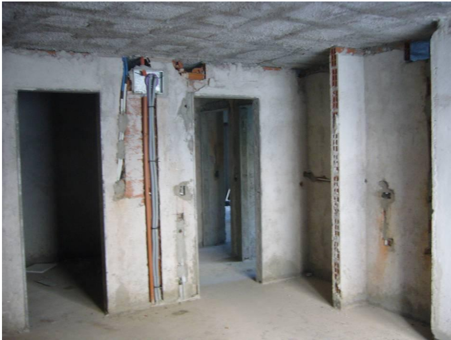
Figura 3.4 Carpeta ejecutada e instalaciones en pared abiertas
