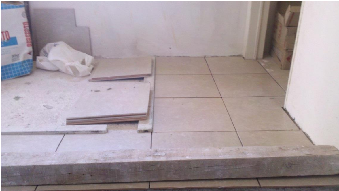
Figura 3.11 Tareas de Colocación de Cerámicos
