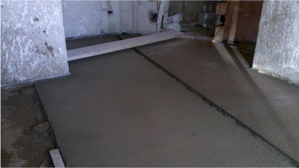
Figura 3.3 Ejecución de la Carpeta
