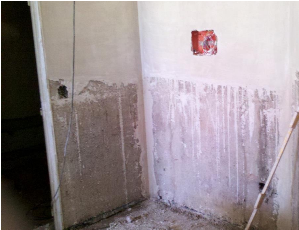
Figura 3.1 Trabajo de Enlucido de Yeso
