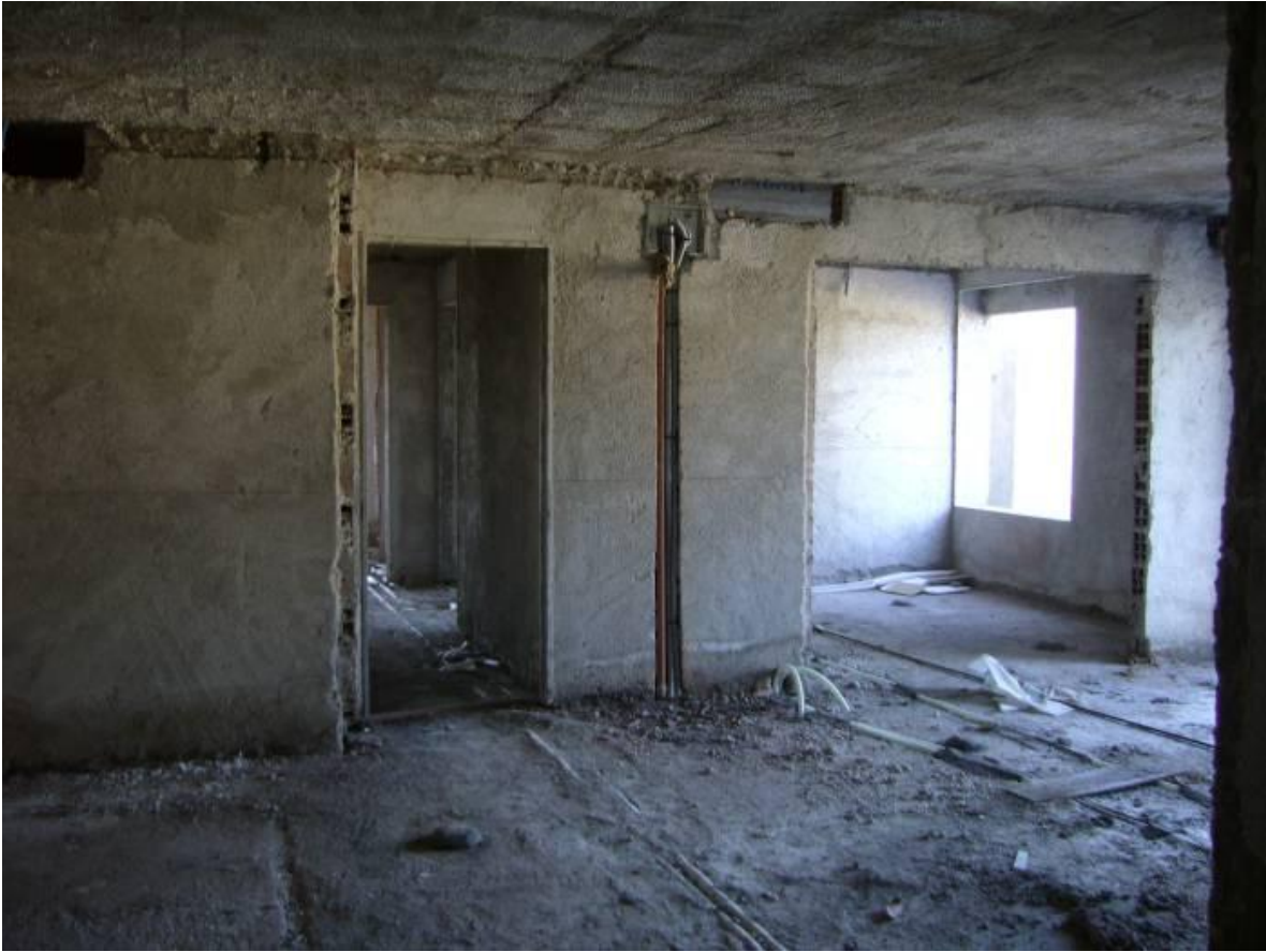
Figura 3.6 Revoque Grueso Ejecutado
