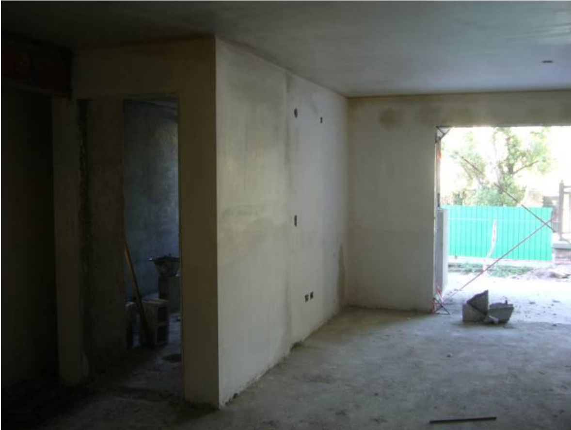
Figura 3.5 Carpeta ejecutada e instalaciones cerradas
