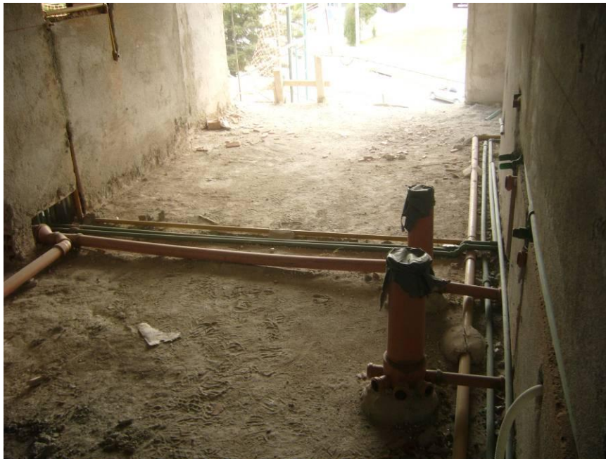
Figura 3.2 Instalaciones antes de la confección de la carpeta
