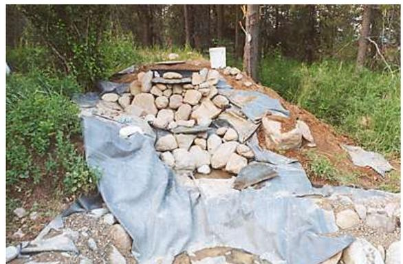
Figura 25 Colocación y sujeción de la lona.
