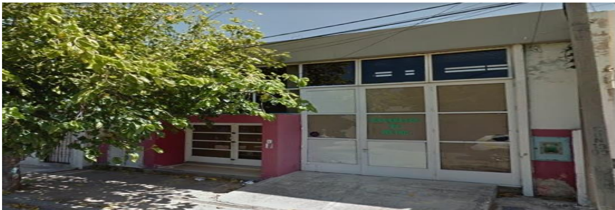
Figura 19: Fachada de la empresa
