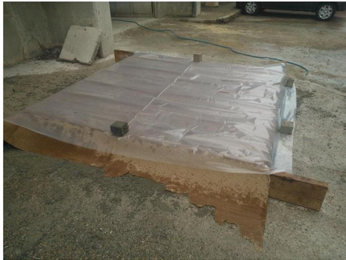
*Figura 7.5 Colocación de Nylon sobre cartón corrugado.*
