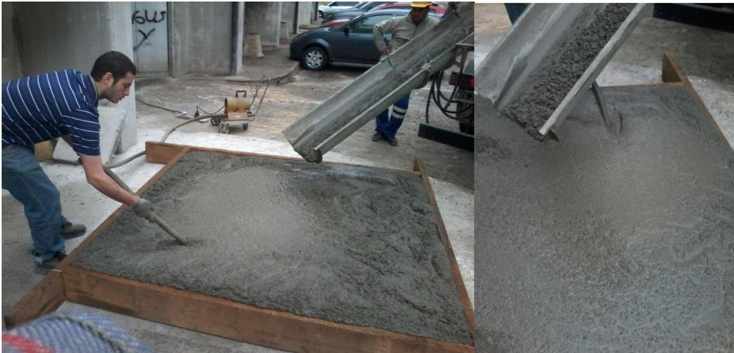
*Figura 7.2 Momento de hormigonado y vibrado de la losa.*
