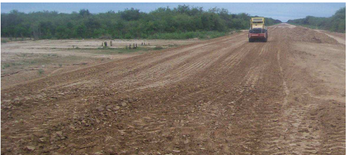
Fig.4.151: Compactación de capa con rodillos pata de cabra. Sección III.
