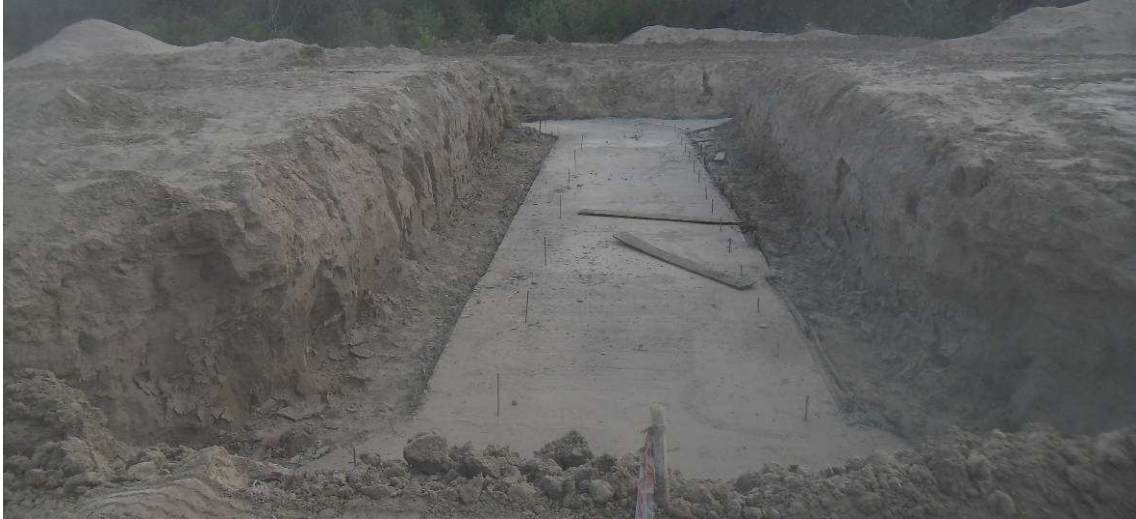
Fig.4.89: Losa inferior de alcantarilla de una boca. Prog. 13+010 Sec. III.
