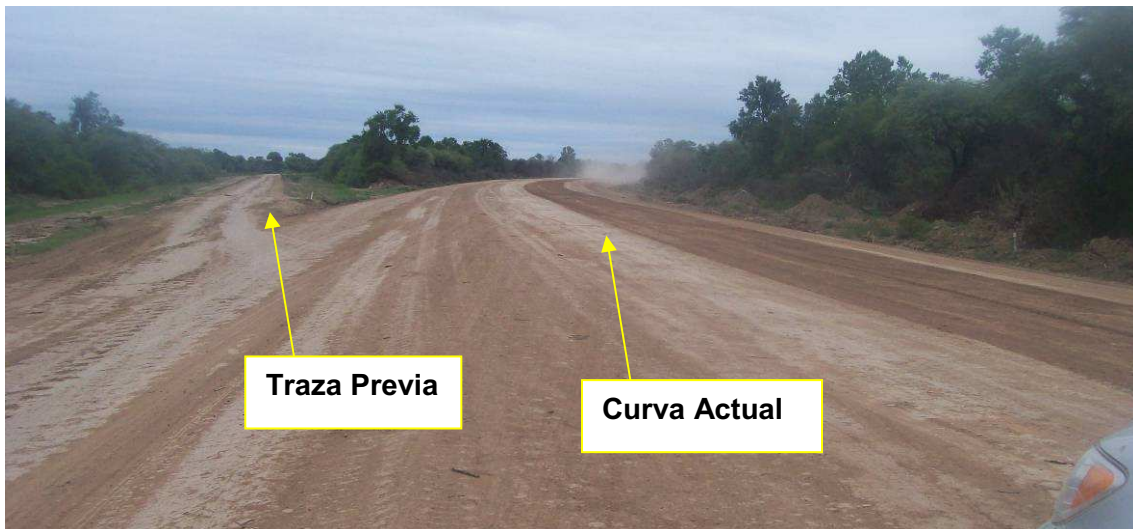
Fig.4.184: Rectificado de curva VC1 en Sección III.
