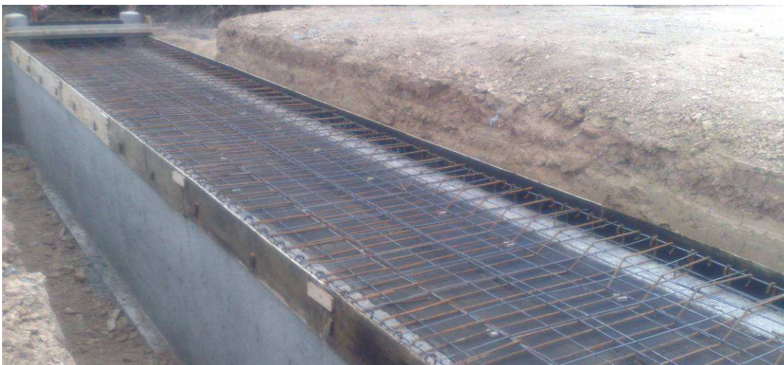
Fig.4.104: Armadura de losa superior de alcantarilla de una boca. Prog. 5+200 Sec. II
