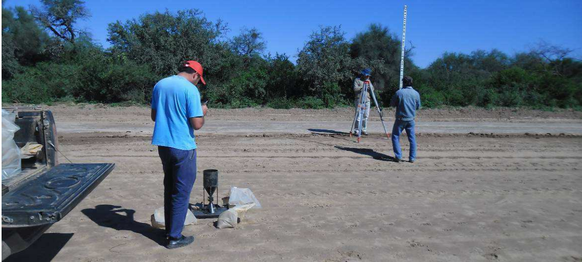
Fig.4.166: Tomando niveles en capa terminada. Sección III.
