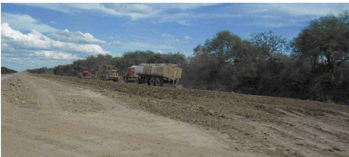
Fig.4.138: Escarificado, distribución y regado del suelo. Sección III
