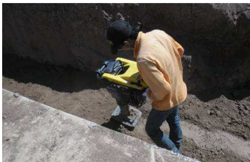
Fig.4.109: Compactación con pisón mecánico en unión alcantarilla – terraplén. Sec. II
