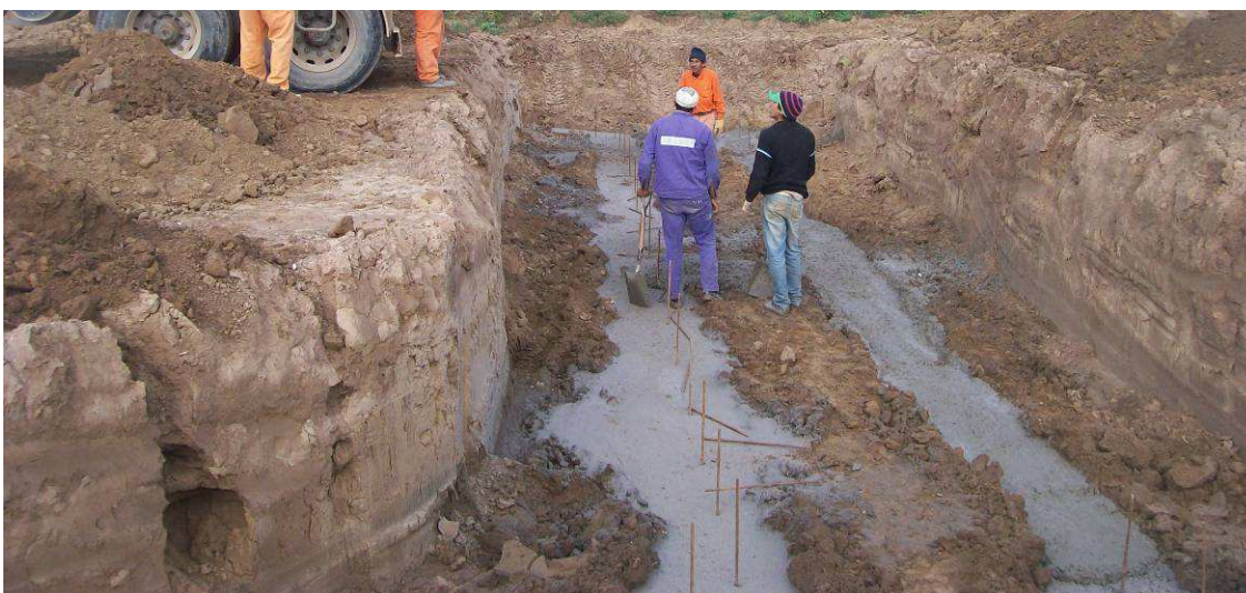
Fig.4.82: Hormigonado de fundaciones de alcantarilla. Prog. 28+500 Sec.II
