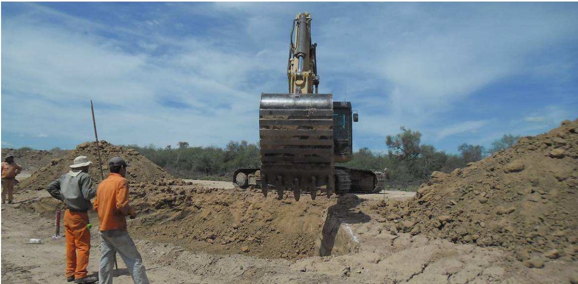
Fig.4.75: Retroexcavadora Caterpillar 323D ejecutando la apertura en terraplén para emplazamiento de alcantarilla. Prog. 10+900 Sec. II.
