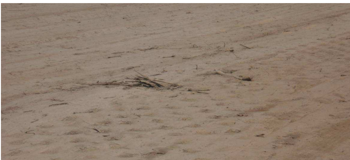
Fig.4.126: Presencia de ramas y raíces sobre base de asiento compactada. Progresiva 12+700 Sec.III.
