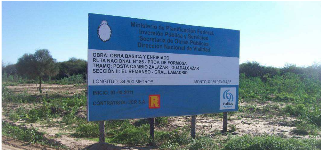
Fig.4.196: Cartel de Inicio de Obra en comienzo de Sección II
