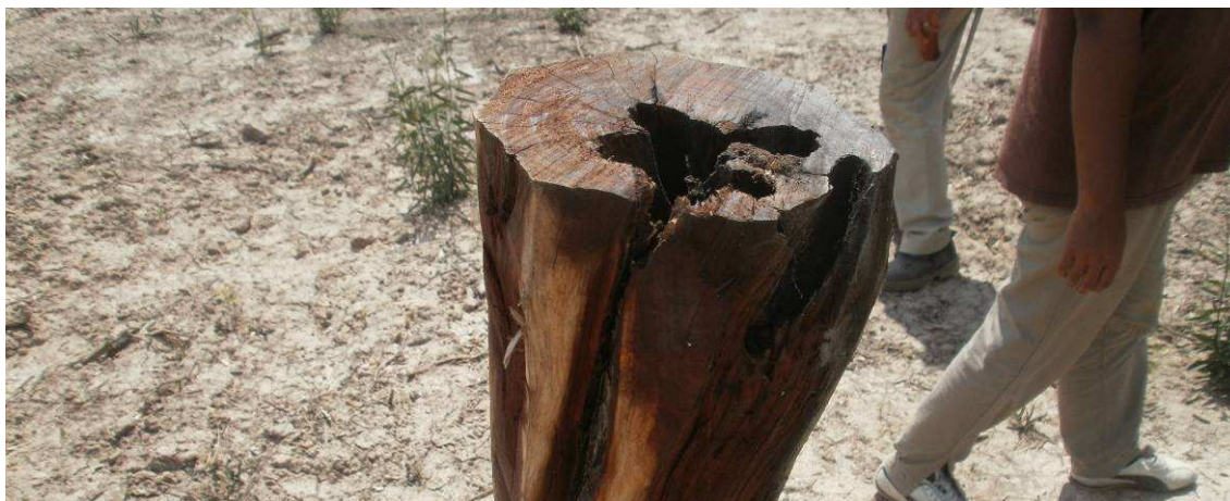
Fig.4.58: Poste en mal estado rechazado por inspección previamente en obrador. Postado entre Prog. 0+000 y 1+500 lado derecho, Sección III.
