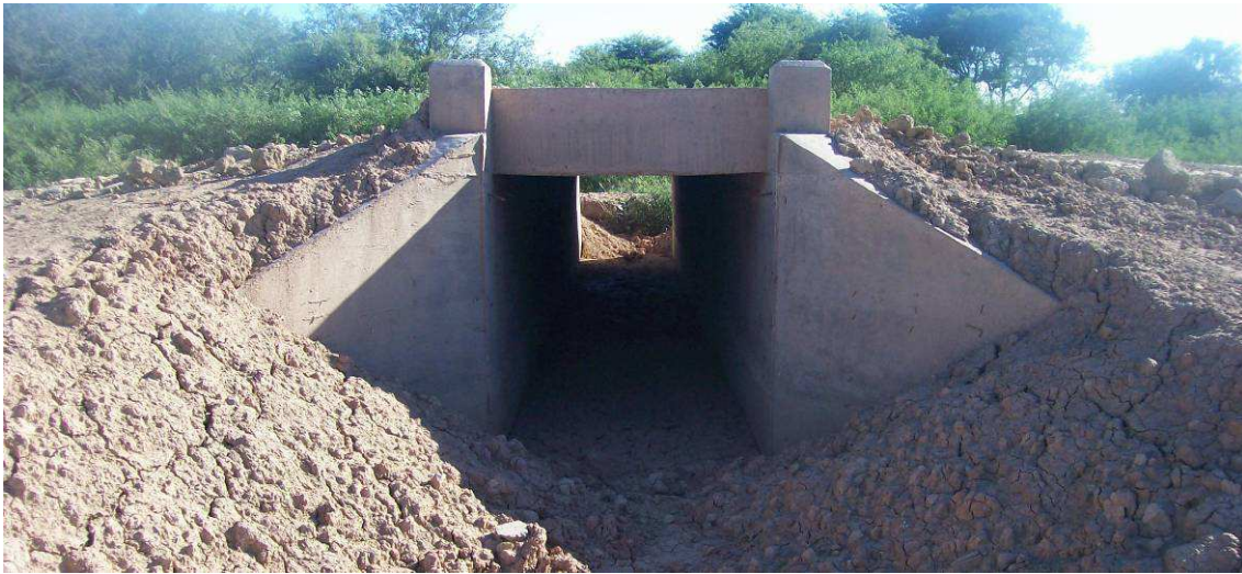
Fig.4.113: Alcantarilla transversal lista. Prog. 29+505 Sección III.
