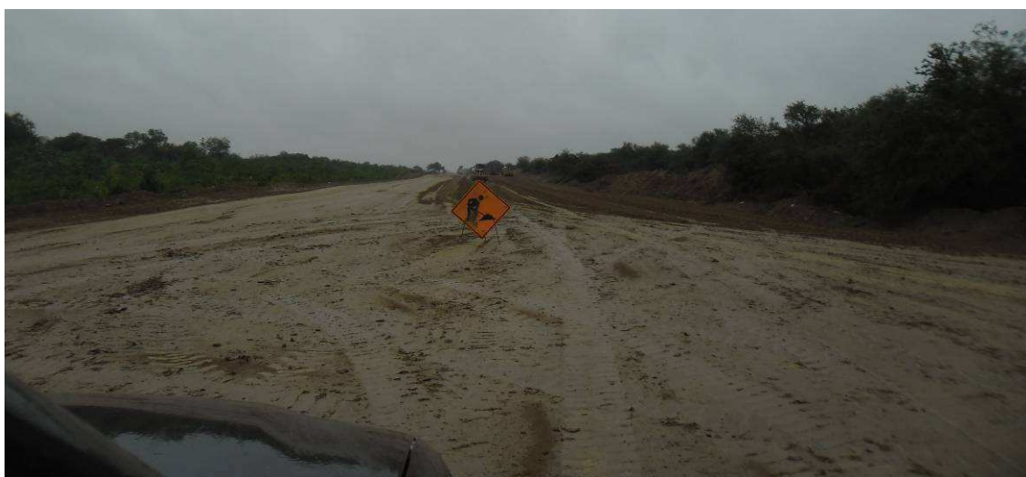
Fig.4.191: Cartel indicador de Hombres trabajando en zona de trabajo. Sección III.
