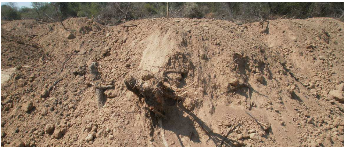
Fig.4.124: Presencia de ramas y raíces de gran tamaño en montículos de suelo descargados en Progresiva 12+500 Sec.III.
