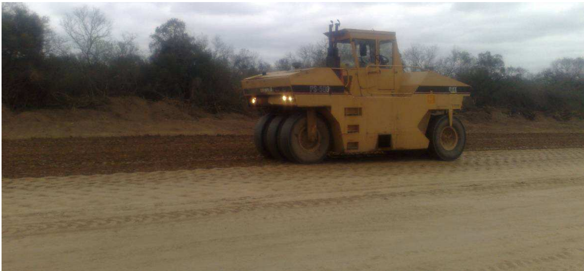
Fig.4.148: Sellado de capa con compactador neumático Caterpillar. Sección III.
