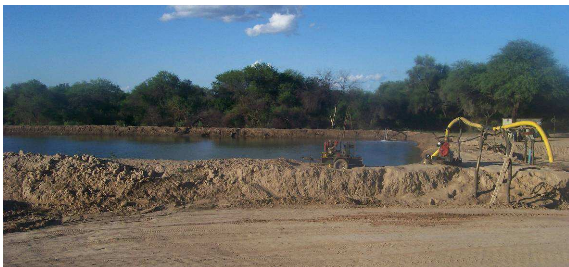
Fig.4.34: Reservorio de agua por perforación y bombeo en El Remanso. Las paredes de la reserva, sobre el nivel de terreno natural, funcionan como dique para contener el agua dentro del reservorio gracias a su baja permeabilidad.
