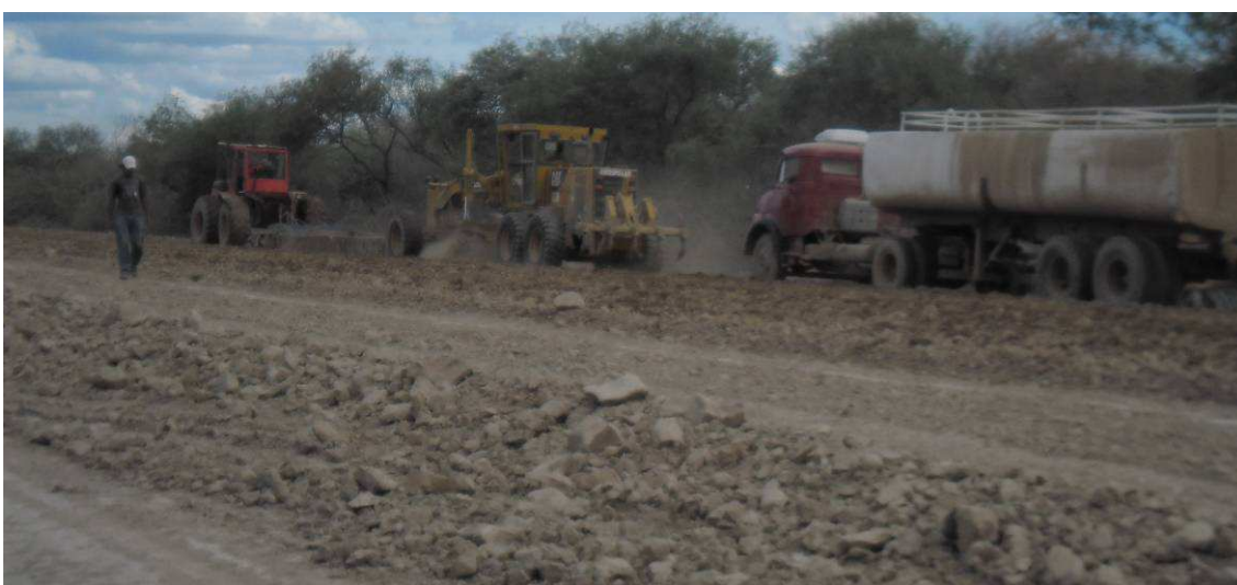
Fig.4.139: Escarificado, distribución y humectado del suelo. Sección III.
