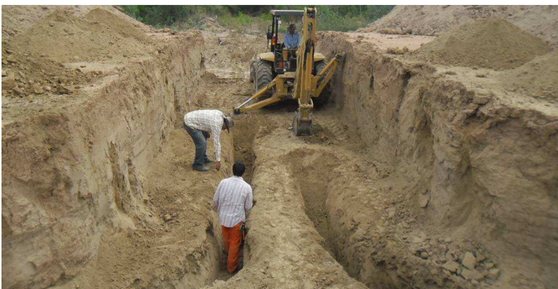
Fig.4.78: Apertura de zanja para fundaciones de alcantarilla. Prog. 18+000 Sec.II.
