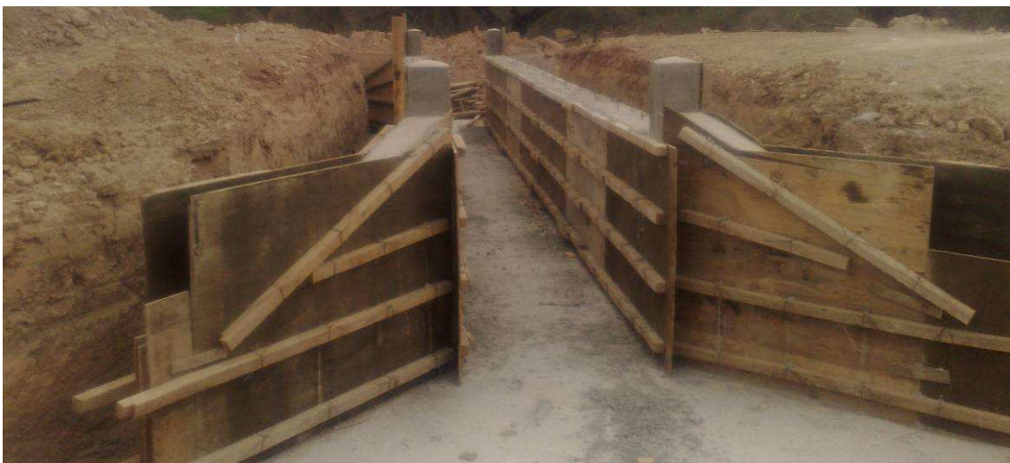
Fig.4.99: Alcantarilla de una boca con muros laterales listos. Prog. 5+600 Sec. II.
