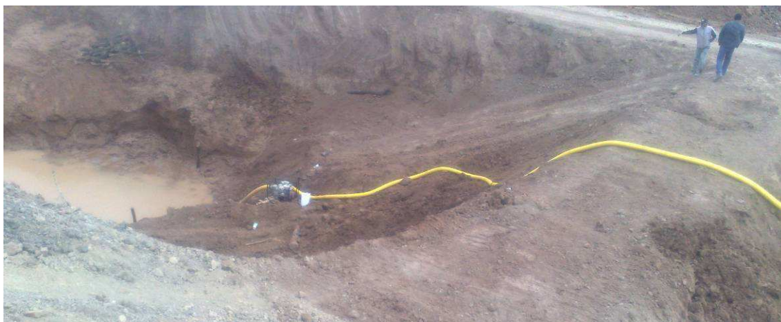
Fig.4.33: Traspaso del agua de una fosa a otra en préstamo ubicado en Sección II.
