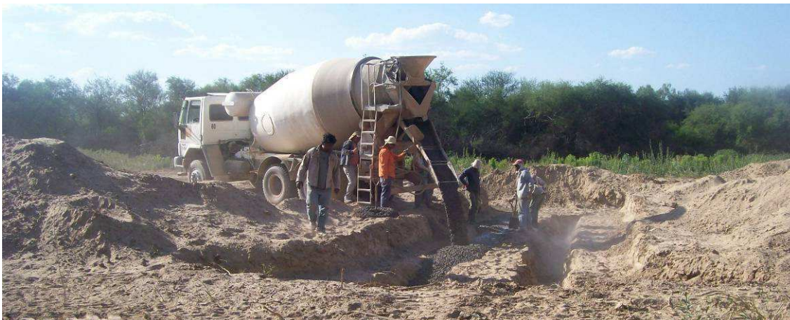
Fig.4.80: Hormigonado de fundaciones de alcantarilla. Prog. 13+010 Sec.III.
