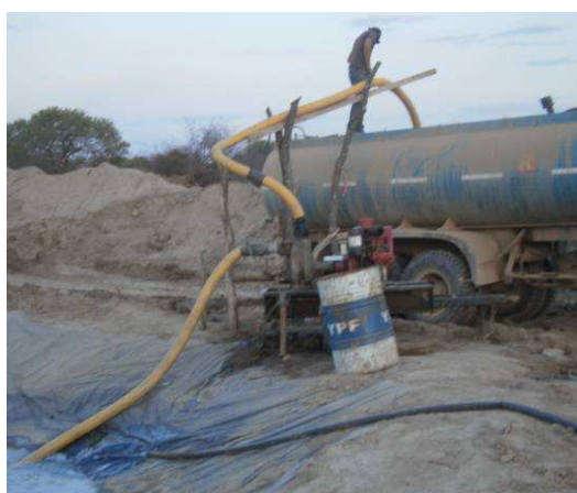
Fig. 8.21: Carga de agua en camión cisterna
