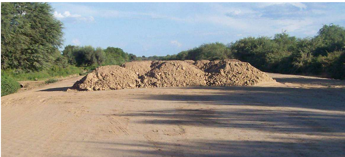
Fig.4.137: Descarga de suelo sobre capa de terraplén. Sección III
