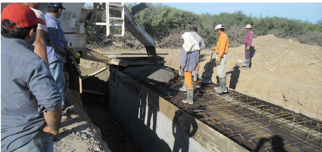
Fig.4.106: Hormigonado de losa superior de alcantarilla de una boca. Prog. 5+200 Sec. II
