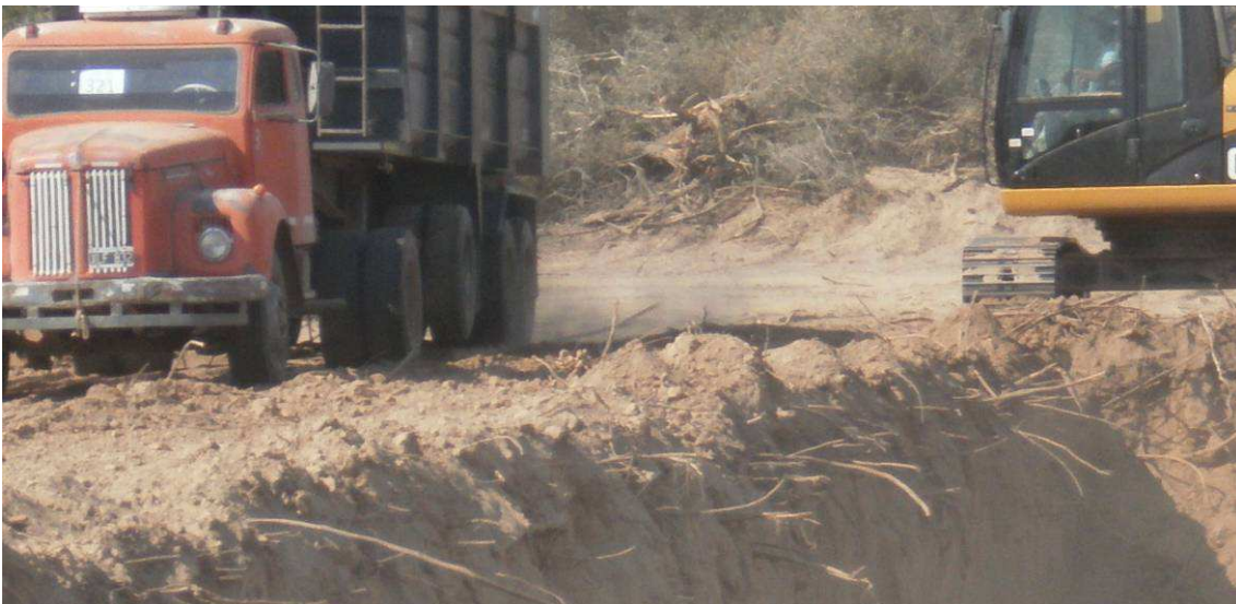
Fig.4.117: Presencia de raíces y ramas en primeras capa de préstamo en Progresiva 13+000 Sec.III.
