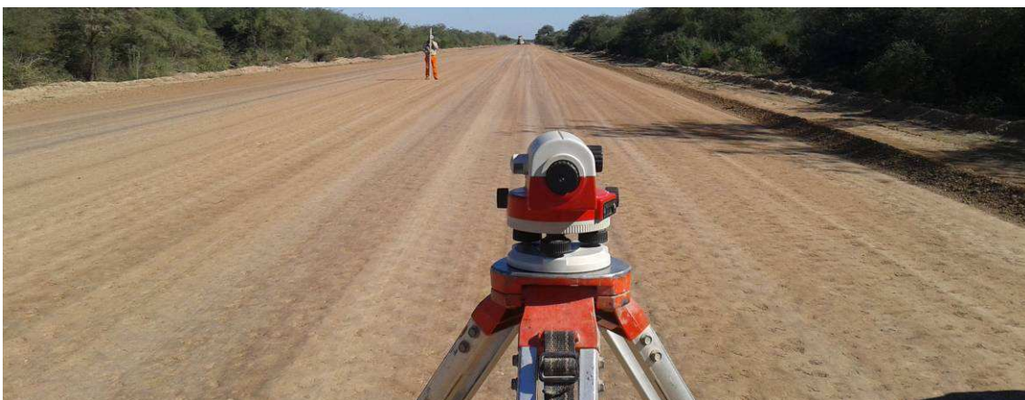
Fig.4.165: Tomando niveles en capa terminada. Sección II.
