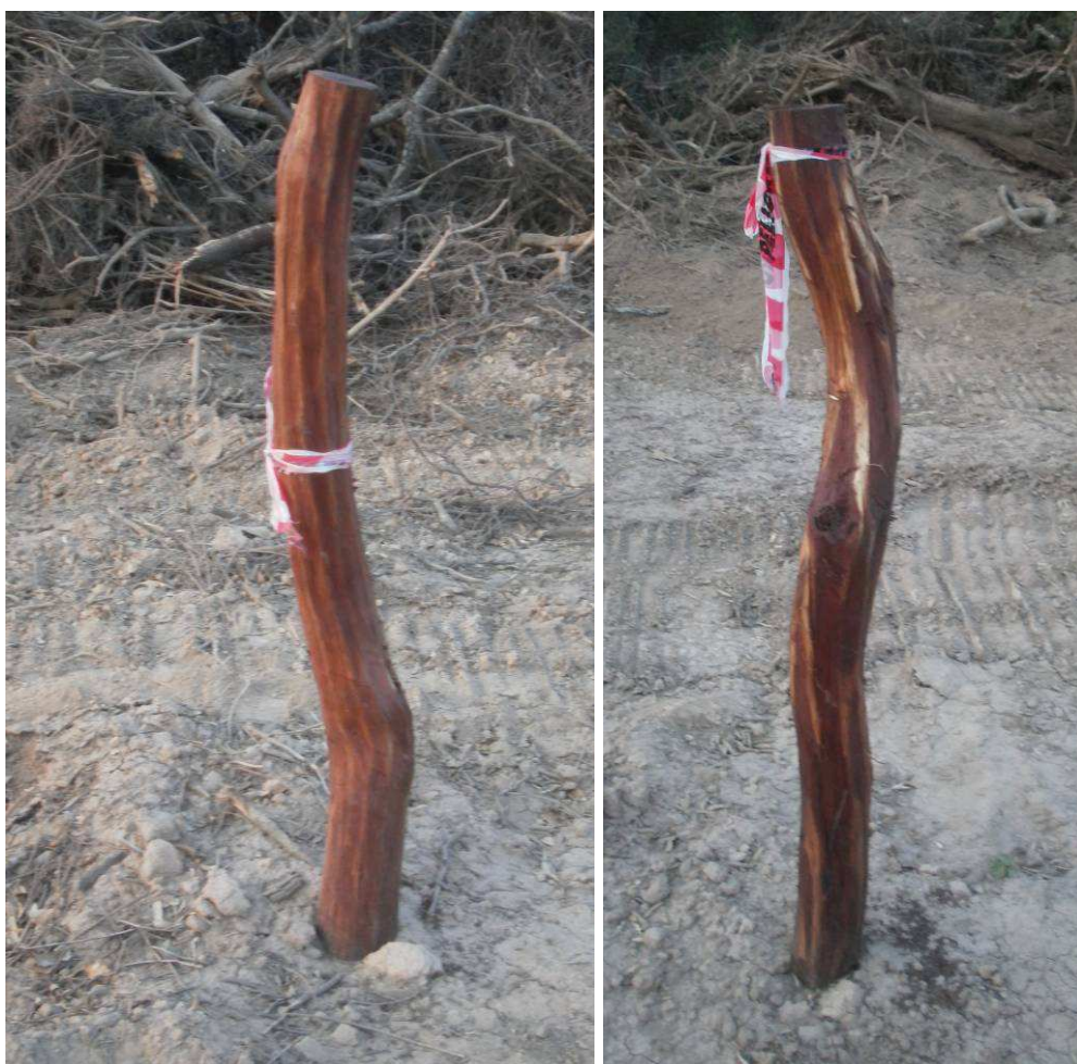
Fig.4.67 (Izq.): Poste rechazado por flecha mayor a la admisible (10cm). Descartado Prev. Por inspección en obrador.
