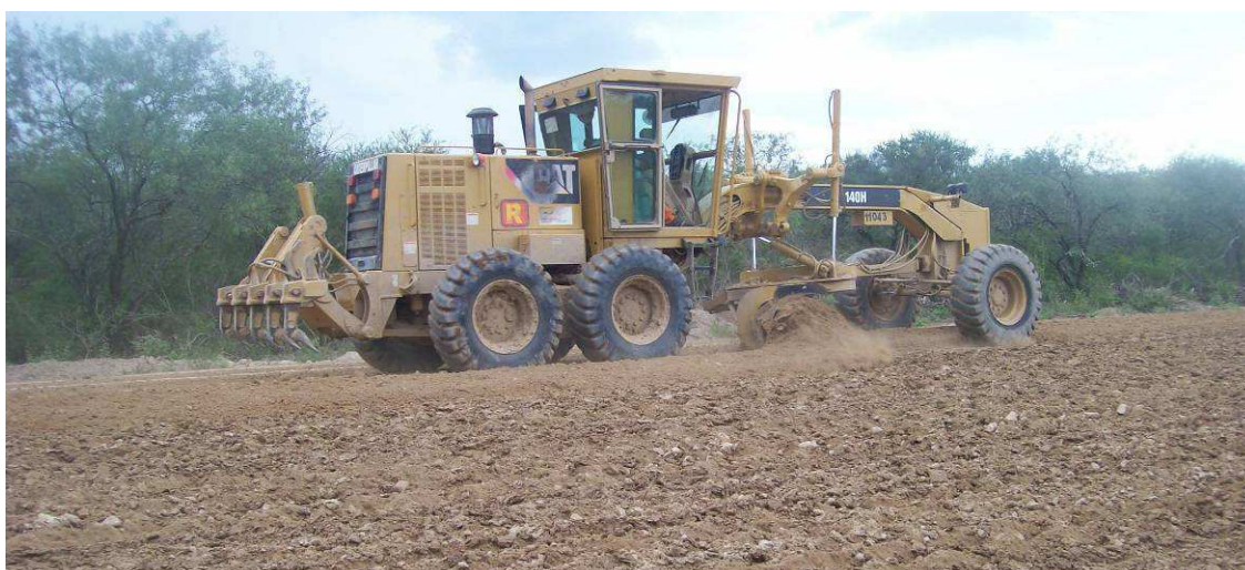
Fig.4.142: Motoniveladora 140H. Trabajando sobre la distribución del suelo en cancha. Prog. 24+400 Sec. II.
