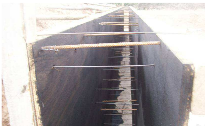
Fig.4.97: Vista del interior del encofrado de muros laterales de alcantarilla de una boca en Prog. 14+535 Sec. III.
