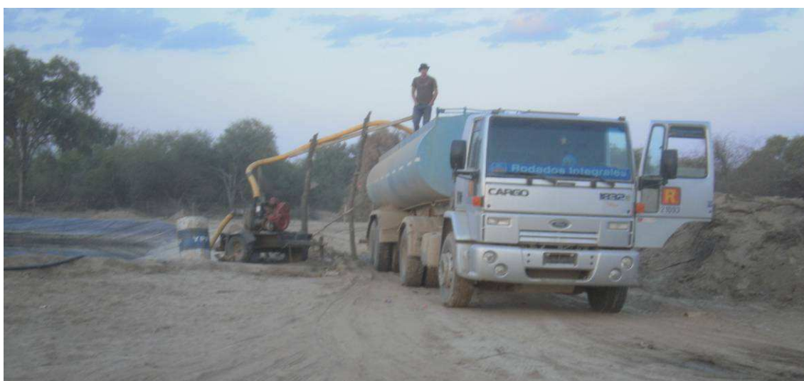
Fig.4.20: Bombeo del agua de la reserva al camión regador.
