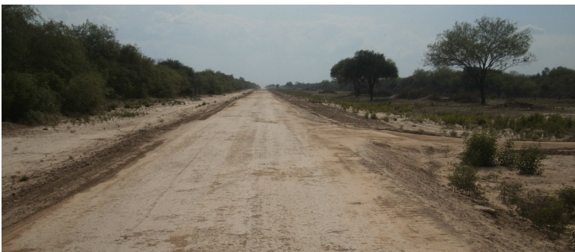
Fig.4.42: Sector de margen derecha de Sec. III donde no se realizo un desbosque selectivo. Solo se dejaron tres árboles en pie en 500 metros.
