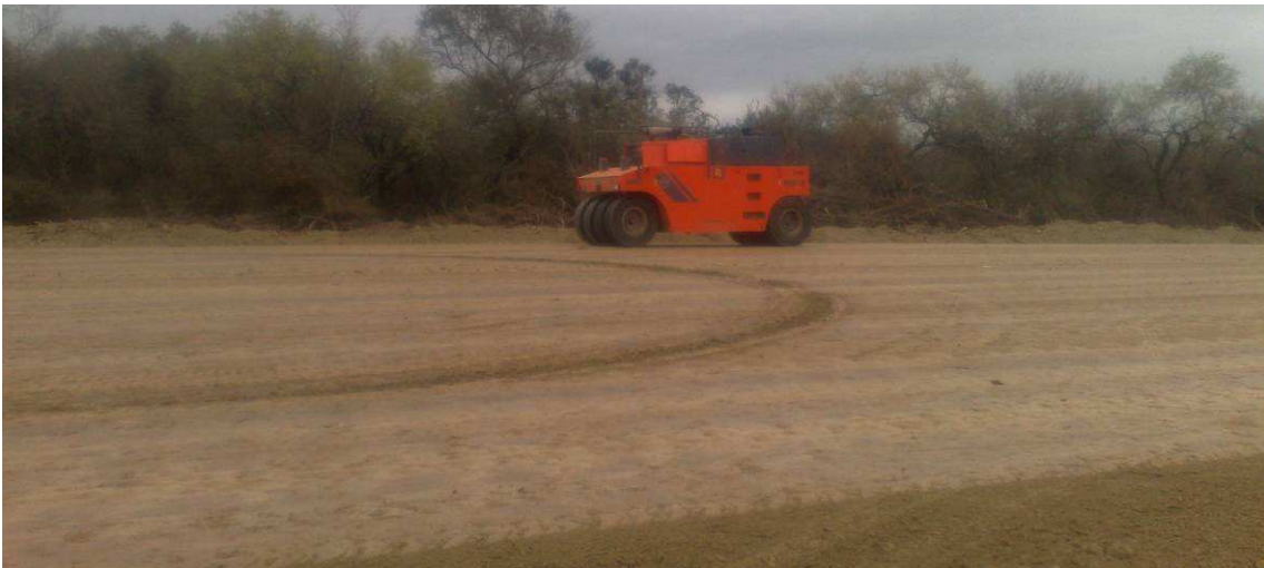
Fig.4.150: Sellado de capa de terraplén con compactador neumático. Sección III.
