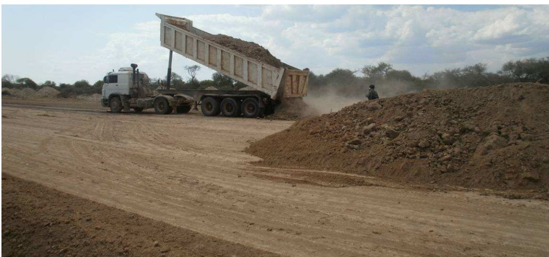
Fig.4.119: Descarga de suelo sobre base de asiento. Progresiva 12+500 Sec.III.
