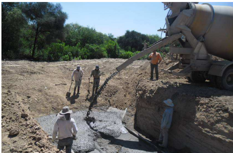
Fig.4.86: Hormigonado de fundaciones junto a losa inferior de alcantarilla. Prog. 19+900 Sec. II.
