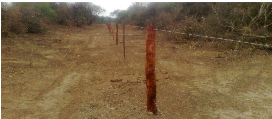
Fig.4.56: Posteo con varillon central y alambre superior e inferior. Sec II entre Prog. 30+300 a 31+000 Lado izquierdo.
