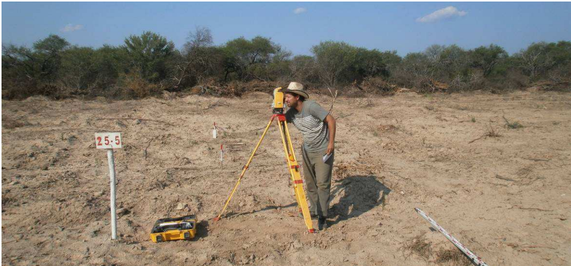
Fig.4.35: Controlando planimetría con Estación Total Trimble M3 en Sección II.
