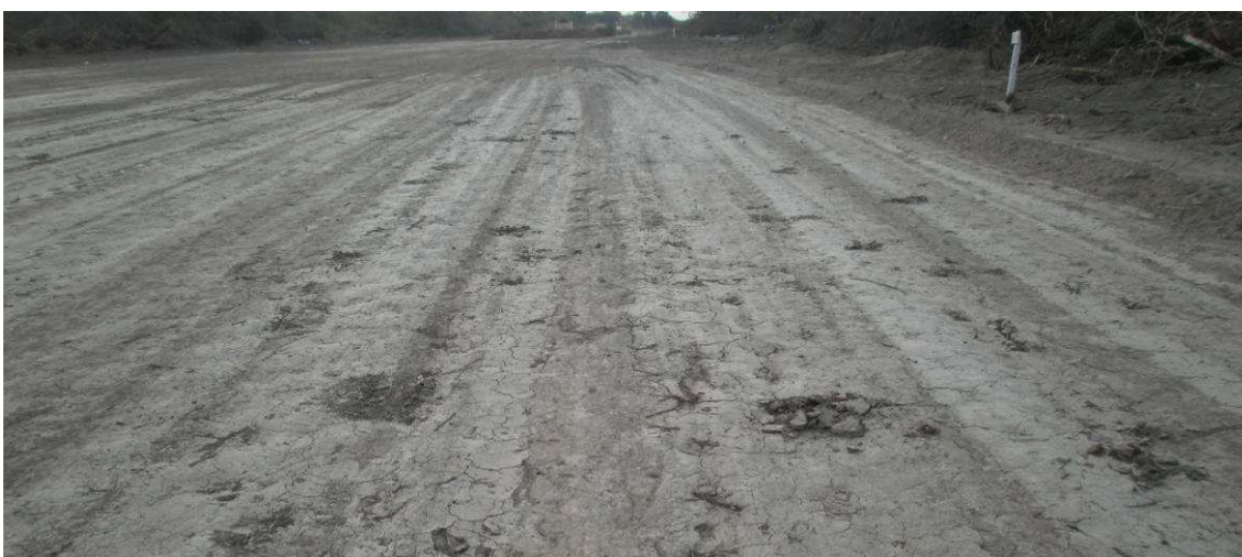
Fig.4.131: Superficie de base de asiento de terraplén, sin presencia de ramas o raíces. Progresiva 12+700 Sec.III.
