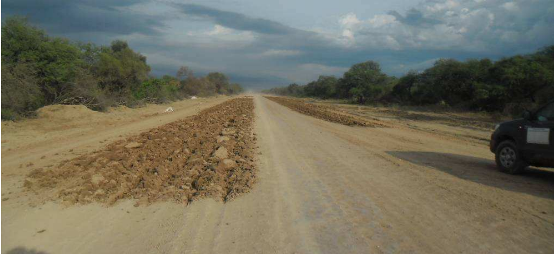
Fig.4.161: Escarificado y posterior recompactado de sector bacheado en cancha. Progresiva 22+200 Sección II.
