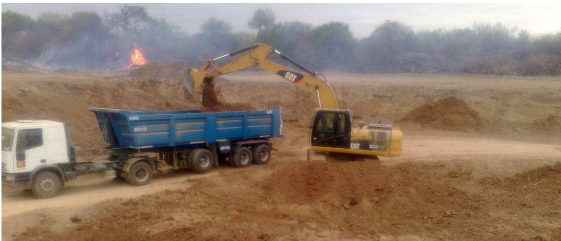
Fig. 8.32: Retroexcavadora CAT 323D cargando suelo del préstamo en batea.
