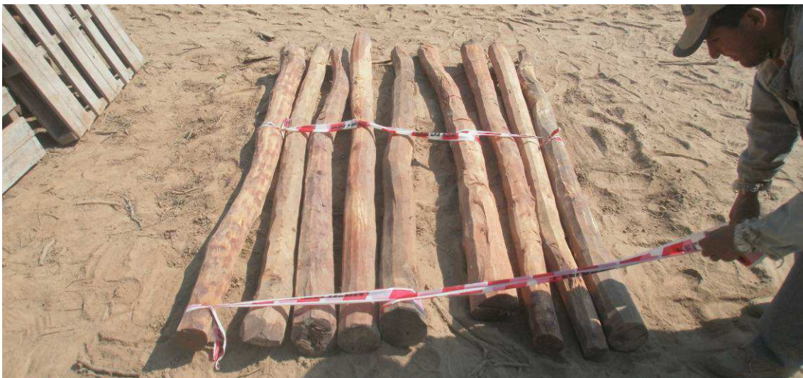
Fig.4.47: Postes desaprobados por la Inspección en obrador de JCR de Lamadrid.
