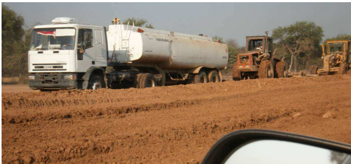
Fig.4.140: Humectado, Escarificado y distribución del suelo. Sección II.
