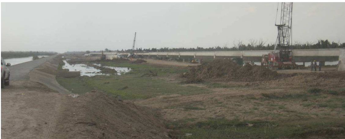
Fig.8.5: A la izquierda de la figura se observa el vertedero que atraviesa el bañado y sobre la derecha de la misma, podemos apreciar la construcción del puente nuevo sobre Ruta Provincial N°28.
