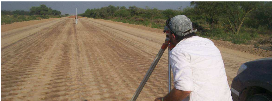
Fig.4.164: Tomando niveles en capa terminada. Sección II.
