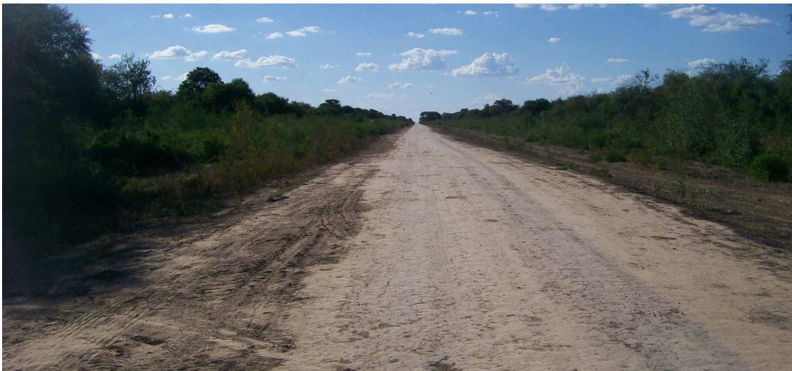
Fig. 2.4: Traza previo a la obra.
