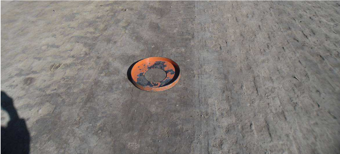
Fig.4.168: Ubicando posición del plato del Cono de arena para ensayo de densidad. Sección II.
