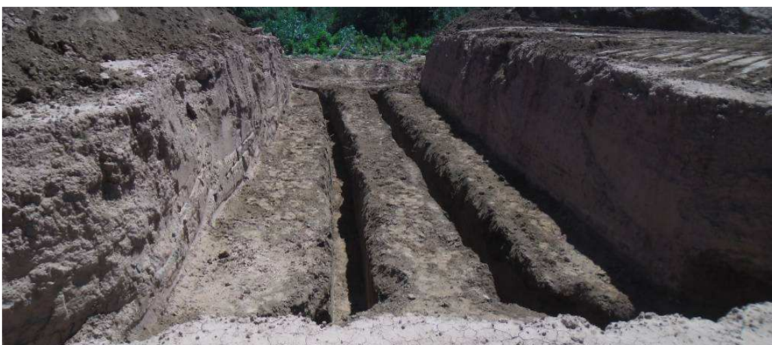
Fig.4.79: Zanjas de fundaciones de alcantarilla. Prog. 18+500 Sec.II.
