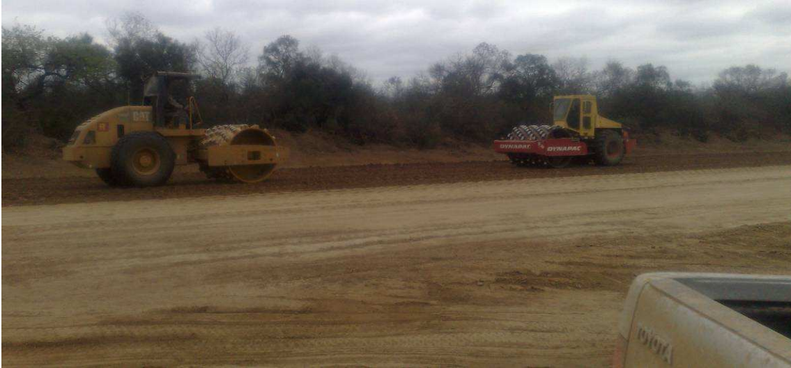
Fig.4.149: Compactación de capa con rodillos pata de cabra. Sección III.
