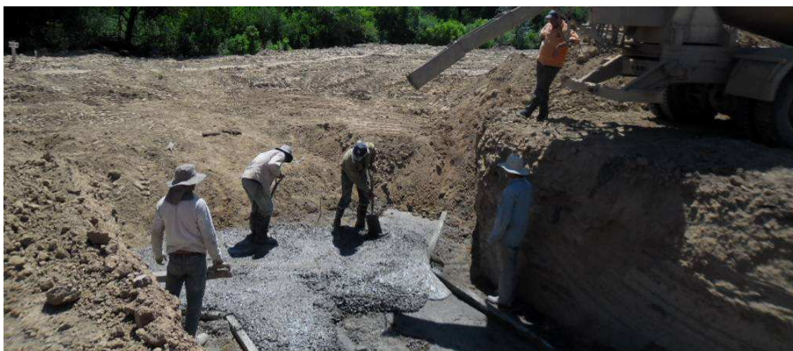
Fig.4.87: Hormigonado de fundaciones junto a losa inferior de alcantarilla. Prog. 19+900 Sec. II.
