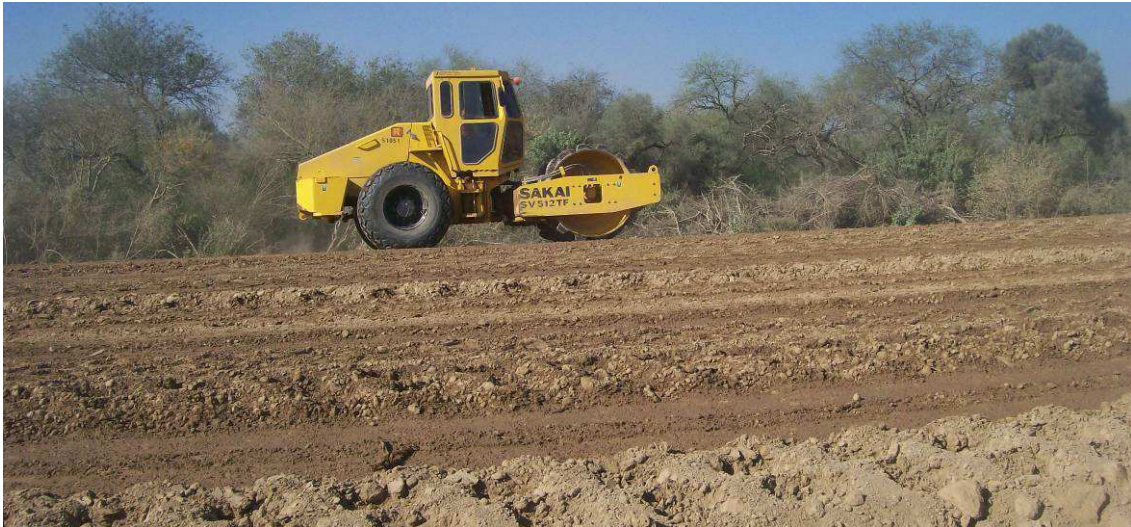
Fig.4.152: Compactación de capa con rodillos pata de cabra. Sección II.
