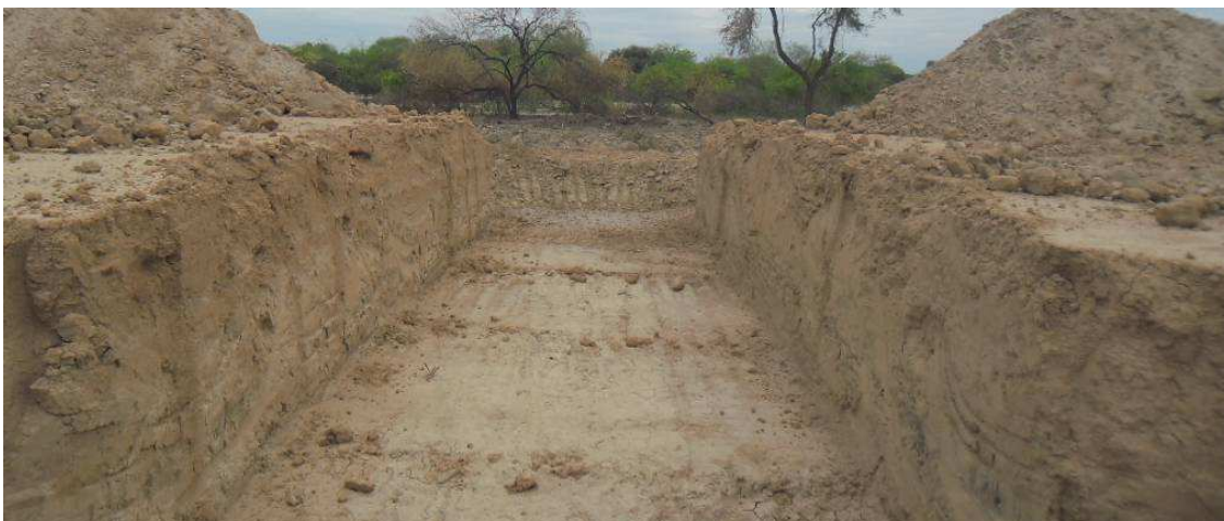
Fig.4.77: Apertura en terraplén para emplazamiento de alcantarilla. Prog. 13+950 Sec.II.
