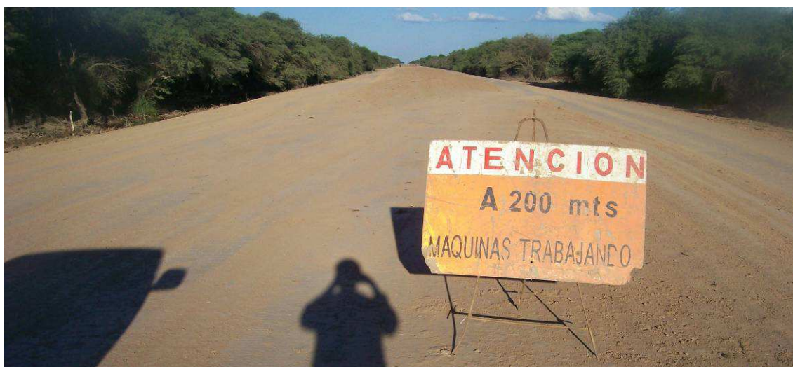
Fig.4.192: Cartel indicador de Maquinas trabajando en zona de trabajo. Sección II.
