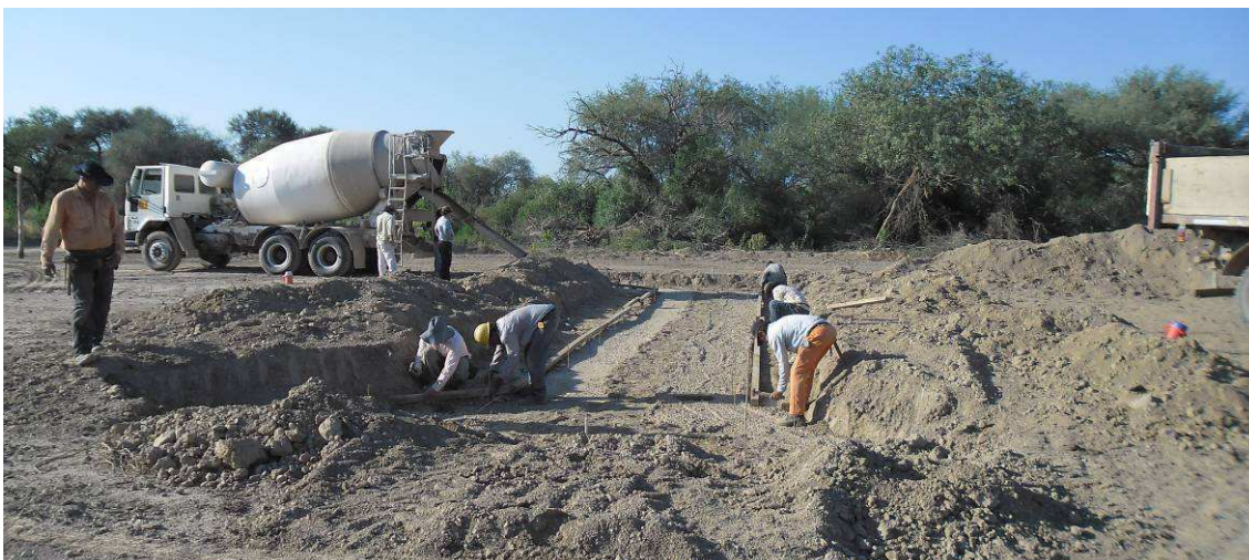
Fig.4.83: Hormigonado de losa inferior de alcantarilla. Prog. 13+950 Sec.I.
