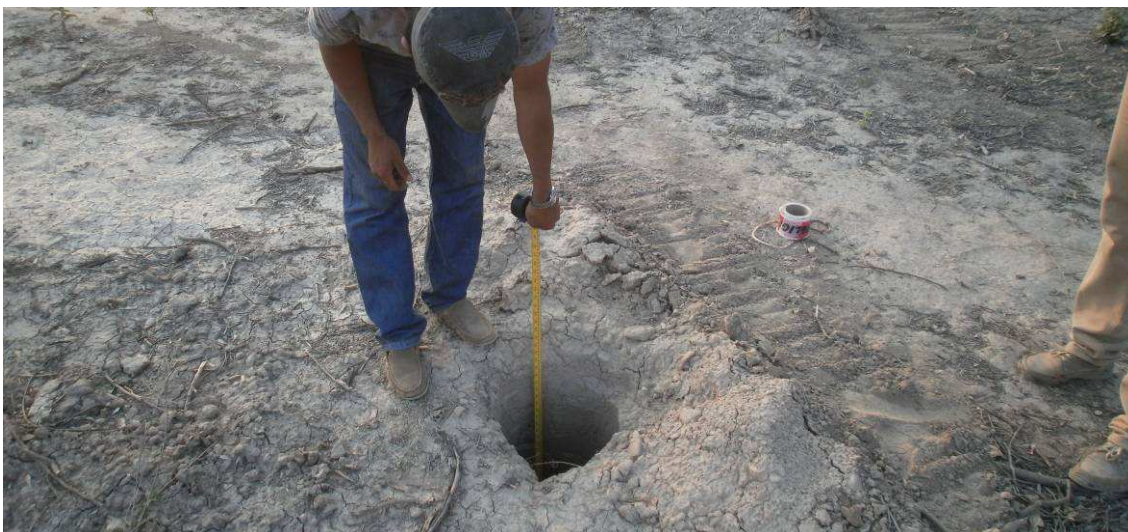
Fig.4.64: Controlando profundidad de pozos. Prog. 0+000 y 1+500 lado derecho, Sec III.
