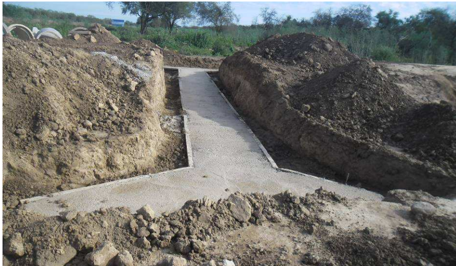
Fig.4.114: Base de alcantarilla longitudinal. Prog. 0+570 Sección II.
