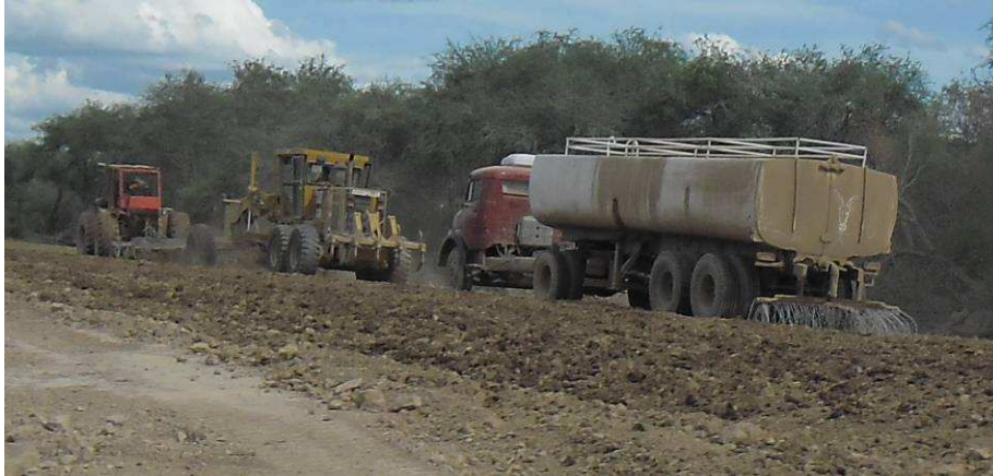
Fig. 8.38: Camión regador humectando capa de terraplén.
