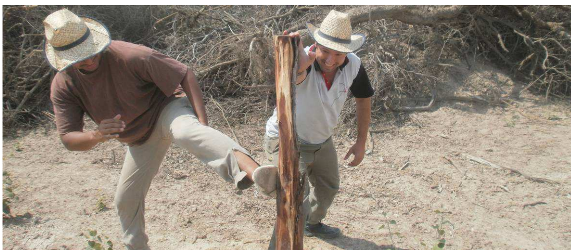
Fig.4.60: Poste en mal estado sacado de la línea de alambrado por inspección. Postado entre Prog. 0+000 y 1+500 lado derecho, Sección III.
