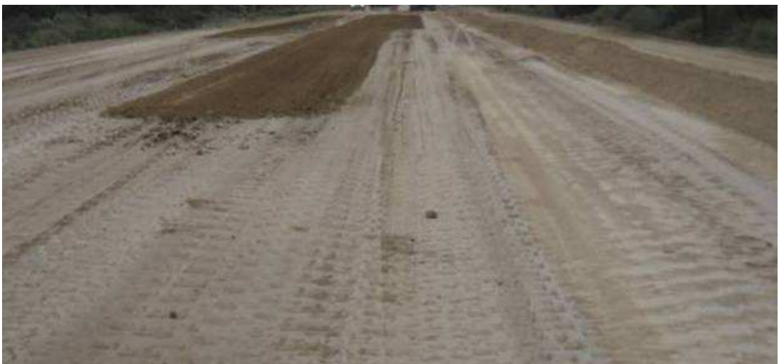
Fig.4.160: Recompactando sector bacheado de cancha. Sección II.
