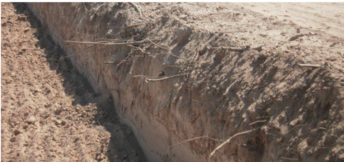
Fig.4.118: Presencia de raíces y ramas en primeras capa de préstamo en Progresiva 13+000 Sec.III
