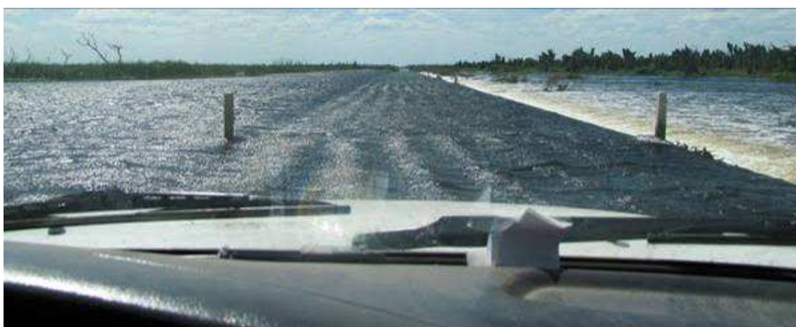
Fig.8.4: Vista desde arriba de un vehículo transitando por encima del vertedero en épocas de crecidas, antes de que se construya el puente sobre Ruta Provincial N° 28.
