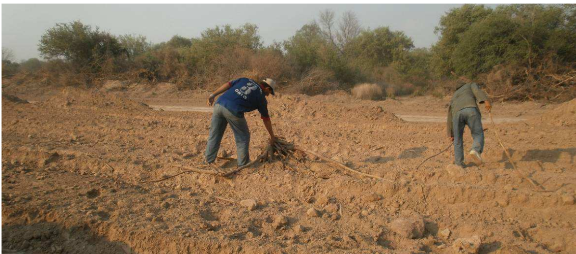
Fig.4.129: Ayudantes de inspección sacando raíces del suelo pertenecientes a la primera capa del terraplén. Progresiva 12+500 Sec.III.
