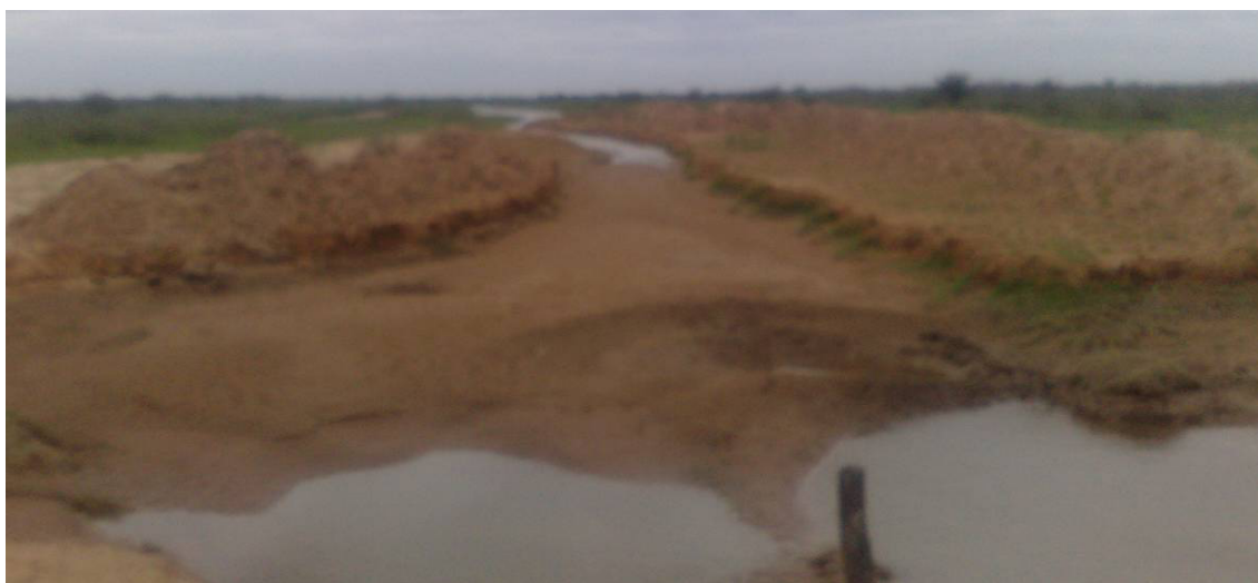
Fig.4.28: Punto de unión entre el canal de abastecimiento a la reserva de Sección III y el brazo del bañado proveniente del Río Pilcomayo.
