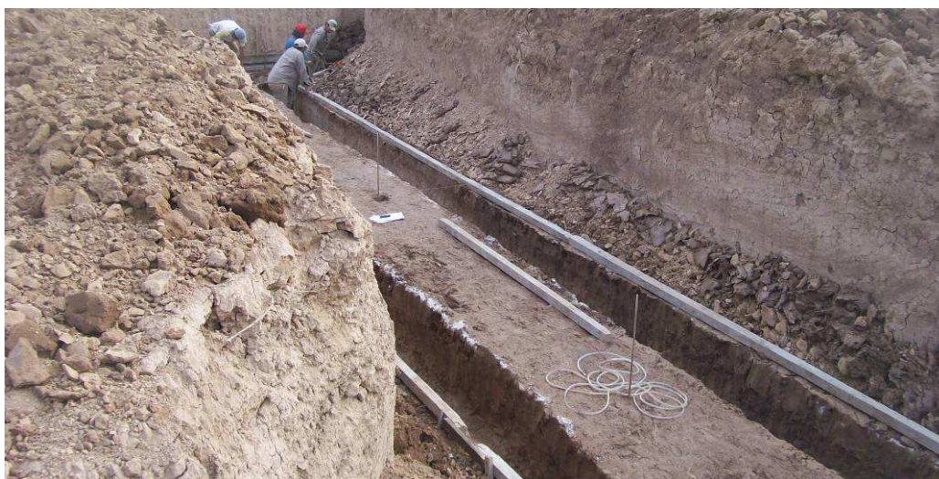
Fig.4.85: Hormigonado de fundaciones junto a losa inferior de alcantarilla. Prog. 19+900 Sec. II.
