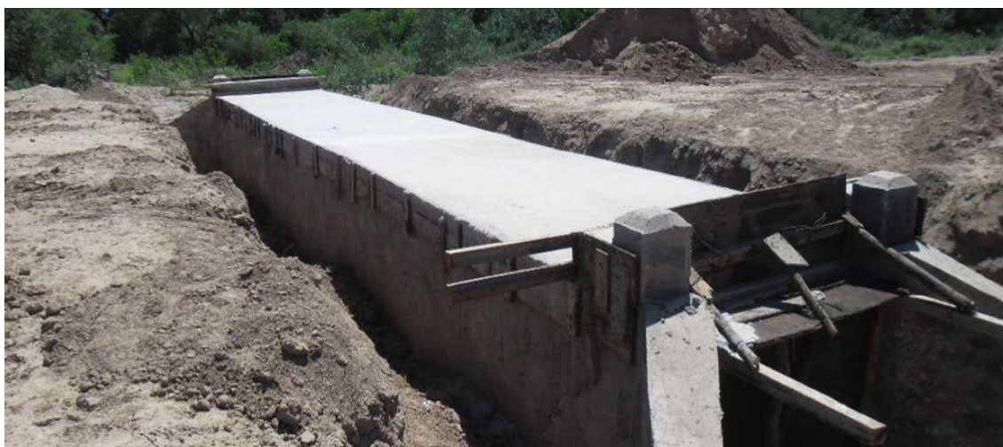
Fig.4.108: Losa superior de alcantarilla de una boca recién hormigonada. Prog. 5+200 Sec. II
