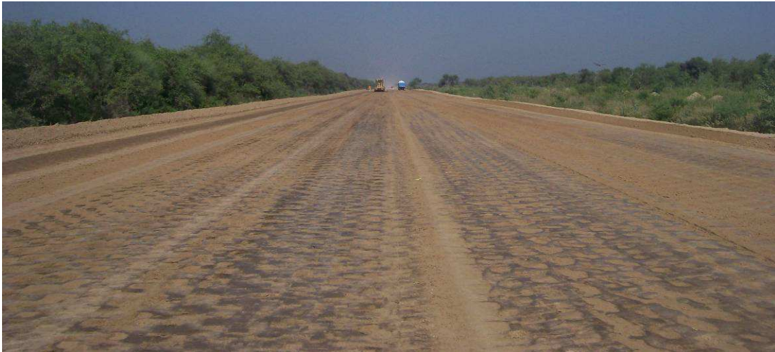
Fig.4.155: Capa de terraplén lista. Sección II.
