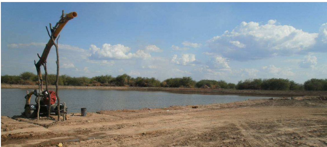
Fig.4.24: Reserva de agua en Sección III.
