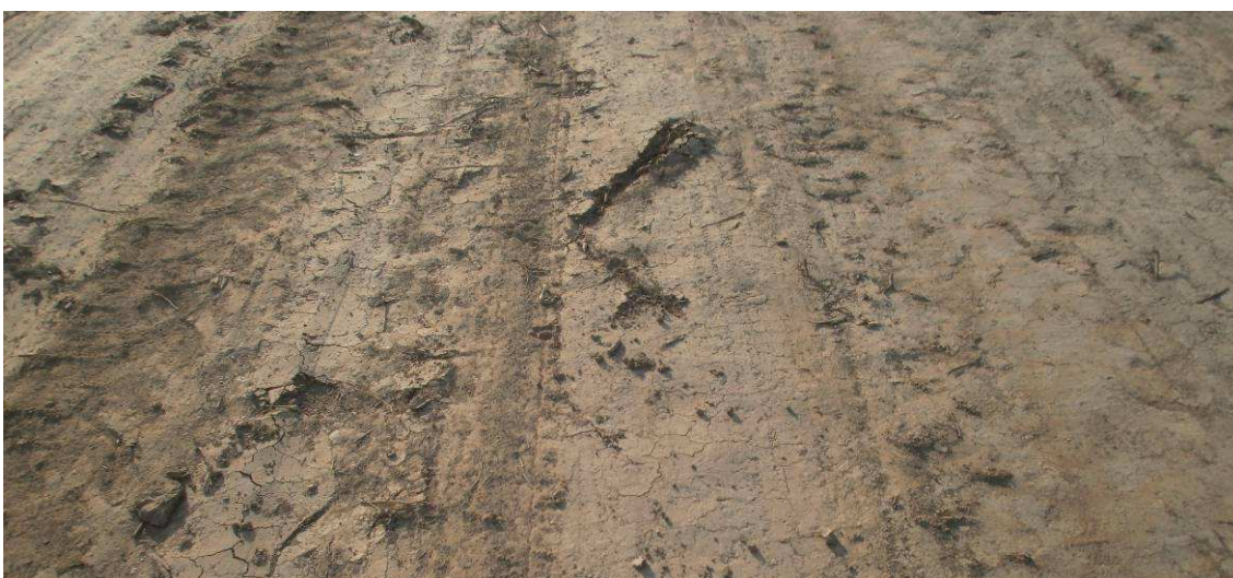
Fig.4.135: Marca sobre la superficie de la base de asiento dejada por la presencia de ramas o raíces. Prog. 12+700 Sec.III.
