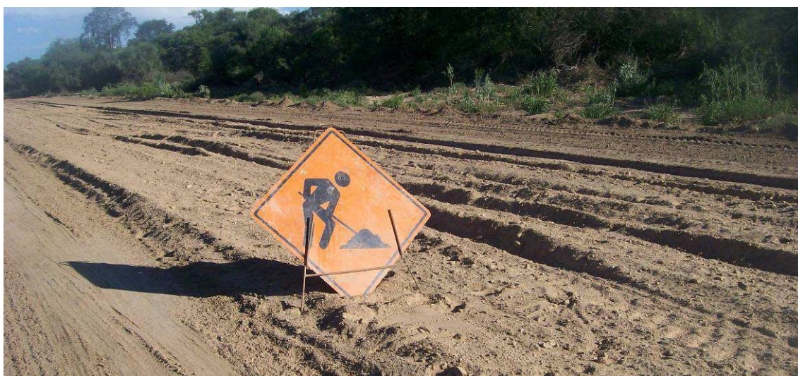
Fig.4.188: Cartel indicador de Hombres trabajando en zona de trabajo. Sección II.
