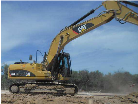
Fig. 8.31: Retroexcavadora CAT 323D abriendo terraplén para emplazamiento de alc.
