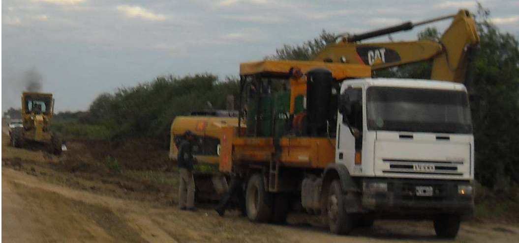
Fig. 8.40: Camión de mantenimiento auxiliando a Retroexcavadora.
