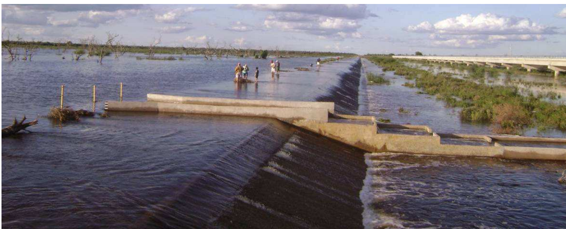
Fig.8.12: Escalera de peces construido sobre el vertedero. El mismo permite que los peces asciendan aguas arriba para desovar.
