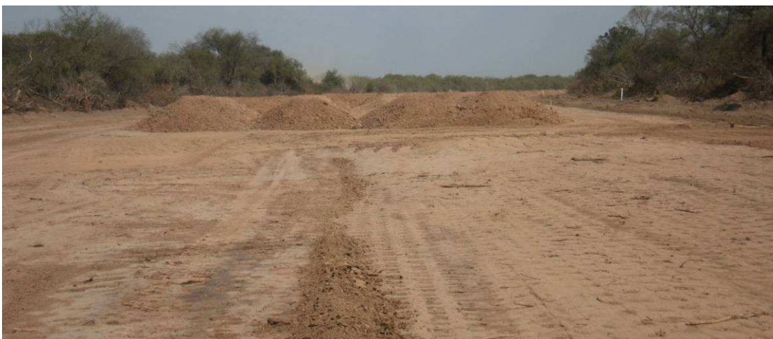
Fig.4.120: Suelo descargado en montículos sobre base de asiento. Progresiva 12+500 Sec.III.
