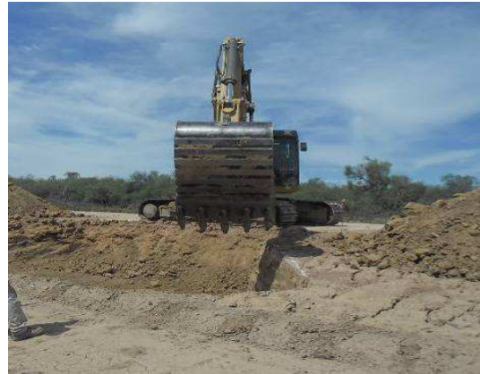
Fig. 8.31: Retroexcavadora CAT 323D abriendo terraplén para emplazamiento de alc.
