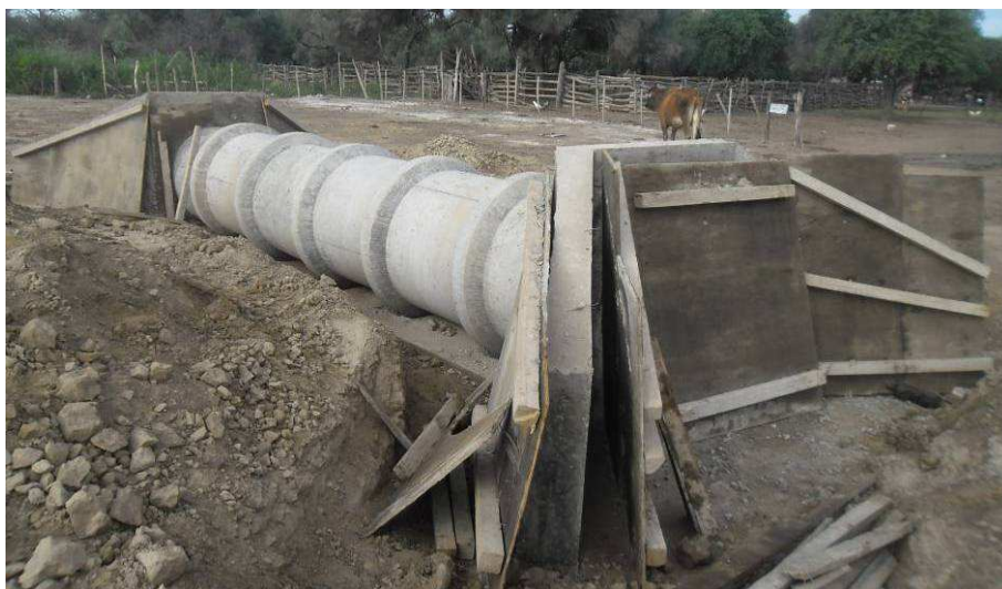
Fig.4.115: Alcantarilla longitudinal. Prog. 0+570 Sección II.
