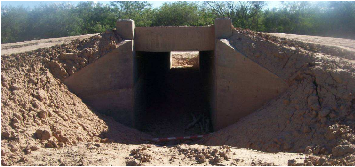
Fig.4.110: Alcantarilla transversal lista. Prog. 29+305 Sección III.
