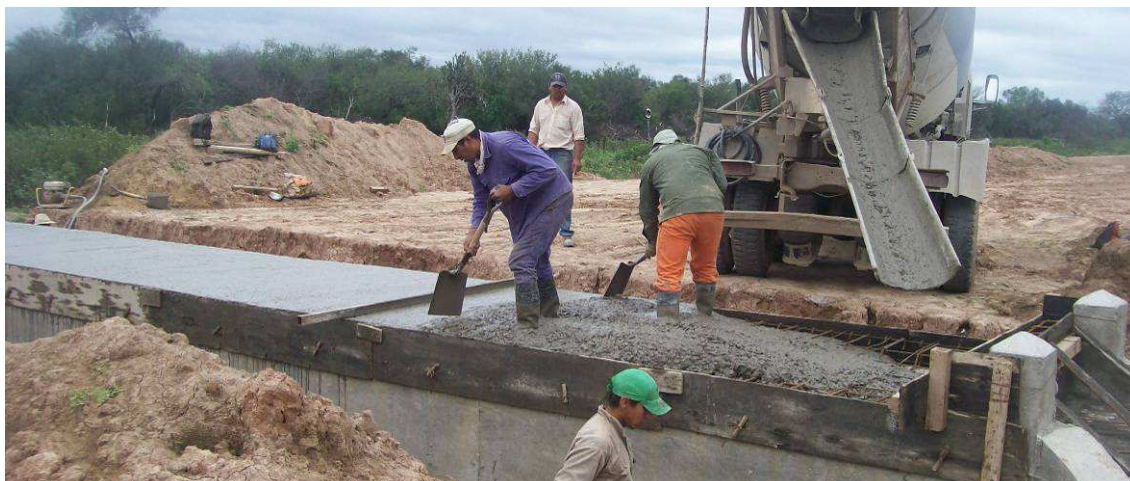
Fig.4.107: Hormigonado de losa superior de alcantarilla de una boca. Prog. 5+200 Sec. II
