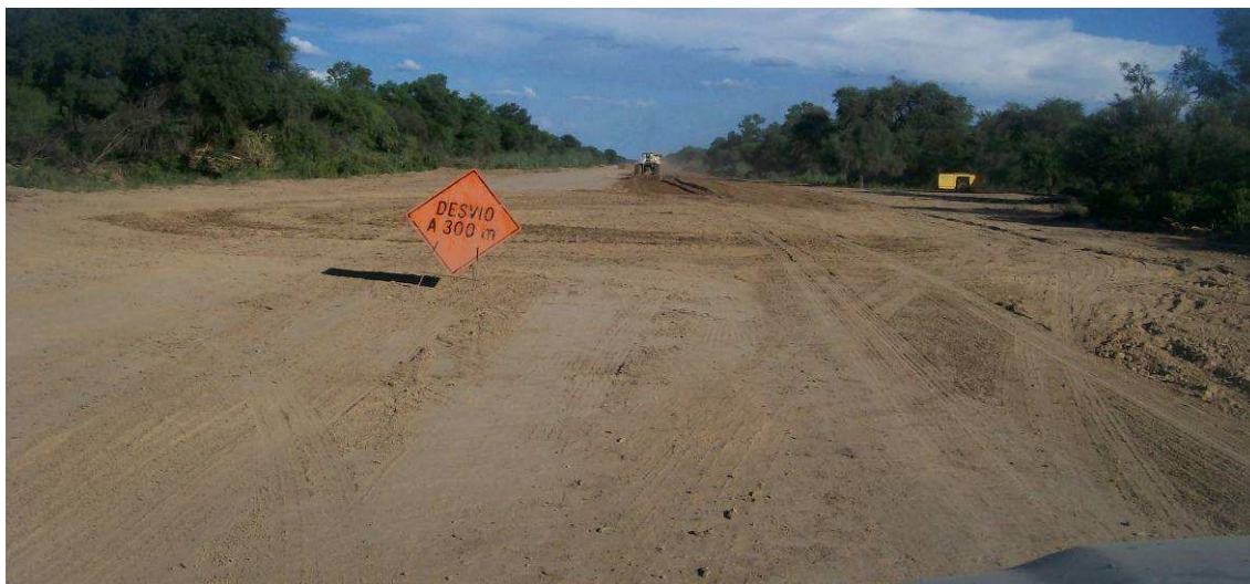
Fig.4.187: Cartel de Desvío en zona de trabajo. Sección II.
