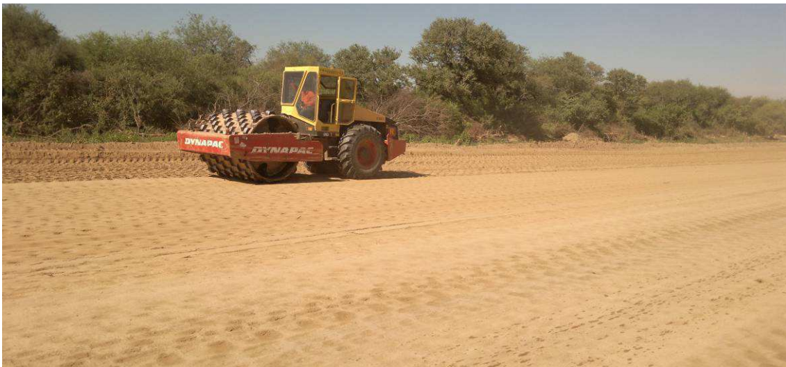
Fig.4.153: Compactación de capa con rodillos pata de cabra. Sección II.
