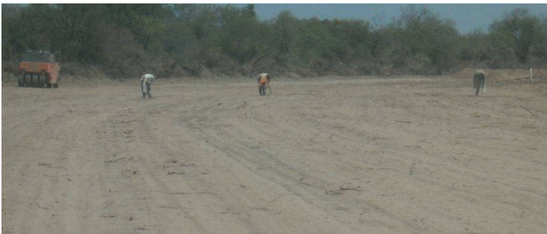
Fig.4.130: Personal de JCR sacando raíces y ramas que afloran sobre la superficie de la base de asiento de terraplén. Progresiva 12+700 Sec.III.
