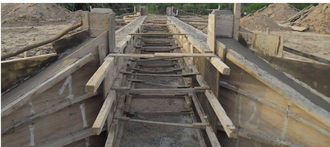
Fig.4.100: Alcantarilla de una boca con muros laterales recién hormigonados. Prog. 13+010 Sec. III
