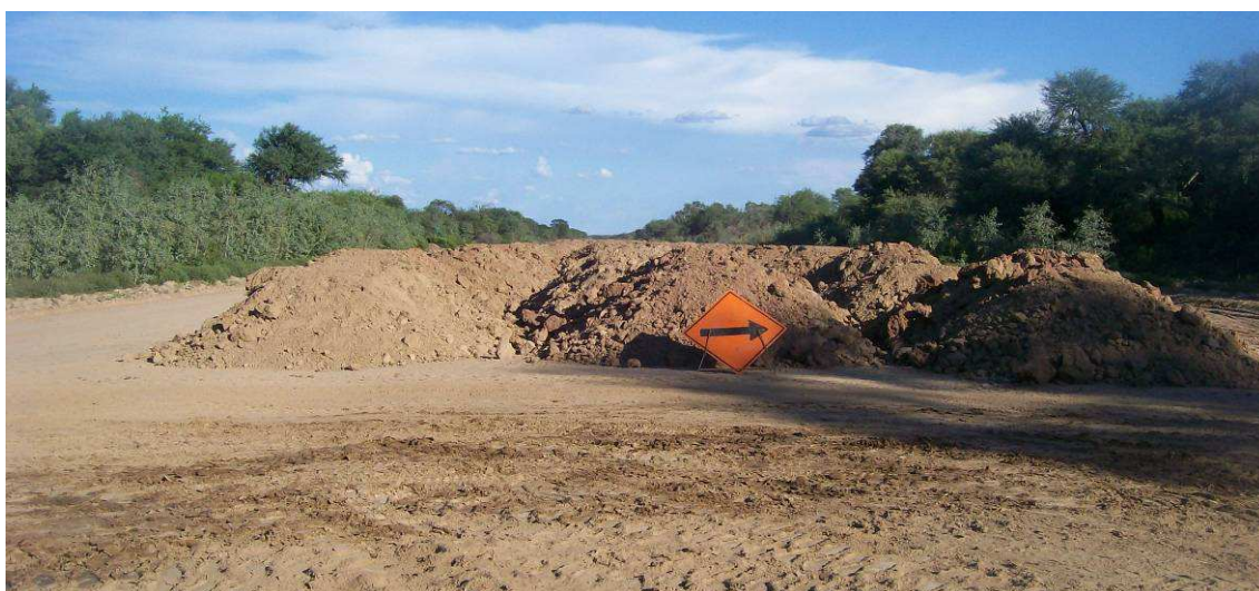
Fig.4.189: Cartel indicador de Dirección obligatoria. Cartel mal ubicado, esta muy cerca de los montículos de suelo. Sección II.
