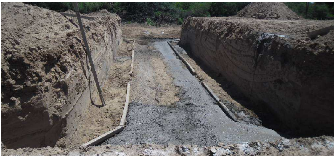
Fig.4.84: Hormigonado de losa inferior de alcantarilla. Prog. 18+960 Sec.II.
