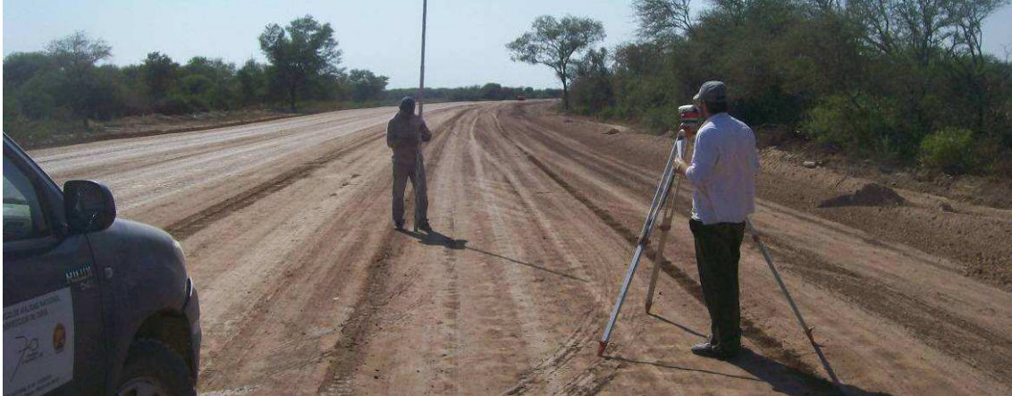
Fig.4.163: Tomando niveles en capa terminada. Sección II.
