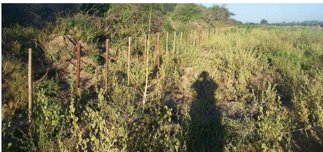
Fig.4.50: Alambrado terminado. Sec II desde Prog 30+500 a 32+500 lado derecho.
