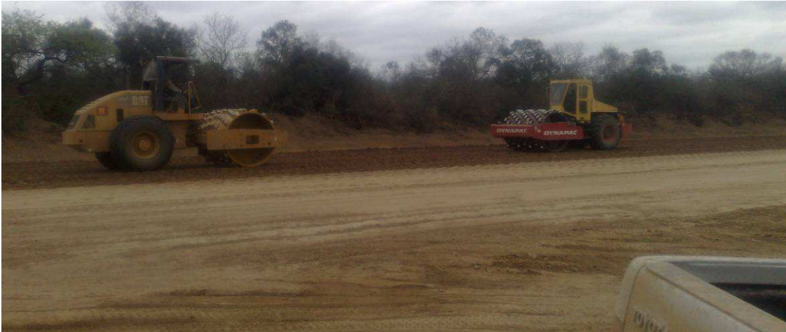
Fig. 8.24: Rodillo Pata de cabra Caterpillar CS533 y Dynapac CA250
