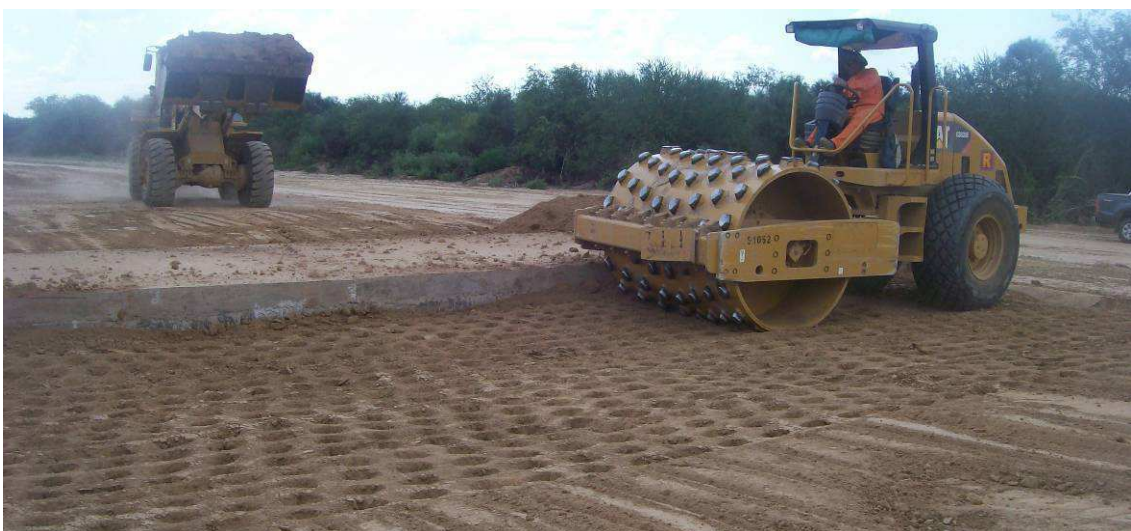
Fig.4.154: Compactación de capa en zona adyacente a una alcantarilla con rodillo pata de cabra. Sección II.
