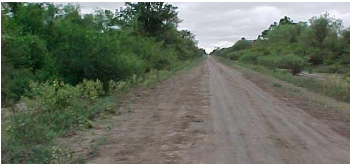
Fig. 2.5: Traza previo a la obra.
