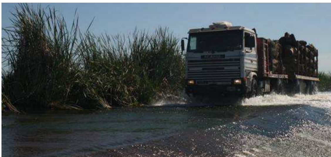
Fig.8.3: Paso de los camiones sobre el vertedero en épocas de crecidas, antes de que se construya el puente sobre Ruta Provincial N° 28.
