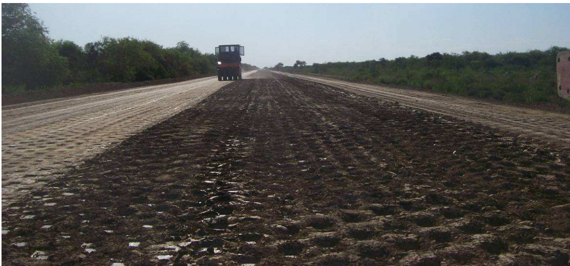
Fig.4.156: Sellado con compactador neumático mientras un rodillo pata de cabra termina con la compactación de la capa. Sección III.
