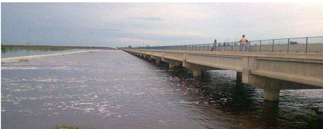
Fig.8.7-A: Puente terminado y habilitado sobre Ruta Provincial N°28.
