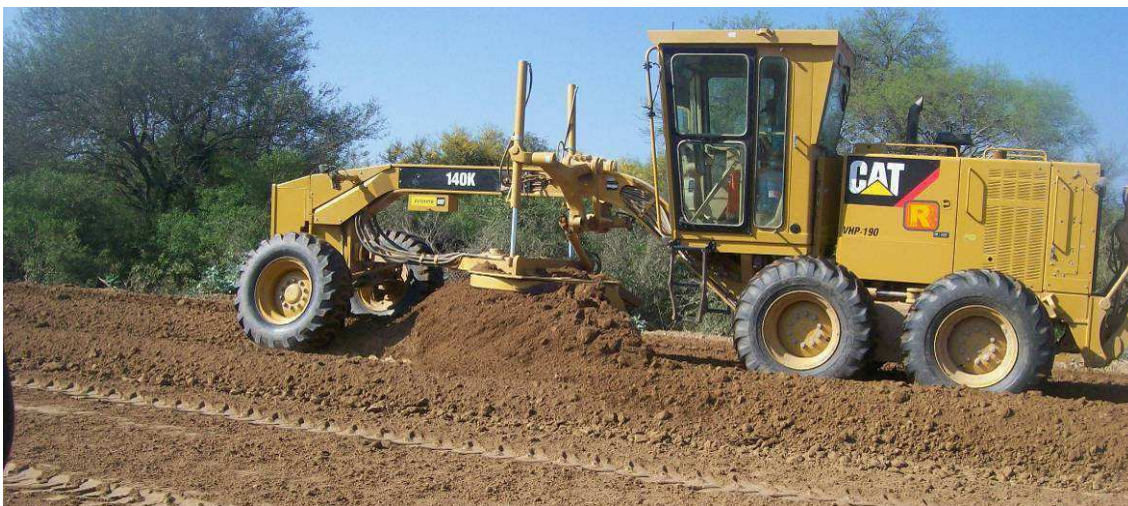
Fig.4.143: Motoniveladora 140K trabajando sobre la distribución del suelo en cancha. Sec. III.
