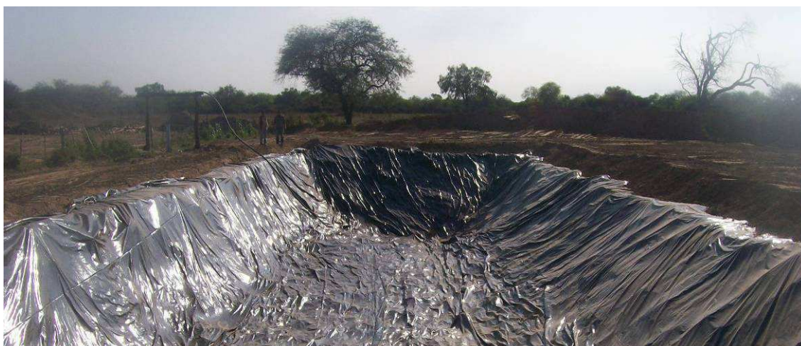
Fig.4.22: Fosa para reserva de agua por bombeo en Sección II.
