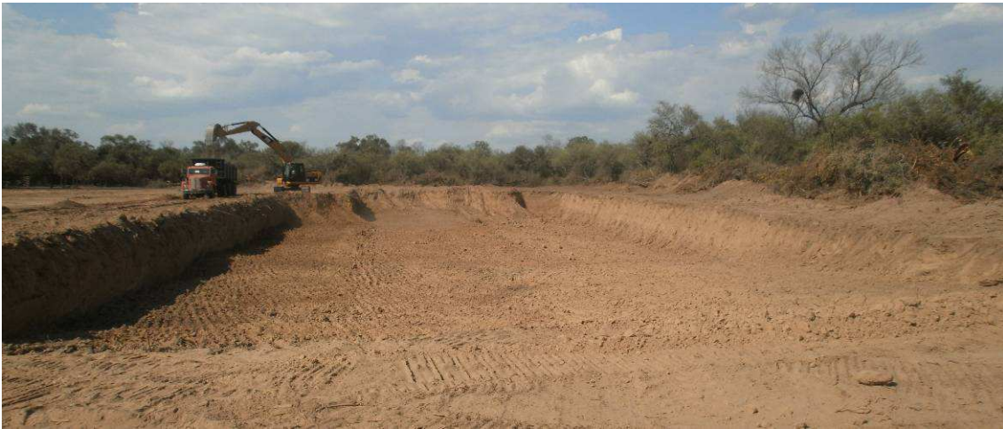
Fig.4.116: Explotación de préstamo en Progresiva 13+000 Sec.III.
