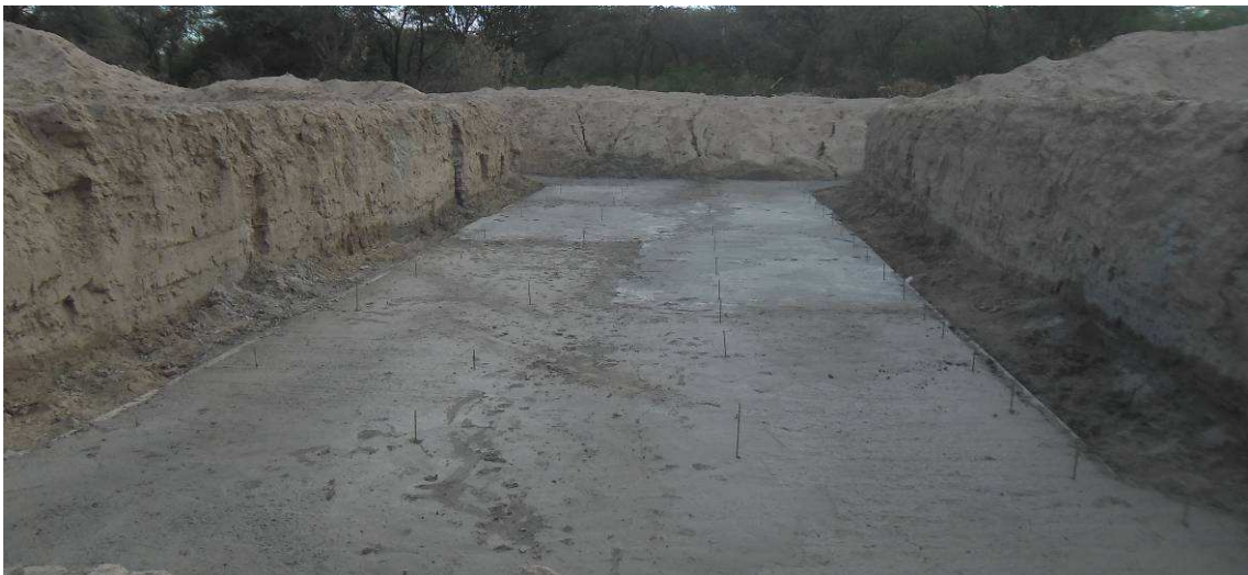
Fig.4.90: Losa inferior de alcantarilla de tres bocas. Prog. 16+580 Sec. III.
