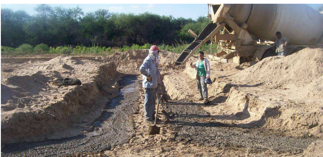
Fig.4.81: Hormigonado de fundaciones de alcantarilla. Prog. 13+010 Sec.III
