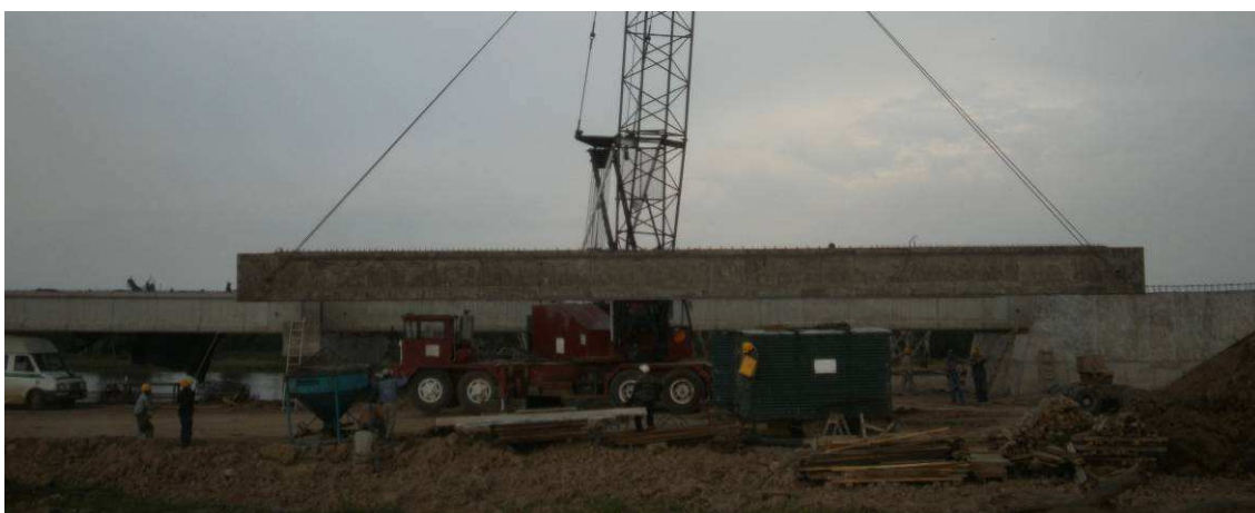
Fig.8.6: Construcción de un tramo del puente nuevo sobre Ruta Provincial N°28.
