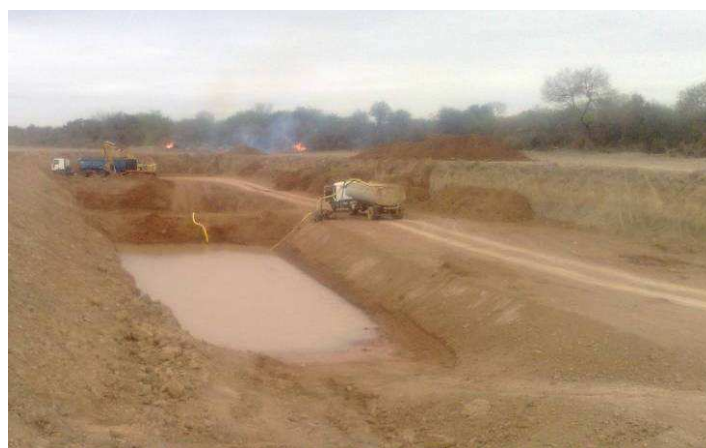
Fig.4.31: Préstamo en Sección II, que luego de las lluvias se utilizó como toma de agua para riego.
