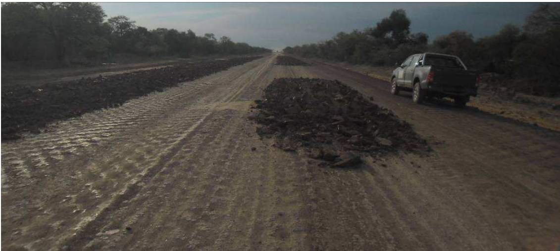
Fig.4.162: Escarificado y posterior recompactado de sector bacheado en cancha. Progresiva 22+200 Sección II.
