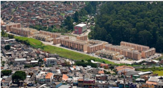
Figura 10 – Vista aérea Conjunto habitacional Colinas d'Oeste/Morro do Socó – Osasco – Estado de São Paulo Fuente: VIGLIECCA, 2014. Disp. http://www.vigliecca.com.br/pt-BR/projects/portais-area
