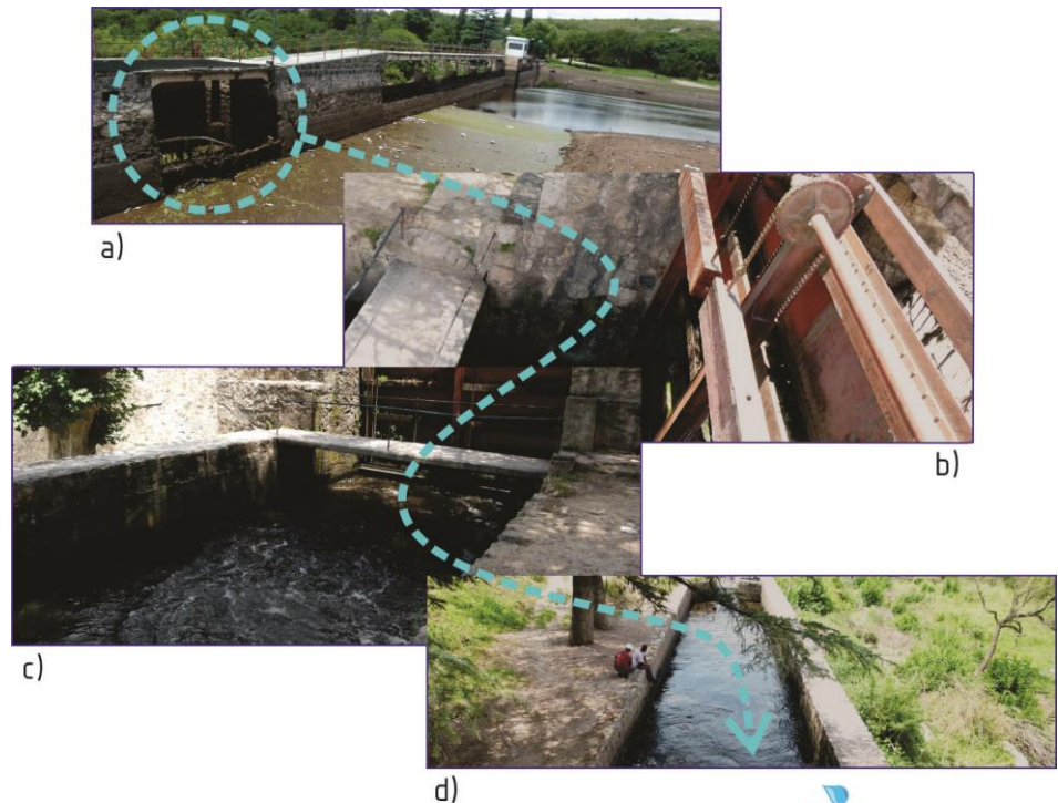
FIGURA 1.3: Fotografías de toma de derivación en Dique Mal Paso. a) Compuerta de derivación vista desde aguas arriba. b y c) Detalle mecanismo de apertura y cierre d) Vista superior de canal de conducción inmediatamente aguas debajo de la toma.
