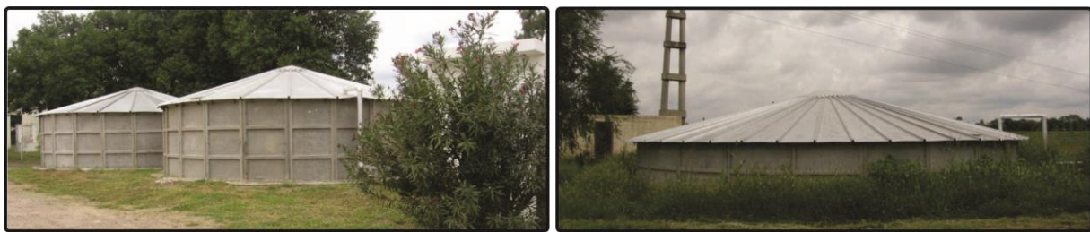
FIGURA 4.10: Tanques australianos (reservorios) comunitarios. FUENTE: (Elaboración propia)
