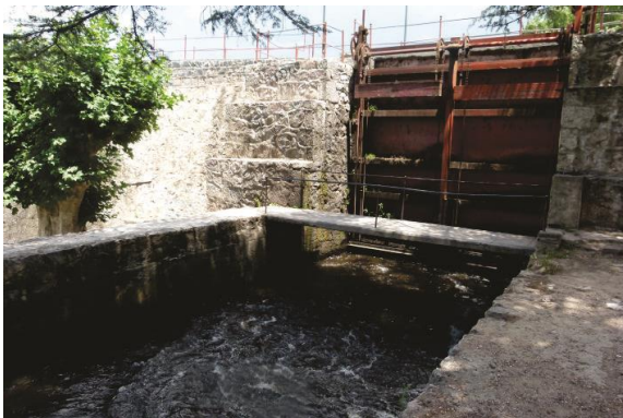
FIGURA 6.2: Vista de compuerta de derivación para canal de riego en el Dique Mal Paso
