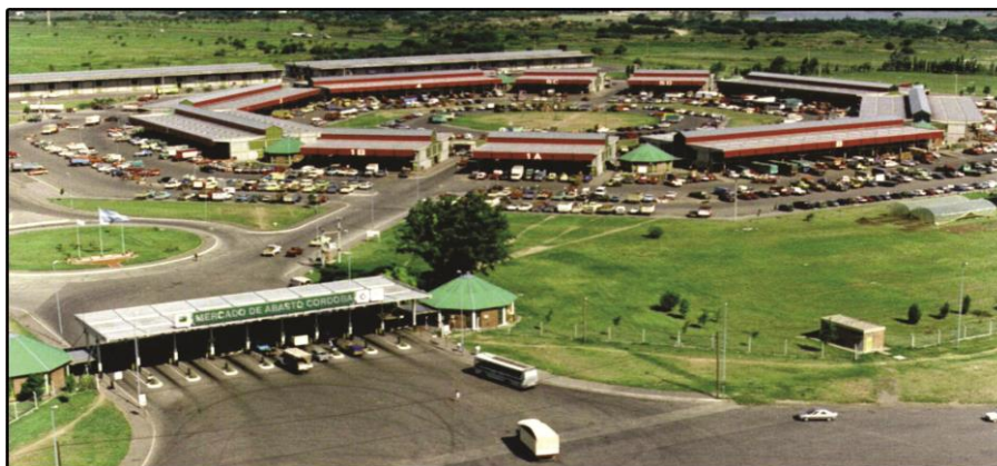
FIGURA 5.1: Mercado de abasto central de Córdoba
