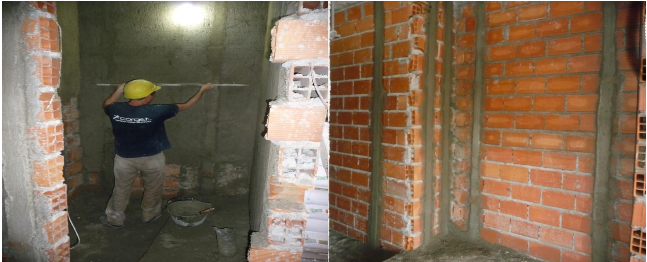
Figura 2.1 Ejecución de Revoque Grueso
