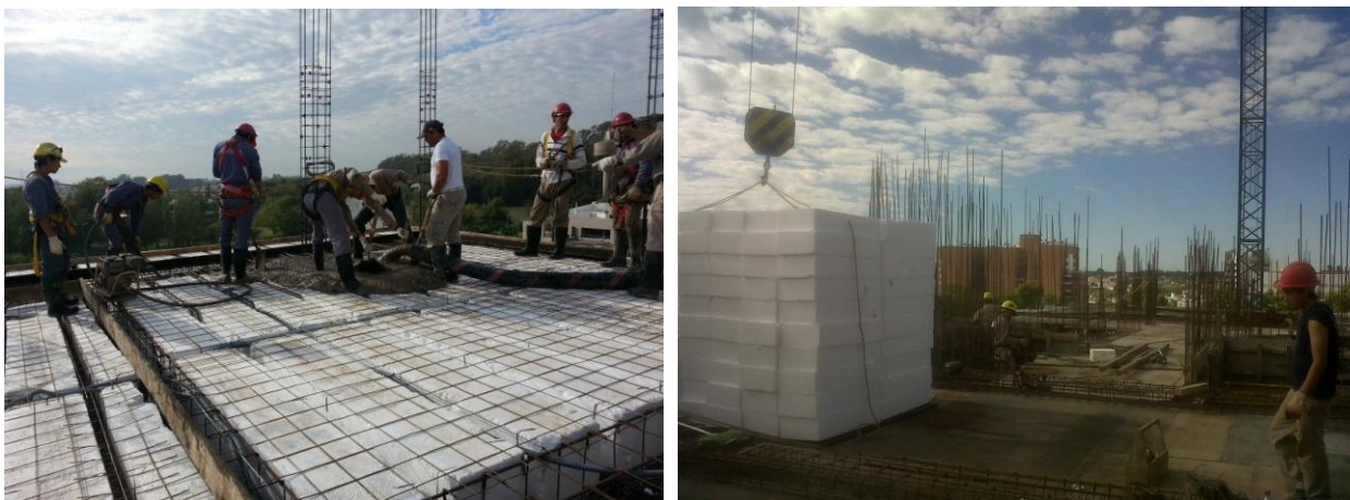
Figura 2.3 Armado y llenado de losa
