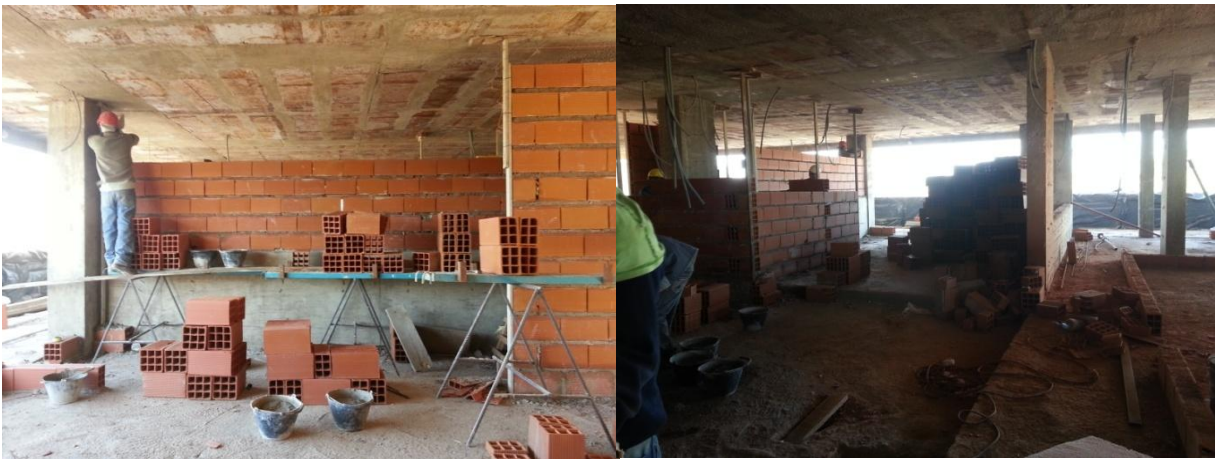
Figura 2.2 Elevación de mampostería
