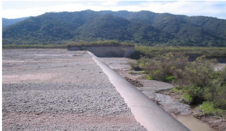
*Figura 4: Sedimentación aguas arriba del Dique Fijo*
