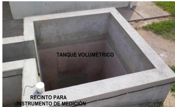
Figura 15: Tanque Volumétrico
