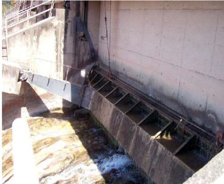
*Figura 8: Compuerta del Dique Móvil*
