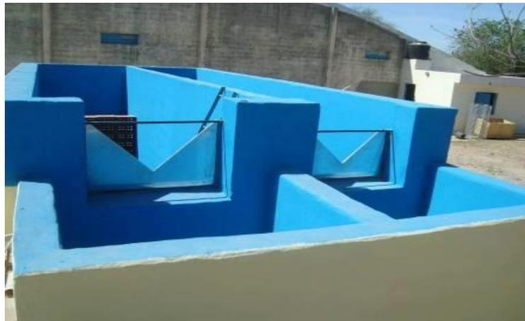
*Figura 10: Cámaras de Aforo con vertedero triangular*
