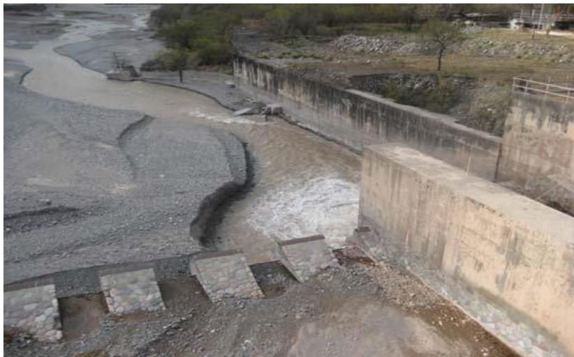
*Figura 7: Erosión local aguas abajo del Canal Moderador*
