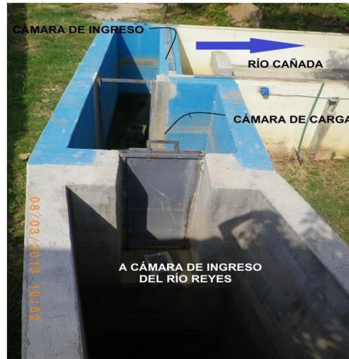
*Figura 11: Cámara de Carga del río Reyes*
