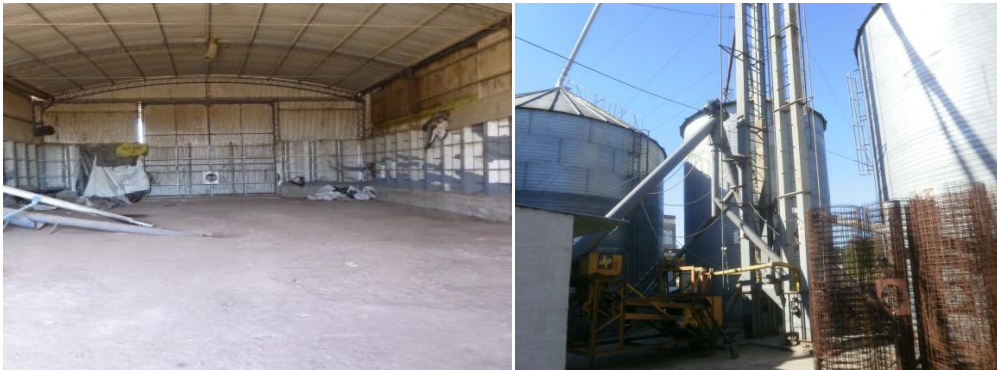
Figura 10: Galpón de almacenamiento y silos metálicos cilíndricos
