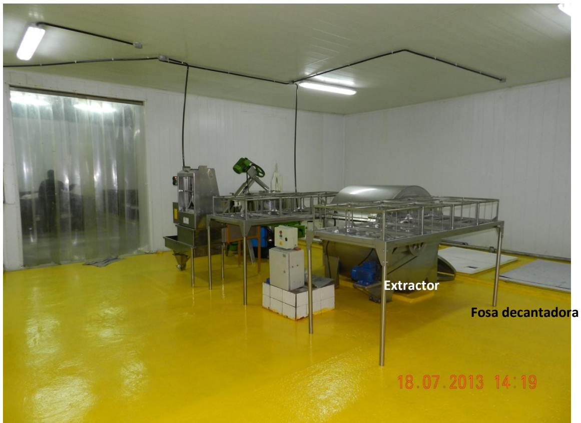
Figura 14: Sala de extracción del establecimiento Santa Eufemia
