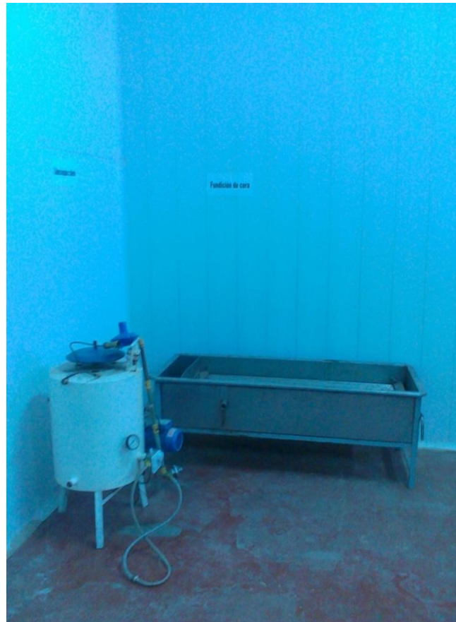
Figura 16: Fundidora de cera, Establecimiento Santa Eufemia
