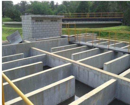
**Imagen 16 Sedimentador Terciario y Cámara de Contacto**
