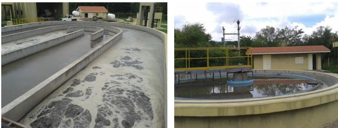
**Imagen 19 Cámara de Contacto y Sedimentador secundario**
