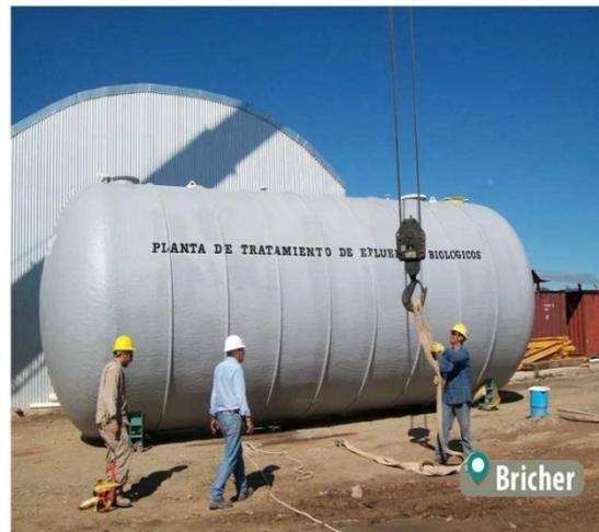
**Imagen 41 Planta Compacta Modular Aireación Extendida Bricher S.A. (www.bricher.com.ar)**
