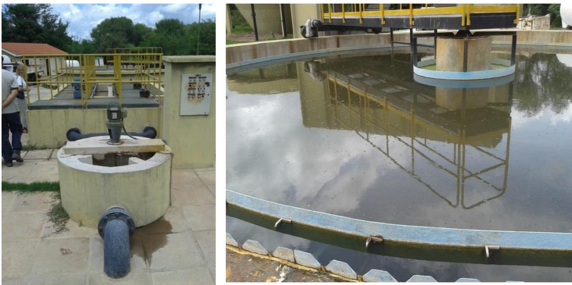
**Imagen 20 Floculador y Sedimentador Terciario**
