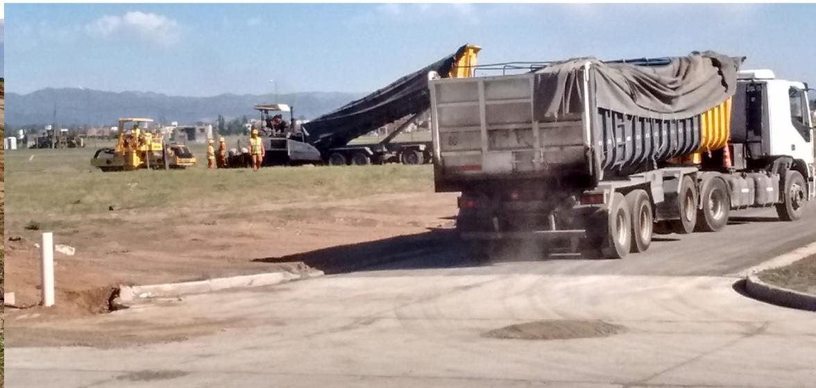
**Imagen 4.44 : Conformación de carpeta asfáltica.**
