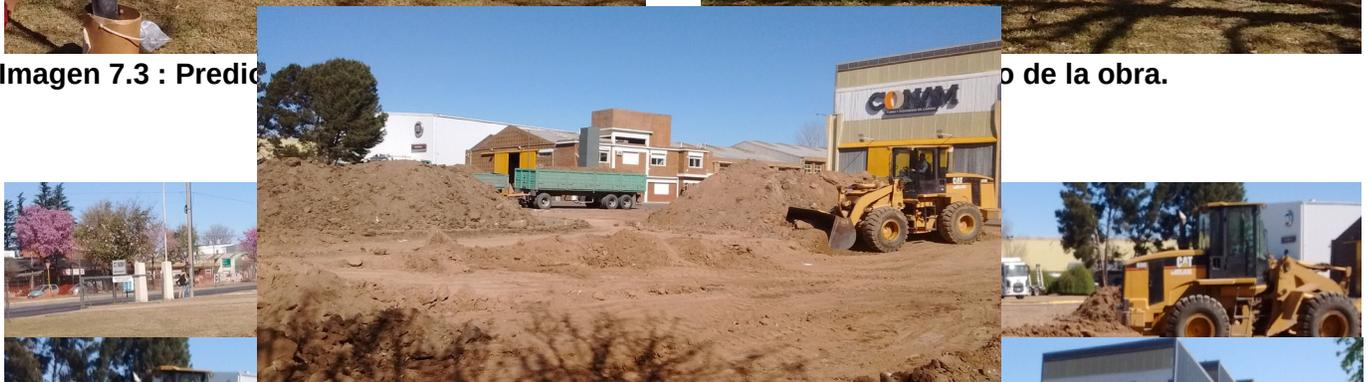
Imagen 7.8 : Acopio de material excavado.
