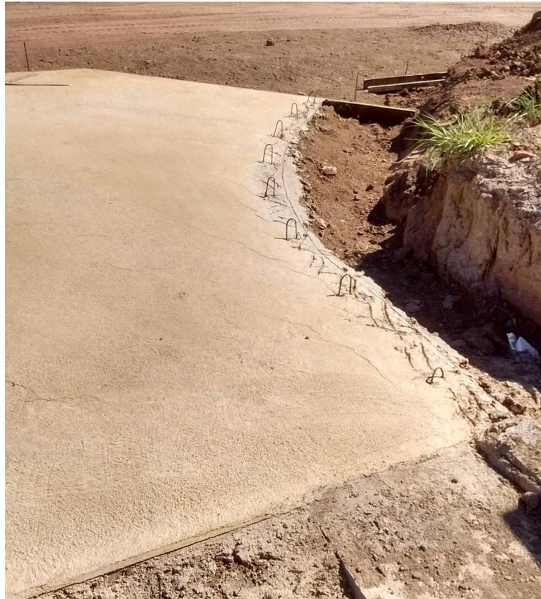
**Imagen 4.39 : Colocación de armadura de vinculación.**
