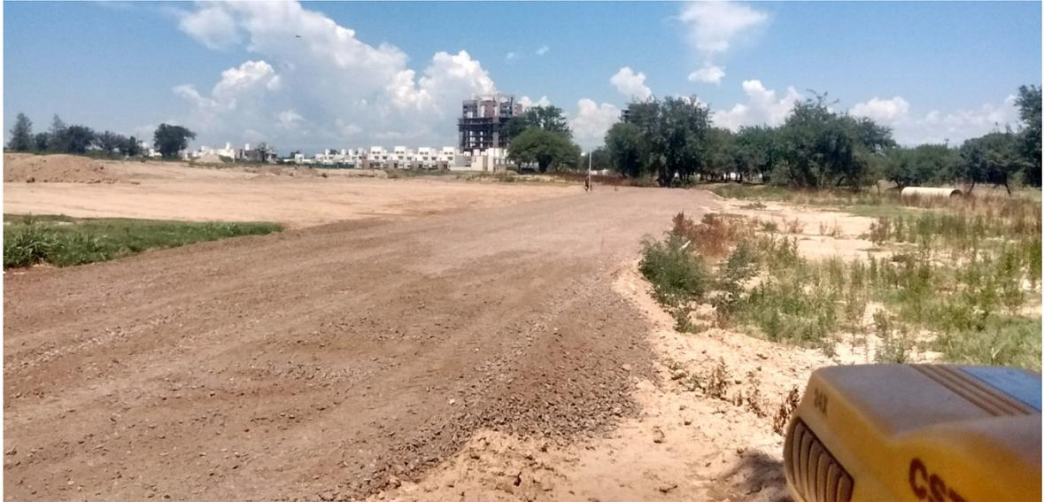
Imagen 4.33 : Verificación de niveles sobre estacas y galibo.
