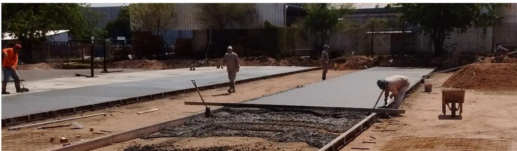
**Imagen 7.16 : Construcción de losas.**
