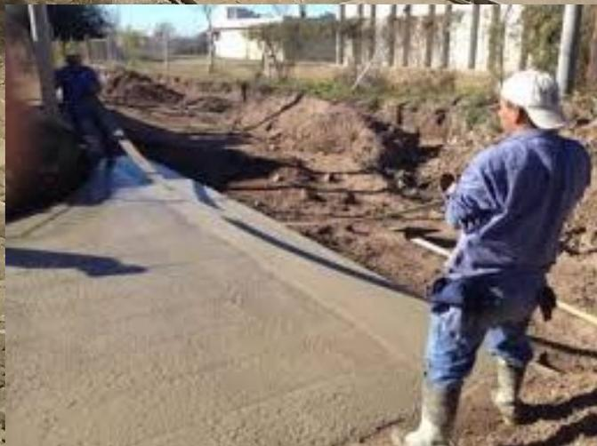
**Imagen 4.38 : Terminación final del paño de hormigón.**
