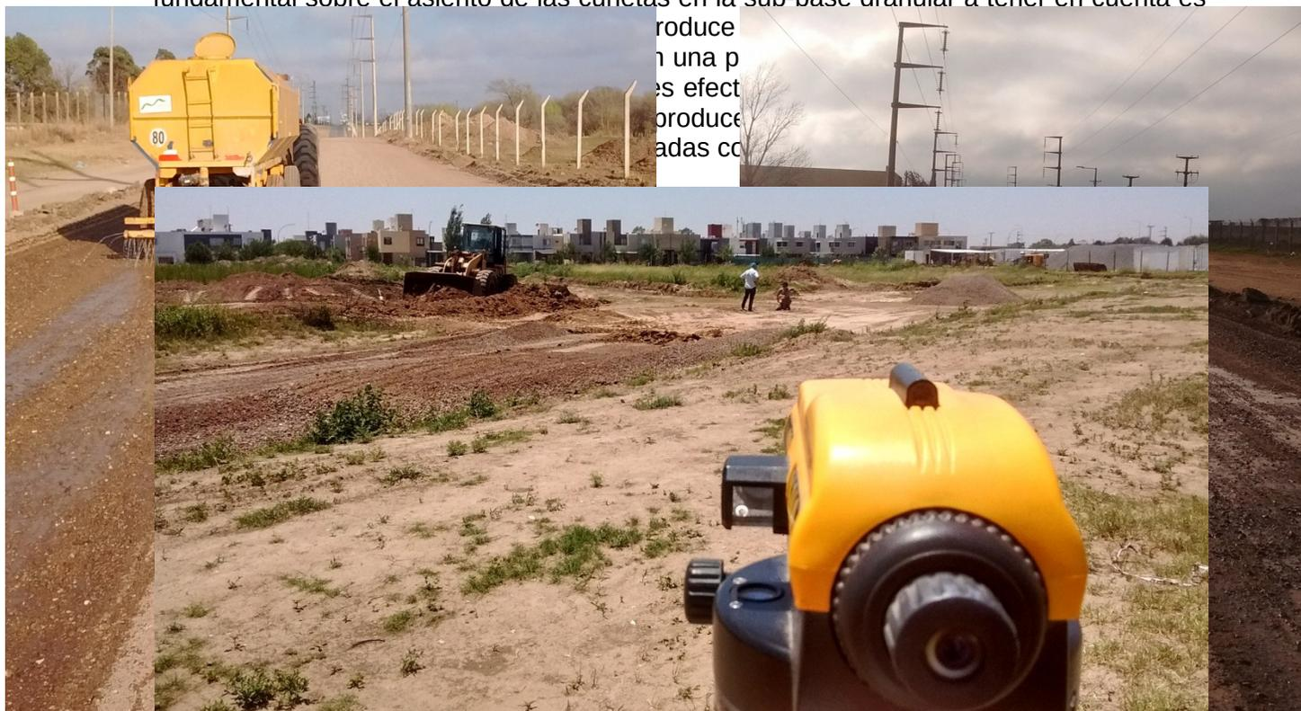
**Imagen 4.28 : Colocación de estacas y nivelación de sub-base.**
