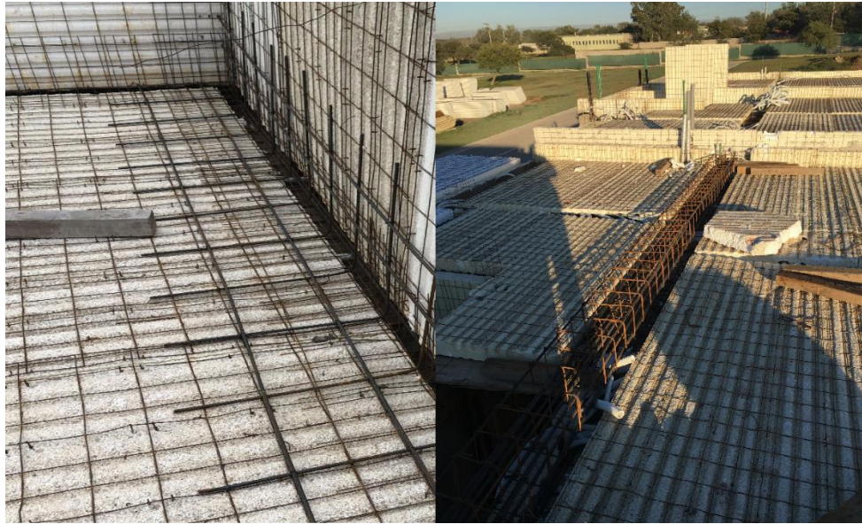
Figura 22 – Armado de losa, refuerzos estructurales.
