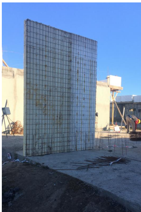
Figura 16 – Montaje panel en planta baja.
