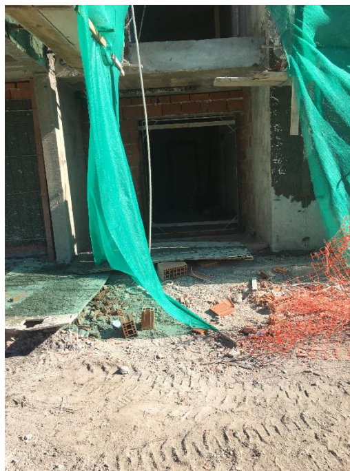
Figura 38 – Orden y limpieza obra con sistema constructivo tradicional.
