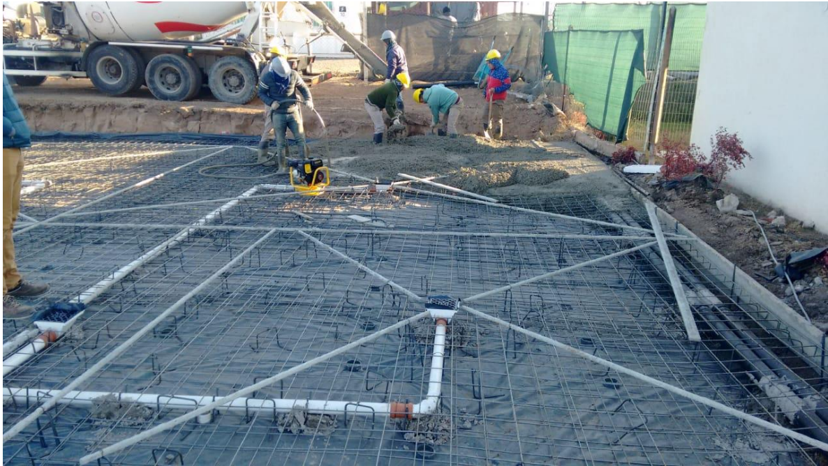
Figura 14 – Llenado de platea, caños de desagüe.
