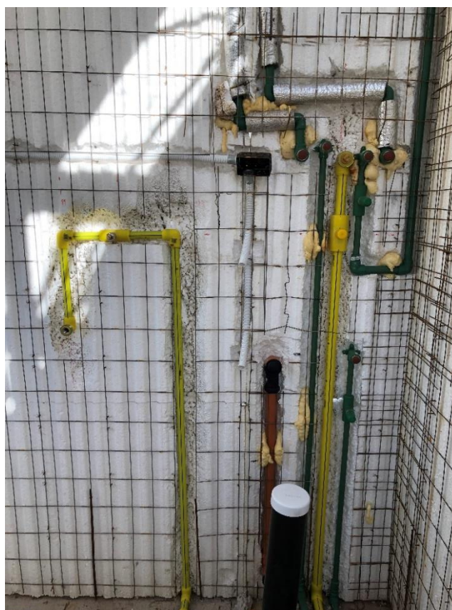
Figura 17 - Instalaciones sobre panel Emmedue.
