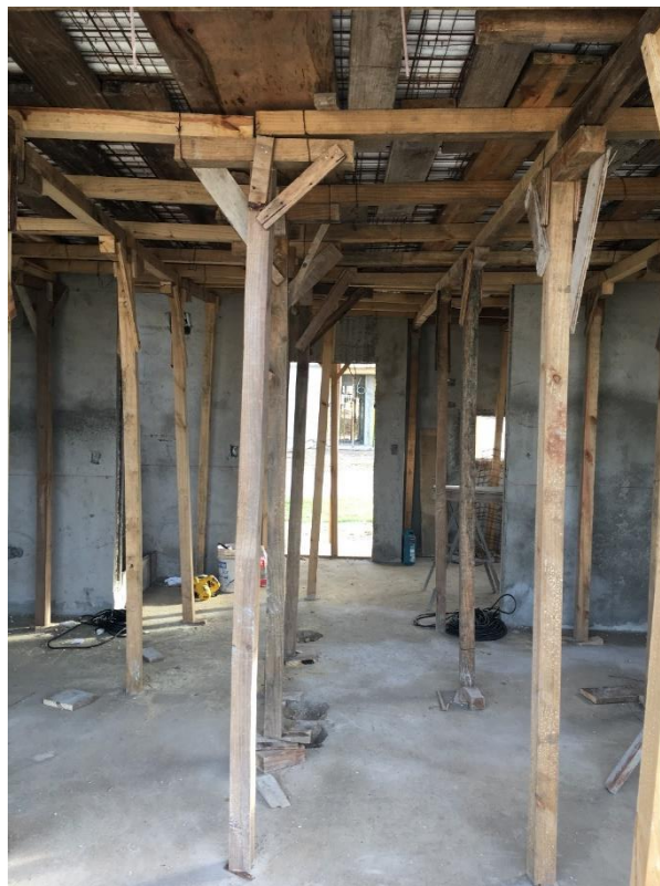
Figura 23 – Apuntalamiento losa de planta baja.
