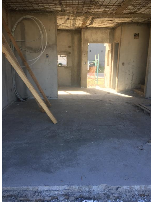
Figura 37 – Orden y limpieza obra con sistema Emmedue.
