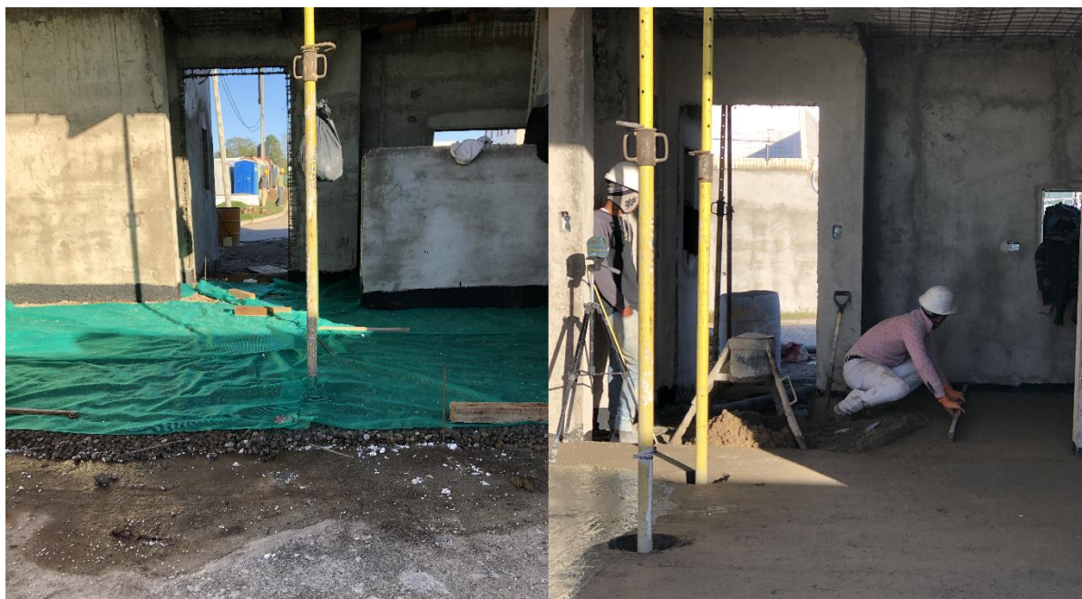
Figura 21 – Ejecución de contrapiso en planta baja.
