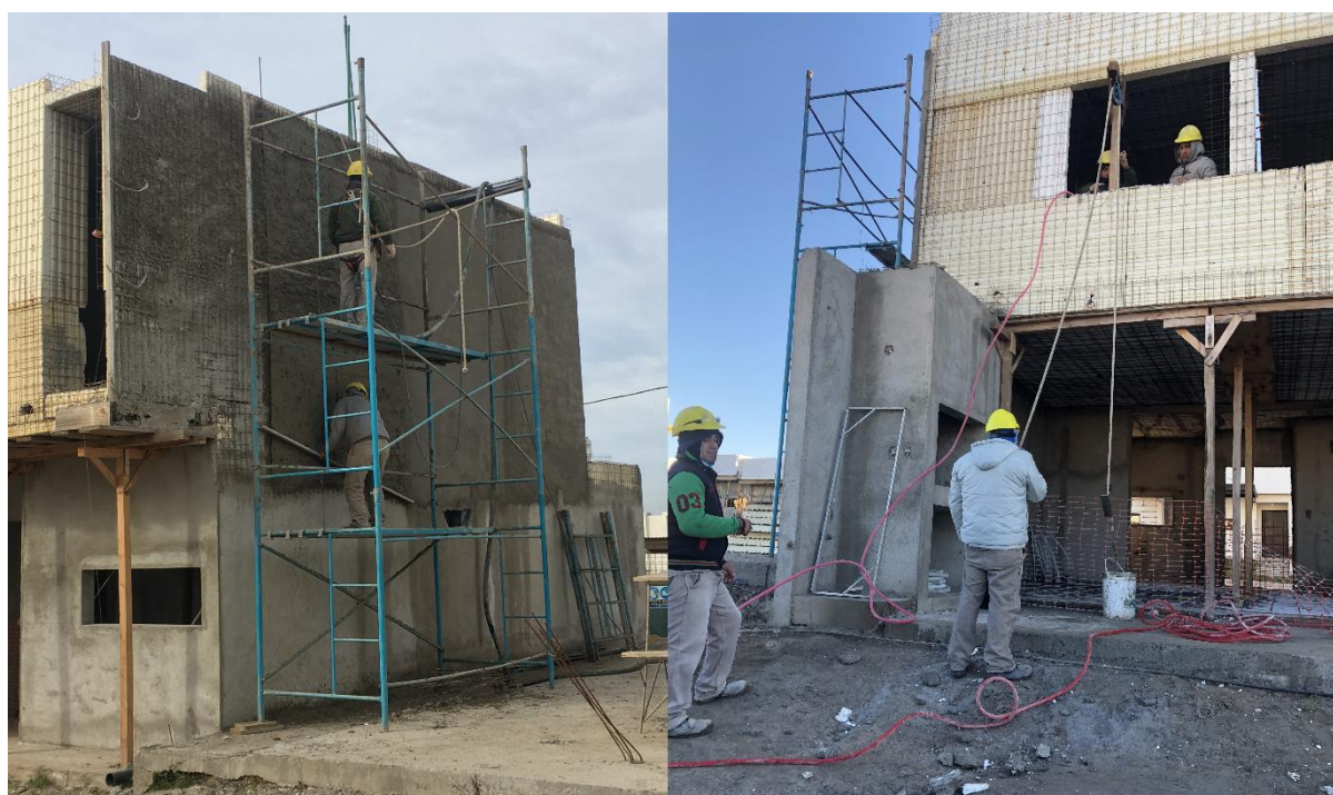
Figura 25 – Proyectado de mortero en planta alta, andamios e izaje de materiales.
