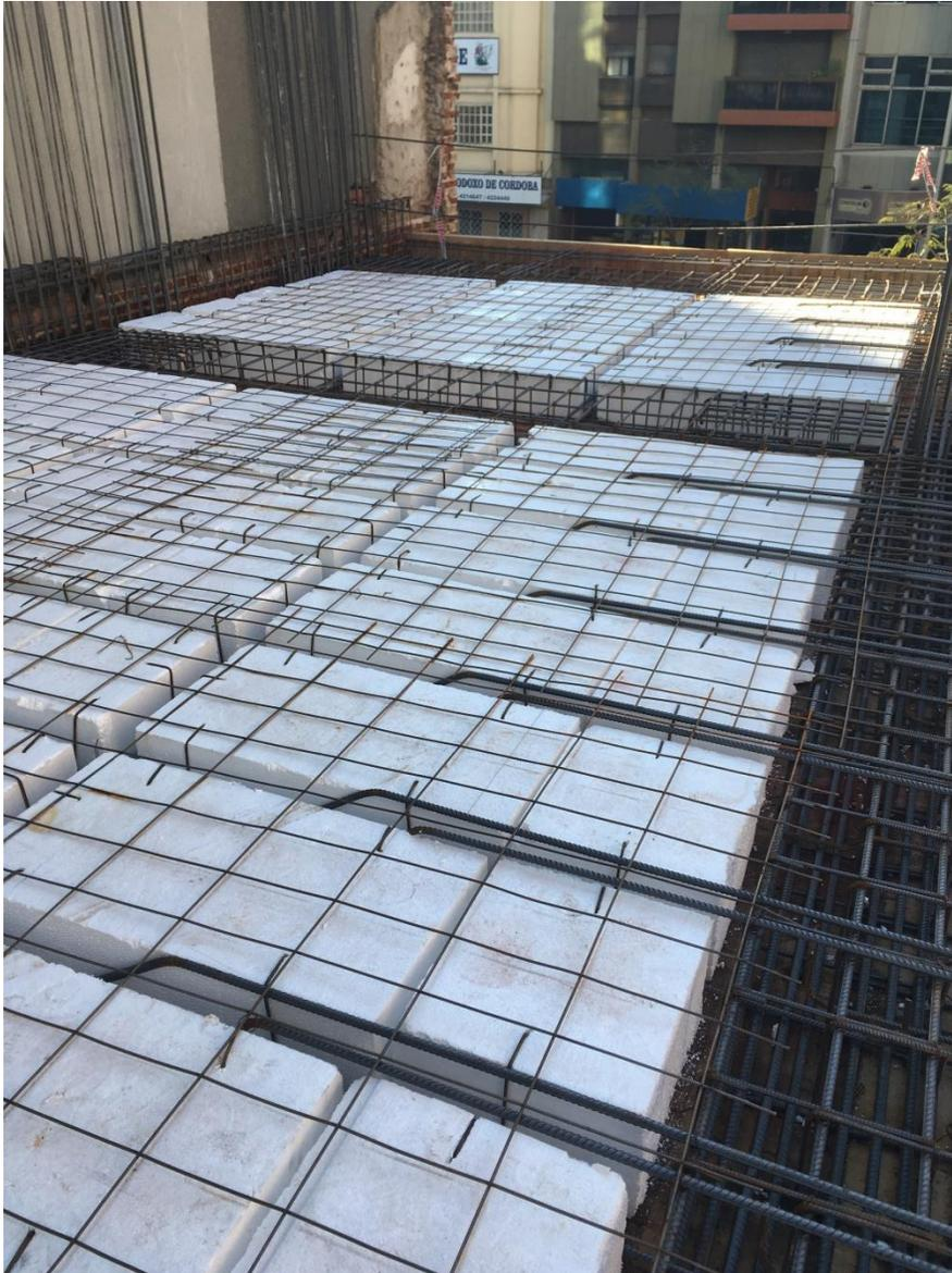
**Figura 4.22:** Losa Armada, con nervios y malla sima.
