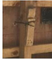
**Figura 4.6:** Detalle de ataduras de alambres con cuñas.
