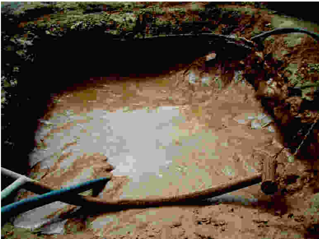
Ilustración 10 Pileta de lodo luego de una perforación de pilote
