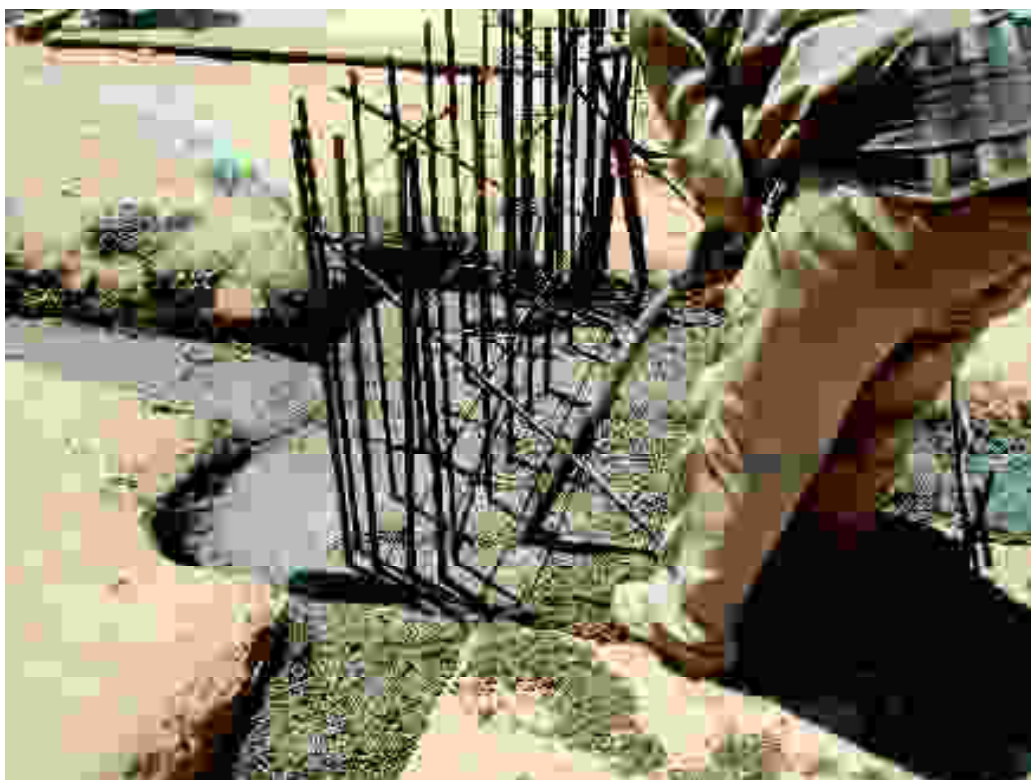
Ilustración 22 Vibrado de hormigón en cabezal y vigas riostras
