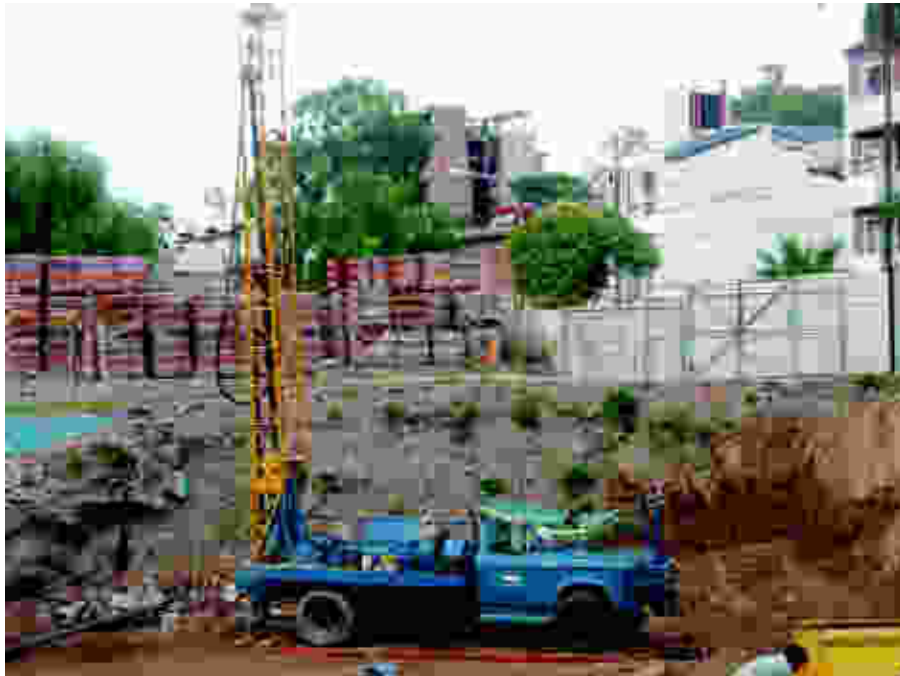
Ilustración 9 Camión perforador de pozos para pilotes
