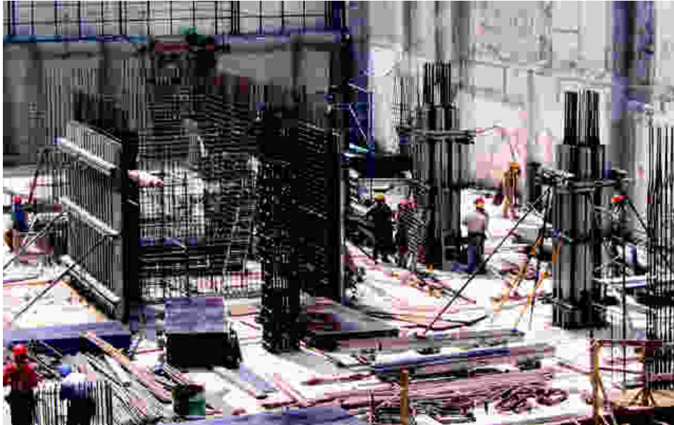
Ilustración 27 Encofrado de tabiques de hormigón
