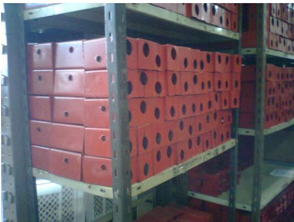
Las cajas metálicas de la izquierda son utilizadas para restringir (anulando o disminuyendo) el caudal de ingreso a la vivienda debido a algún tipo de incumplimiento. Dichas cajas se colocan envolviendo a la llave maestra, de manera de evitar el manipuleo por personas ajenas a la prestación del servicio.
