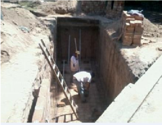
Figura 5.16 – Excavación y ejecución de la platea de hormigón armado en la Cámara enterrada
