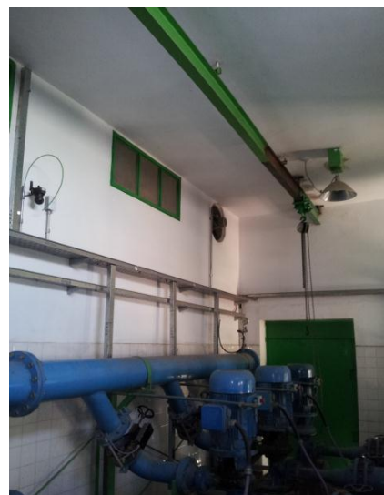
Figura 5.15 – Monorrailes con aparejo manual a cadena para los sistemas de baja presión (provisorio) y alta presión
