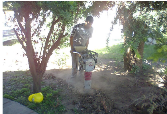
Figura 5.18 –Tendido de la cañería de descarga de PEAD de 90mm entre la cámara enterrada y el pozo absorbente y compactación de zanja
