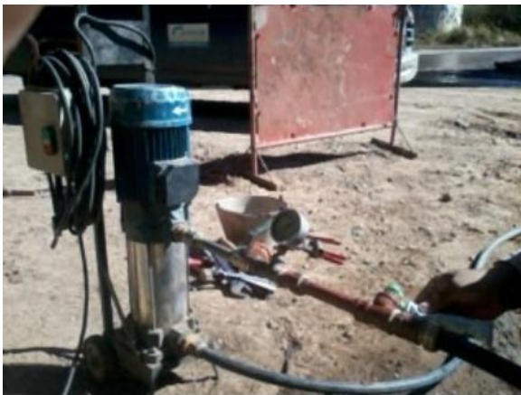
Figura 4.9 – Instalación para prueba hidráulica. Bomba, conexión de entrada de agua y conexión de salida de agua a alta presión con llaves y manómetro
