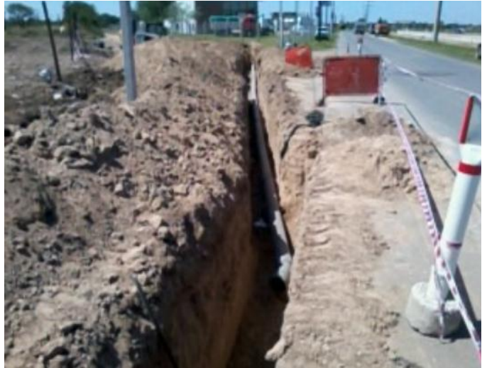
Figura 4.4 – Tendido de cañería de PVC DN 200mm en calle Colectora Av. Circunvalación – Obra N°56
