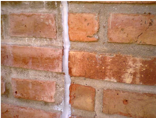
Figura 5.5 – Encuentro de muros viejo y nuevo, impermeabilizado con sellador SIKA 1A
