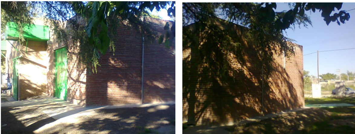
Figura 5.9 – Exterior de la Sala de Tableros
