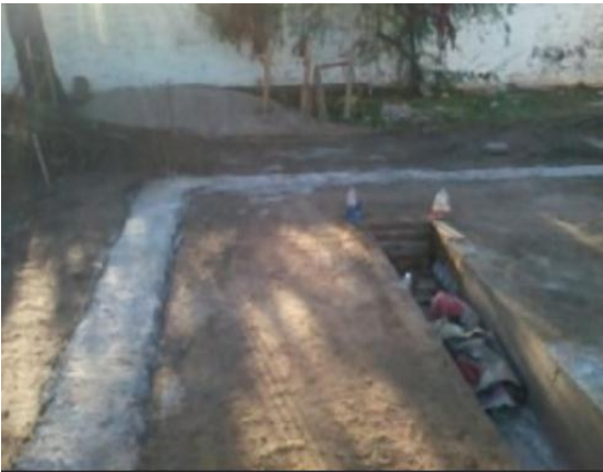
Figura 5.1 – Vigas de platea y trincheras para tendido eléctrico. En las esquinas de trinchera, pequeñas columnas de encadenado.
