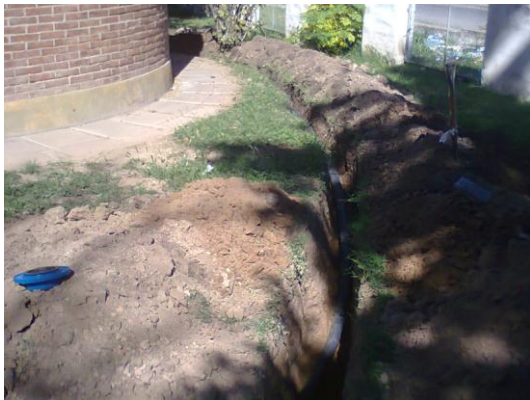
Figura 5.18 –Tendido de la cañería de descarga de PEAD de 90mm entre la cámara enterrada y el pozo absorbente y compactación de zanja
