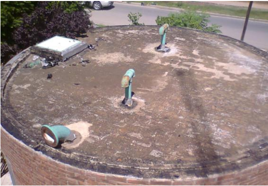
Figura 5.19 – Secado de la superficie de la capa de pendiente de la cubierta del Depósito para la posterior colocación de membrana asfáltica
