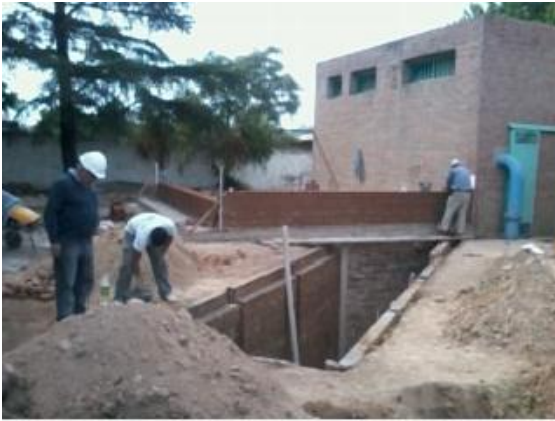
Figura 5.17 –Ejecución de muros y encadenados de la Cámara (izquierda) y Cámara terminada (derecha)
