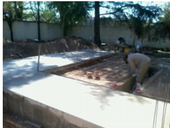
Figura 5.2 – Platea de hormigón armada en dos direcciones
