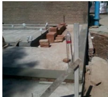
Figura 5.3 – Capa aisladora realizada sobre la platea
