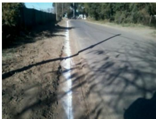
Figura 4.3 – Traza marcada para guiar la excavación en tramo de calzada de asfalto, previamente demolido y retirado – Obra N°56
