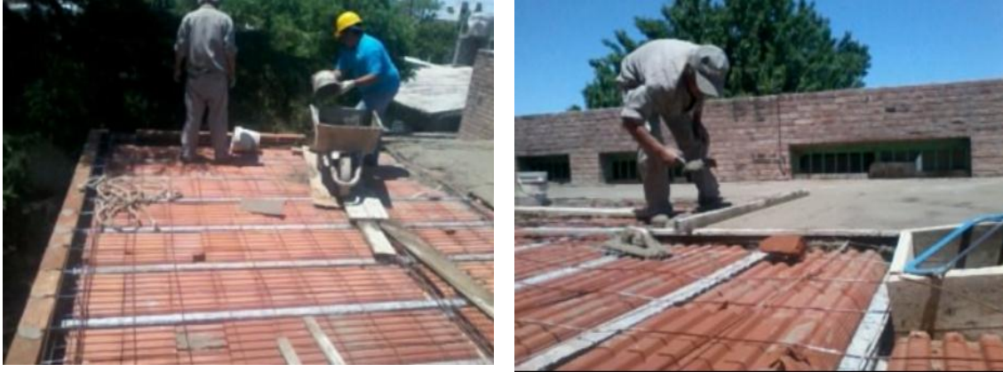
Figura 5.7 – Ejecución de la capa de compresión de la losa de viguetas
