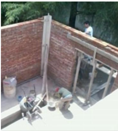
Figura 5.4 – Ejecución de muros, encadenados verticales y dintel de abertura
