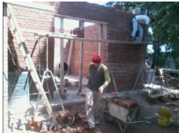
Figura 5.4 – Ejecución de muros, encadenados verticales y dintel de abertura
