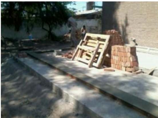
Figura 5.3 – Capa aisladora realizada sobre la platea
