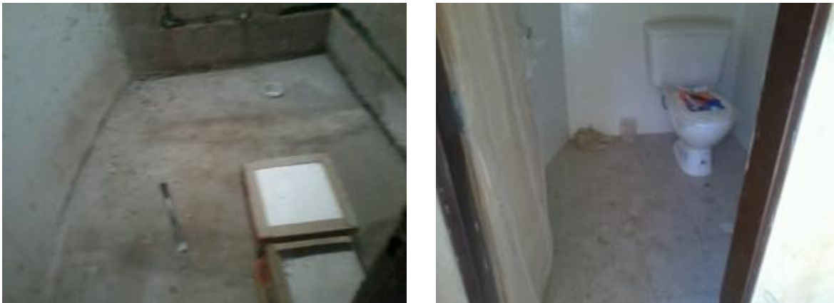
Figura 5.20 – Ejecución del toilette dentro del Depósito
