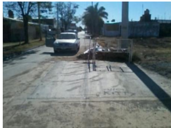
Figura 4.8 – Reconstrucción de losa de hormigón simple, empalme barrio Liceo – Obra N°56
