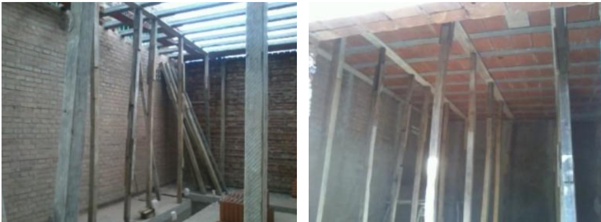
Figura 5.6 – Apuntalamiento de losa de viguetas y ladrillos cerámicos macizos
