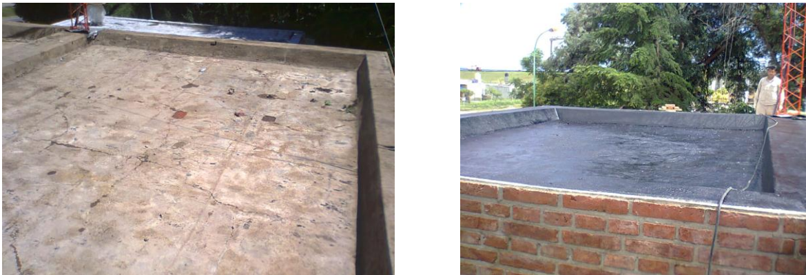
Figura 5.12 –Reparación de fisuras e impermeabilización de cubierta en S.T.
