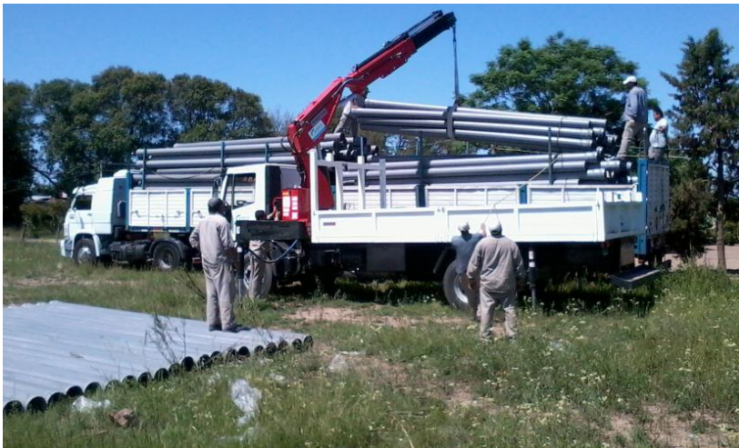
Figura 4.2 – Recepción en obra de caños de PVC DN 200mm
