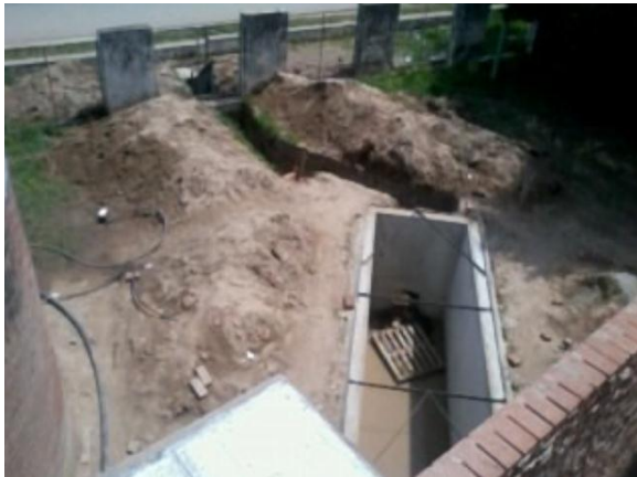
Figura 5.21 – Excavación de la obra de red y de la Cámara enterrada de Caudalímetro y Válvulas.
