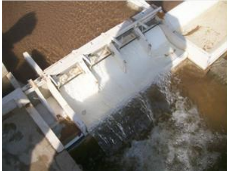
Figura 15: Tercera etapa de la metodología II de aperturas de compuertas
