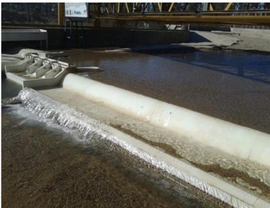
Figura 9: Primera etapa de la metodología I de aperturas de compuertas
