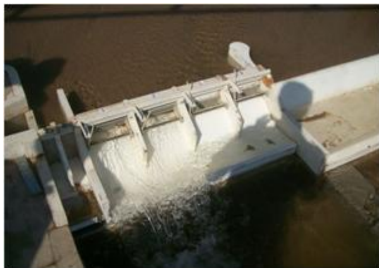
Figura 16: Cuarta etapa de la metodología II de aperturas de compuertas
