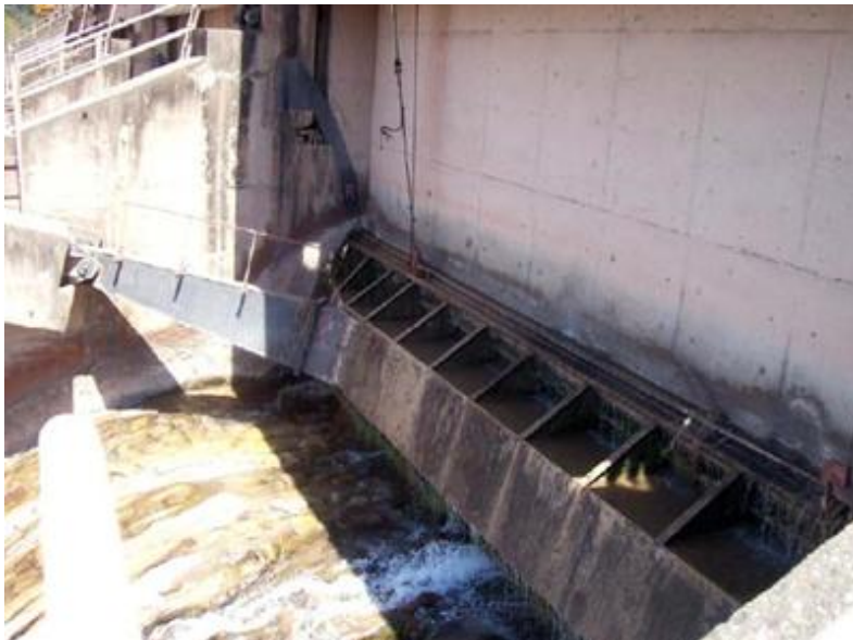
Figura 7: Problema en los sellos del Dique Móvil (DM)
