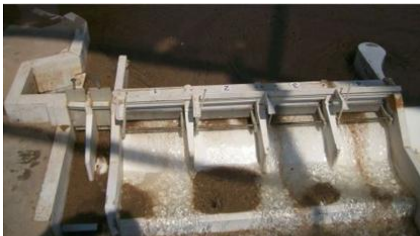
Figura 11: Cuarta etapa de la metodología I de aperturas de compuertas
