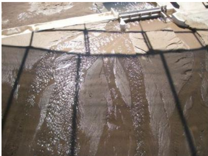
Figura 12: Cuarta etapa de la metodología I de aperturas de compuertas
