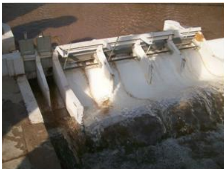
Figura 14: Segunda etapa de la metodología II de aperturas de compuertas
