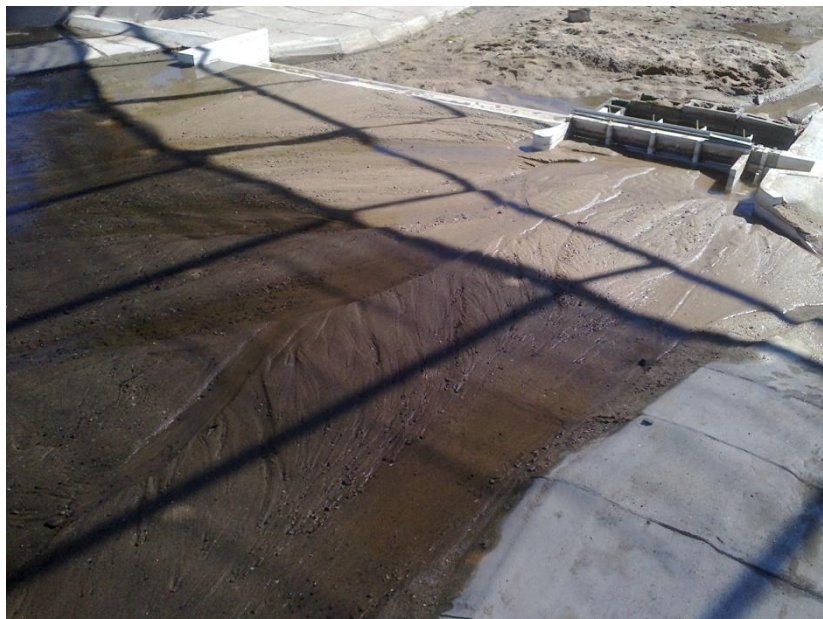
Figura 53: Superficie obtenida durante el ensayo en que se espera la crecida con compuertas abiertas con aporte de sedimentos continuo
