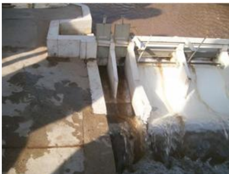
Figura 17: Quinta etapa de la metodología II de aperturas de compuertas
