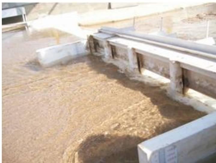
Figura 13: Primera etapa de la metodología II de aperturas de compuertas
