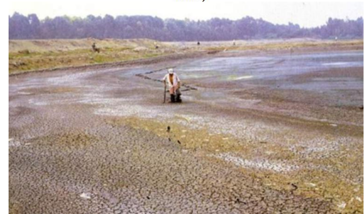
Figura 21. Imagen de lodo o barro del fondo de una laguna de tratamiento luego de transcurridos 10 años. Fuente Citon, Fabricio. (2014) 10
