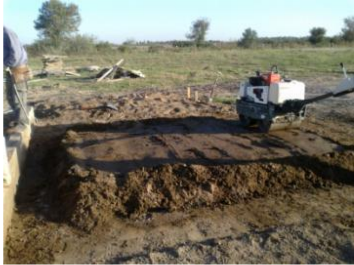
Figura 7.54: Compactación del suelo cemento.
