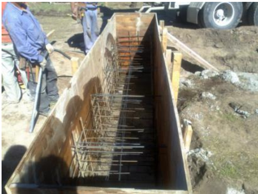
Figura 7.40: Encofrado de Cabezales
