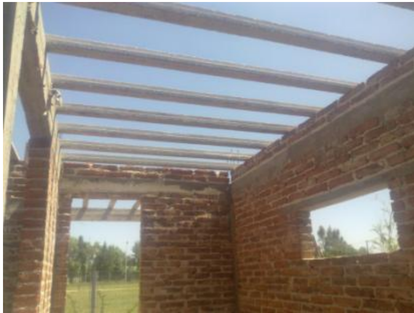
Figura 4.16: Dintel de cocina
