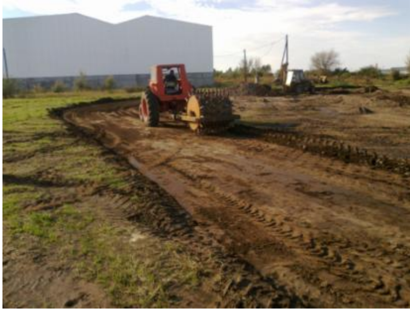
Figura 7.72: Compactación con rodillo pata de cabra.
