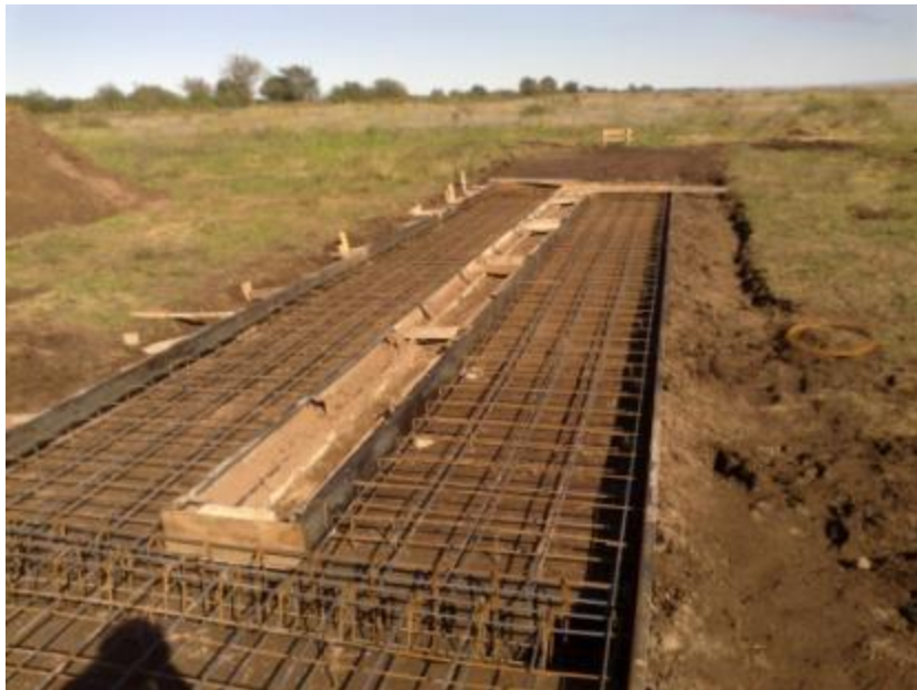
Figura 7.17: Pre-hormigonado
