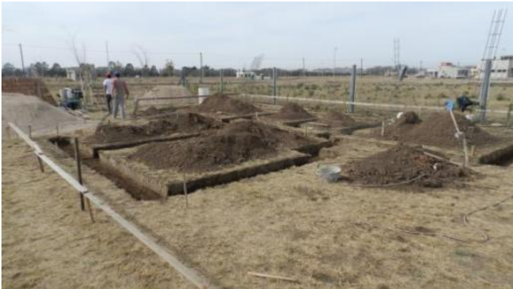
Figura 4.5: Corralito de replanteo y excavación de la fundaciones.
