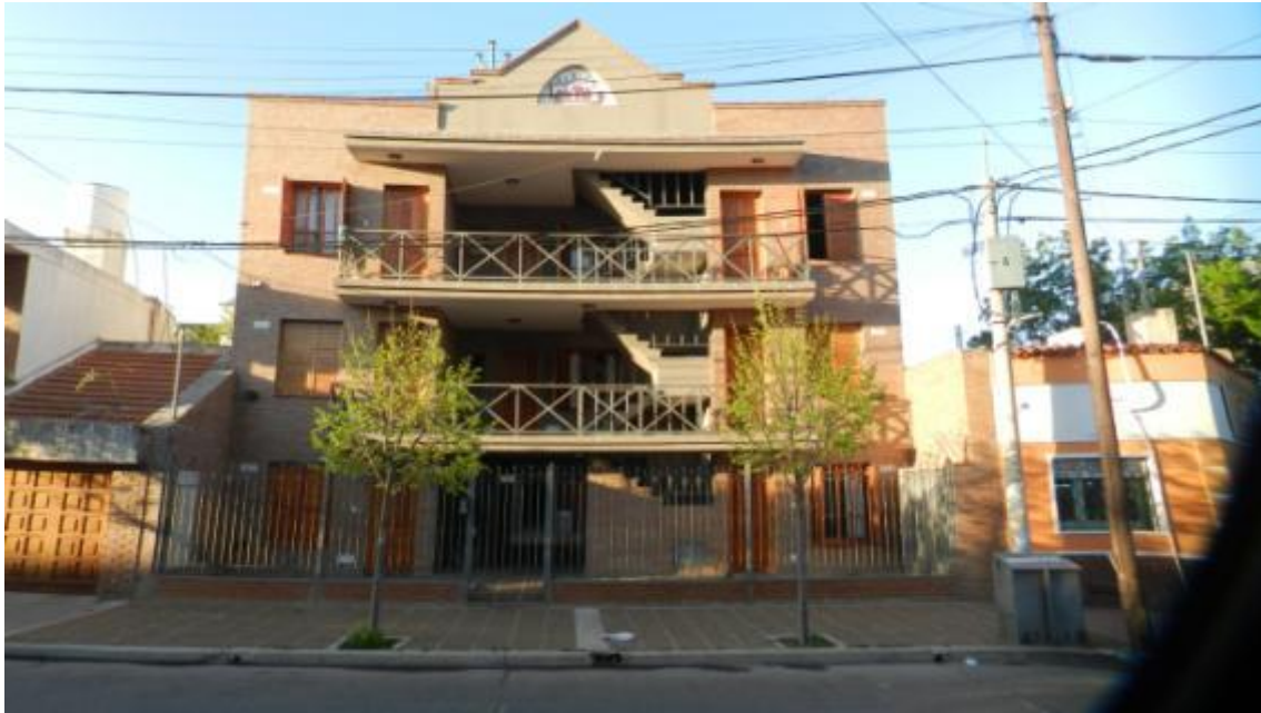
Figura 5.8: Fachada del Edificio
