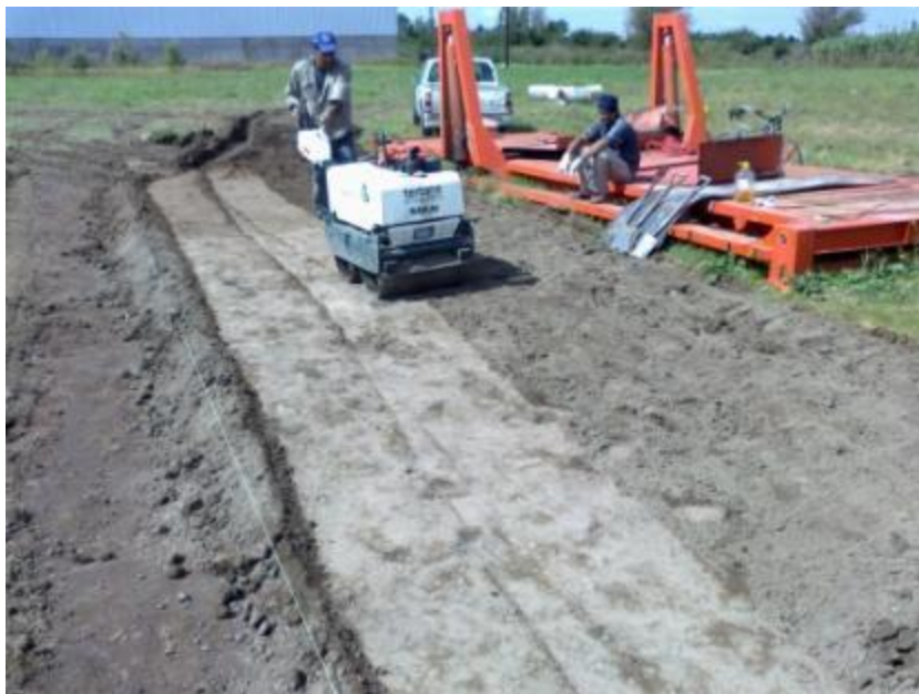
Figura 7.15: Compactación del suelo cemento
