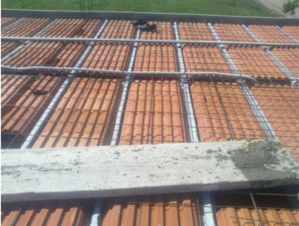
Figura 4.30: Malla electrosoldada en capa de compresión.
