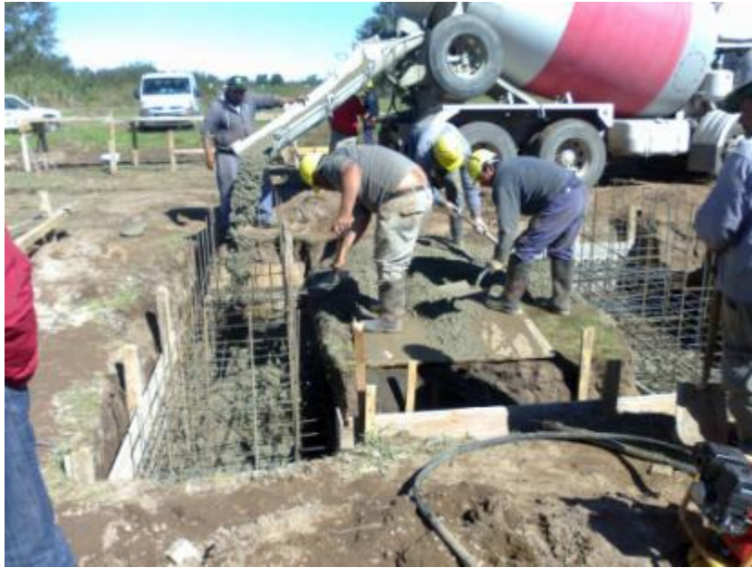
Figura 7.37: Colado del Hº en las bases
