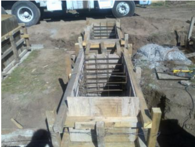
Figura 7.41: Encofrado de Cabezales
