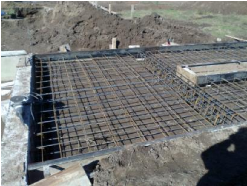
Figura 7.18: Losa de aproximación.
