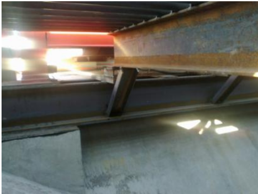
Figura 7.63. Anclaje de vigas
