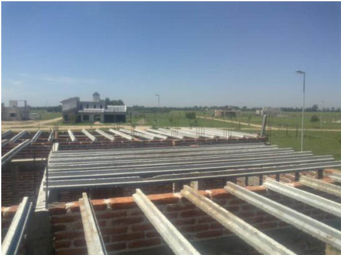
Figura 4.23: Losa de viguetas.
