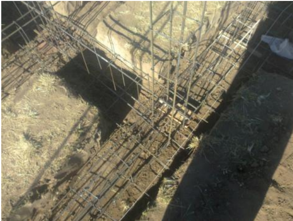
Figura 4.10: Entrelazado de armaduras.
