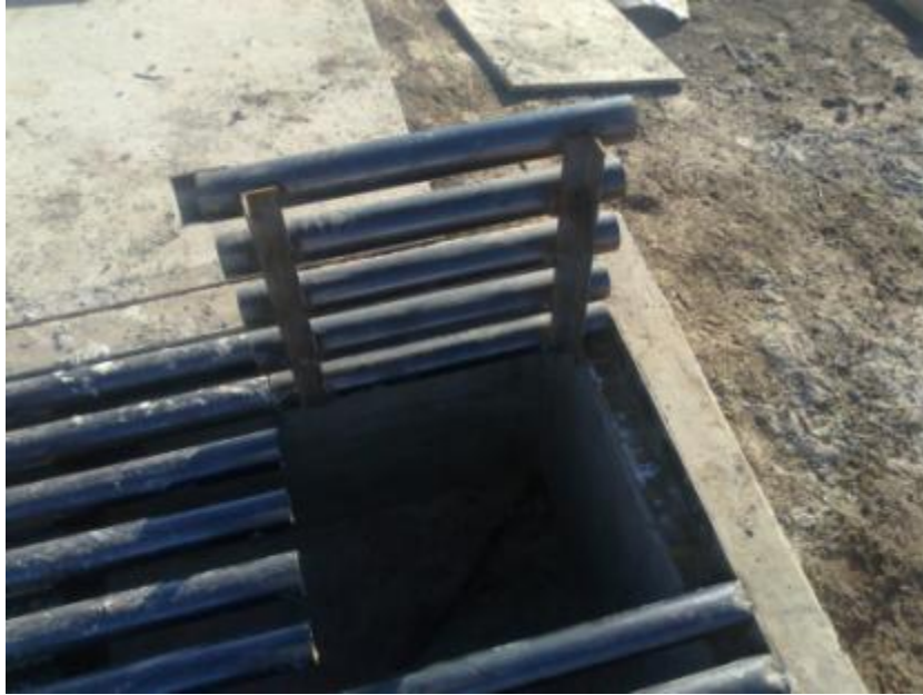
Figura 7.66: Abertura de acceso
