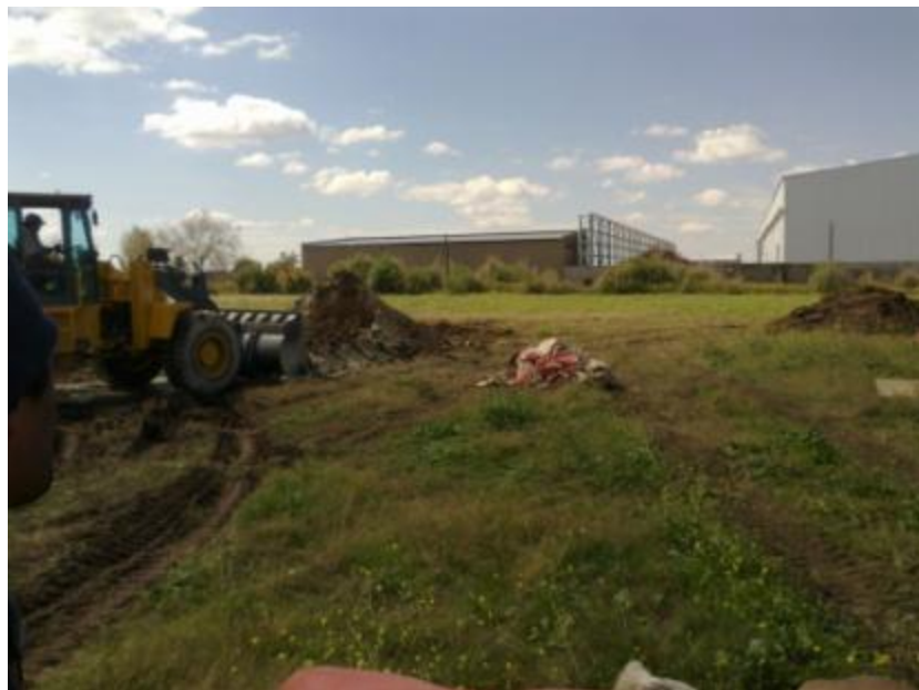
Figura 7.11:Mezclado de suelo cemento
