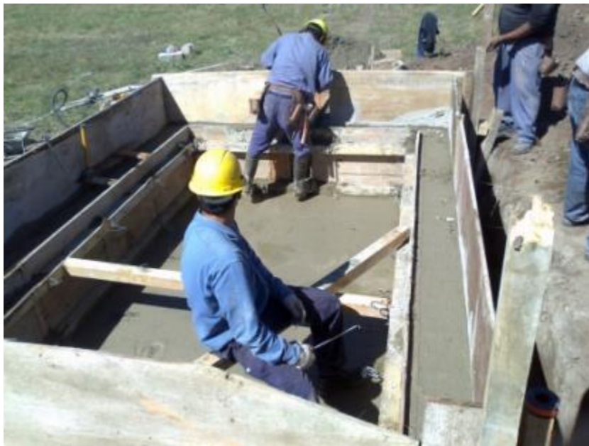
Figura 7.7: Hormigonado del recinto
