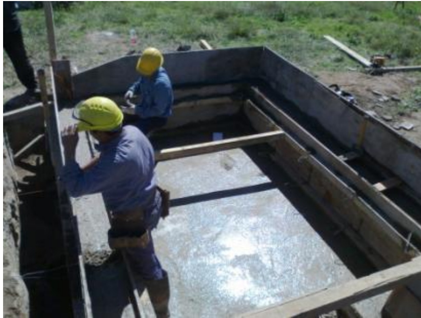
Figura 7.8:Hormigonado del recinto
