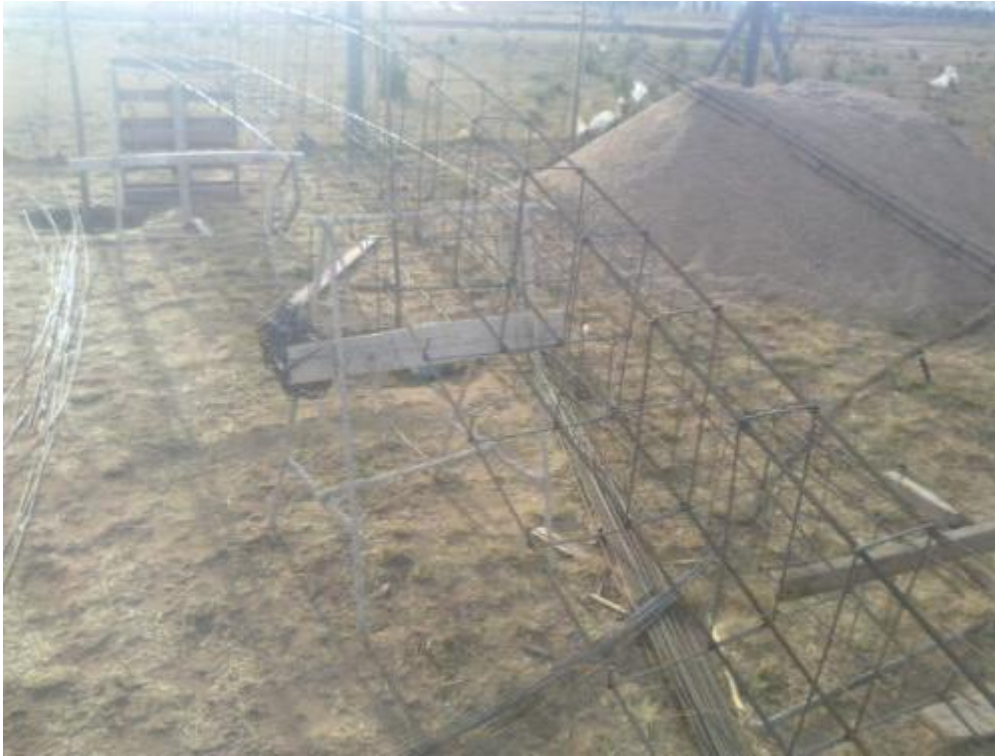
Figura 4.9: Armadura de zapatas corridas
