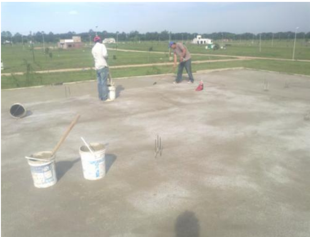
Figura 4.37: Curado del Hormigon con lechada cementicia
