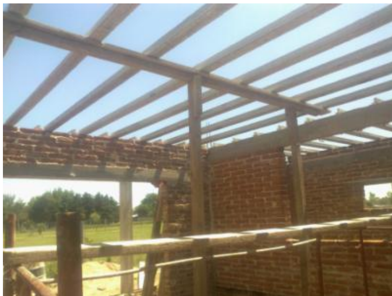
Figura 4.17: Encadenado superior.
