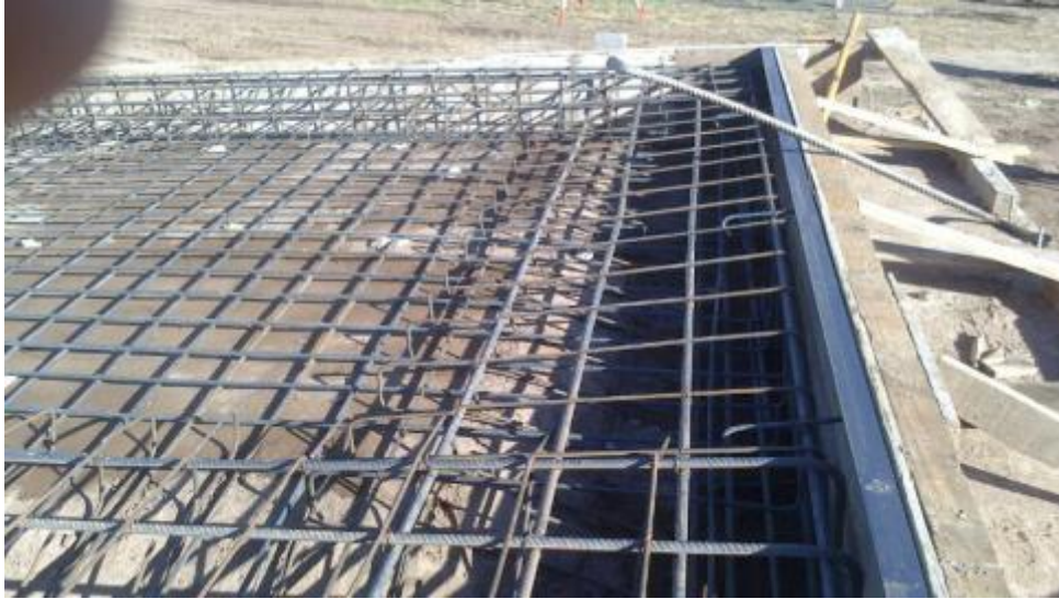
Figura 7.48: Armadura Losa de Aproximación
