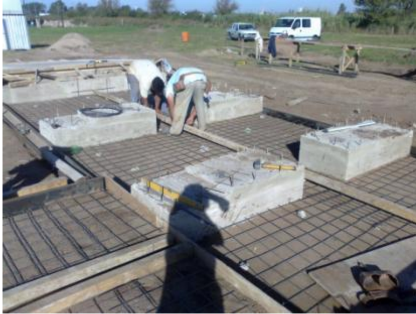
Figura 7.56: Colocación de la armadura.
