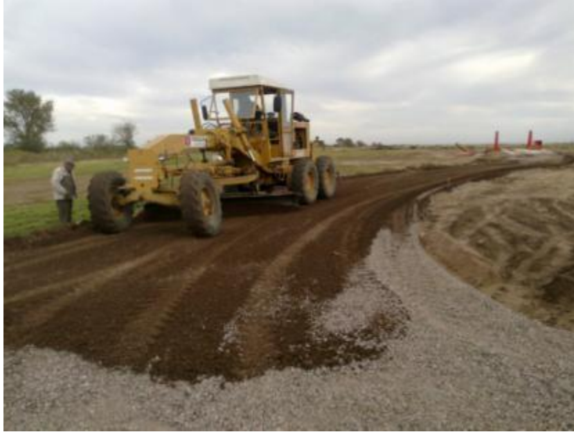
Figura 7.76: Motoniveladora distribuyendo tierra sobre piedra 0-20.
