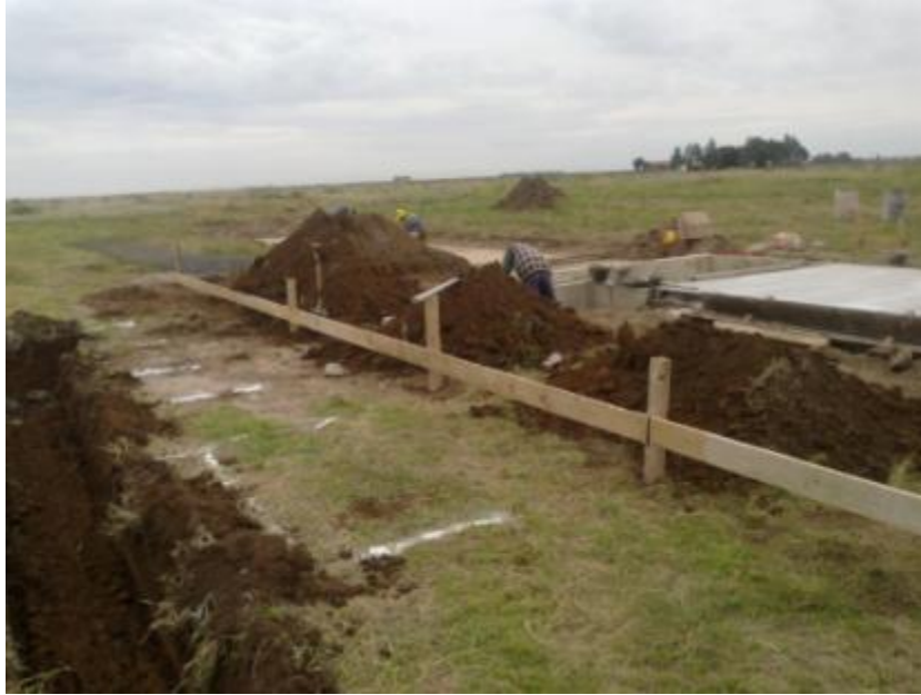
Figura 7.25: Corralito de Replanteo.
