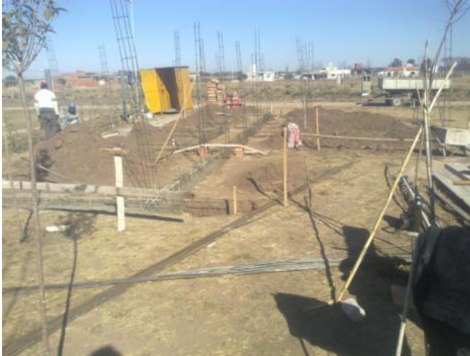
Figura 4.11: Armadura de columnas
