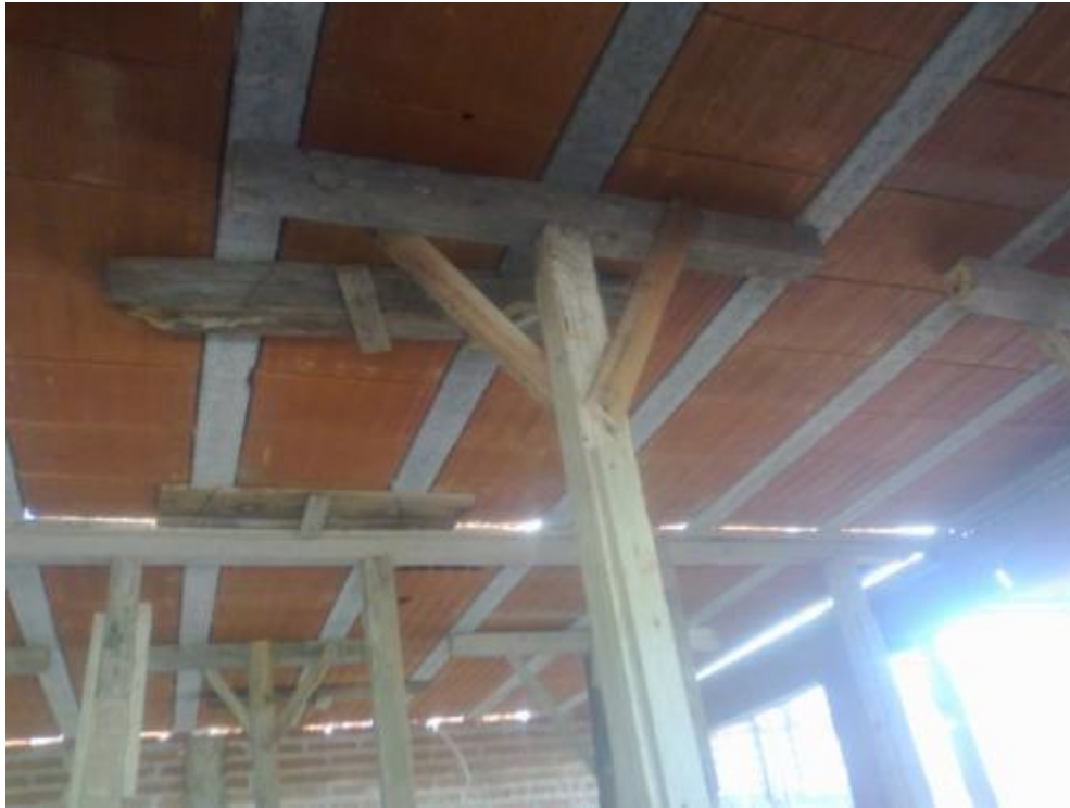
Figura 4.28: Apuntalamiento en Estar.
