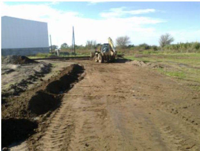
Figura 7.73: Base de asiento terminada.
