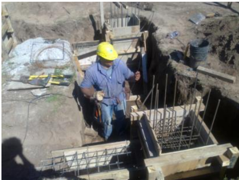
Figura 7.42: Encofrado de Cabezales.
