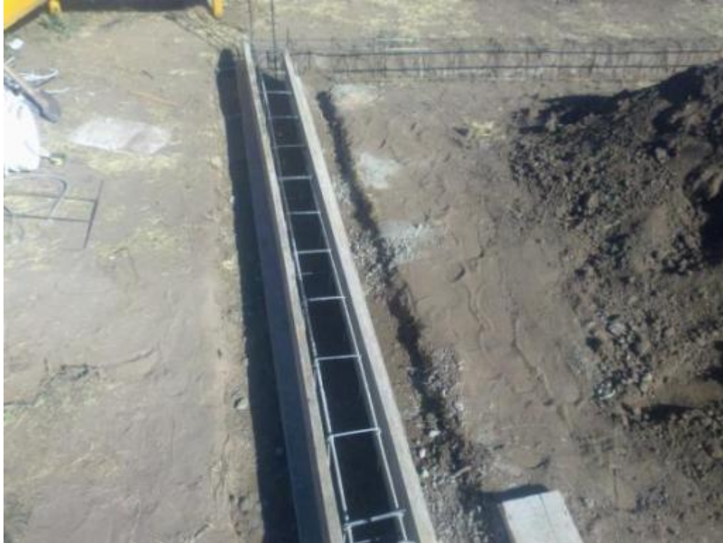
Figura 4.13: Vigas de fundación
