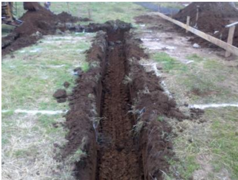
Figura 7.28: Excavación de las vigas riostra.
