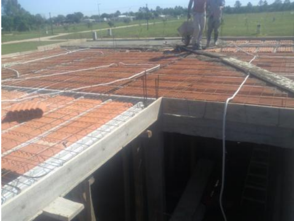
Figura 4.34: Hormigonado de la carpeta de compresion y vigas perimetrales.
