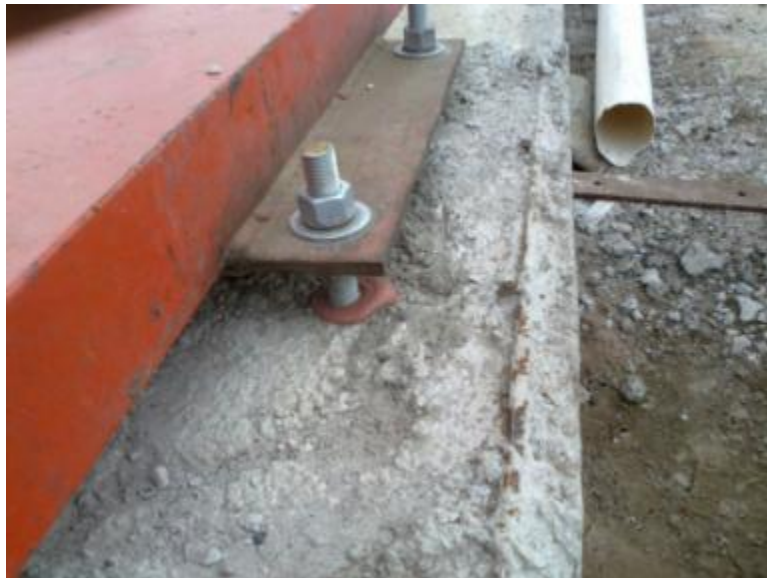
Figura 7.57: Anclajes químicos de la base
