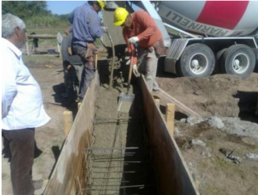
Figura 7.43: Hormigonado de Cabezales.
