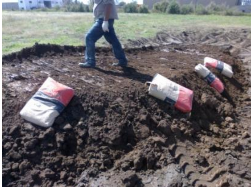
Figura 7.10:Suelo cemento de rampa de acceso
