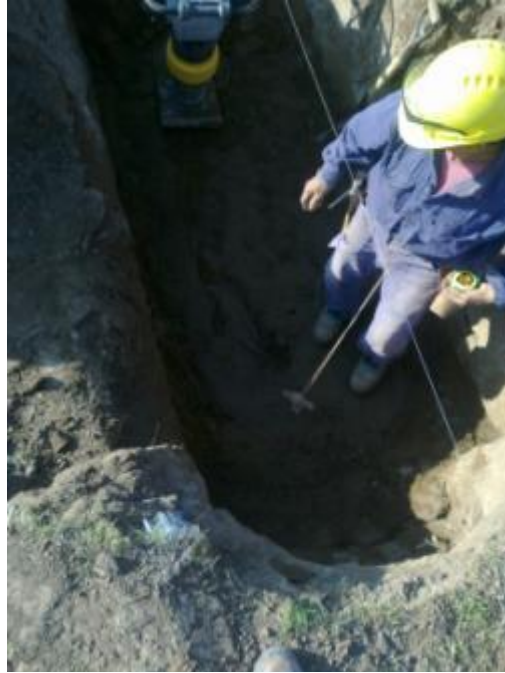
Figura 7.31: Construcción de suelo cemento.
