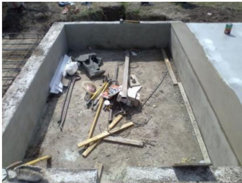
Figura 7.9:Desencofrado
