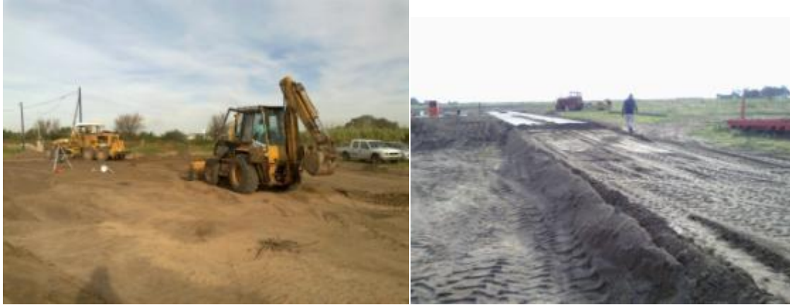
Figura 7.74. Trabajos de distribución de la piedra 0-20
