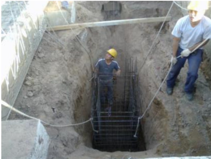
Figura 7.52:Colocación de Canasto
