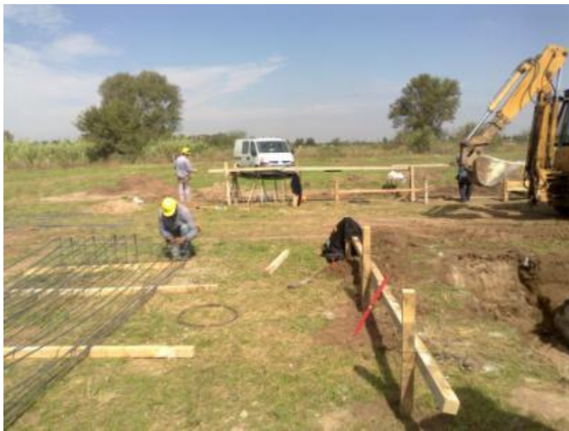
Figura 7.26; Corralito de Replanteo,
