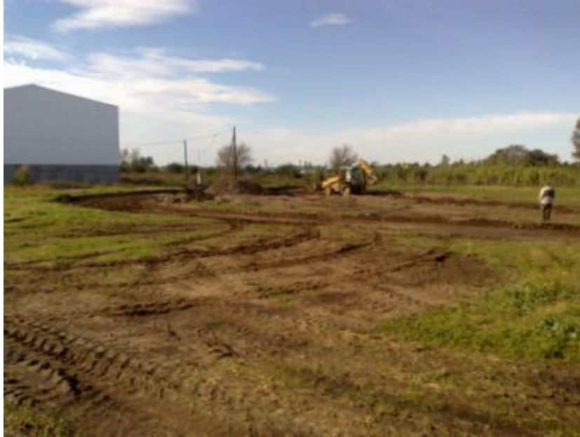
Figura 7.71: Realización de la caja y preparación de la subrasante
