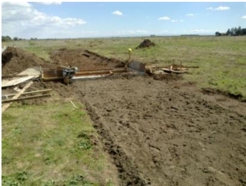
Figura 7.13: Distribución del suelo cemento
