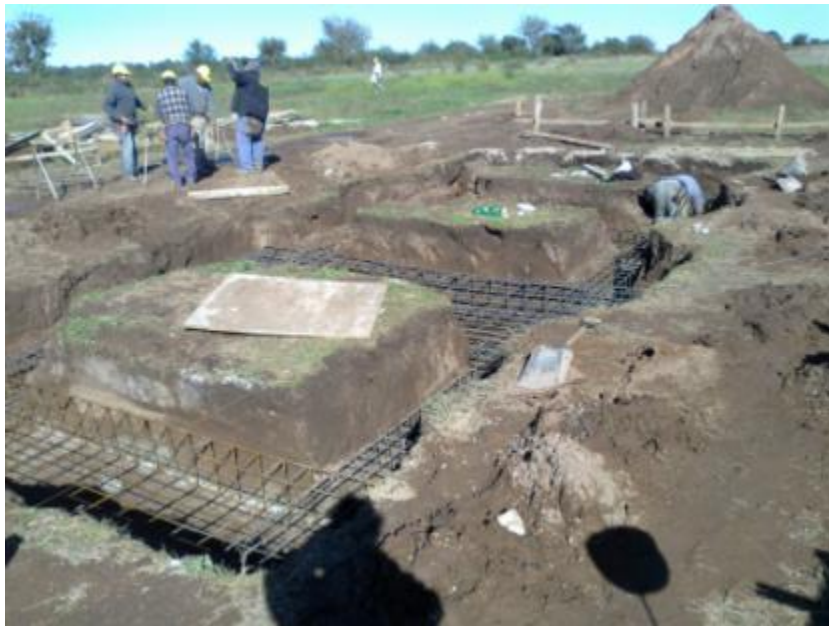
Figura 7.34: Armaduras de fundaciones
