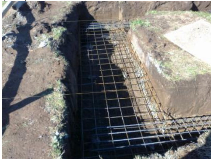
Figura 7.32: Armadura de Bases de fundación y vigas riostras.
