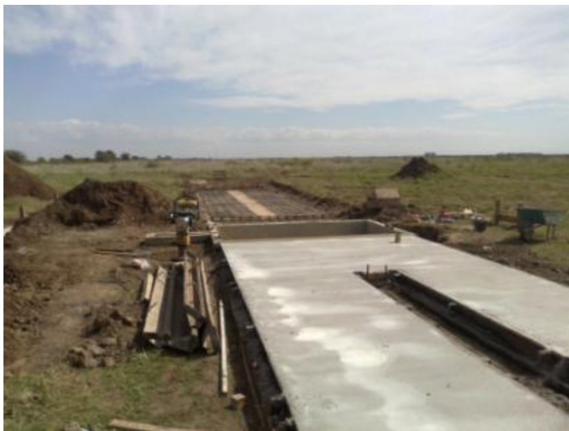
Figura 7.19: Hormigonado de la rampa de acceso Este
