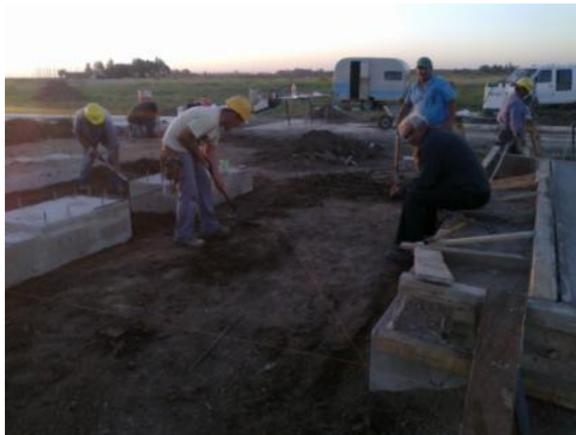
Figura 7.55: Compactación y nivelación de la carpeta.
