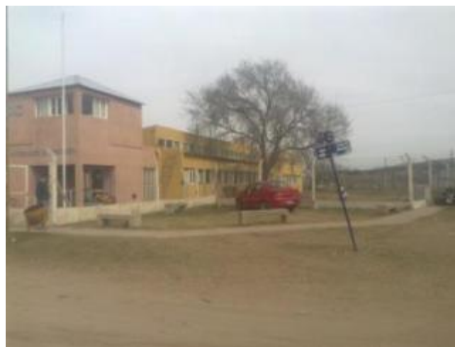
Figura 3.2: Fachada del Edificio
