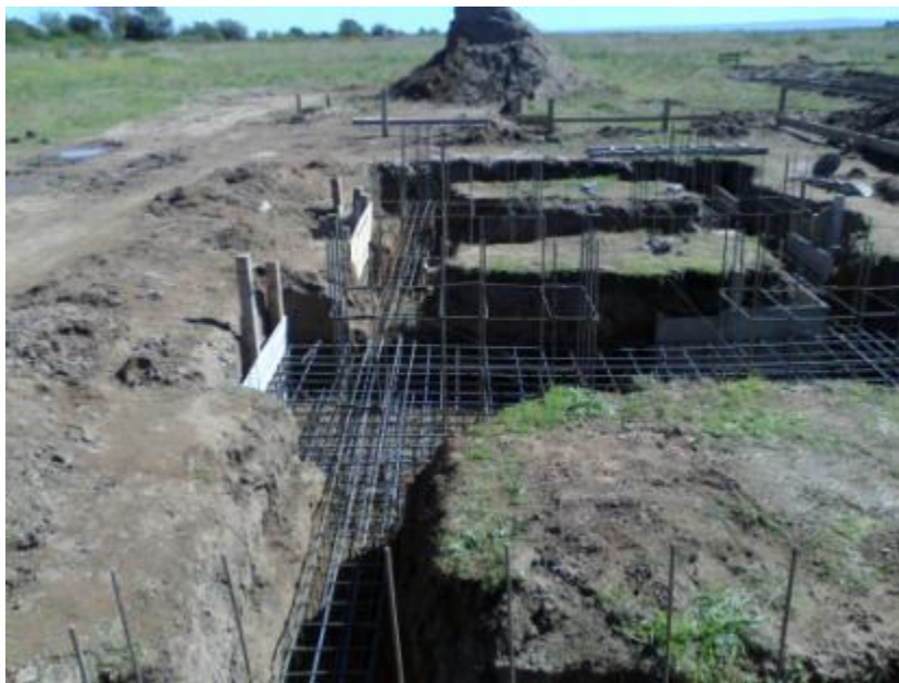
Figura 7.36: Armadura de Cabezales
