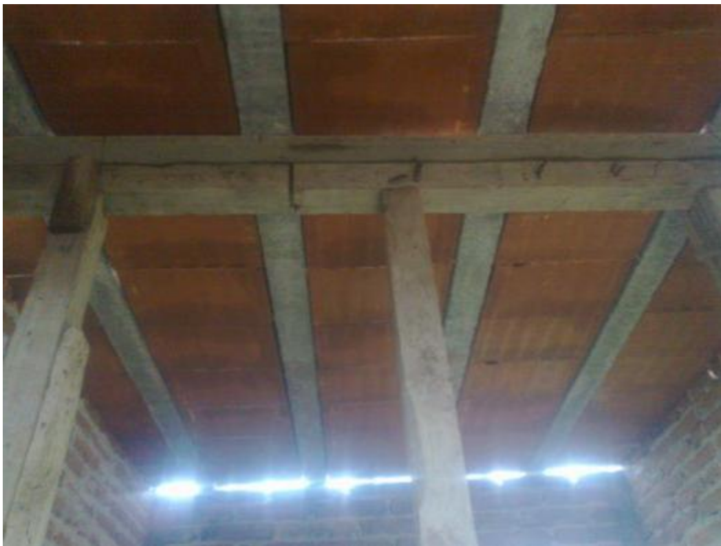
Figura 4.27: Cerramiento sup. y apuntalamientos del nervio trans.
