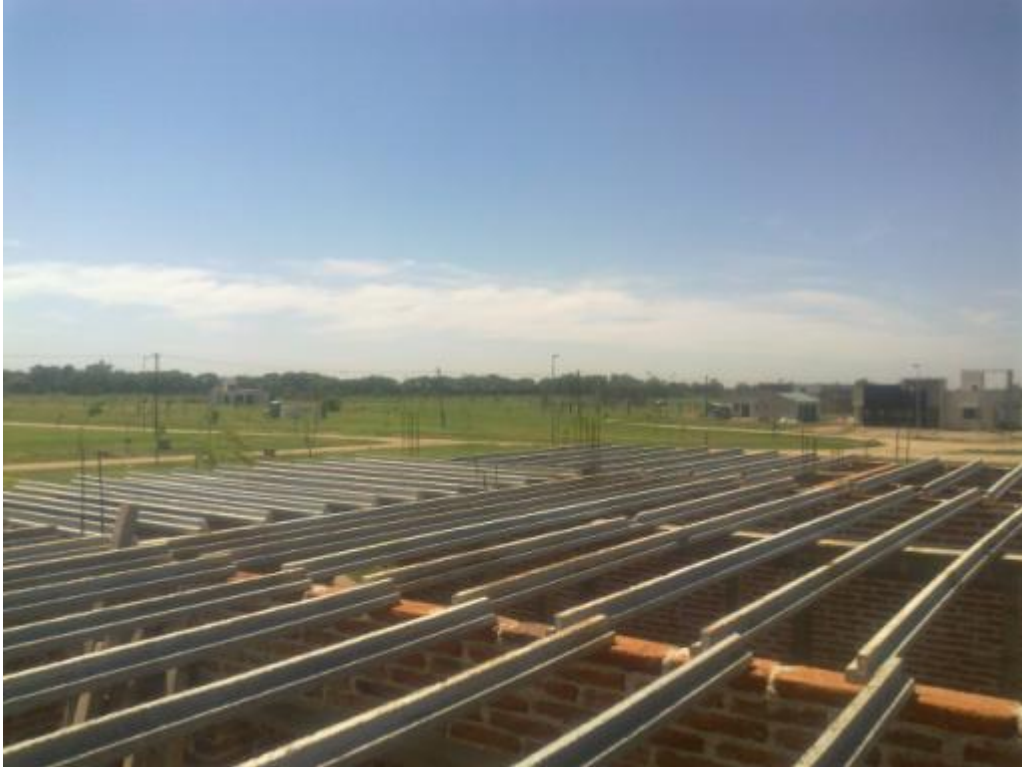
Figura 4.24: Losa de viguetas
