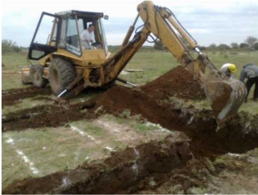
Figura 7.27: Replanteo y excavación
