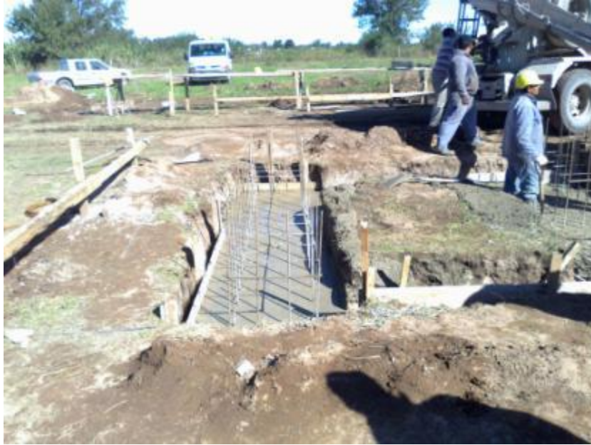
Figura 7.39: Finalización del colado del Hº de las bases
