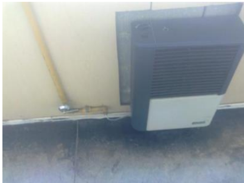
Figura 3.11: Flexible de conexión al calefactor.
