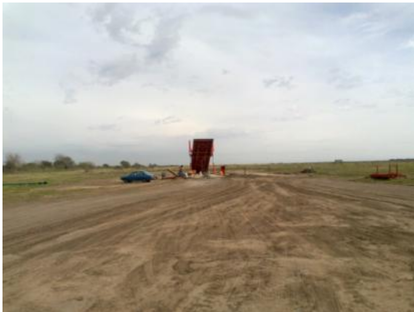
Figura 7.81: Finalización de trabajos en la zona de ingreso a la planta.
