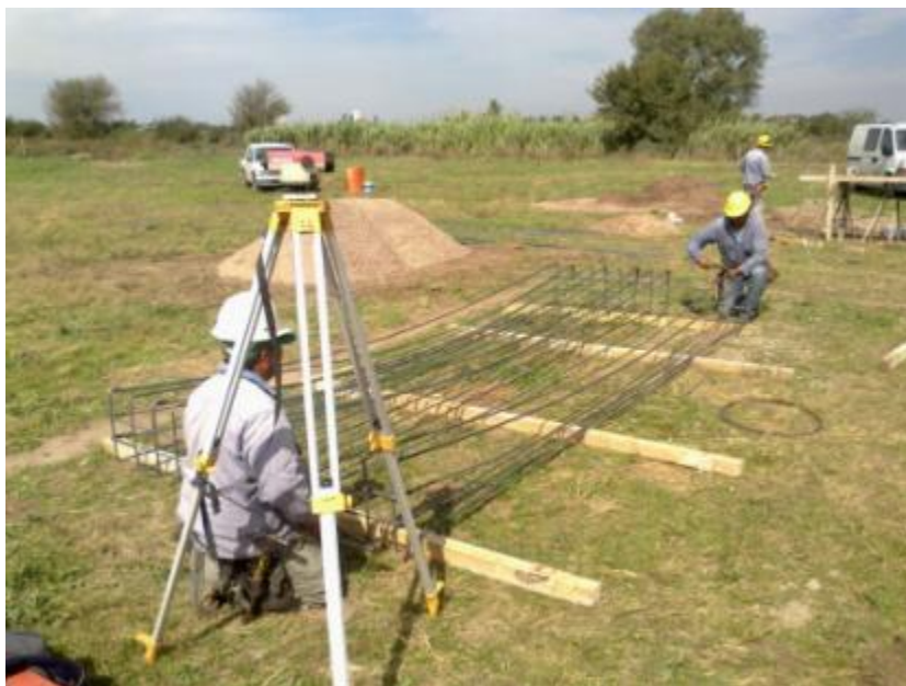
Figura 7.30: Nivel Optico y armadura de zapatas.
