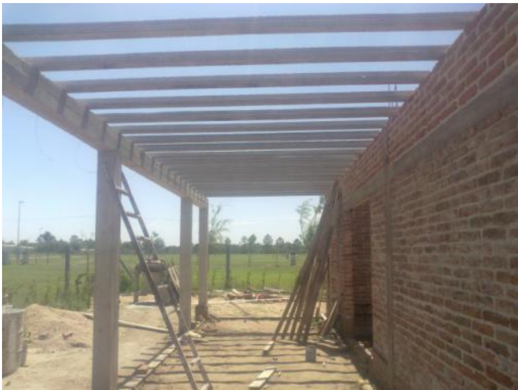
Figura 4.21: Cerramiento superior en garage
