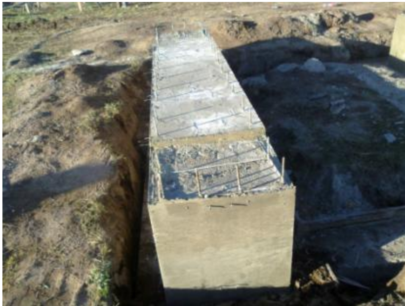
Figura 7.46: Desencofrado de Cabezal.
