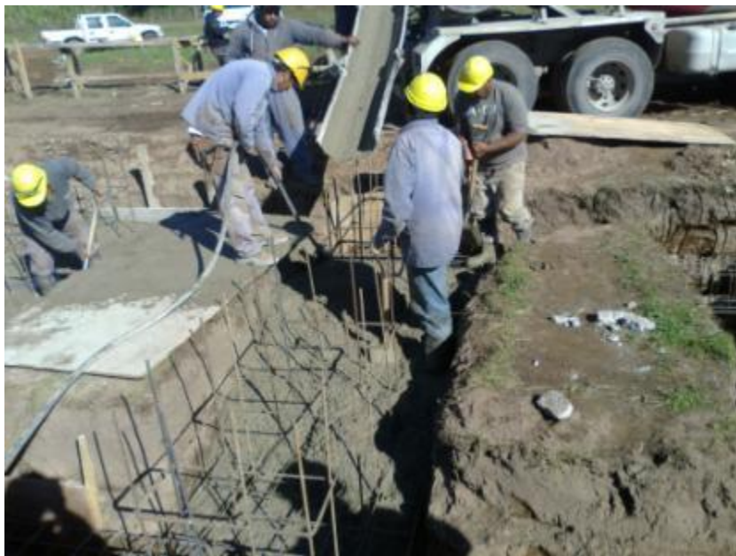
Figura 7.38: Colado del Hº de las bases y vigas riostras
