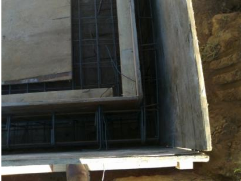
Figura 7.6: Armadura de las vigas perimetrales
