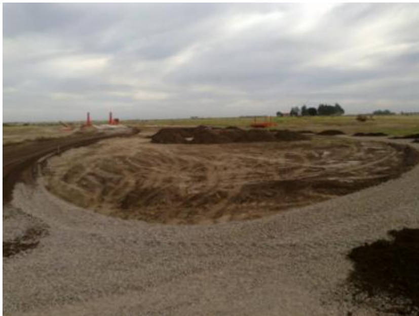
Figura 7.79: Relleno de suelo en zona interna de caminos
