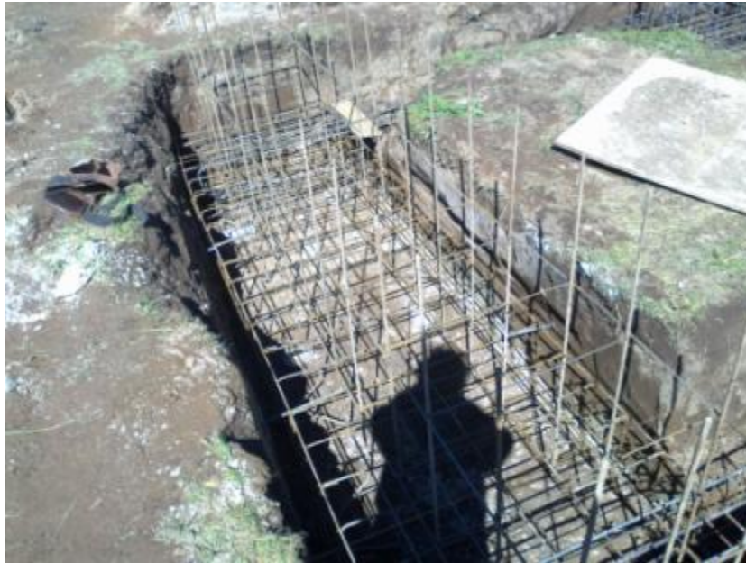
Figura 7.35: Armadura longitudinal de los cabezales.
