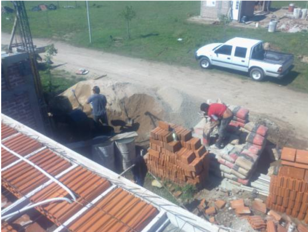
Figura 4.32: Hormigonado de cerramiento; Elaboración del H°
