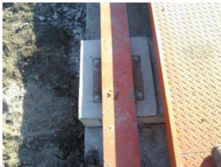
Figura 7.59: Relleno con Grouting
