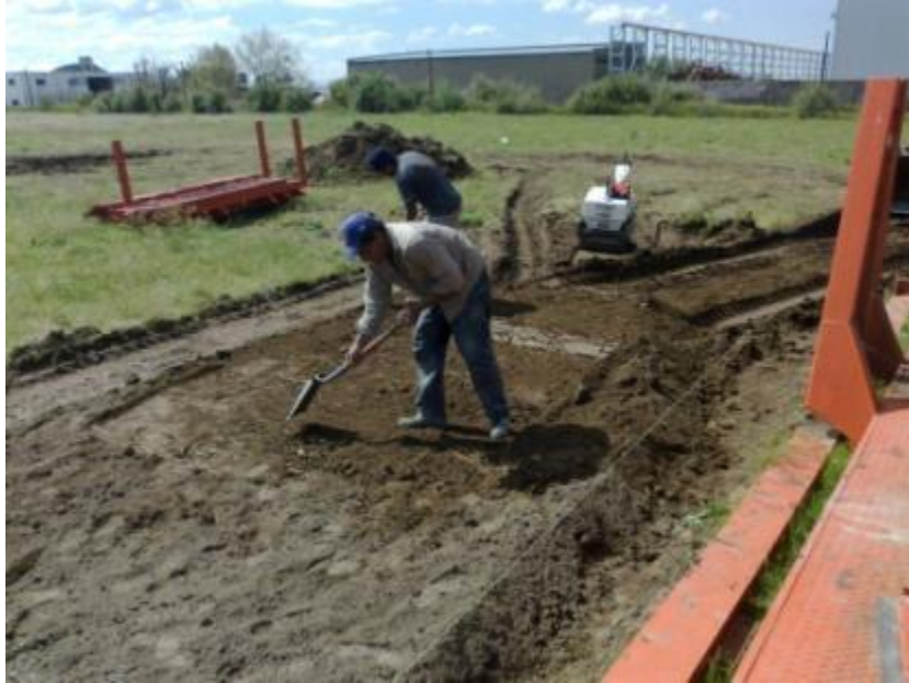
Figura 7.14: Distribución del suelo cemento
