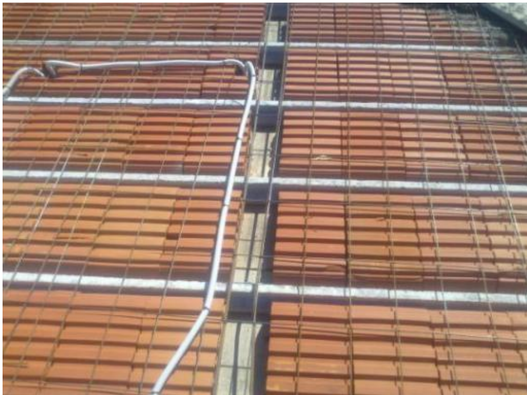
Figura 4.31: Armadura del nervio de repartición e instalación eléctrica.
