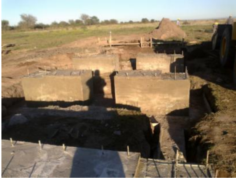
Figura 7.47: Desencofrado de los cabezales.
