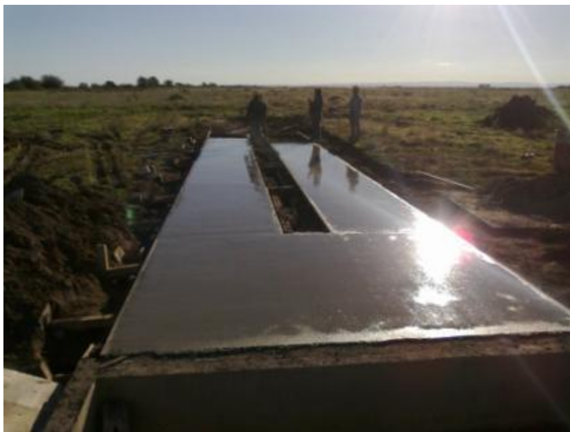
Figura 7.21:Cinteado y colocacion de antisol sobre Hormigon
