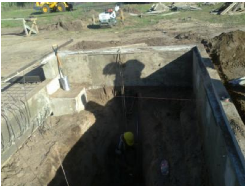
Figura 7.51: Vigas perimetrales de la Tolva
