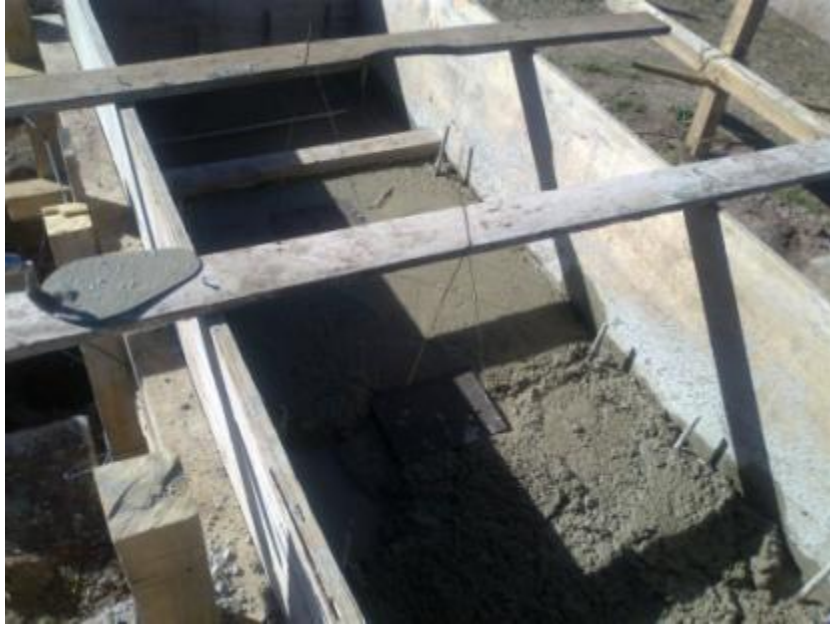
Figura 7.45: Fijación de las placas de apoyo de los rieles
