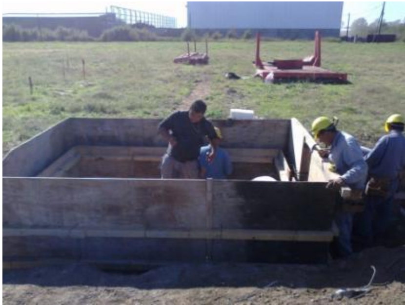
Figura 7.4: Construcción de recinto de H 0 A 0 para balanza
