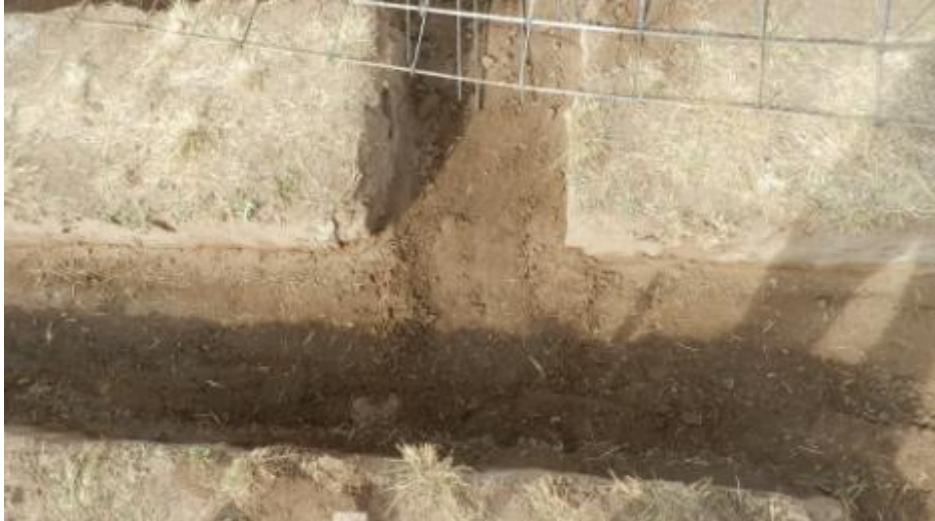
Figura 4.6: Excavación de cimientos
