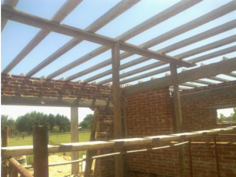
Figura 4.20: Replanteo de Viguetas y apuntalamiento de nervios de repartición
