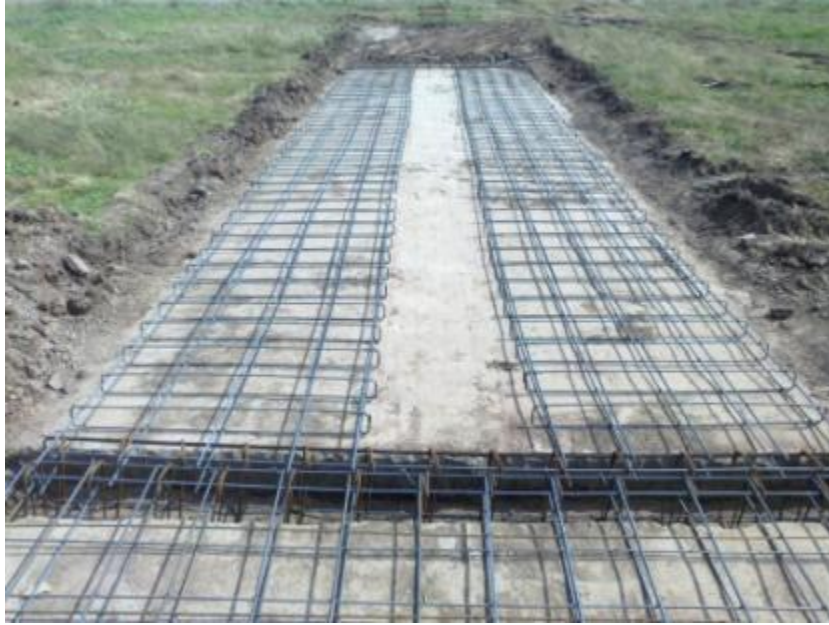
Figura 7.16: Armadura de la rampa de acceso
