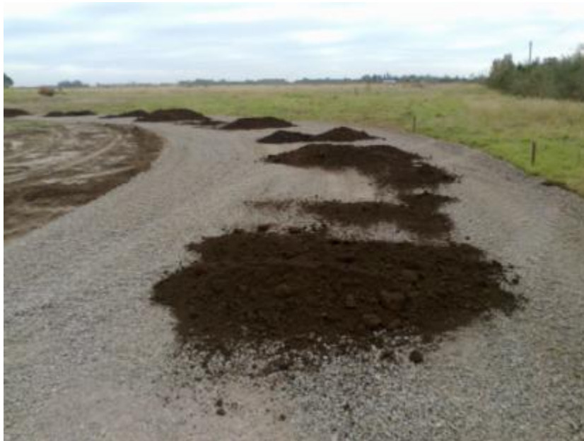
Figura 7.75: Distribución de suelo sobre piedra 0-20.
