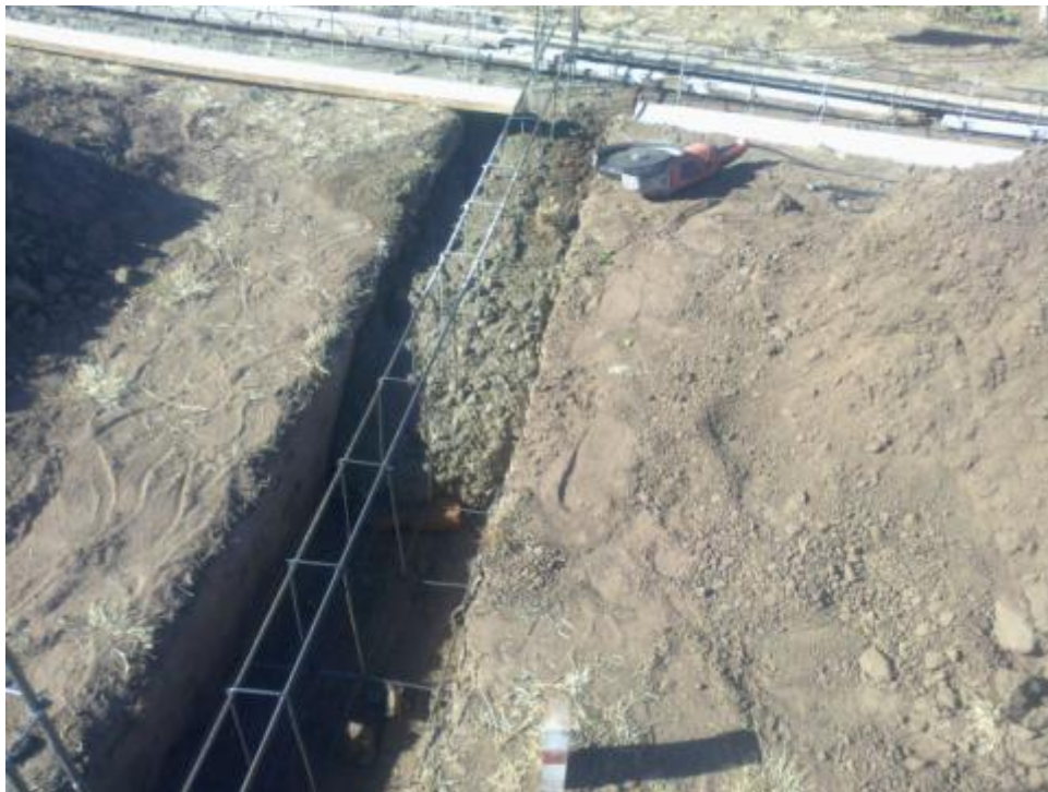
Figura 4.12: Llenado de la fundación
