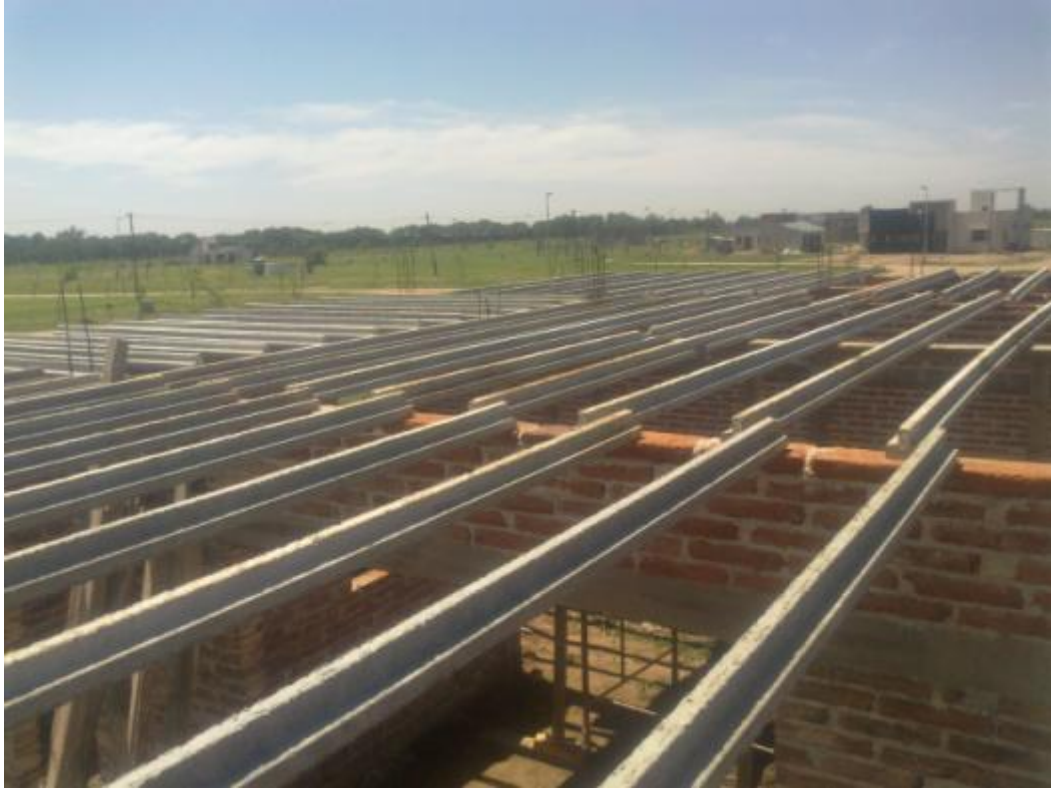
Figura 4.22. Viguetas apoyando en muros contiguos.
