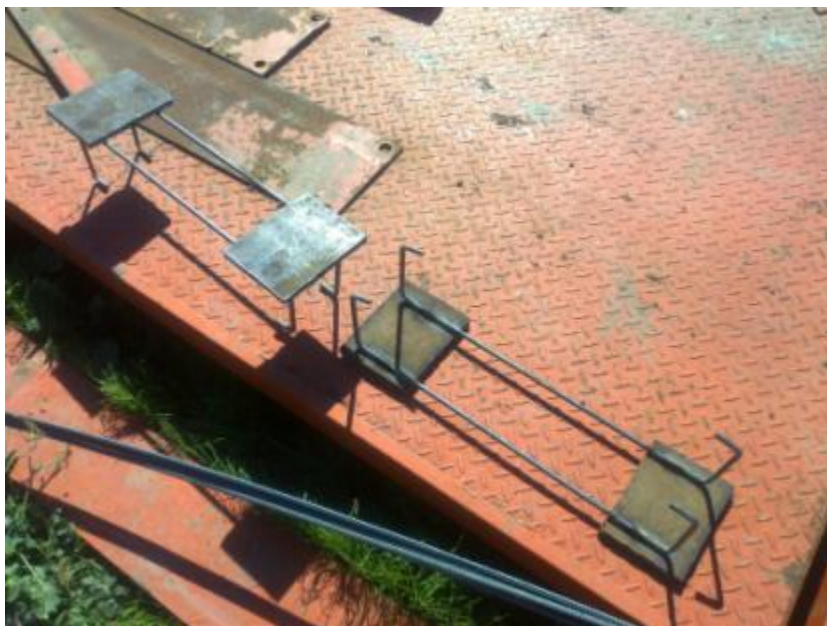
Figura 7.44: Placas de apoyo.
