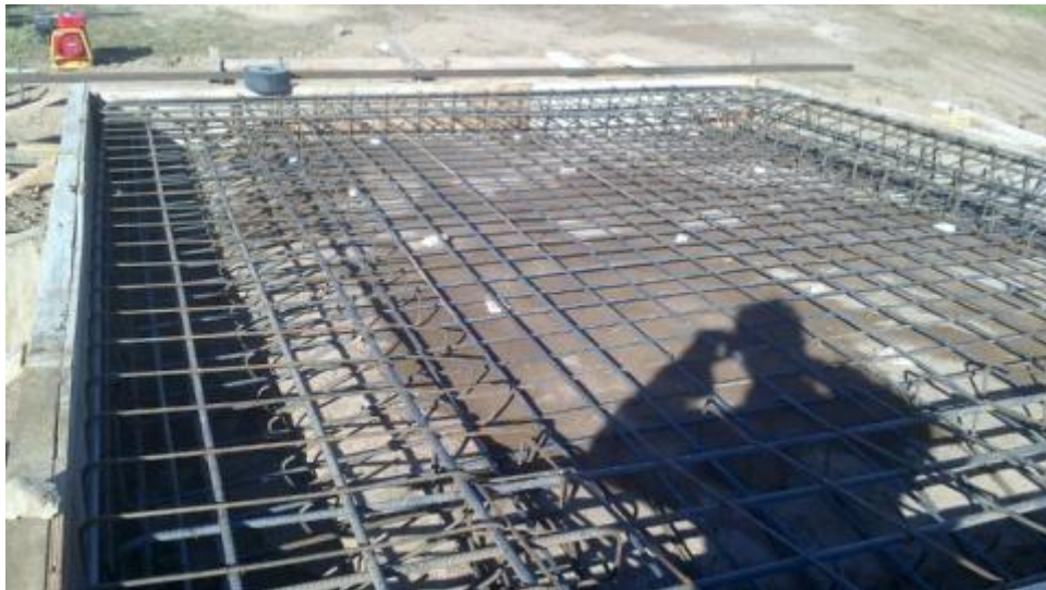
Figura 7.49: Armadura Losa de aproximación.
