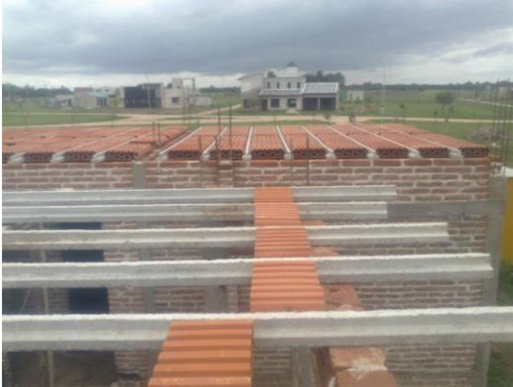
Figura 4.26. Confección del cerramiento superior.
