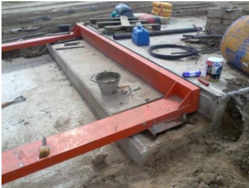
Figura 7.58: Empalme plataforma con losa
