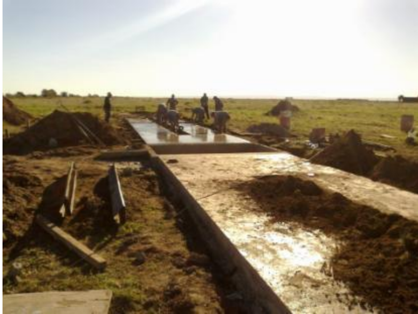
Figura 7.20:Hormigonado de la rampa de acceso Oeste
