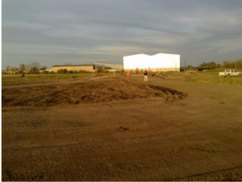
Figura 7.78: Rodillo neumático realizando trabajos de terminación.
