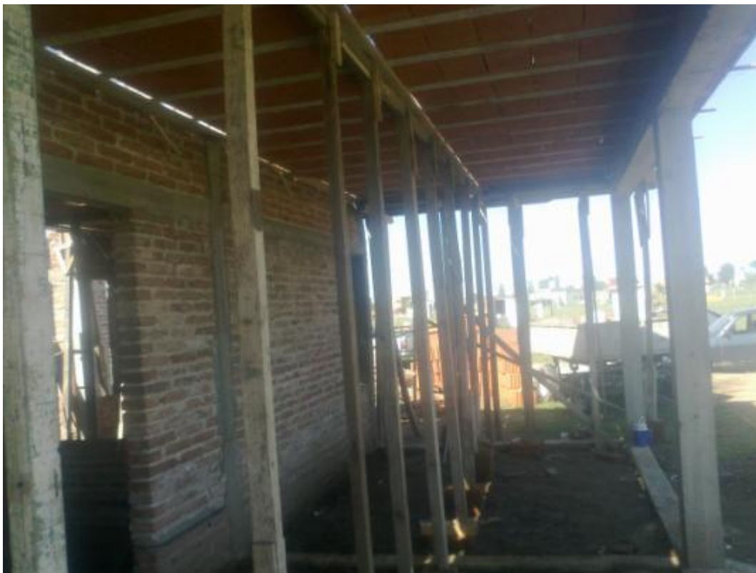
Figura 4.29: Apuntalamiento en cochera,
