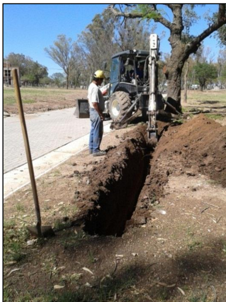
Figuras 4 y 5: Excavación de zanja a máquina y a mano – Baja tensión
