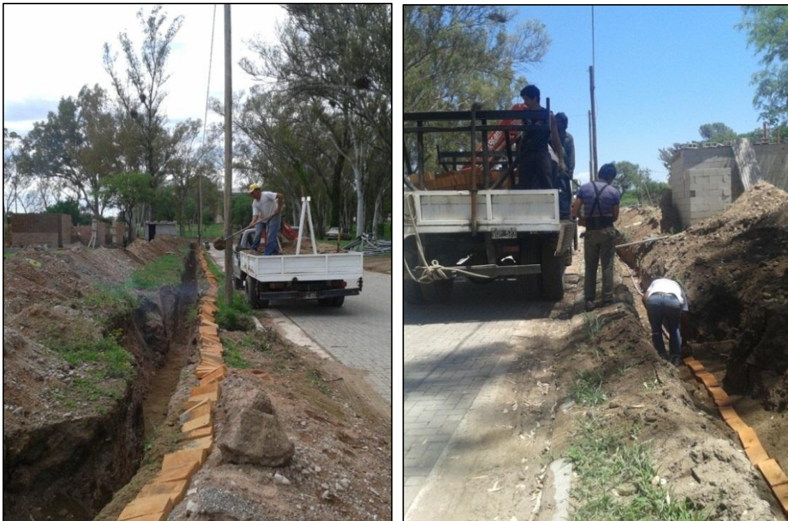
Figuras 11 y 12: Protección del cable con arena y ladrillos – Baja tensión
