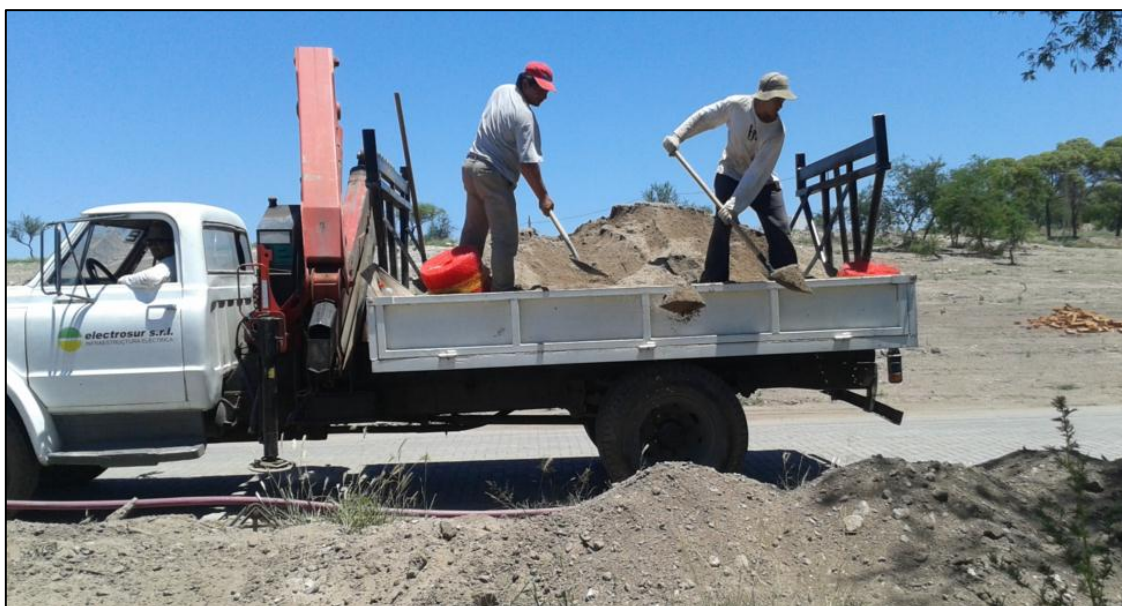
Figura 13: Protección del cable con arena – Baja tensión
