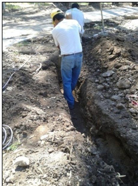
Figuras 4 y 5: Excavación de zanja a máquina y a mano – Baja tensión
