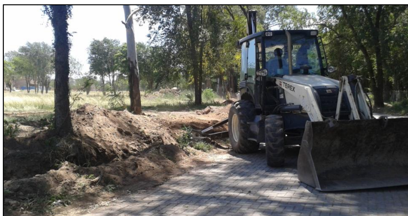
Figura 7: Tapado de zanja a máquina – Baja tensión
