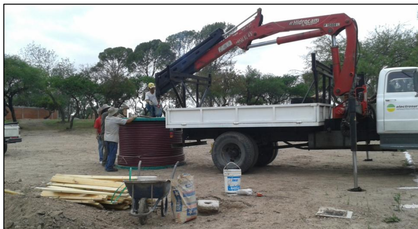
Figura 9: Preparación de cable para el tendido – Baja tensión
