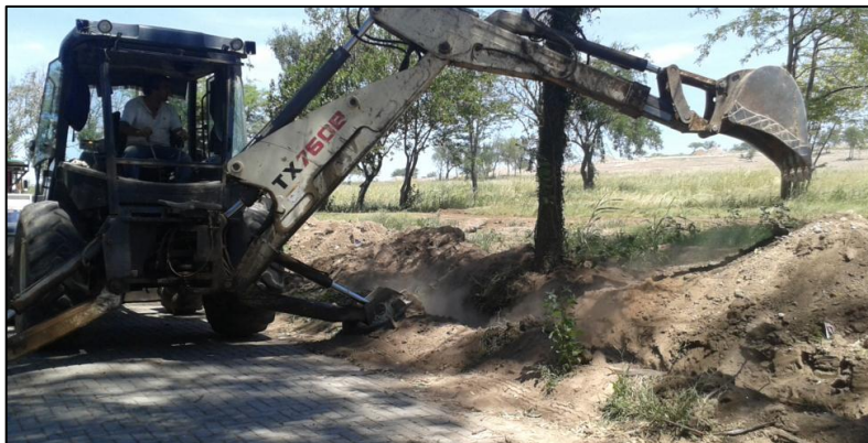
Figura 8: Tapado de zanja a máquina – Baja tensión
