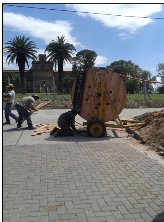
Figuras 19 y 20: Colocación de arena de asiento y preparación del cable para su tendido – Media tensión
