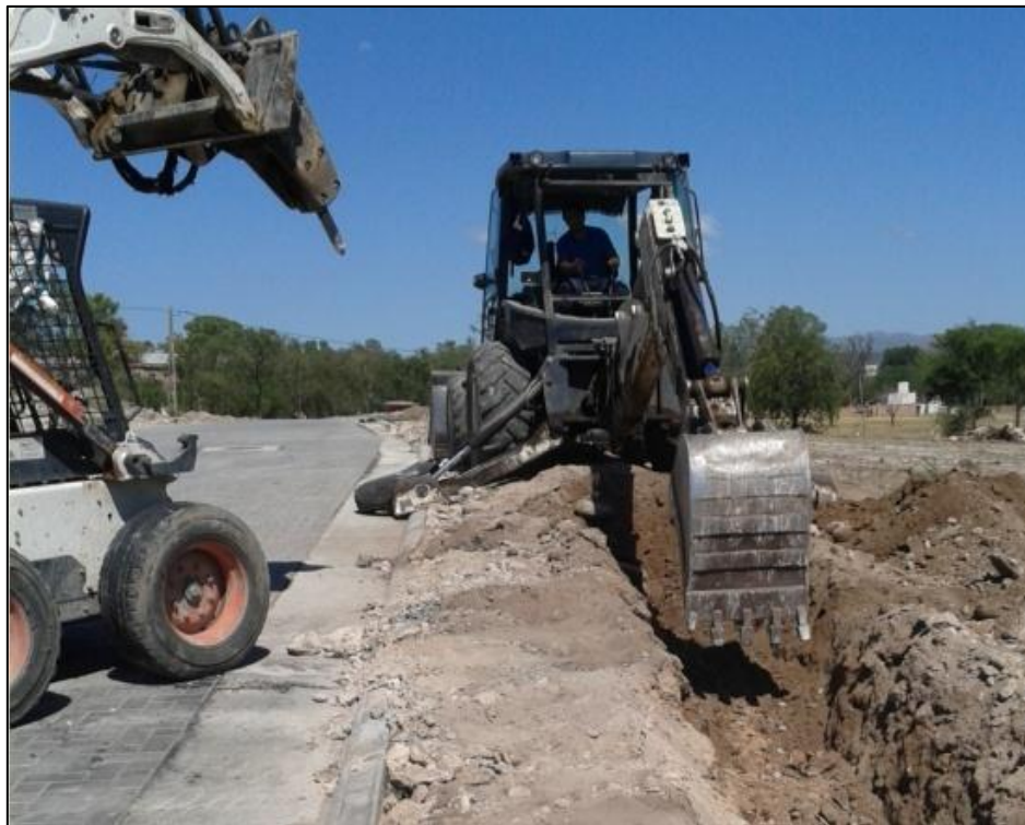
Figura 16: Excavación en roca a máquina – Baja tensión
