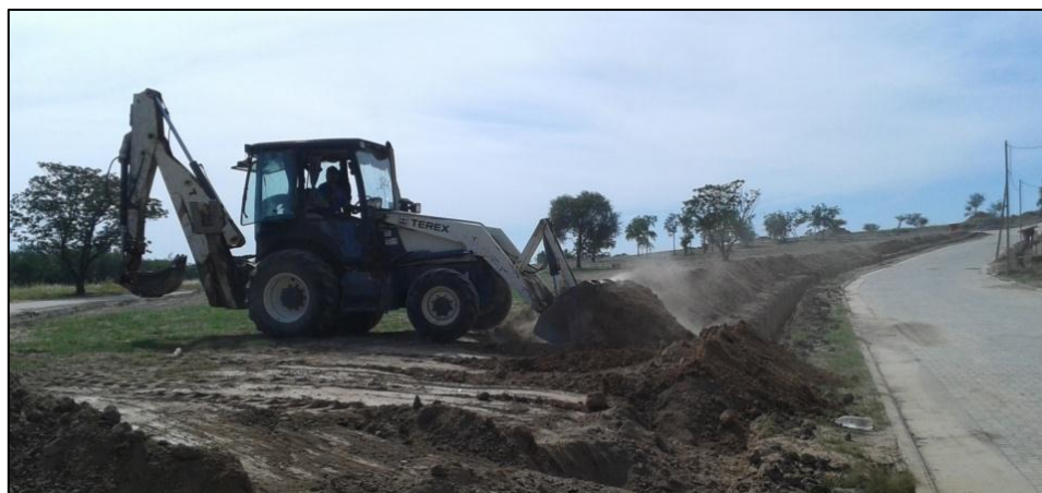
Figura 18: Tapado de zanja a máquina – Media tensión
