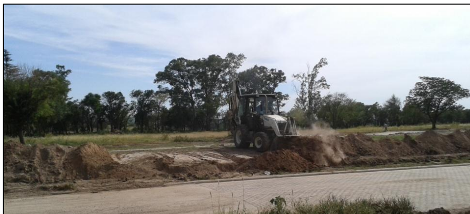
Figura 17: Tapado de zanja a máquina – Media tensión
