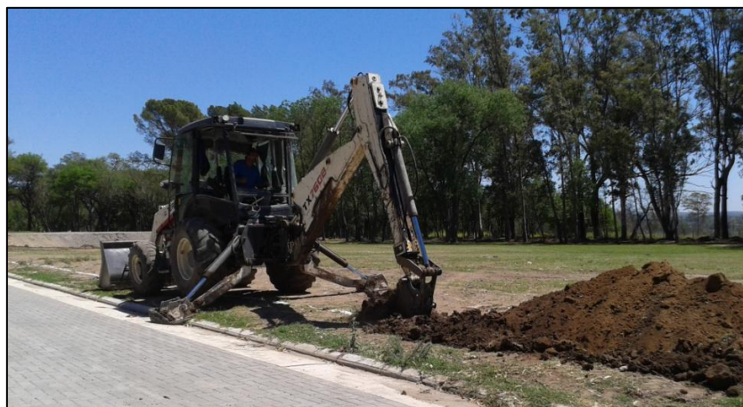
Figura 6: Excavación a máquina en suelo común – Baja tensión
