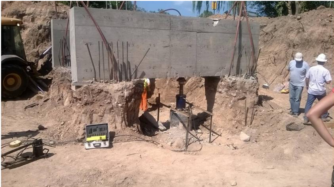
Figura 3.15. Vista del ensayo en pilote PE1
