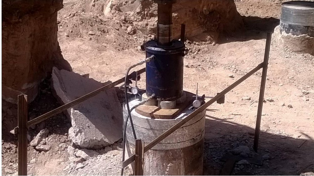
Figura 3.16. Vista de cabezales de pilotes de ensayo PE1 y PE2.
