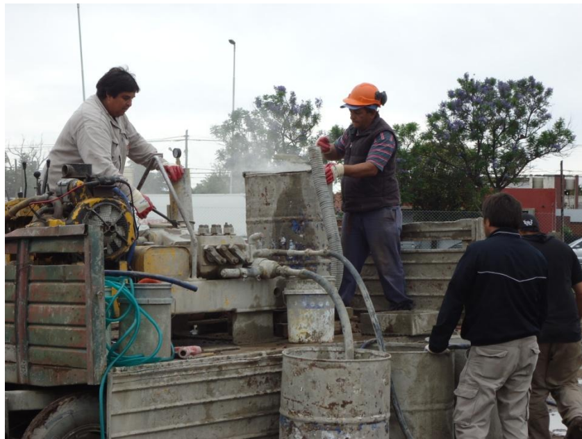
Figura 3.8. Preparación de la lechada cementicia y sistema de bombeo.
