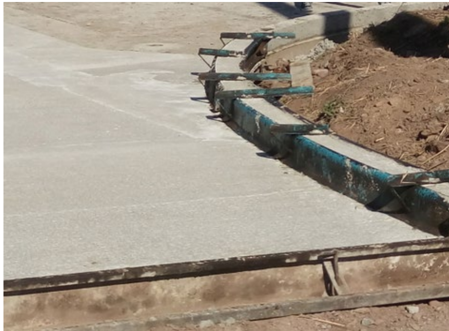
Figura 5.38. Cordón en tramo curvo. – Fuente: Elaboración Propia
