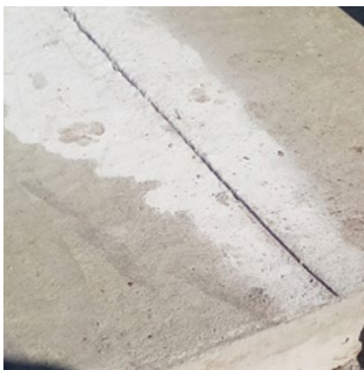
Figura 5.32. Aserrado en bocacalle. – Fuente: Elaboración Propia
