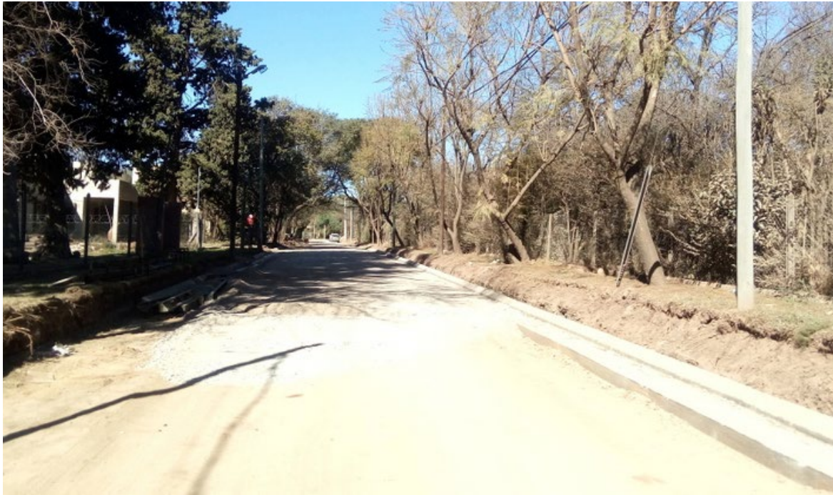
Figura 5.42. Distribución de 0-20 sobre subbase. – Fuente: Elaboración Propia
