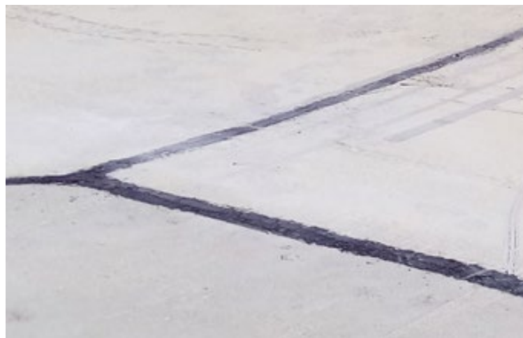
Figura 5.35. Sellado de juntas en bocacalle. – Fuente: Elaboración Propia
