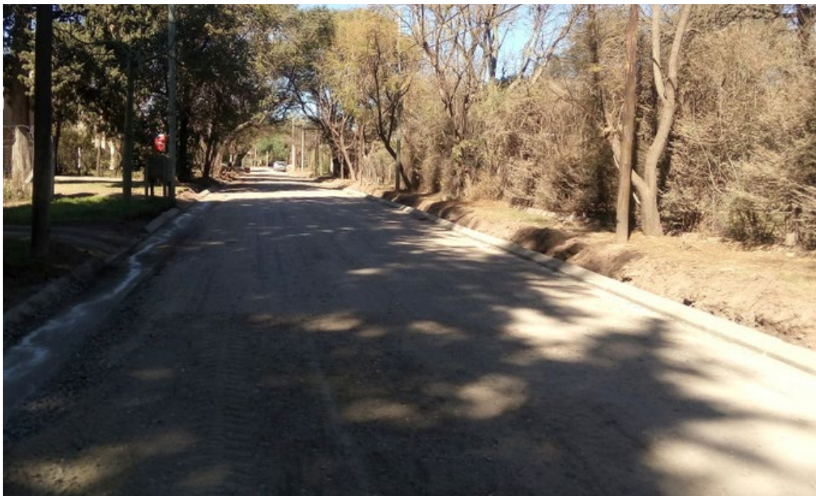
Figura 5.43. Distribución de 0-20 sobre subbase. – Fuente: Elaboración Propia
