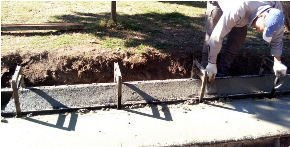
Figura 5.40. Cordón en tramo recto. – Fuente: Elaboración Propia
