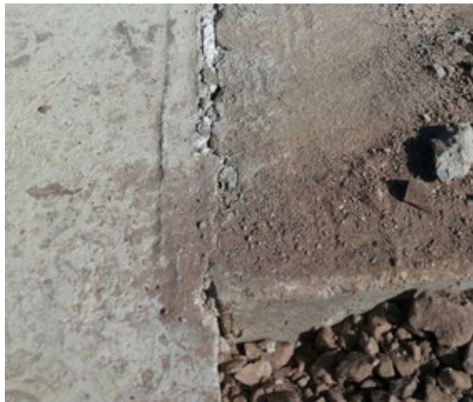
Figura 5.30. Junta de Dilatación. – Fuente: Elaboración Propia.
