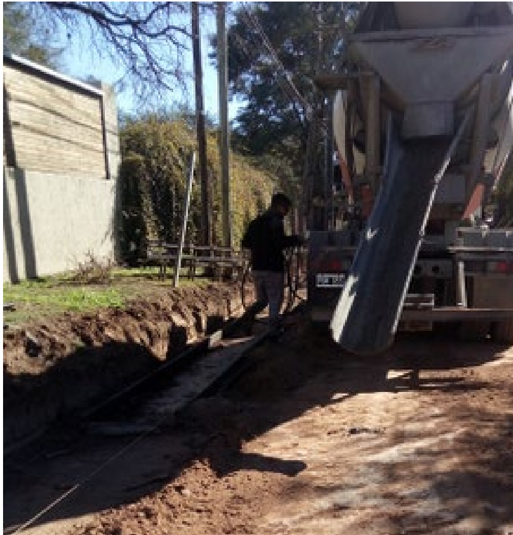
Figura 5.22. Colado de Hormigón en cuneta. – Fuente: Elaboración Propia
