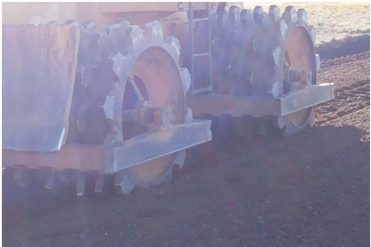
Figura 5.14. Compactación con rodillo Pata de Cabra. – Fuente: Elaboración Propia
