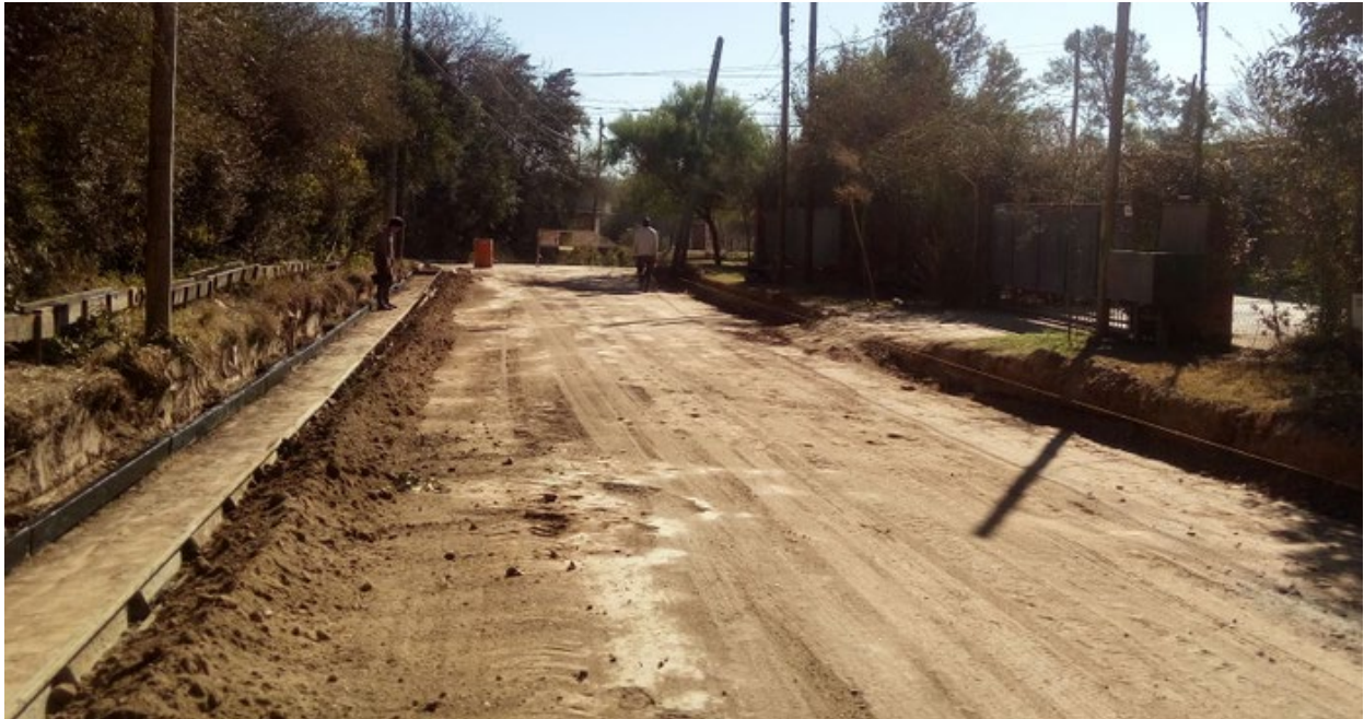
Figura 5.20. Colocación de moldes. – Fuente: Elaboración Propia
