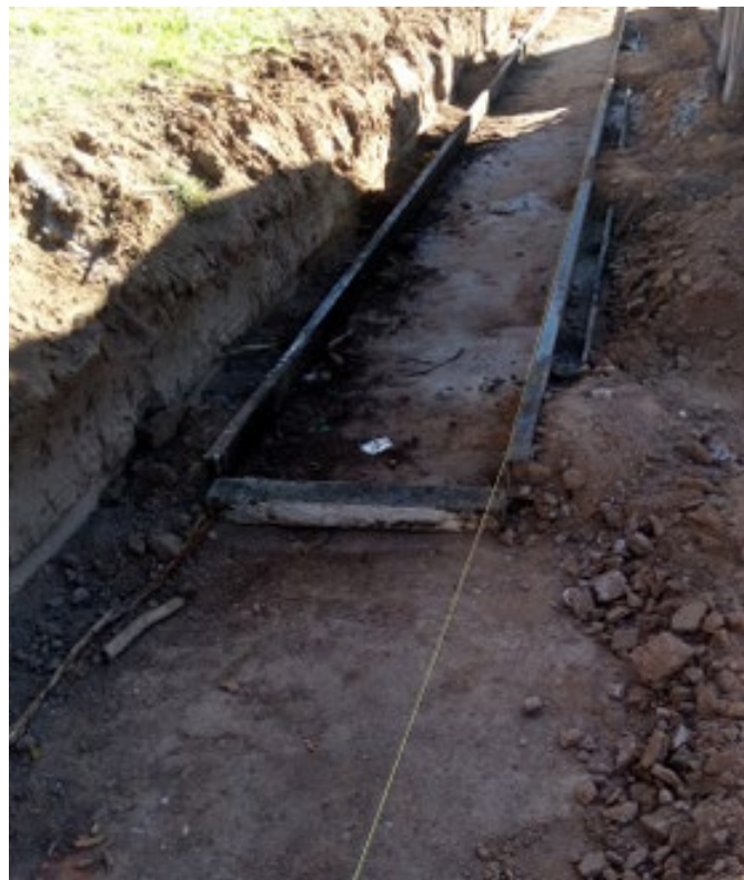
Figura 5.19. Colocación de moldes. – Fuente: Elaboración Propia
