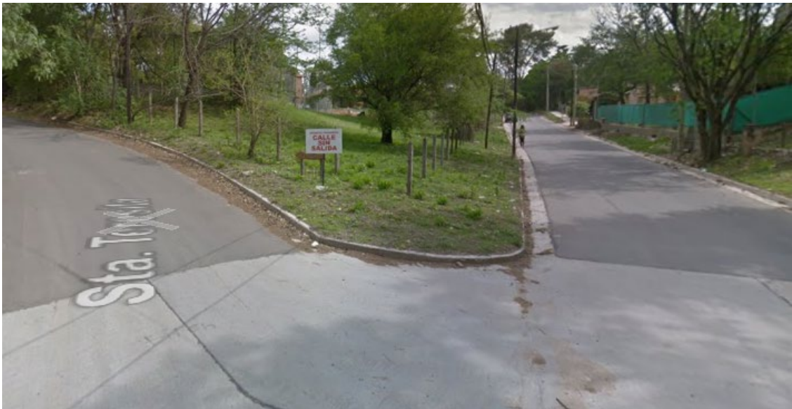
Figura 3.4: Pavimento existente intersección Santa Teresita y San Cayetano. – Fuente: Google Street.
