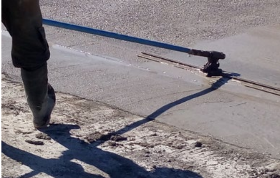
Figura 5.25. Terminación Superficial de boccalle con fratás. – Fuente: Elaboración Propia
