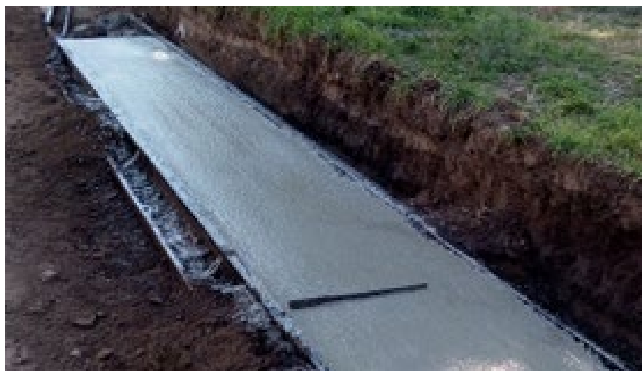
Figura 5.31. Aserrado de Cuneta. – Fuente: Elaboración Propia
