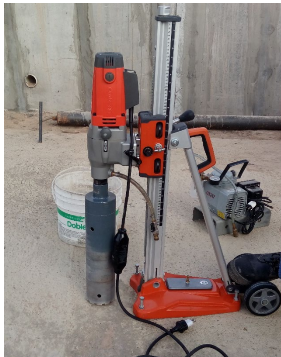
Figura 6.24: Extracción de testigos. – Fuente: Elaboración Propia.
