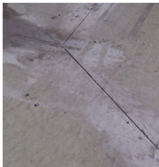
Figura 5.33. Aserrado en bocacalle. – Fuente: Elaboración Propia
