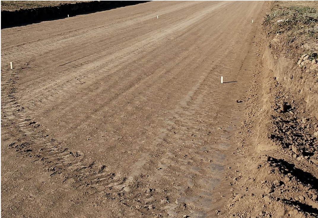
Figura 5.10: Aproximación a la subrasante. – Fuente: Elaboración Propia.
