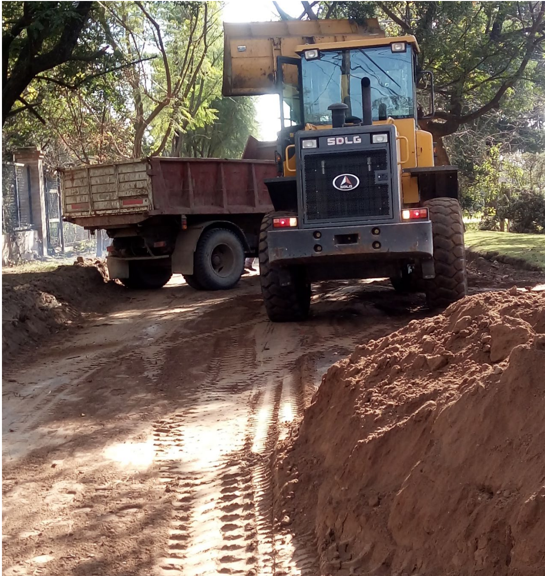
Figura 5.9: Pala Cargadora trabajando con el Camión Volcador. – Fuente: Elaboración Propia.
