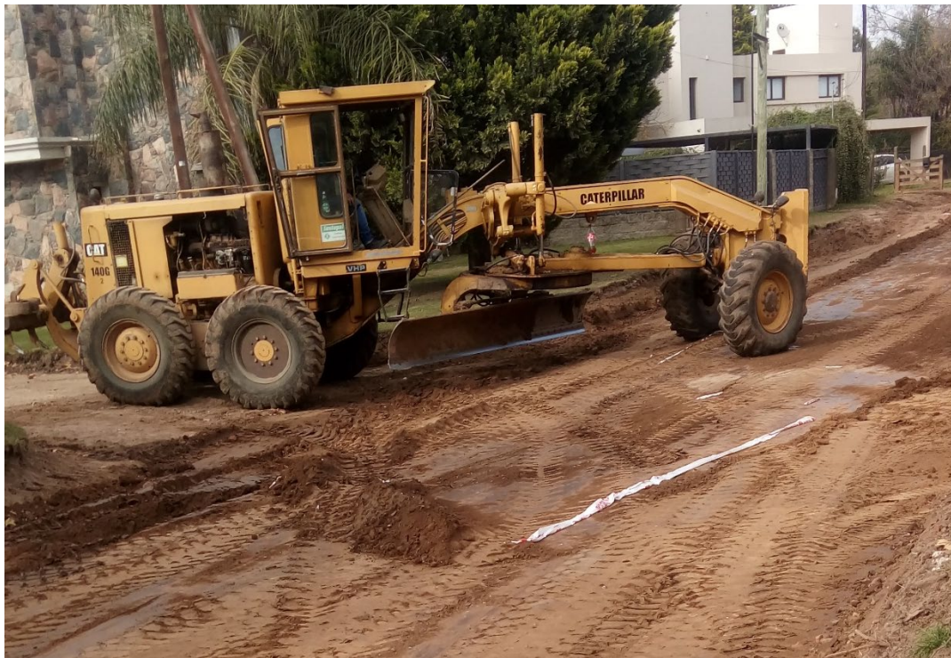
Figura 5.8: Motoniveladora trabajando. – Fuente: Elaboración Propia.
