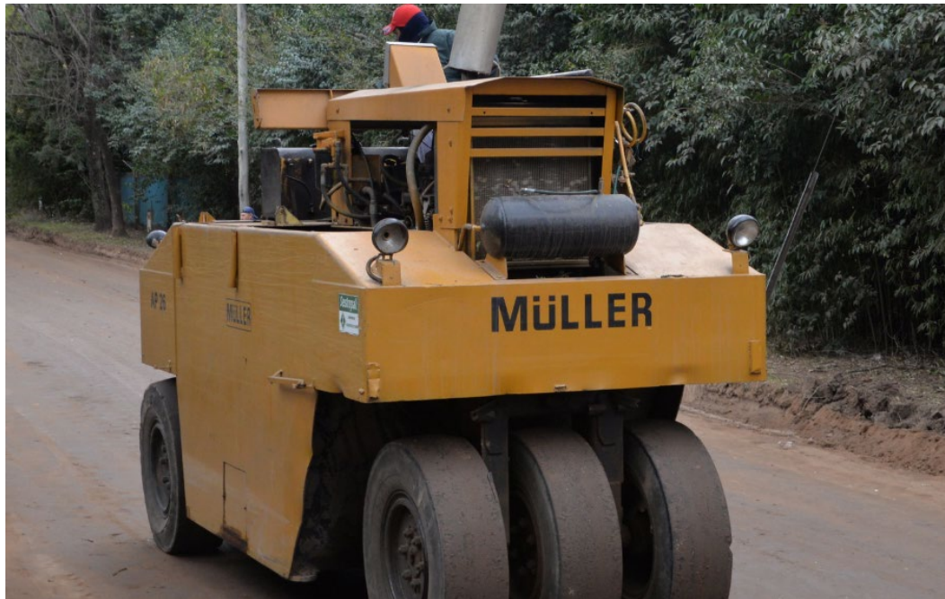
Figura 5.17. Compactación con rodillo neumático. – Fuente: Elaboración Propia
