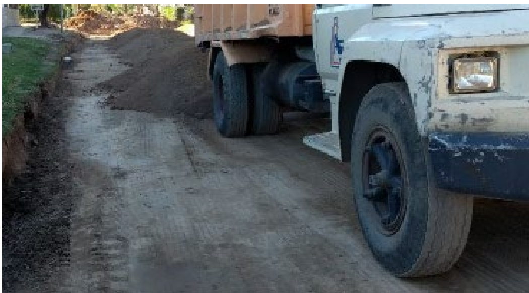
Figura 5.16. Descarga de material sobre la subrasante. – Fuente: Elaboración Propia
