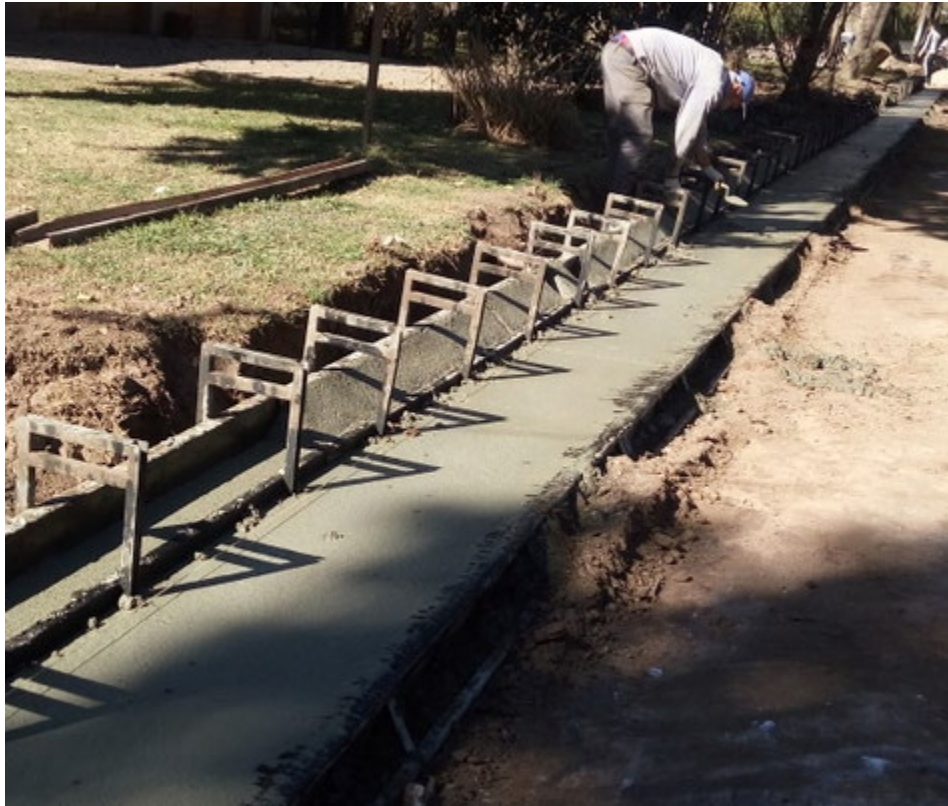
Figura 5.39. Cordón en tramo recto. – Fuente: Elaboración Propia
