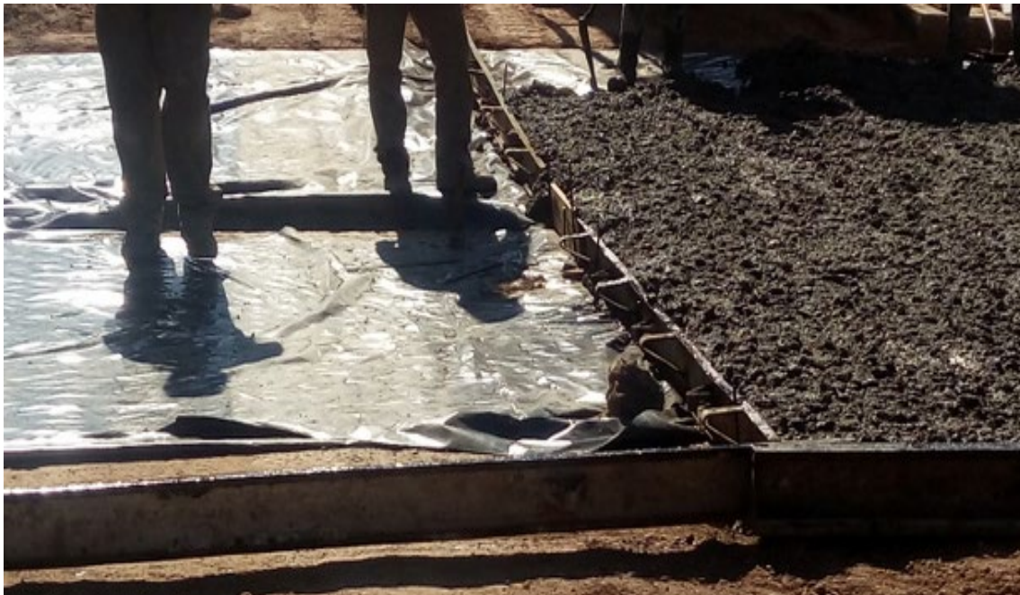
Figura 5.36. Colocación de membrana plástica previa al colado. – Fuente: Elaboración Propia
