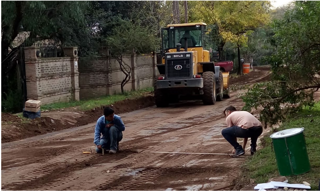
Figura 5.7: Operarios colocando estacas para nivelación geométrica. – Fuente: Elaboración Propia.
