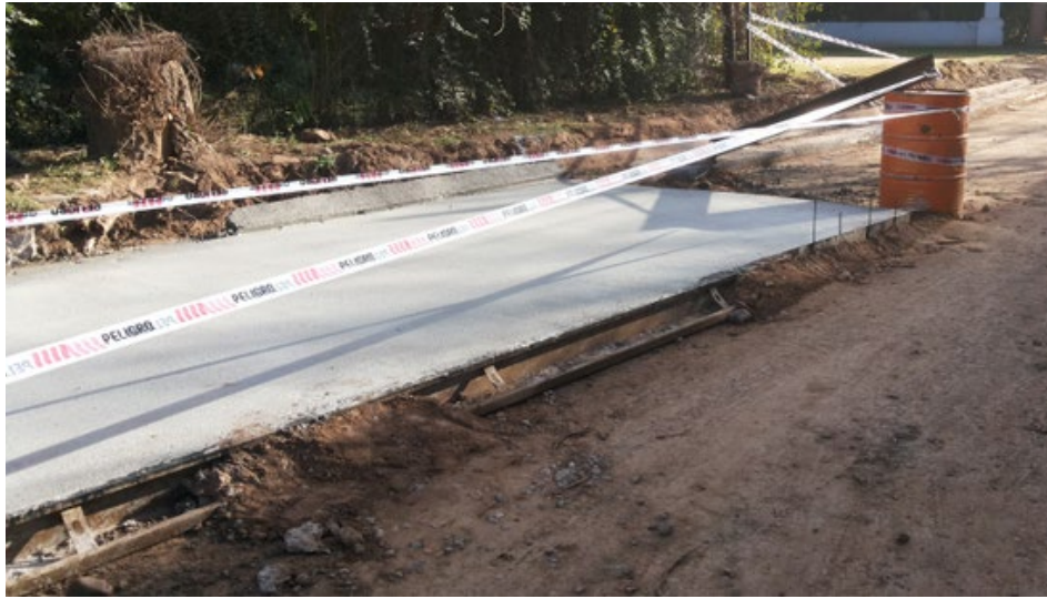
Figura 5.37. Protección de bocacalle hormigonada. – Fuente: Elaboración Propia
