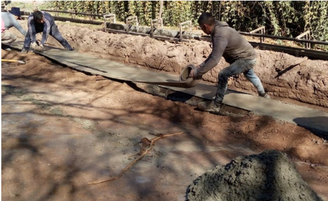
Figura 5.27. Terminación Superficial de cordón cuneta con cinta alisadora. – Fuente: Elaboración Propia
