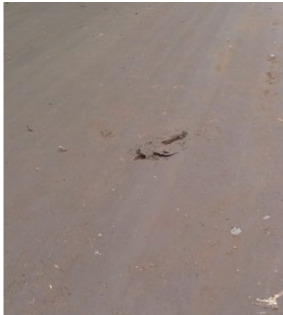
Figura 5.15. Relevamiento de Baches. – Fuente: Elaboración Propia
