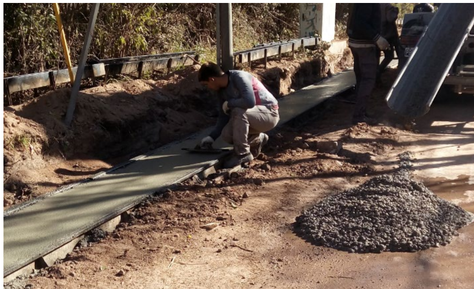
Figura 5.26. Terminación Superficial de cordón cuneta con fratás. – Fuente: Elaboración Propia
