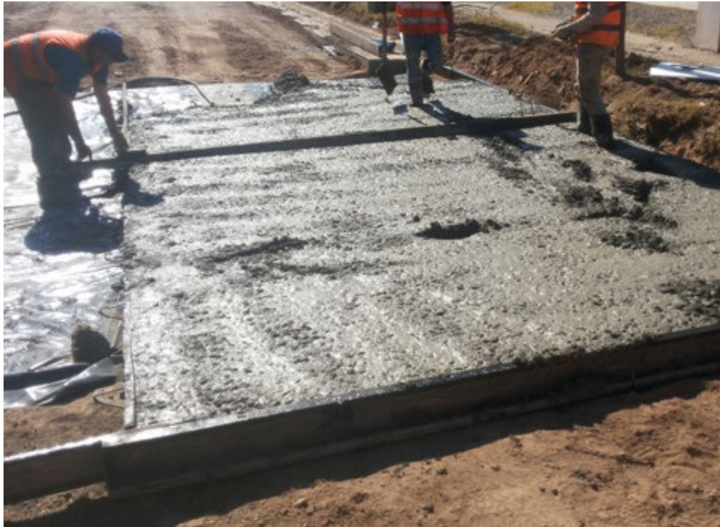
Figura 5.23. Colado de Hormigón en badén. – Fuente: Elaboración Propia
