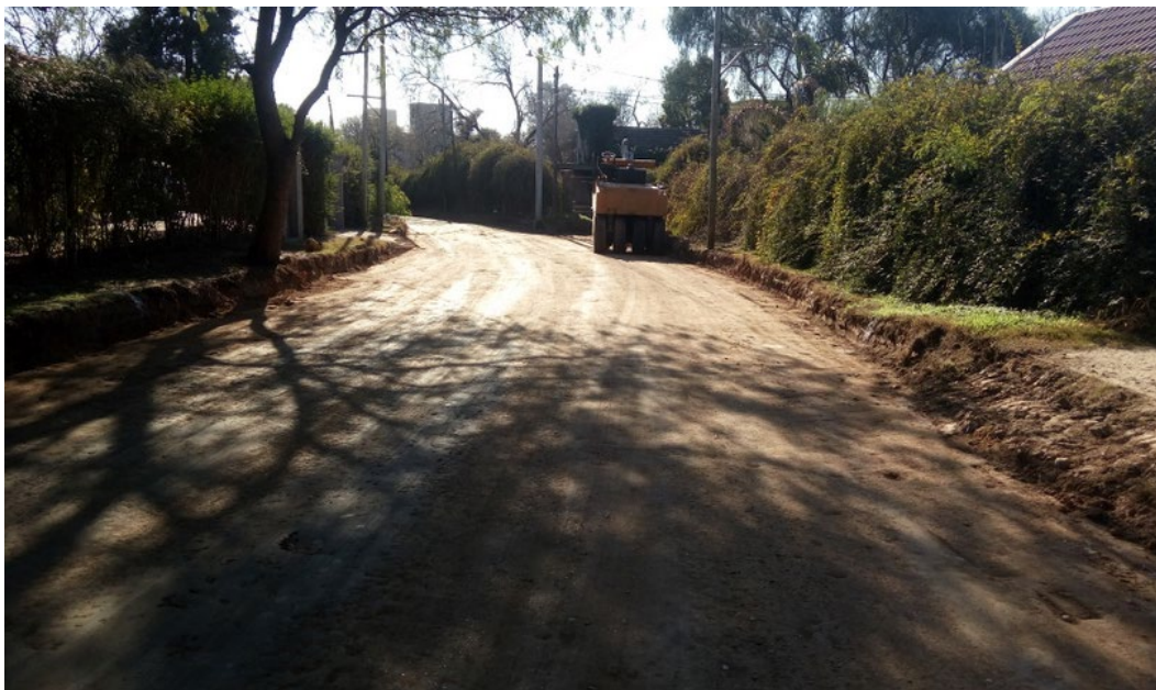
Figura 5.18. Compactación con rodillo neumático. – Fuente: Elaboración Propia
