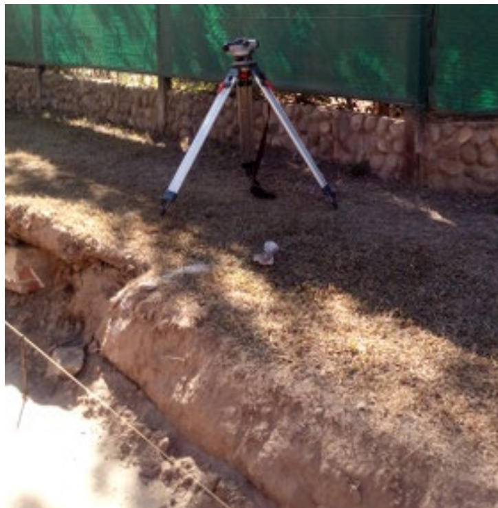
Figura 5.21. Control altimétrico del cordón cuneta. – Fuente: Elaboración Propia
