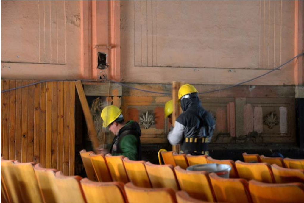
Gráfico N° 30: Retiro de revestimiento de madera en muros laterales
