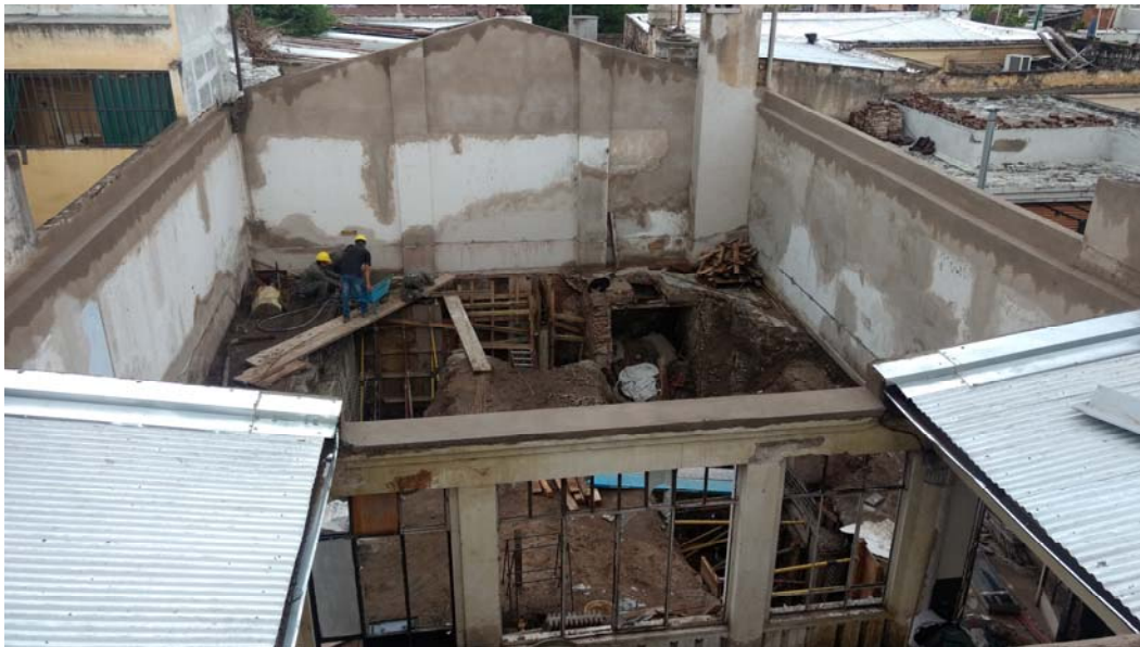
Gráfico N° 33 y 34 : Vista del edificio de depósito al momento del desarme de la cubierta y durante los trabajos para la sala de máquinas y cisterna.
