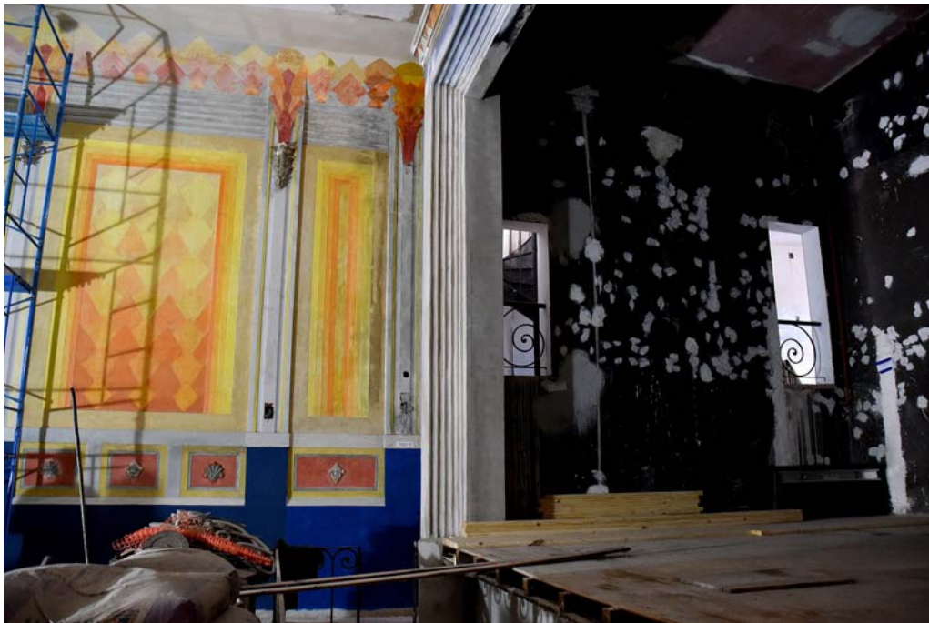
Gráfico N° 31: Vista de los trabajos restauración de pintura
