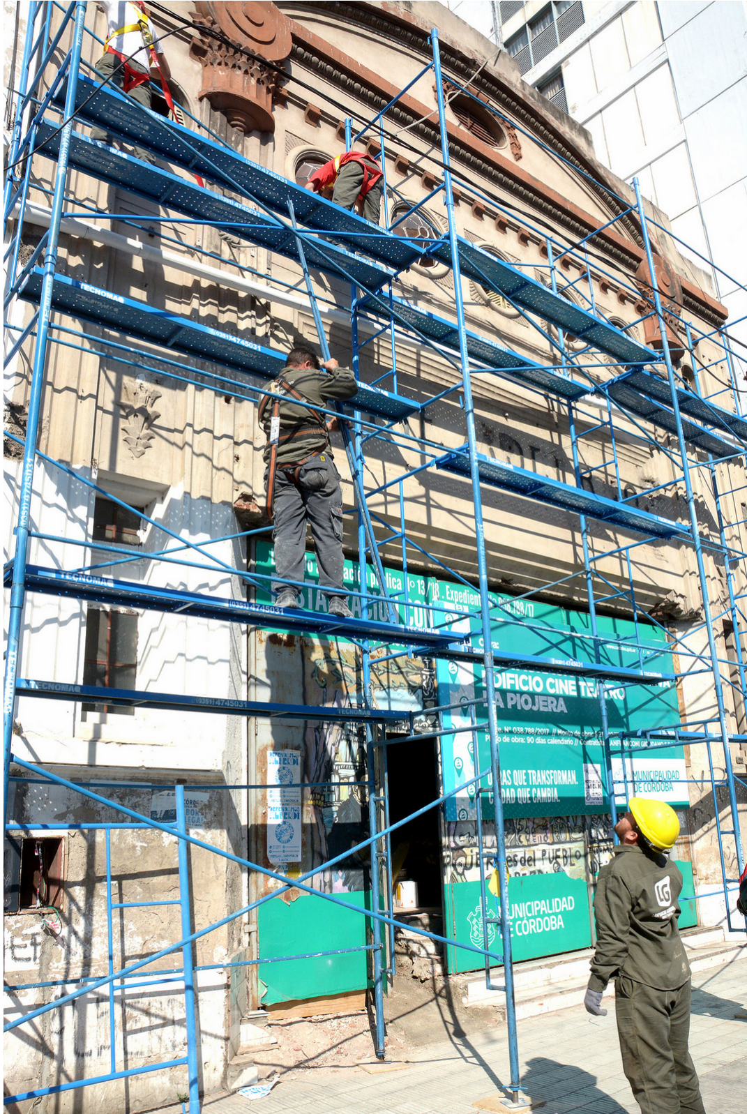
Gráfico N° 26 y 27 : Instalación de andamios para trabajos en fachada
