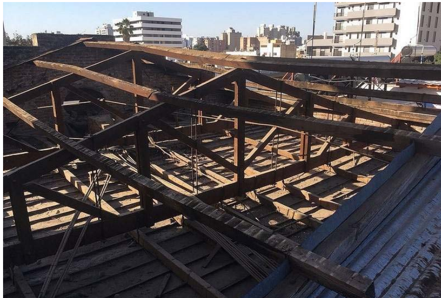
Gráfico N° 14: Estructura de madera de la cubierta del salón principal.
