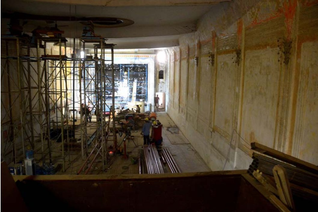
Gráfico N° 32: Estructura de soporte provisoria de l cielorraso durante los trabajos de reparación
