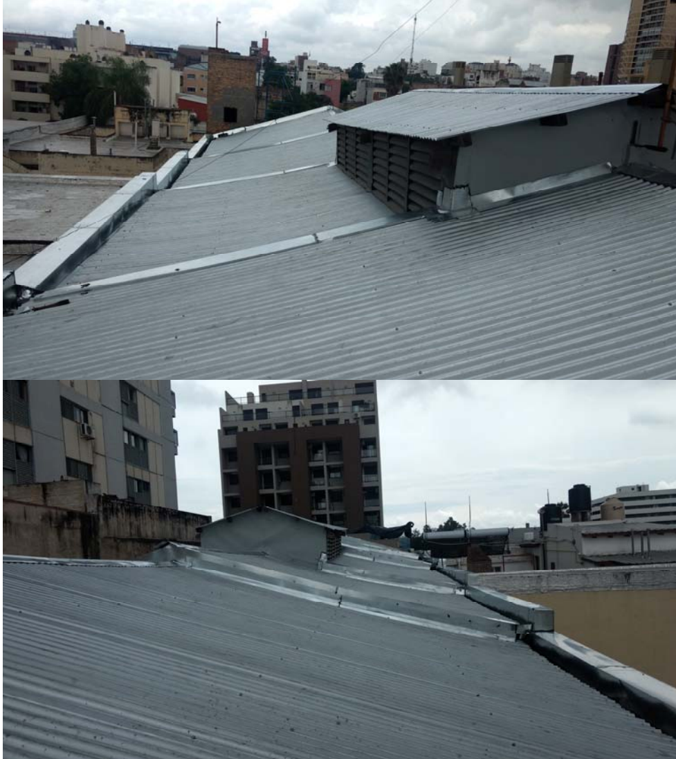
Gráfico N° 24: Vistas de la cubierta ya terminada.
