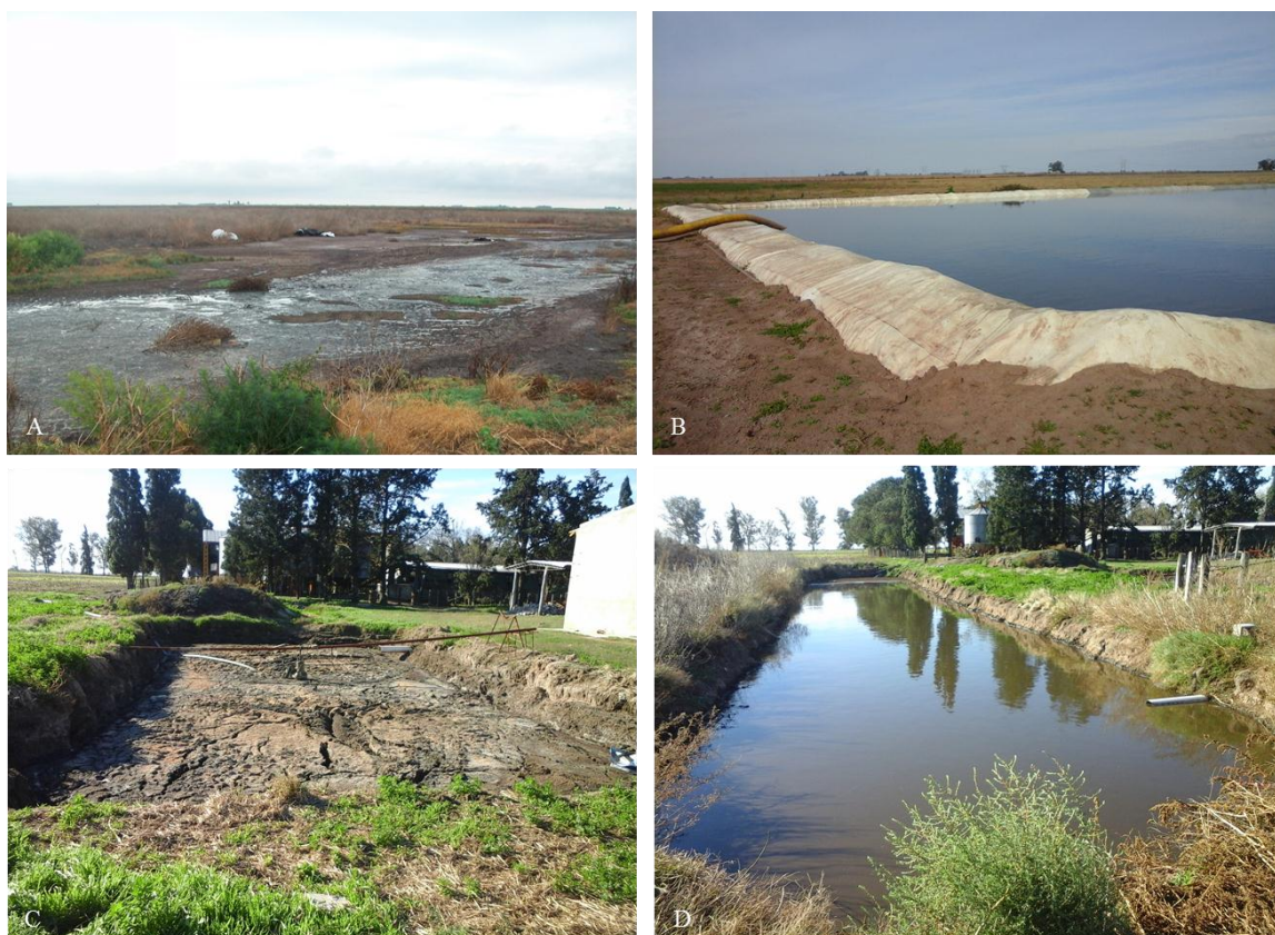
Fig. 3. 7. Sistemas de manejo de efluente porcino, A) Sin tratamiento, B) Tratamiento anaerobio, C) Laguna anaerobia de estabilización y D) Laguna facultativa de estabilización. Imágenes de establecimientos encuestados.
