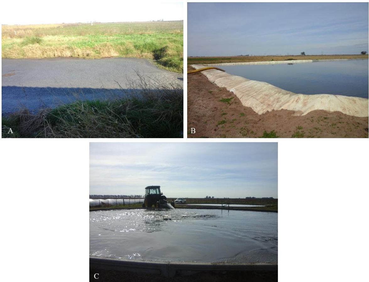
Fig. 3. 9. Tipos de impermeabilización y diseño de sistemas de almacenamiento y/o tratamiento, A) Rectangular sin impermeabilización, B) Rectangular impermeabilizado con geotextil y C) Circular impermeabilizado con hormigón. Imágenes de establecimientos encuestados.
