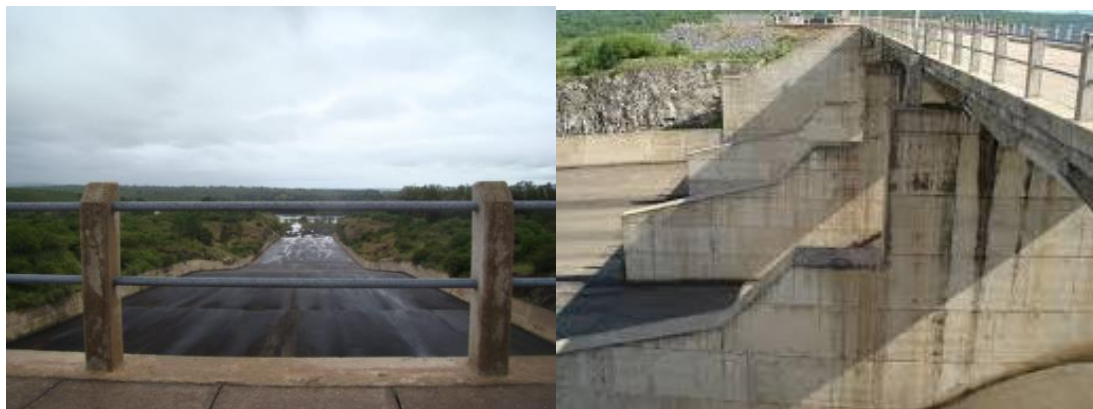
Figura 78 – Vertedero de descarga de la presa Arroyo Corto.
