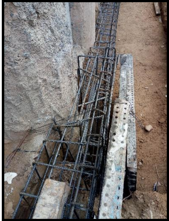
Figura 41: Armadura nudo viga PP
