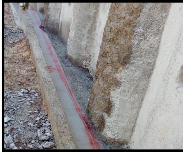
Figura 44: Replanteo de paneles sobre viga PP
