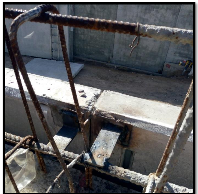
Figura 48: Vinculación viga cabezal y paneles
