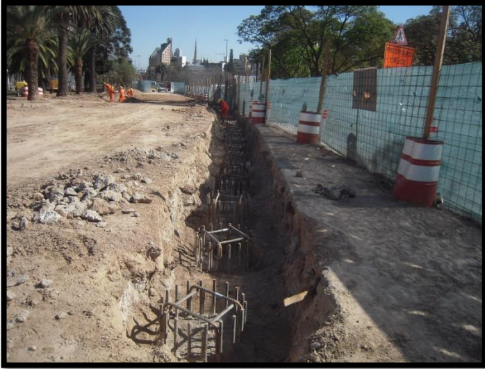
Figura 31: Viga cabezal previo hormigón de limpieza
