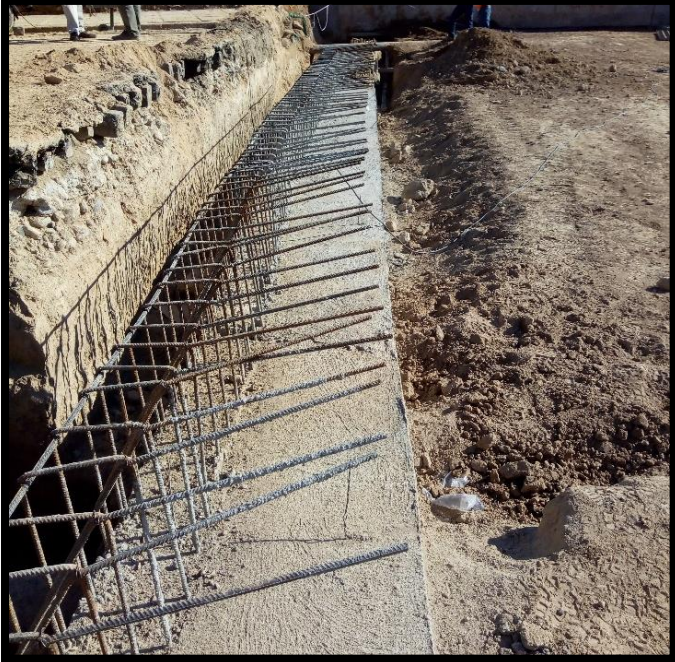
Figura 34: Viga Cabezal final en segunda etapa
