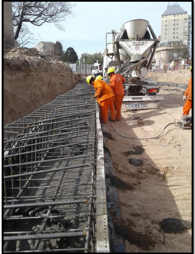
Figura 33: Hormigonado Viga cabezal
