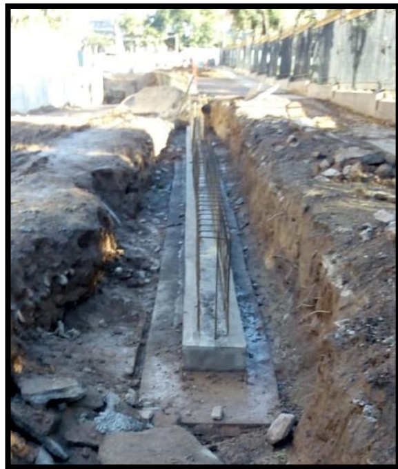
Figura 51: Cordón listo para segunda etapa de hormigonado
