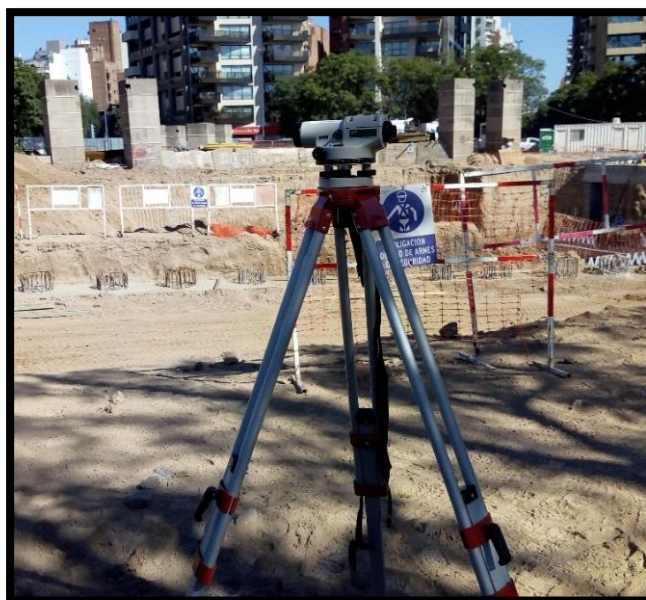
Figura 31: Replanteo Hormigón de limpieza
