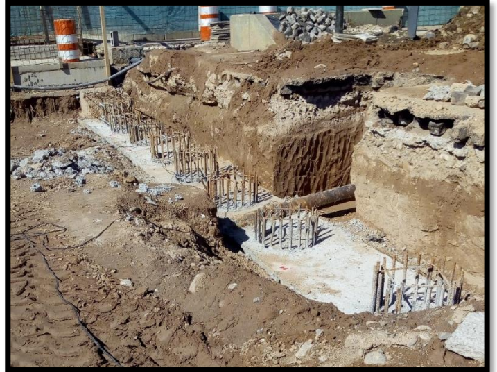
Figura 30: Viga cabezal con Hormigón de limpieza
