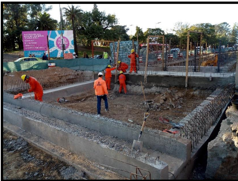
Figura 36: Acondicionamiento del sector de vigas prefabricadas
