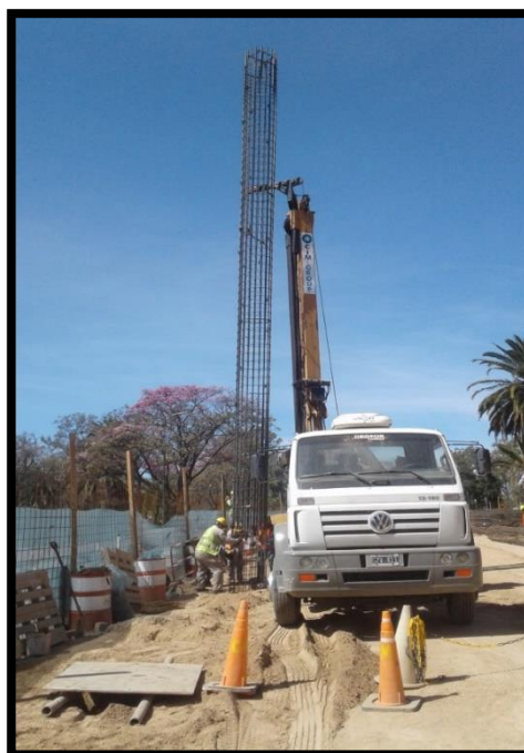
Figura 29: Colocación de armadura pilotes
