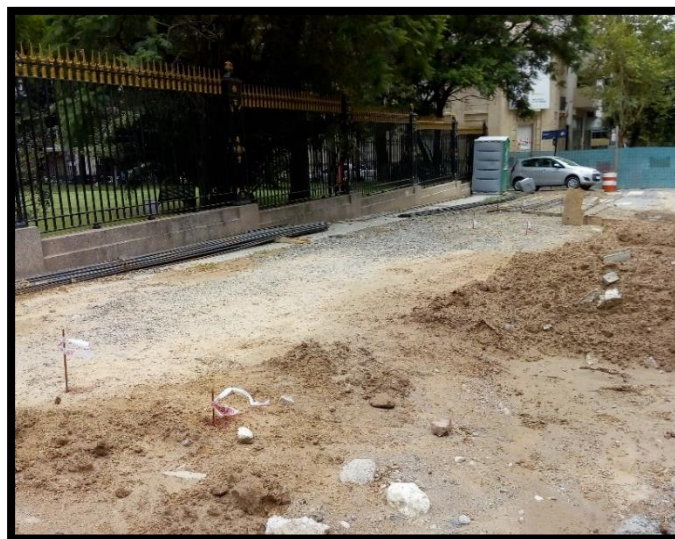
Figura 50: Replanteo de cordón
