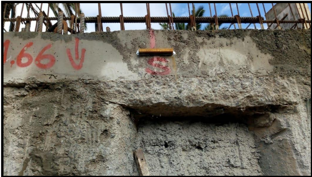
Figura 45: Replanteo de paneles sobre viga cabezal
