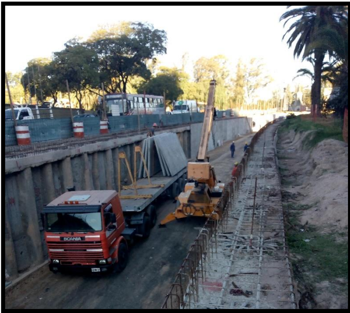
Figura 47: Instalación Paneles
