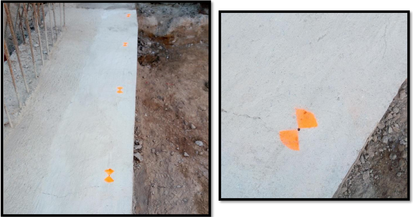
Figura 35: Demarcación de ubicación de losas prefabricadas
