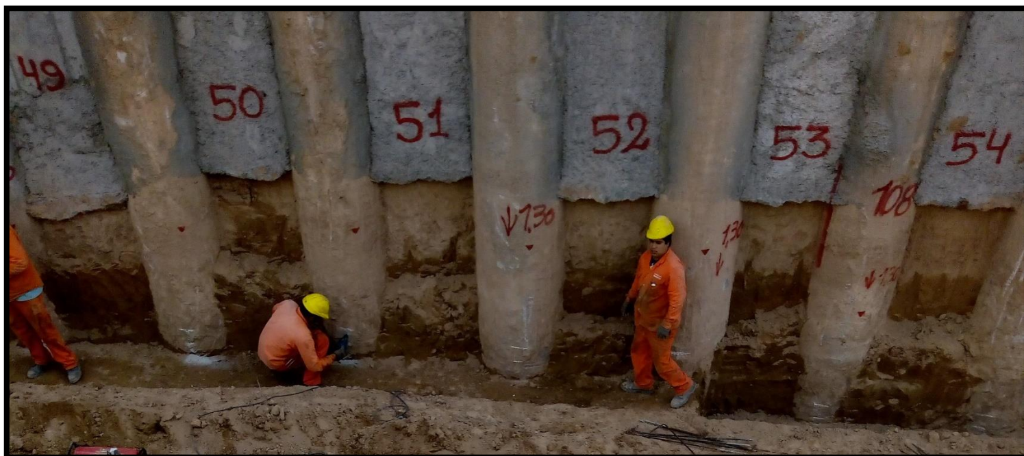
Figura 39: Replanteo de posición de viga porta panel
