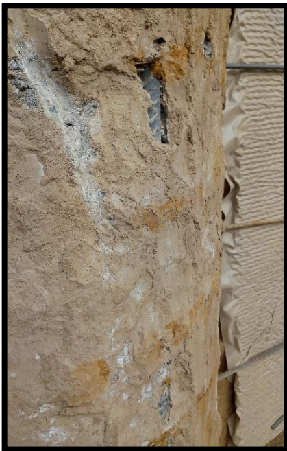
Figura 55: Hierros descubiertos
