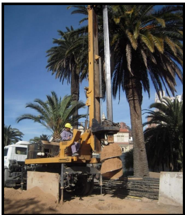
Figura 29: Excavación de pilotes
