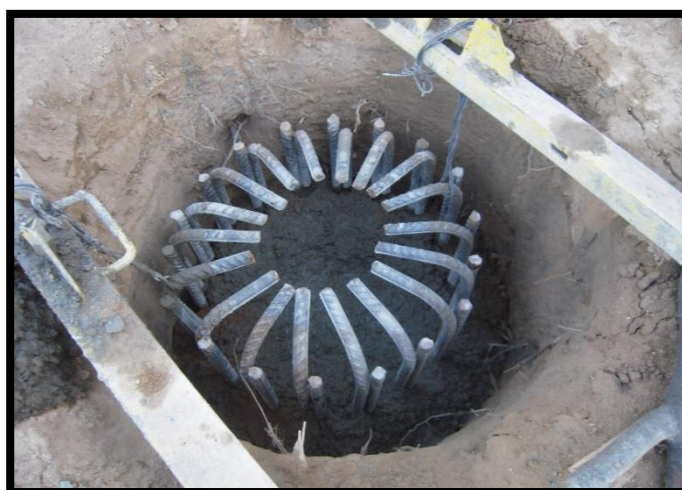
Figura 30: Hormigonado pilotes
