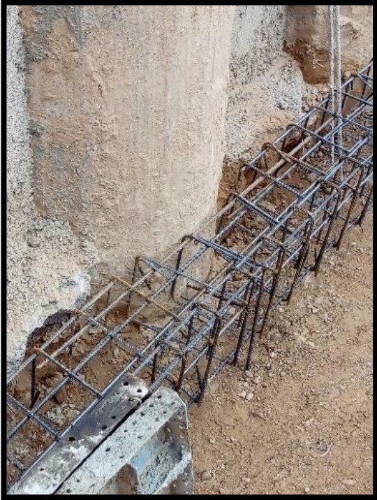
Figura 40: Armadura viga porta panel
