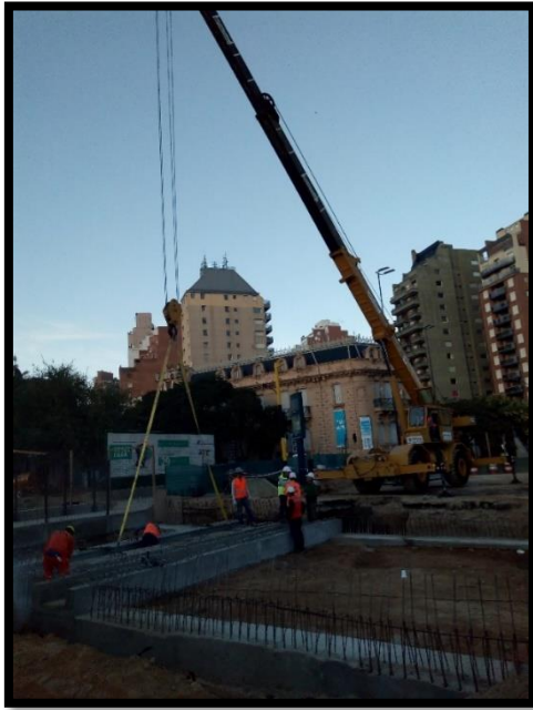
Figura 37: Colocación de losas
