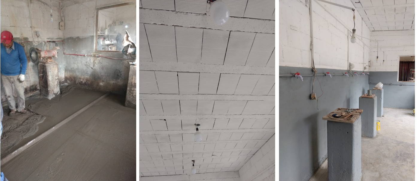
Imagen 13. Remodelación del área de producción.
