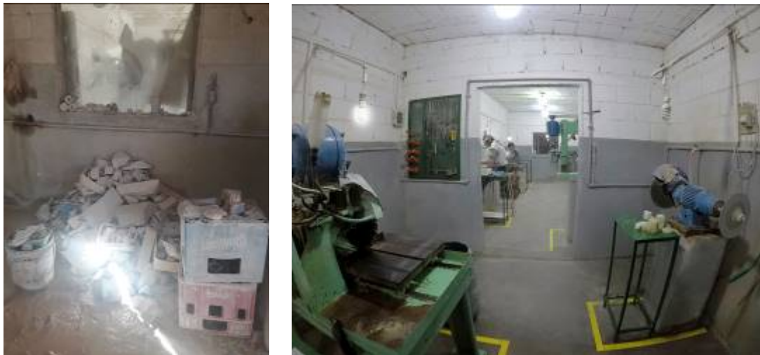
Imagen 33. Antes y después pared divisora de salas.
